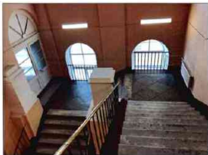
5. Главная лестница. Общий вид. (фотофиксация выполнена 18.02.2021)
