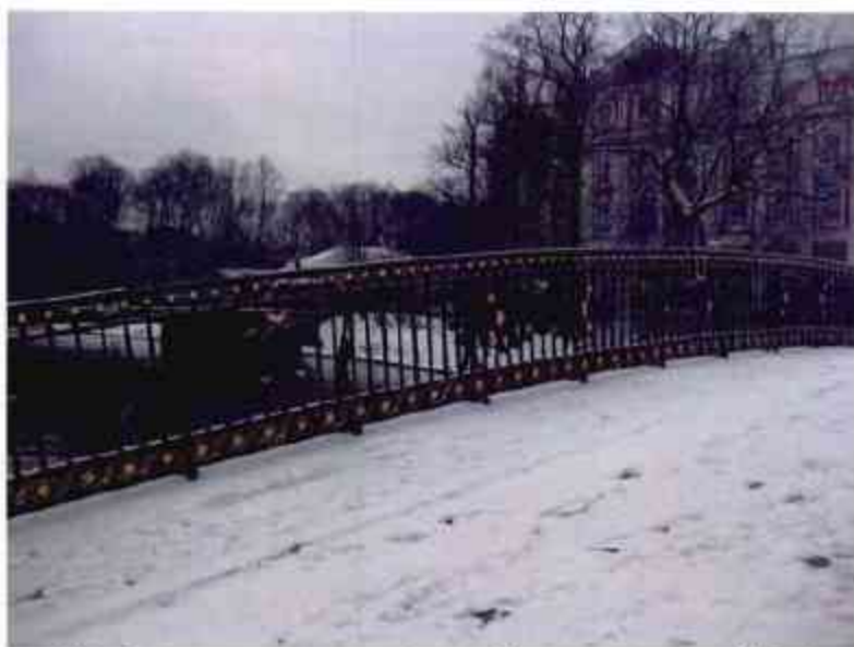
5. Решётка перильного ограждения (верхней фазы со стороны реки Мойки)
