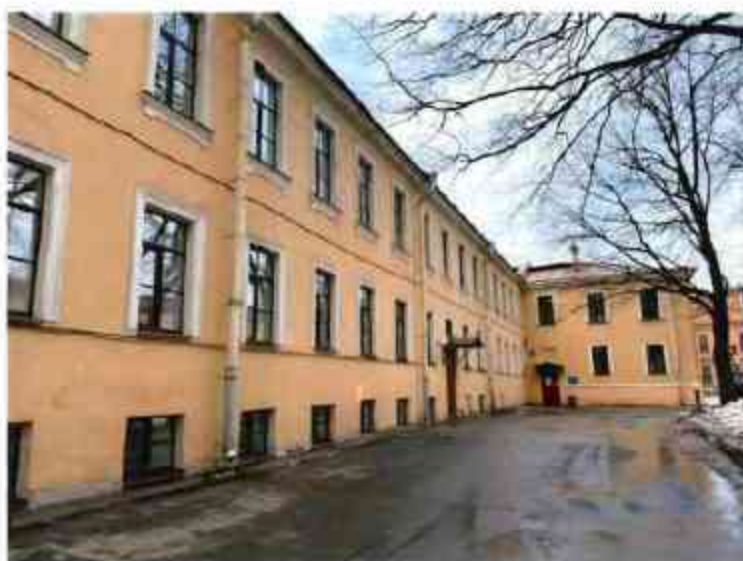
3. Общий вид на объект культурного наследия.
