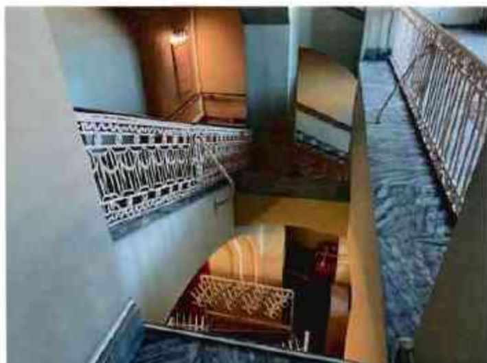
3. Общий вид на лестницу объекта культурного наследия.
