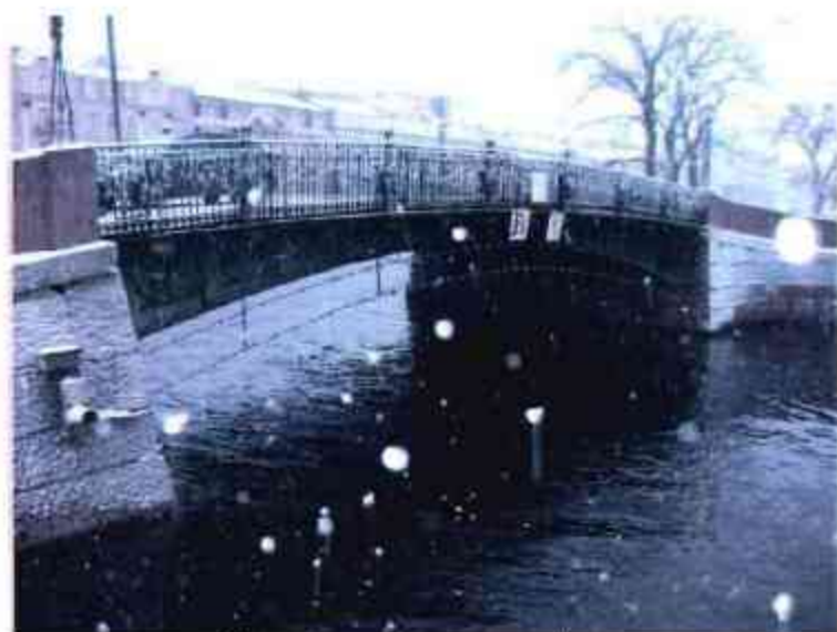
5. Вид моста со стороны низового фасада.
