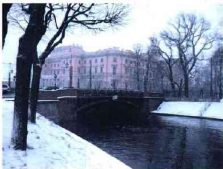
6. Вид моста со стороны низового фасада
