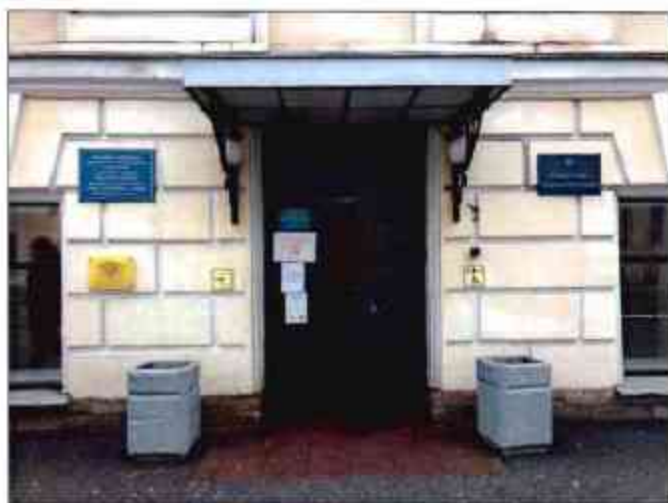
4. Западный фасад объекта культурного наследия. Фрагмент. Главный вход. (фотофиксация выполнена 26.02.2021)
