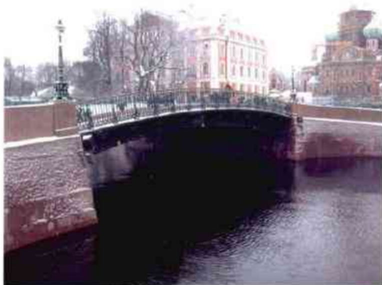
3. Низовой фасад моста со стороны реки Мойки
