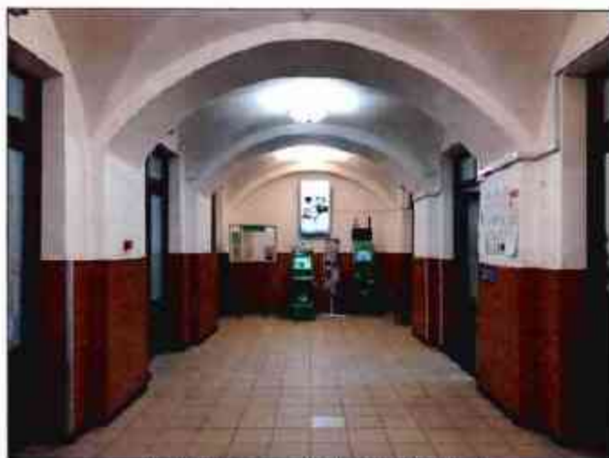
8. Коридор в уровне 1 этажа. Общий вид. (фотофиксация выполнена 18.02.2021)
