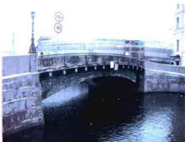
7. Вид моста со стороны низкого фасада
