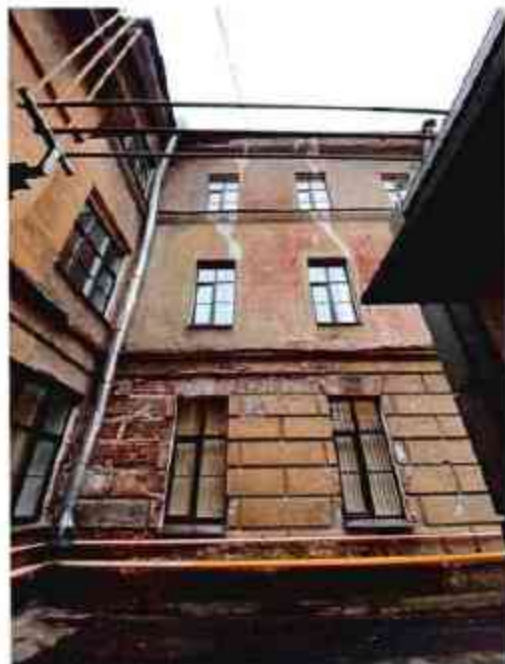
3. Фрагмент западного фасада объекта культурного наследия.
