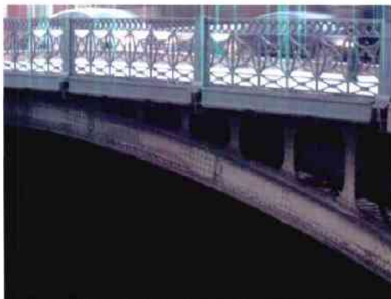
9. Металлическое пролетное строение и решетка перильного ограждения (фрагмент, изловоу фасада)
