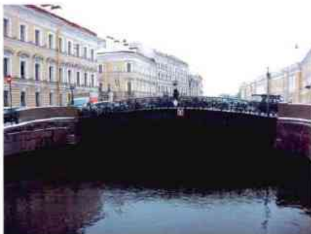
2. Вид моста со стороны верхнего фасада
