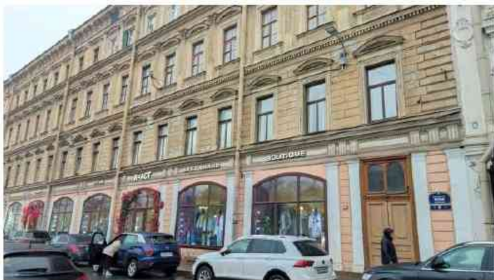
Фото 8. Объект культурного наследия регионального значения "Дом, где в конце 1906 г. проходили заседания ЦК и ПК РСДРП" (Санкт-Петербург, Большая Морская ул., 16; Кирпичный пер., 8). Фрагмент восточного фасада.
