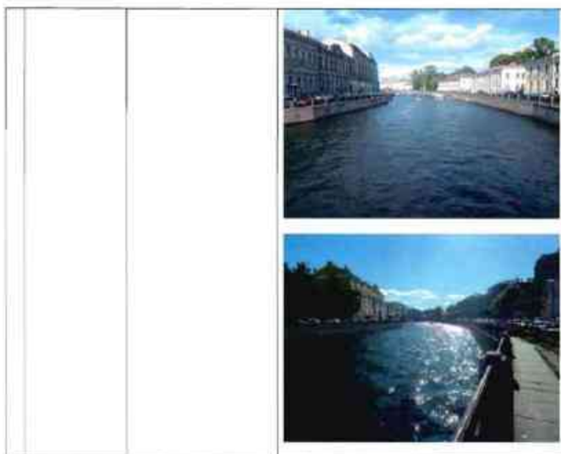
1. «Мост Иохансний Первыи», 1824-1826 гг., инж. Бахсл П.П., 1952-1954 гг., инж. Левин Б.В., 1953 г., арх. Ротин А.Л., расположенный по адресу: Санкт-Петербург, через р. Мойку по р. Фонтанке наб.
