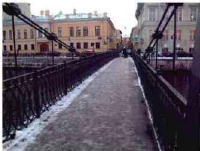
1. Вид на поверхность моста
