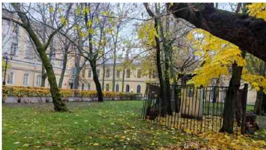
Фото 17. Объект культурного наследия федерального значения «Флигель дамский» (Санкт-Петербург, наб. реки Мойки, 48-50-52, лит. А), входящий в состав объекта культурного наследия федерального значения "Воспитательный дом Императорский" (Санкт-Петербург, Мойки р. наб., 48-54; Гороховая ул., 18; Казанская ул., 3). Фрагмент северного фасада.
