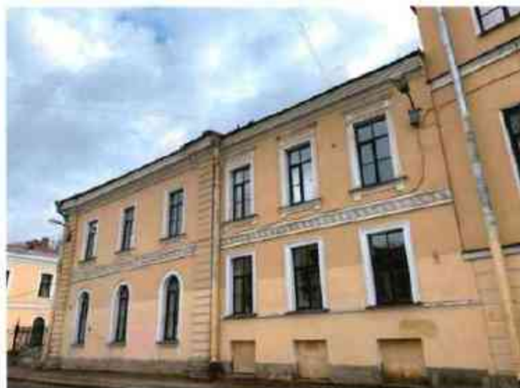
1. Общий вид на объект культурного наследия.
