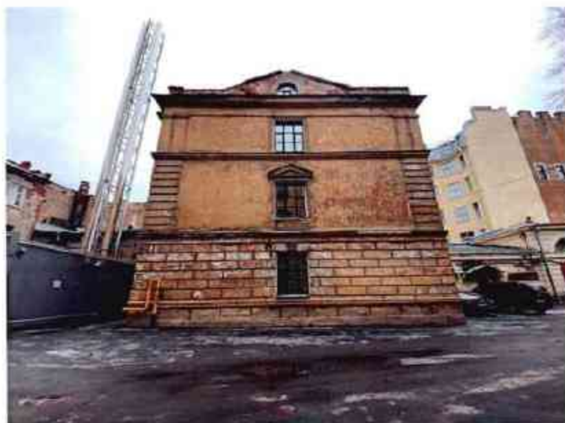
1. Фрагмент южного фасада объекта культурного наследия.
