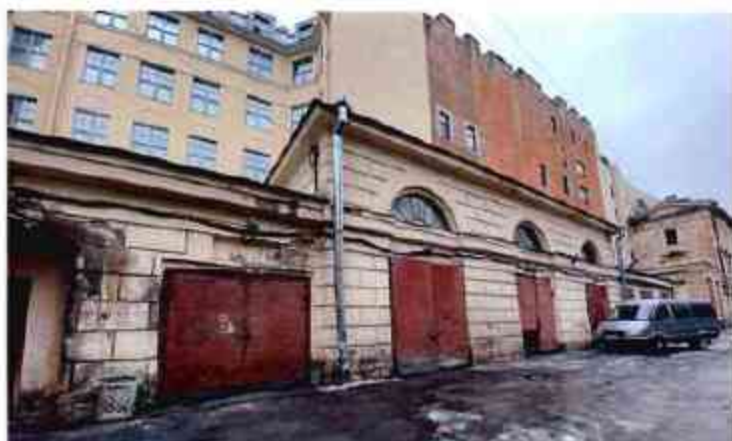
2. Фрагмент южного фасада объекта культурного наследия.
