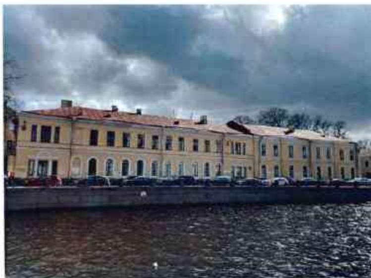
1. Общий вид на объект культурного наследия.
