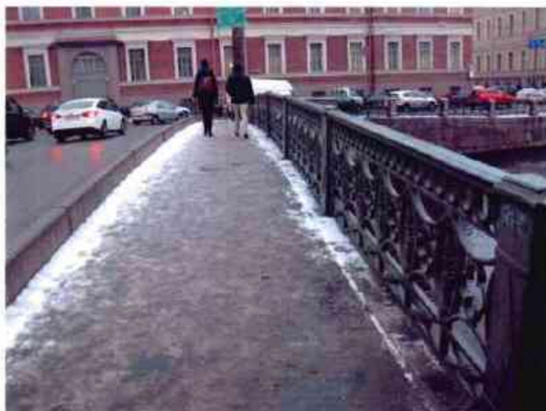
5. Перильное ограждение, тротуар, цикловое ограждение (со стороны верхнего фасада)
