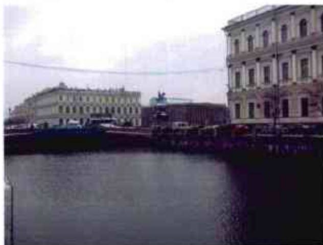
1. Вид моста со стороны верхового фасада
