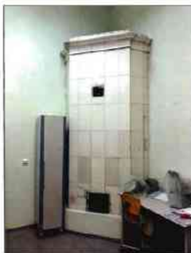
9. Печь. Помещение № 19-Н (94). (фотофиксация выполнена 18.02.2021)
