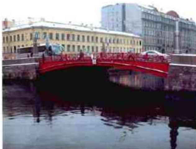
2. Вид моста со стороны верхнего фасада
