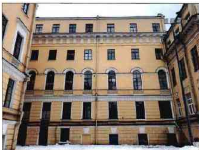
3. Восточный фасад объекта культурного наследия. Общий вид. (фотофиксация выполнена 26.02.2021)
