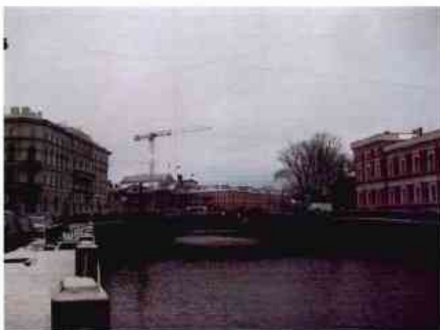
2. Вид моста со стороны верхового фасада
