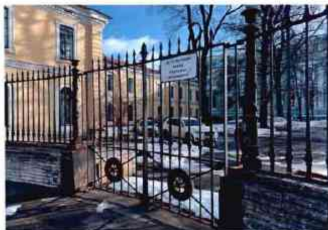
2. Общий вид на объект культурного наследия.
