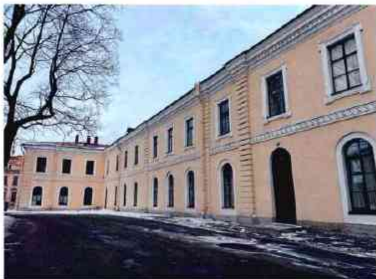
2. Общий вид на объект культурного наследия.
