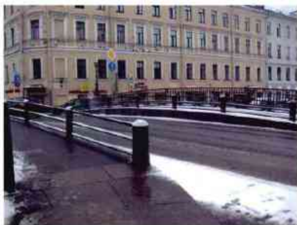
1. Вид на поверхность моста и силовое отражение
