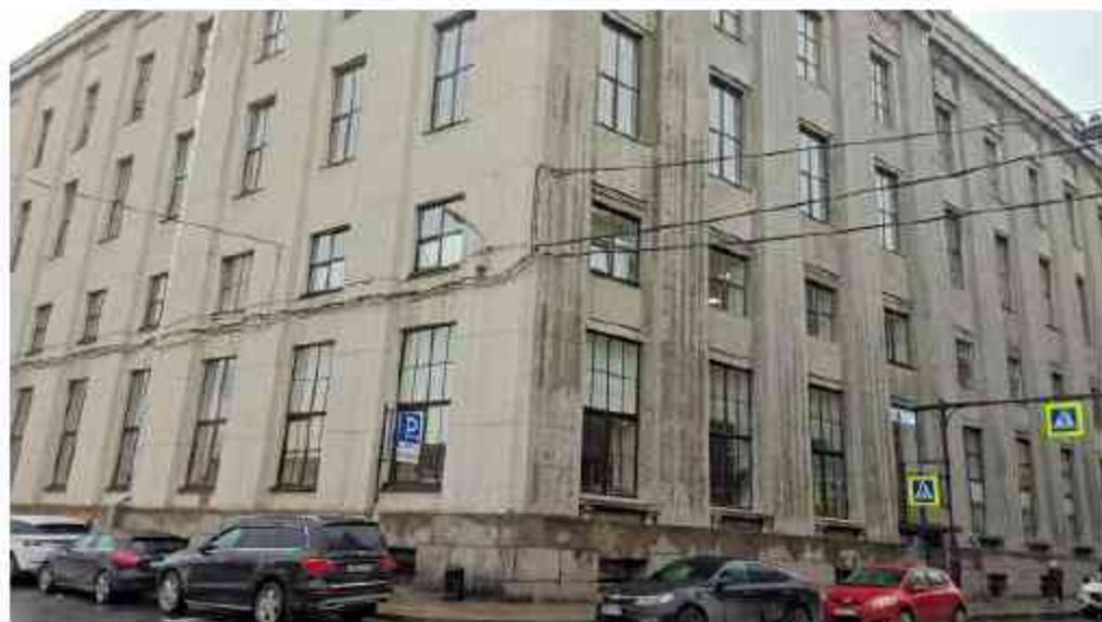
Фото 2. Выявленный объект культурного наследия "Здание Русского банка для внешней торговли (здание Текстильного института)" (Санкт-Петербург, Большая Морская ул., 18; Мойки р. наб., 63; Кирпичный пер., 5). Общий вид с восточной стороны.
