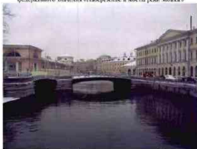
1. Верховой фасад моста со стороны реки Мойки
