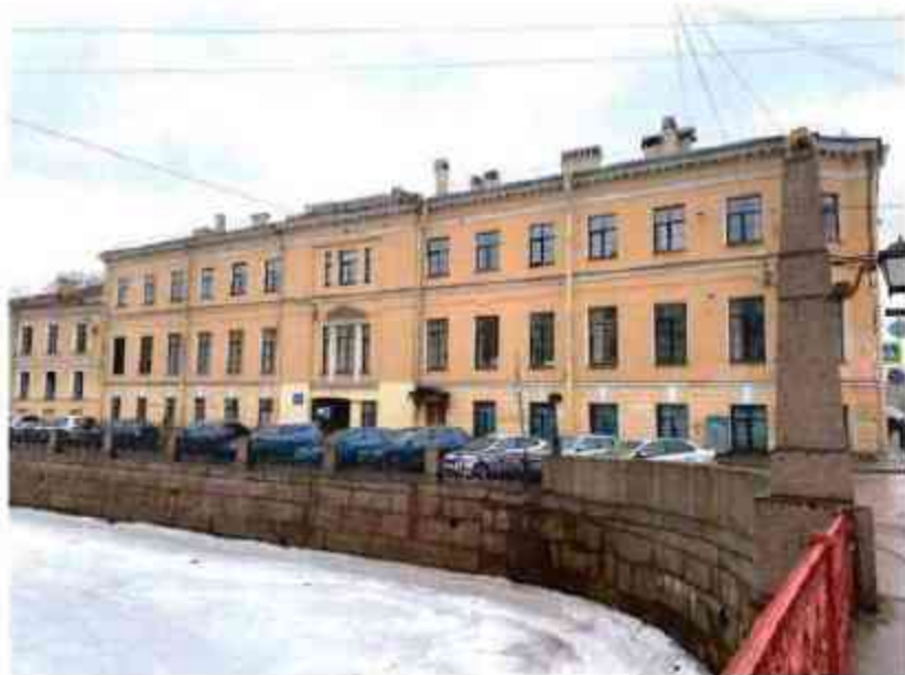
1. Северо-западный лицевой фасад объекта культурного наследия.
