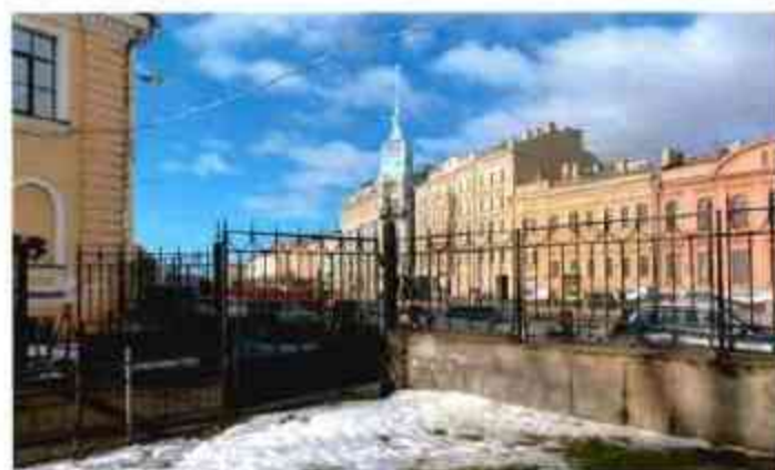
2. Общий вид на объект культурного наследия.
