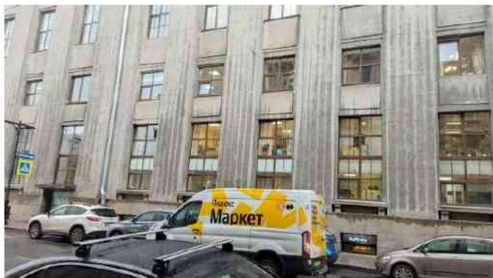
Фото 1. Выявленный объект культурного наследия "Здание Русского банка для внешней торговли (здание Текстильного института)" (Санкт-Петербург, Большая Морская ул., 18; Мойки р. наб., 63; Кирпичный пер., 5). Фрагмент северо-восточного фасада.
