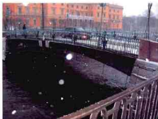
2. Вид моста со стороны верхового фасада
