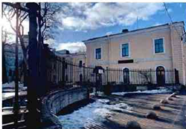
1. Общий вид на объект культурного наследия.
