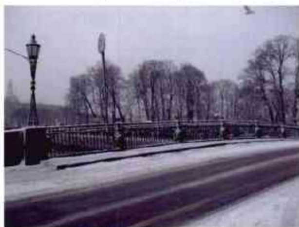
1. Вид на поверхность моста
