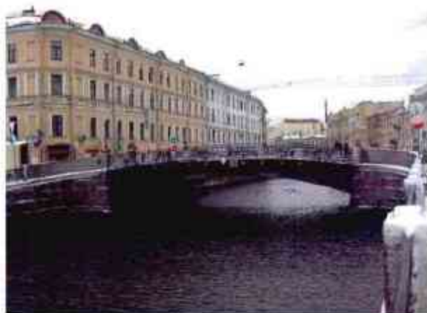
2. Вид моста со стороны верхового фасада
