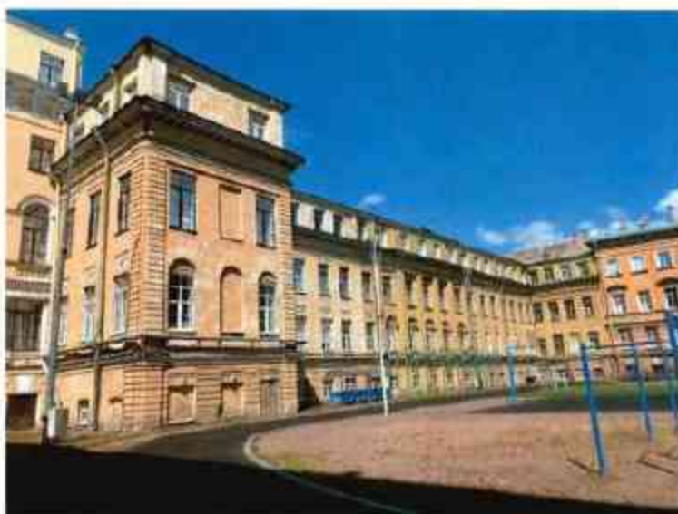
2. Общий вид на объект культурного наследия.
