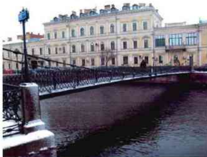
2. Вид моста со стороны верхнего фасада
