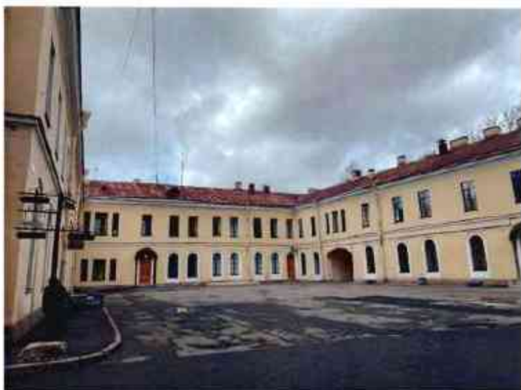
2. Общий вид на объект культурного наследия.
