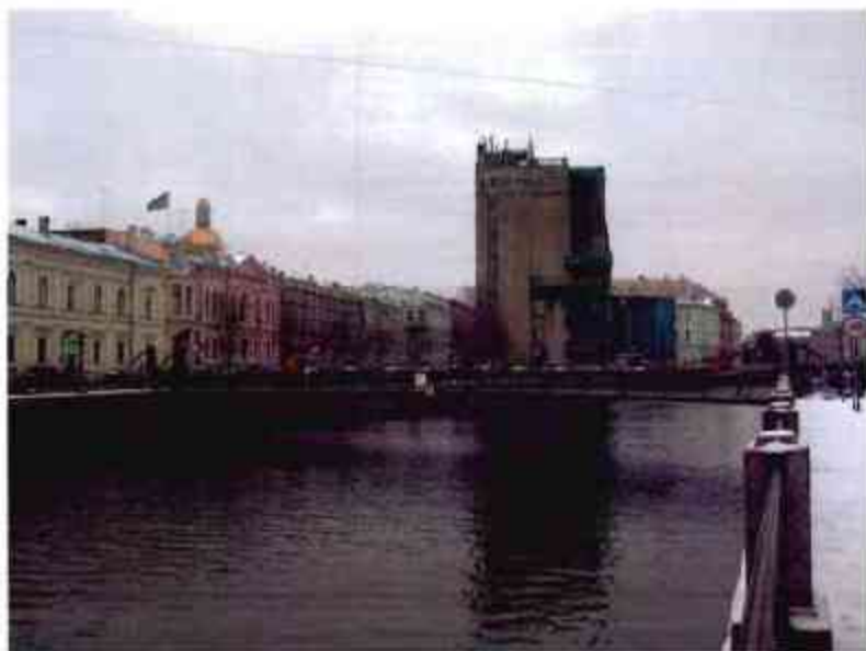
6. Вид моста со стороны низового фасада
