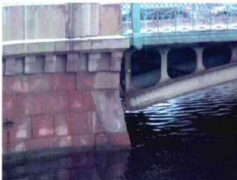
3. Левобережный устой, металлическое пролетное строение, решетка перильного ограждения (фрагмент, верхней фасада)
