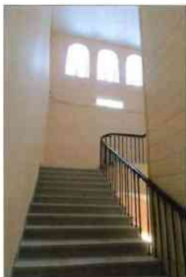
4. Интерьер. Фрагмент. Северо-западная лестница
