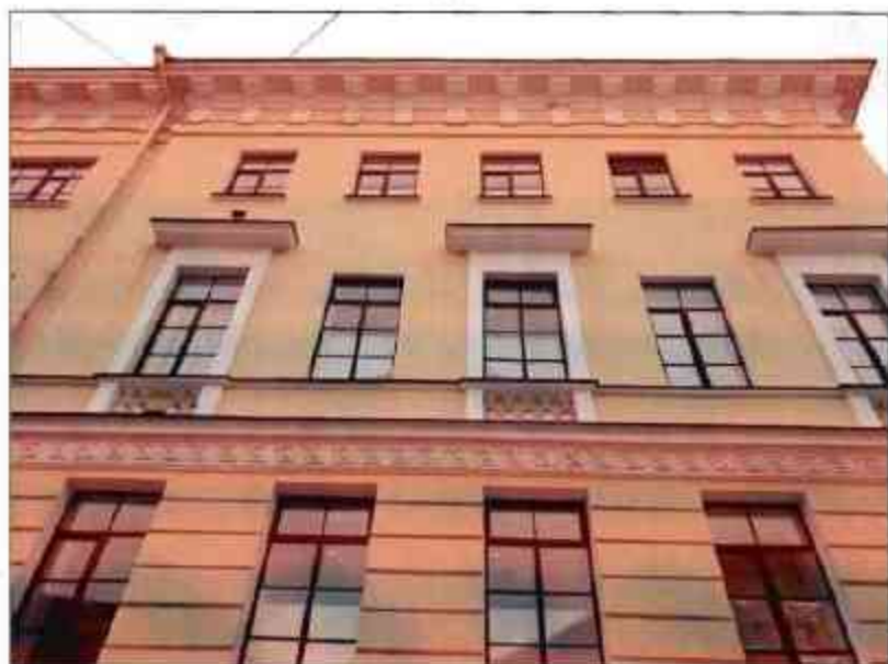
2. Общий вид на юго-западный фасад объекта культурного наследия. Фрагмент.
