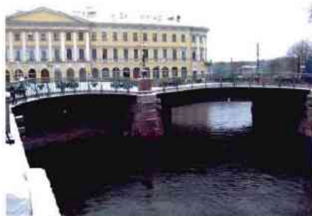
2. Низовой фасад моста со стороны канала Грибоедова (слева ложный арочный свод, имитирующий третий мост)
