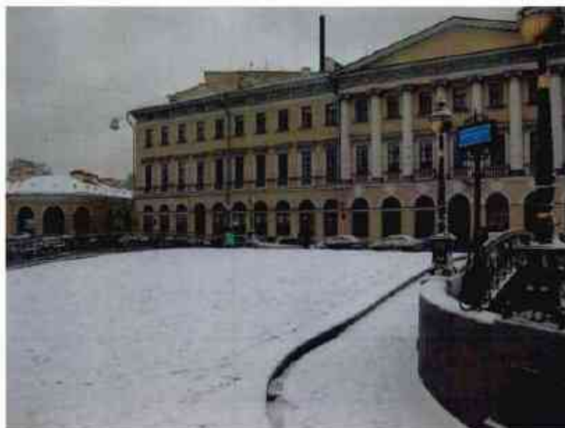
8. Вид на поверхность моста
