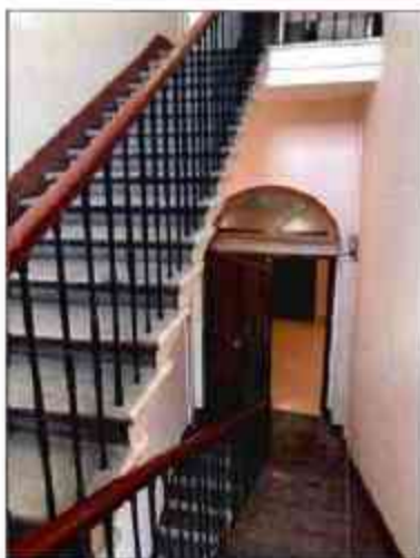
6. Лестница Л12. Общий вид. (фотофиксация выполнена 18.02.2021)
