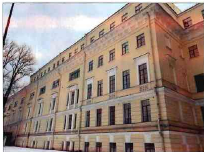
3. Общий вид на северо-восточный фасад объекта культурного наследия.
