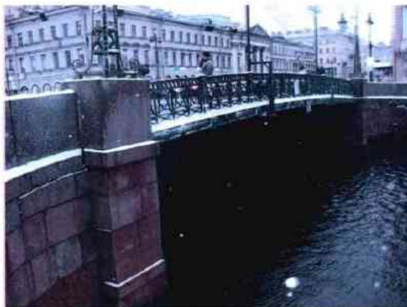
6. Вид моста со стороны низового фасада
