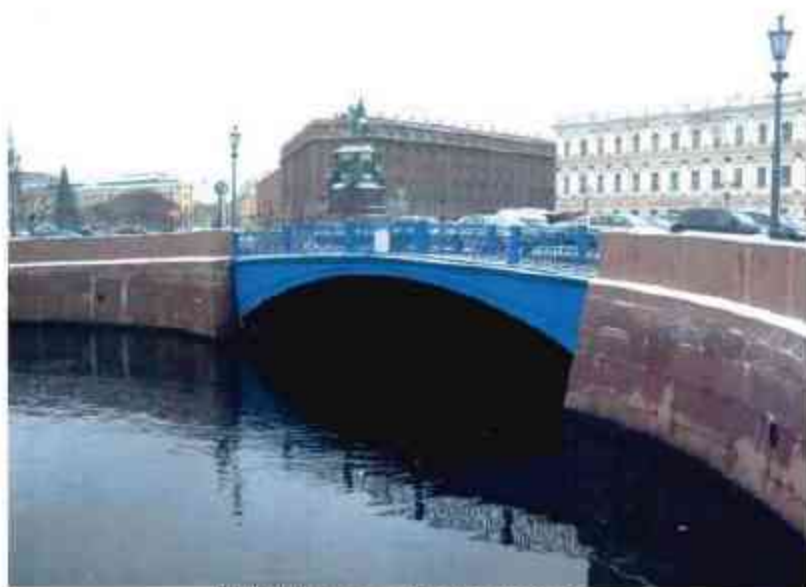
7. Вид моста со стороны низового фасада
