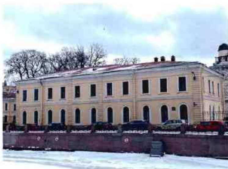
1. Общий вид на объект культурного наследия.
