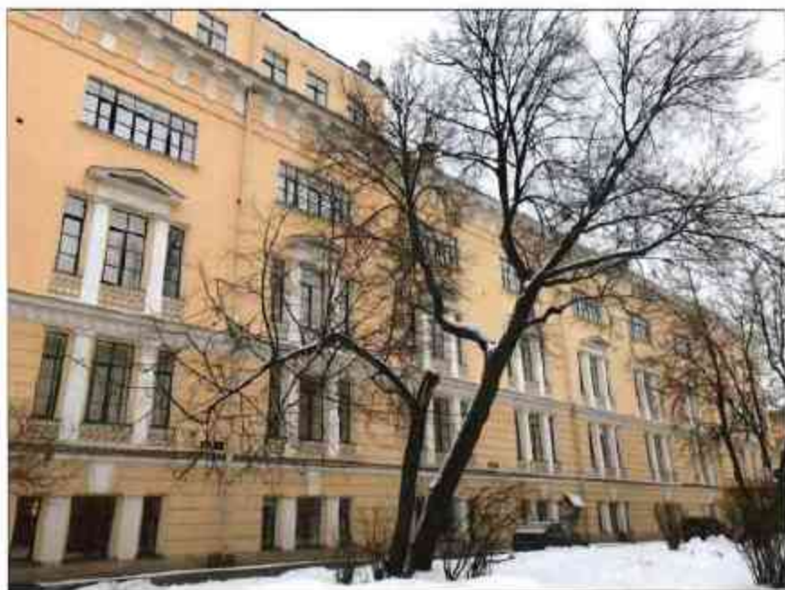
1. Общий вид на юго-западный фасад объекта культурного наследия.
