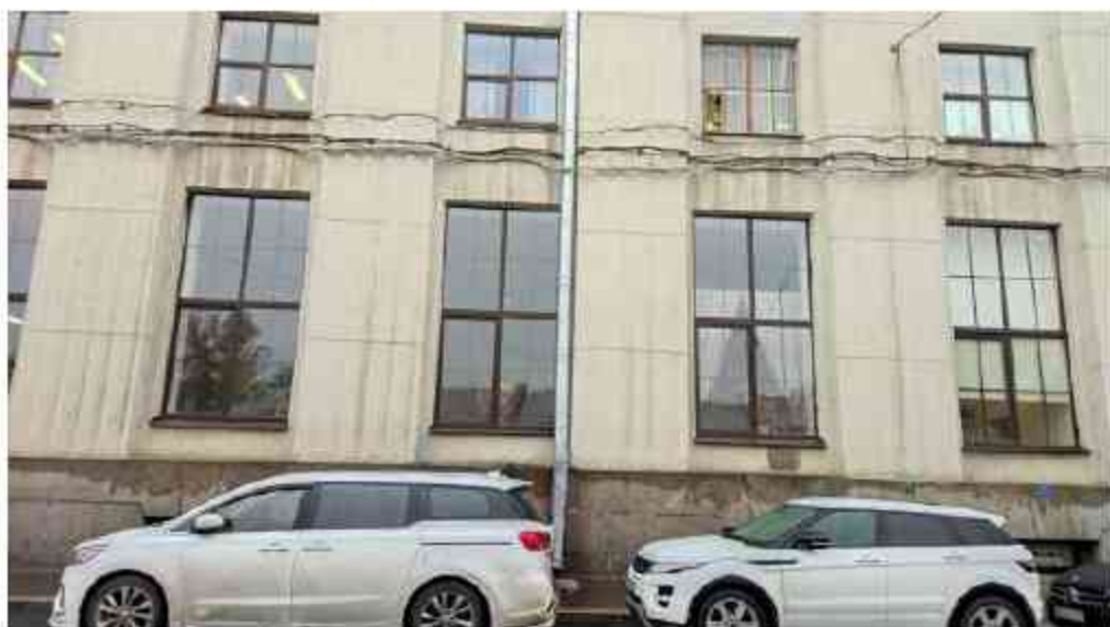
Фото 3. Выявленный объект культурного наследия "Здание Русского банка для внешней торговли (здание Текстильного института)" (Санкт-Петербург, Большая Морская ул., 18; Мойки р. наб., 63; Кирпичный пер., 5). Фрагмент южного фасада.
