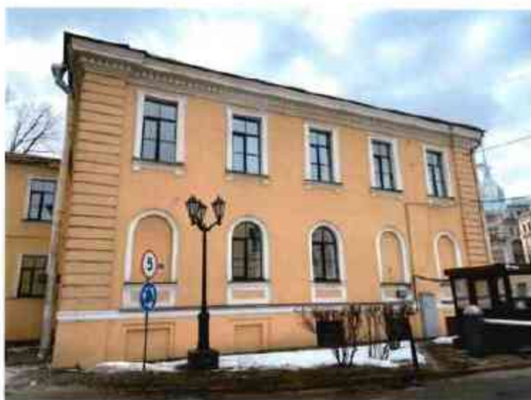
2. Общий вид на объект культурного наследия.
