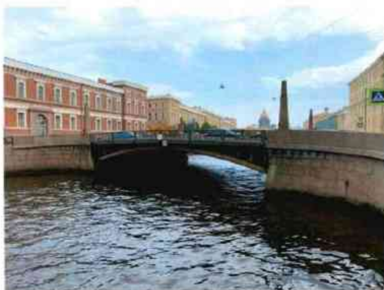
1. Общий вид на объект культурного наследия.
