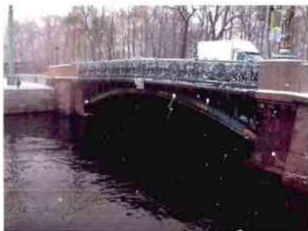
2. Вид моста со стороны верхнего фасада
