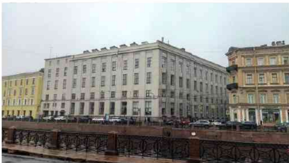
Фото 12. Выявленный объект культурного наследия "Здание Русского банка для внешней торговли (здание Текстильного института)" (Санкт-Петербург, Большая Морская ул., 18; Мойки р. наб., 63; Кирпичный пер., 5). Общий вид с восточной стороны.
