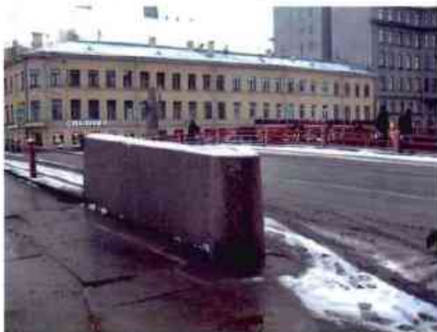
1. Вид на поверхность моста
