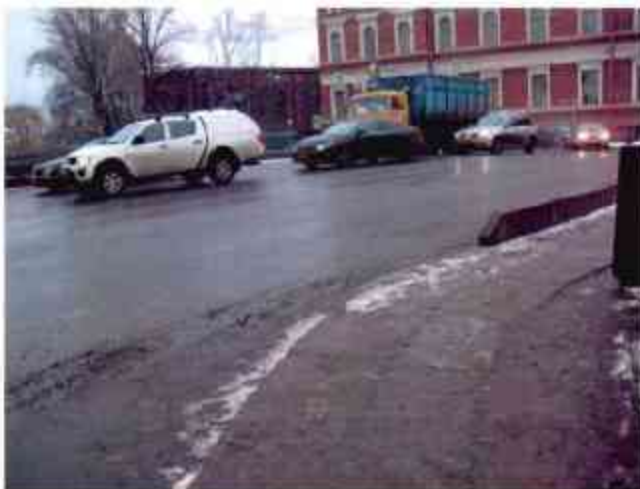
1. Вид на поверхность моста
