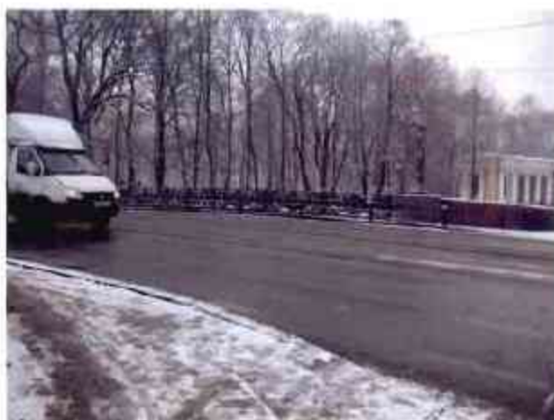
1. Вид на поверхность моста
