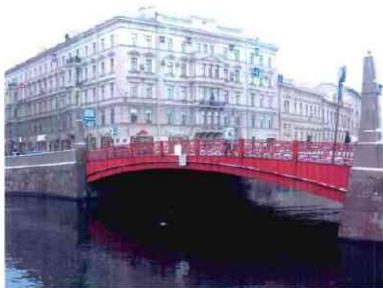
7. Вид моста со стороны низового фасада
