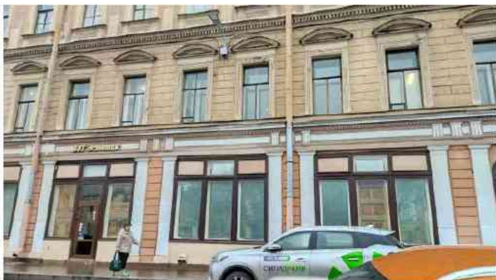
Фото 7. Объект культурного наследия регионального значения "Дом, где в конце 1906 г. проходили заседания ЦК и ПК РСДРП" (Санкт-Петербург, Большая Морская ул., 16; Кирпичный пер., 8). Фрагмент восточного фасада.
