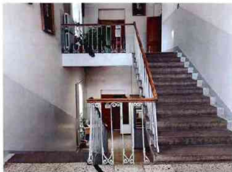
3. Общий вид на лестницу объекта культурного наследия.
