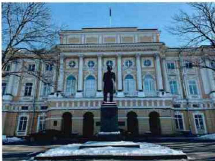
1. Общий вид на западный фасад объекта культурного наследия.
