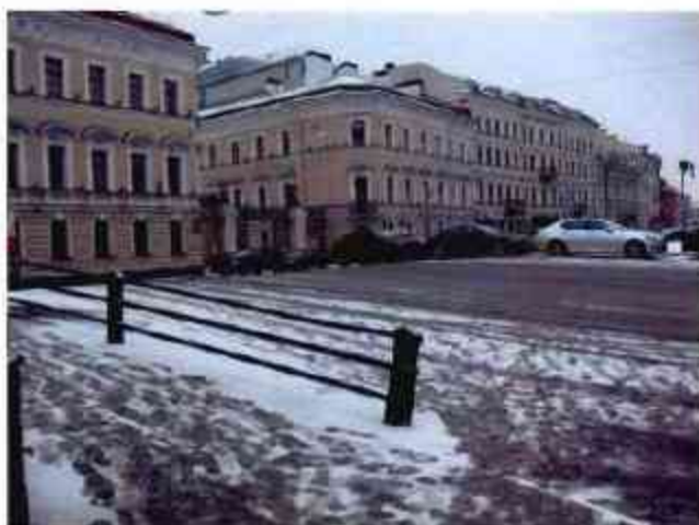
1. Вид на поверхность моста
