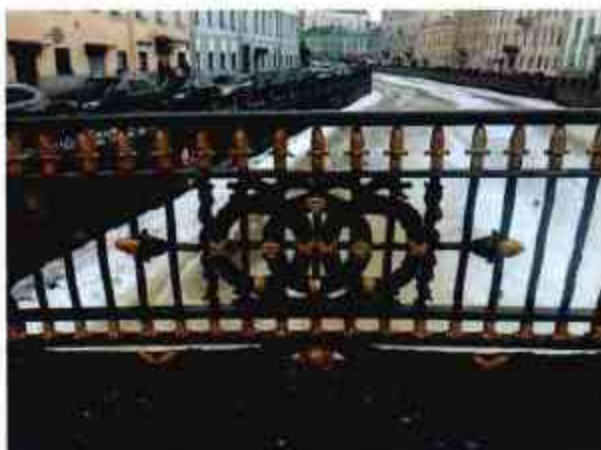
2. Фрагмент решетки перильного ограждения
