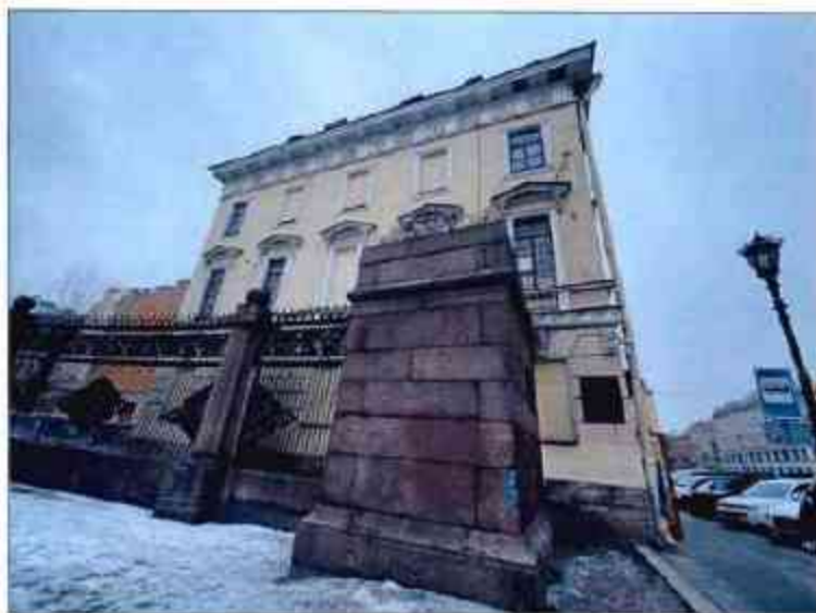
2. Южный лицевой фасад объекта культурного наследия.
