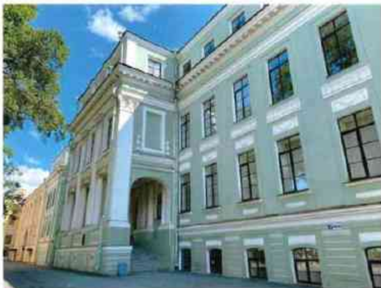
1. Общий вид на объект культурного наследия.
