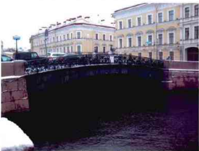
6. Вид моста со стороны низового фасада
