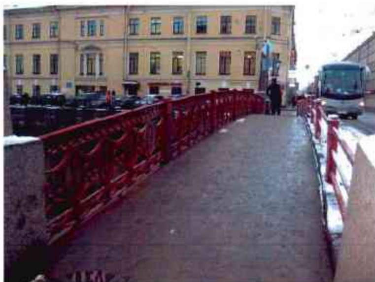
4. Перильное ограждение, тротуар, сидовое ограждение (со стороны верхнего фасада)
