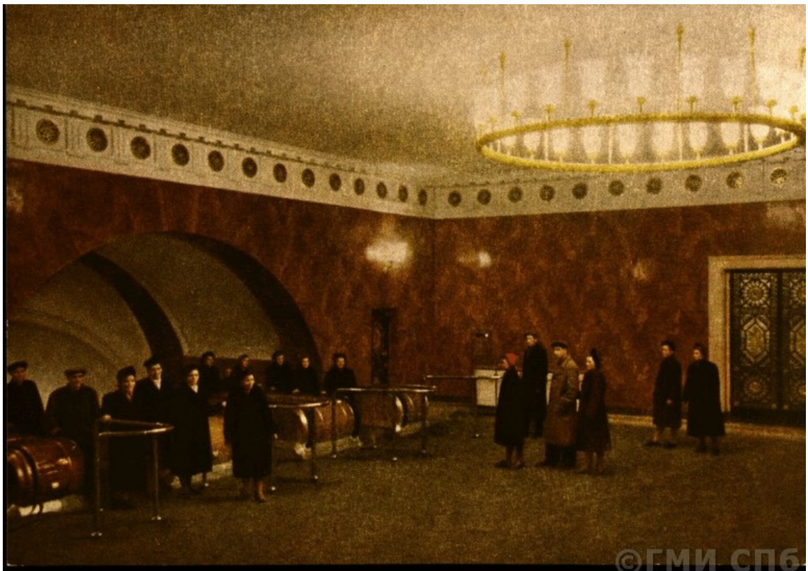
Илл. 9. Ленинградский метрополитен им. В. И. Ленина. Станция «Технологический институт». Эскалаторный зал. 1956 г. СПб ГБУК «Государственный музей истории Санкт-Петербурга». ГМИ СПб Инв.№-I-Б-3758 р.
