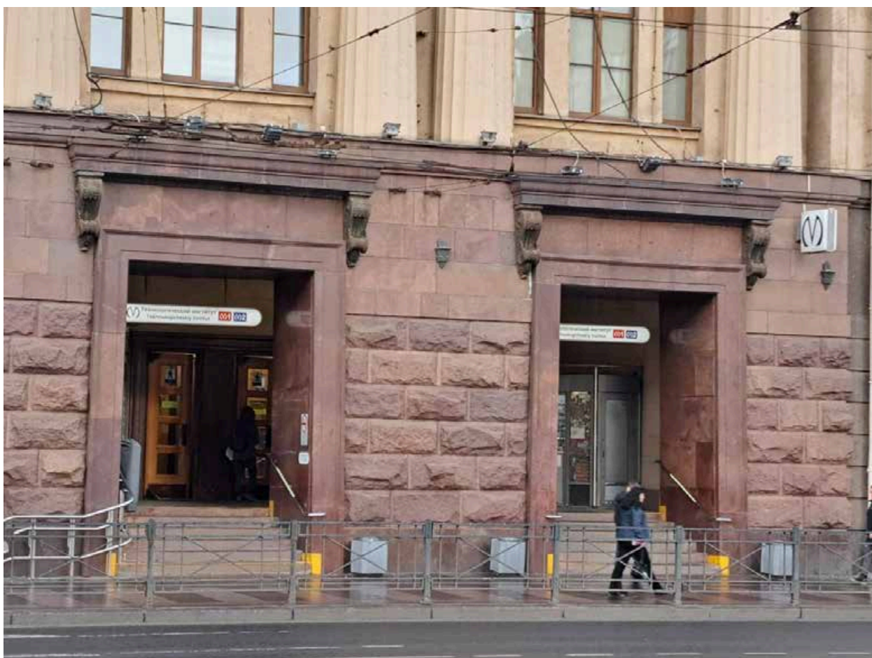
Фото №6. Западный фасад, вход.
