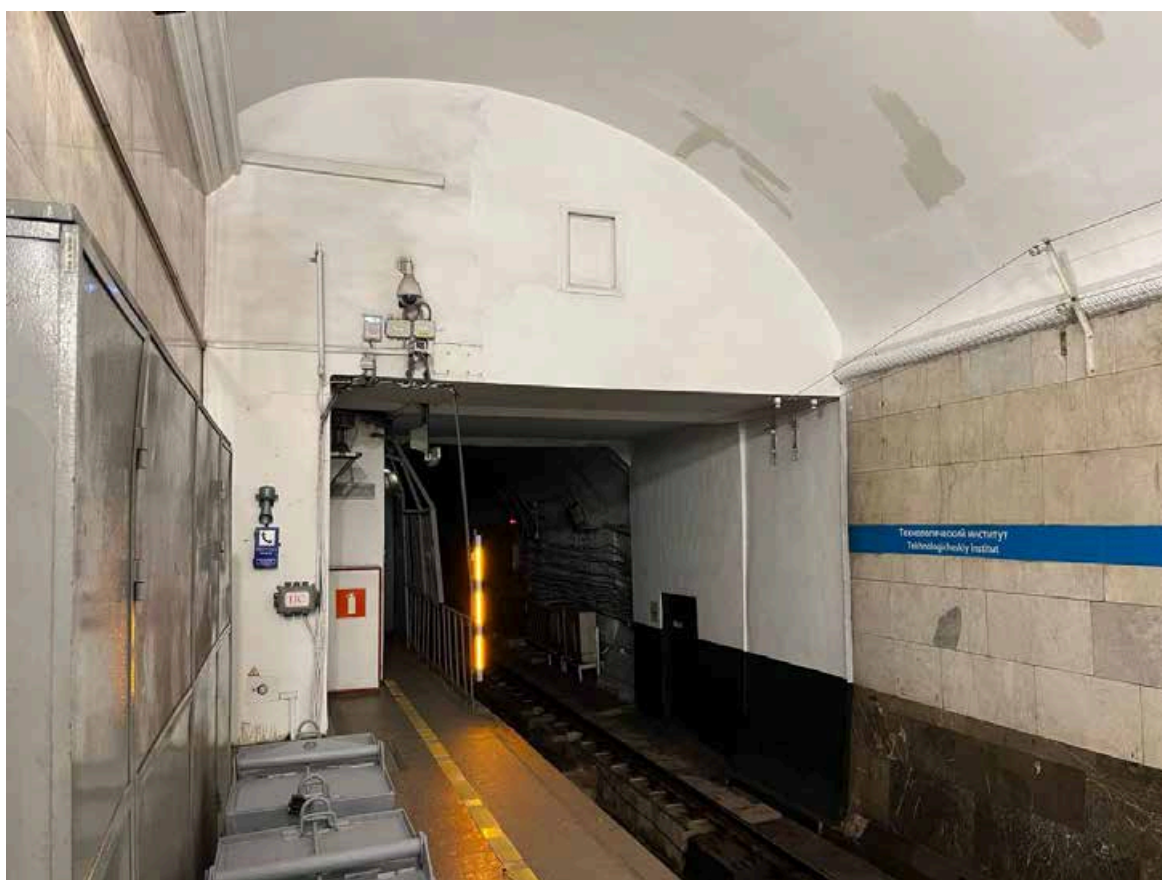
Фото №40. Вестибюль перронного зала, боковой неф.
