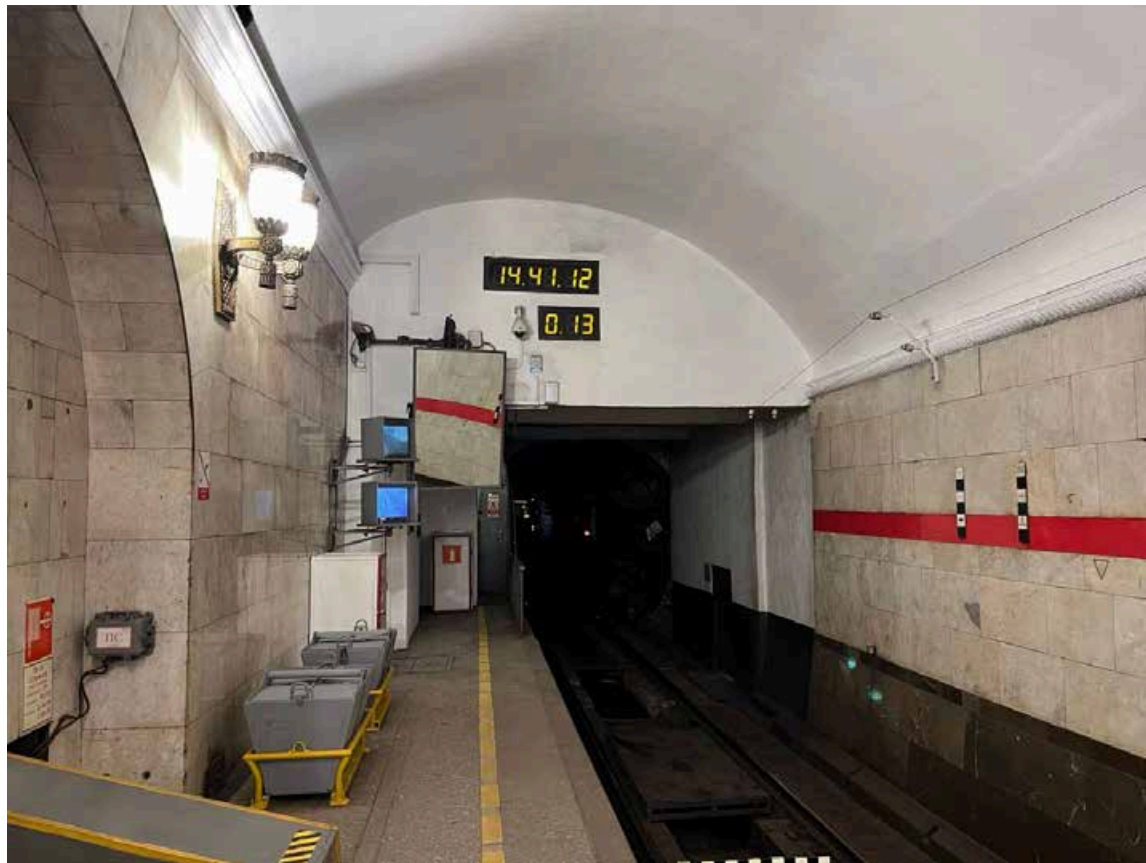
Фото №42. Вестибюль перронного зала, боковой неф.
