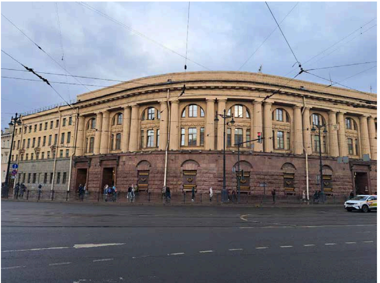
Фото №1. Северо-западный фасад
