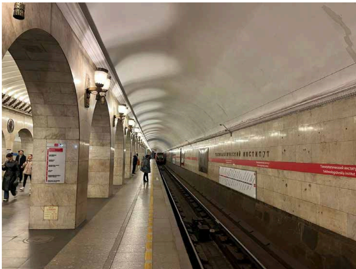
Фото №45. Вестибюль перронного зала, боковой неф.
