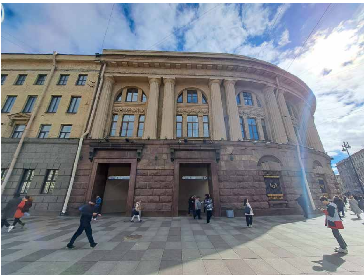
Фото №4. Северо-западный фасад, фрагмент.
