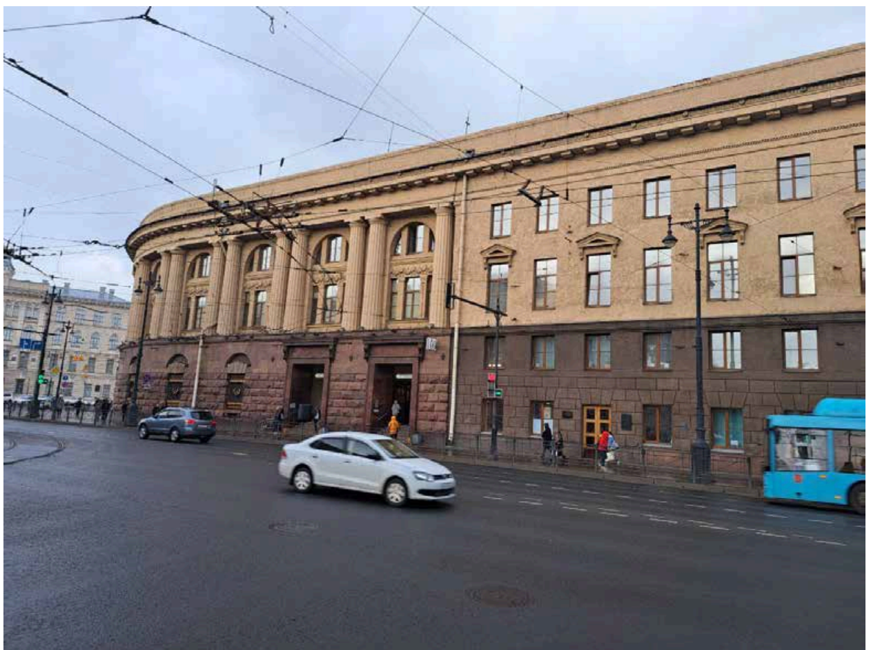
Фото №3. Западный фасад.
