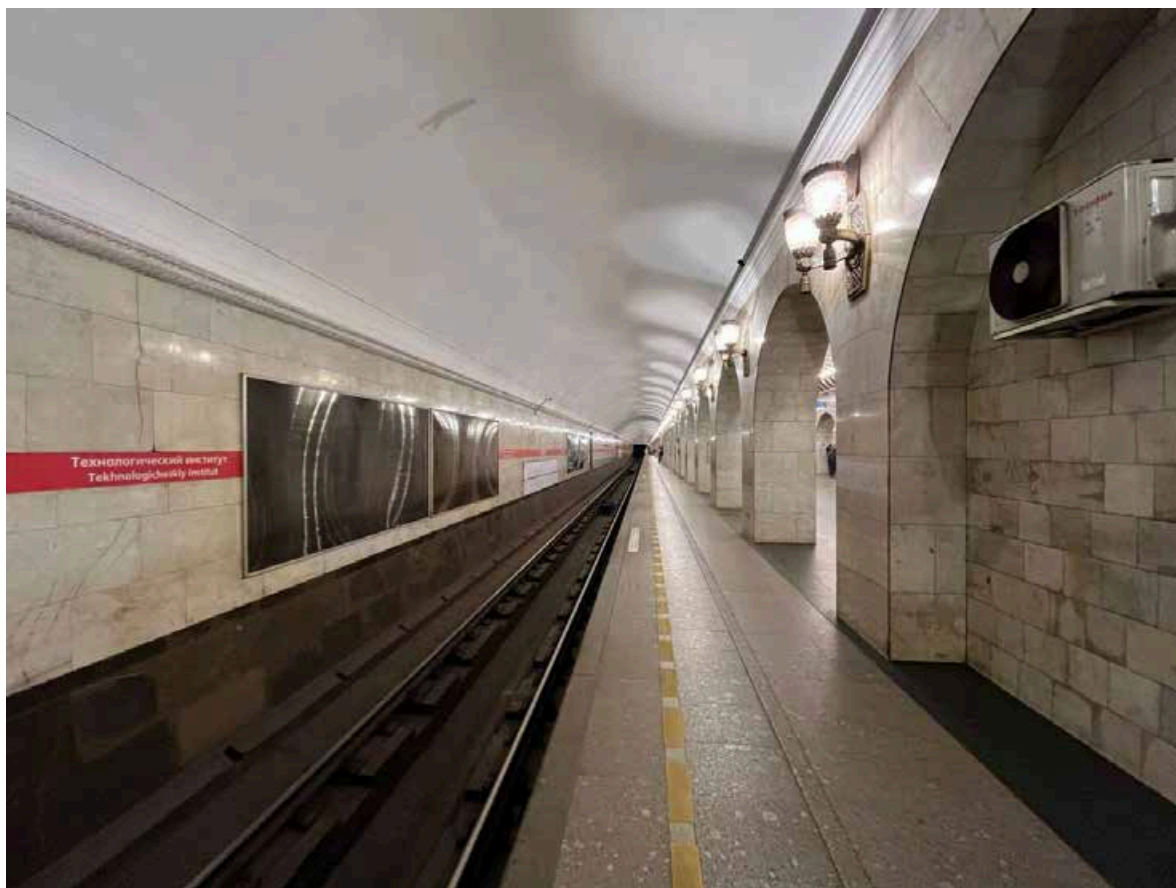
Фото №43. Вестибюль перронного зала, боковой неф.
