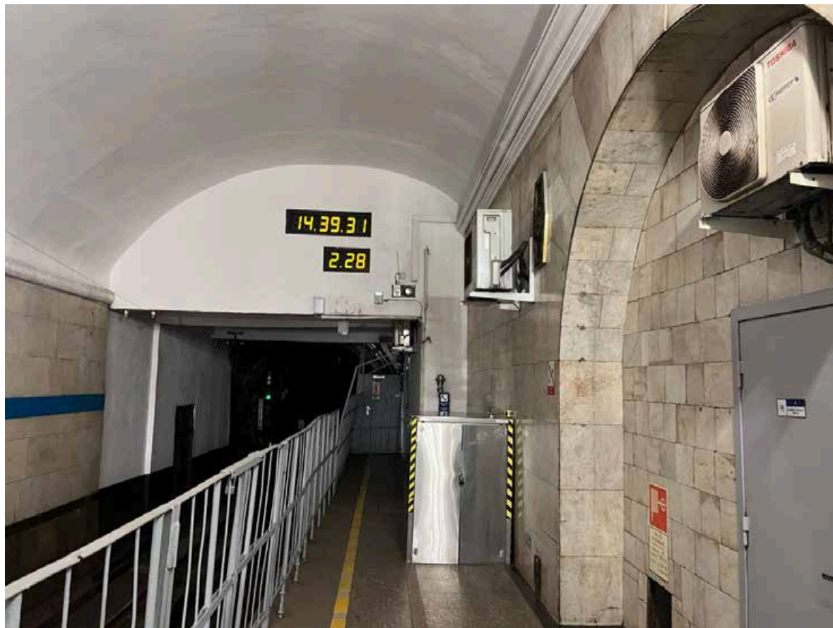
Фото №44. Вестибюль перронного зала, боковой неф.
