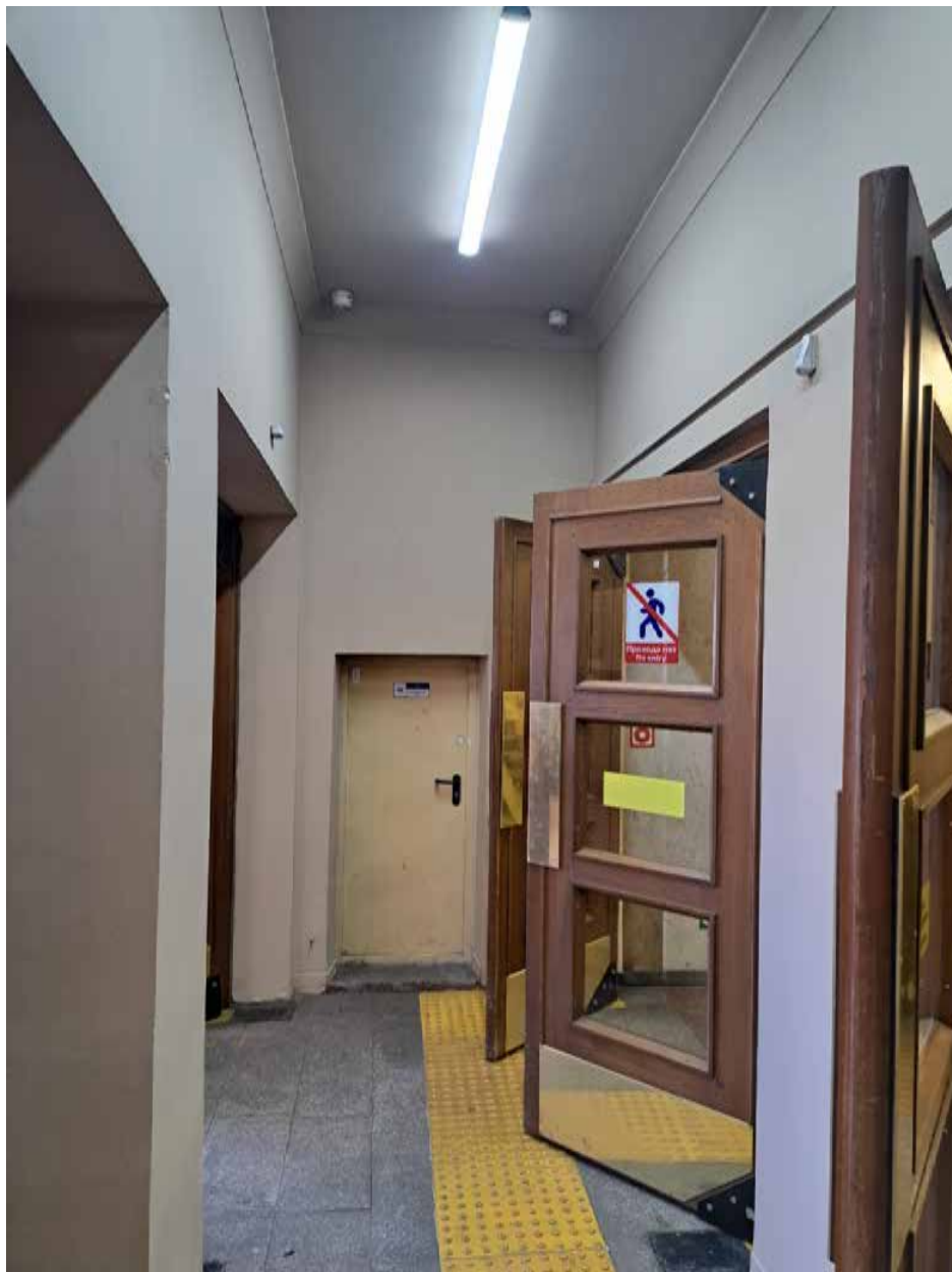
Фото №11. Вестибюль наземной части, пом. 2-Н (48).
