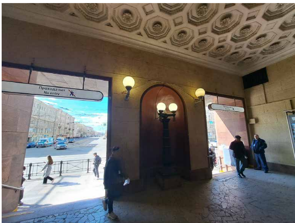
Фото №21. Западный фасад, вход.
