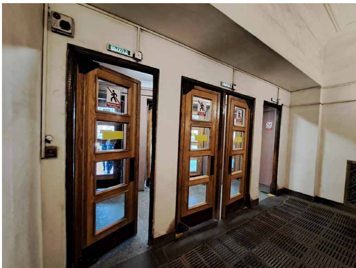
Фото №23. Вестибюль наземной части, пом. 2-Н (65).
