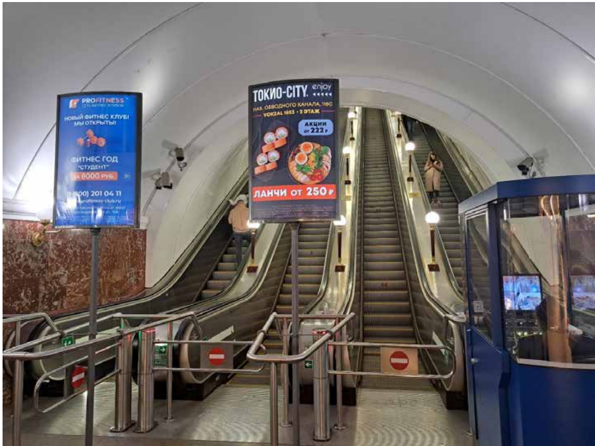
Фото №37. Вестибюль перронного зала, эскалаторы.
