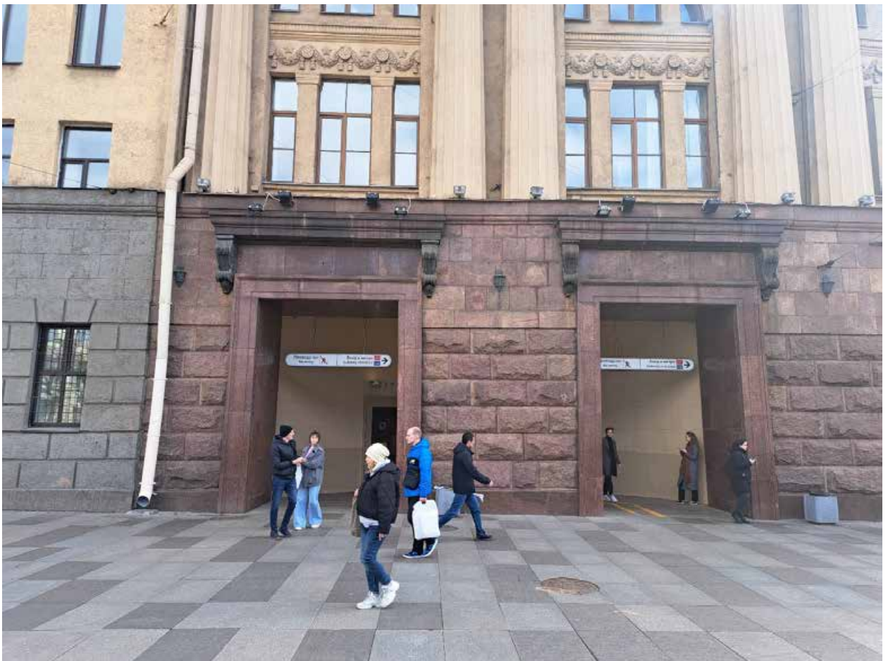
Фото №5. Северо-западный фасад, выход.
