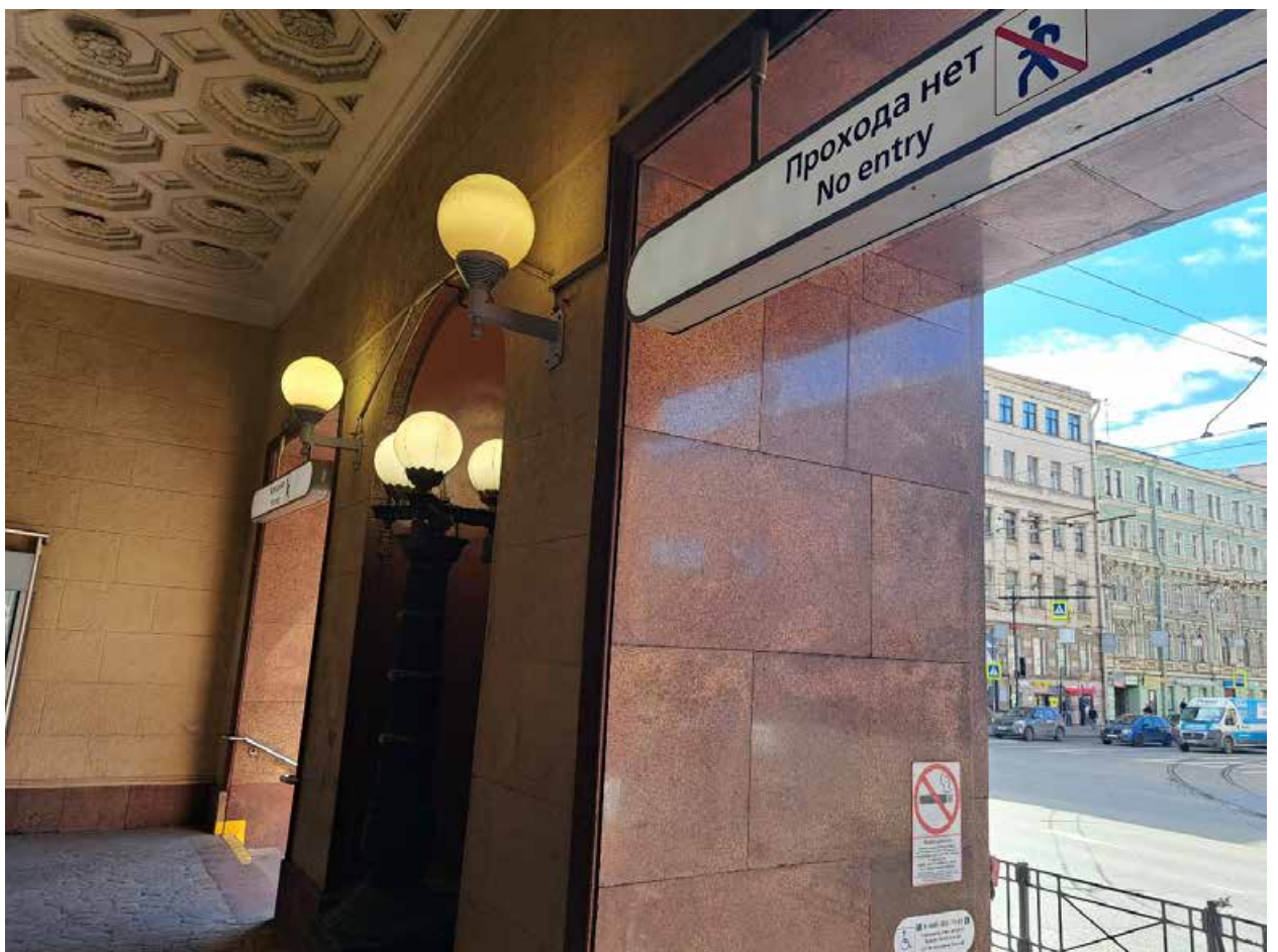
Фото №20. Западный фасад, вход.
