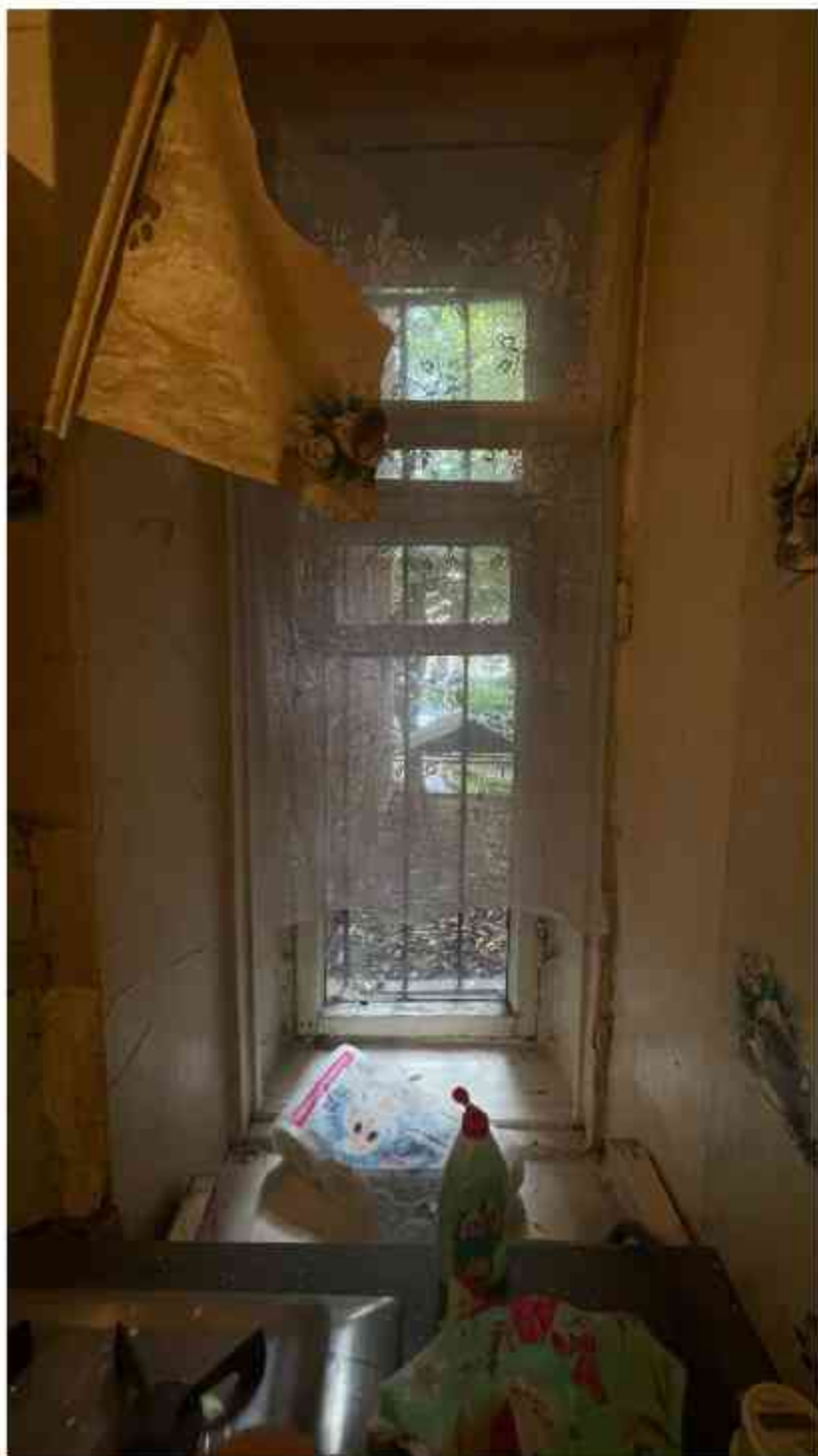
13. Вид на оконное заполнение на кухне (помещение 5.7);
