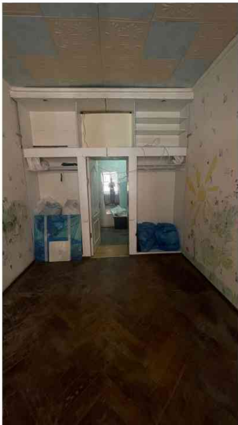
6. Фрагмент интерьера комнаты (помещение 2/14.3);
