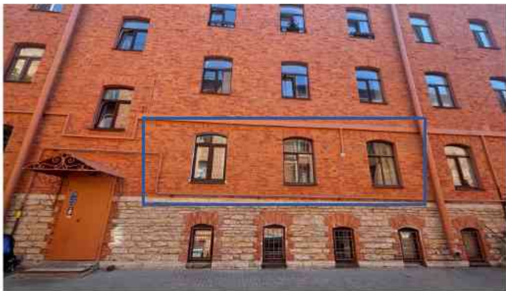
1. Вид на фасад объекта культурного наследия регионального значения «Дворовой корпус, 1904 г.» и окна квартиры;
