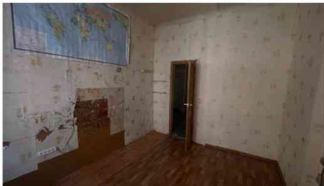
11. Фрагмент интерьера комнаты (помещение 4/11.8);
