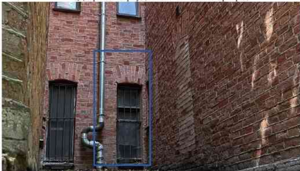
2. Вид на фасад объекта культурного наследия регионального значения «Дворовой корпус, 1904 г.» и окна квартиры;
