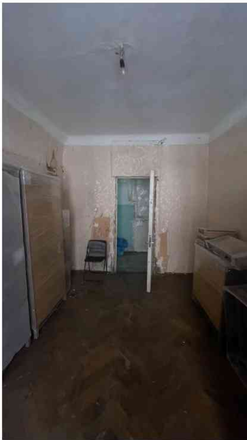
8. Фрагмент интерьера комнаты (помещение 3/14.3);
