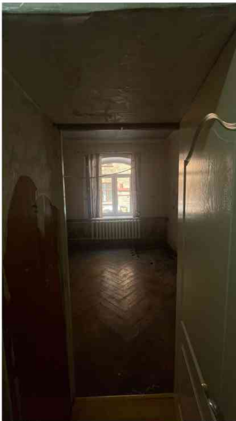
5. Фрагмент интерьера комнаты (помещение 2/14.3);
