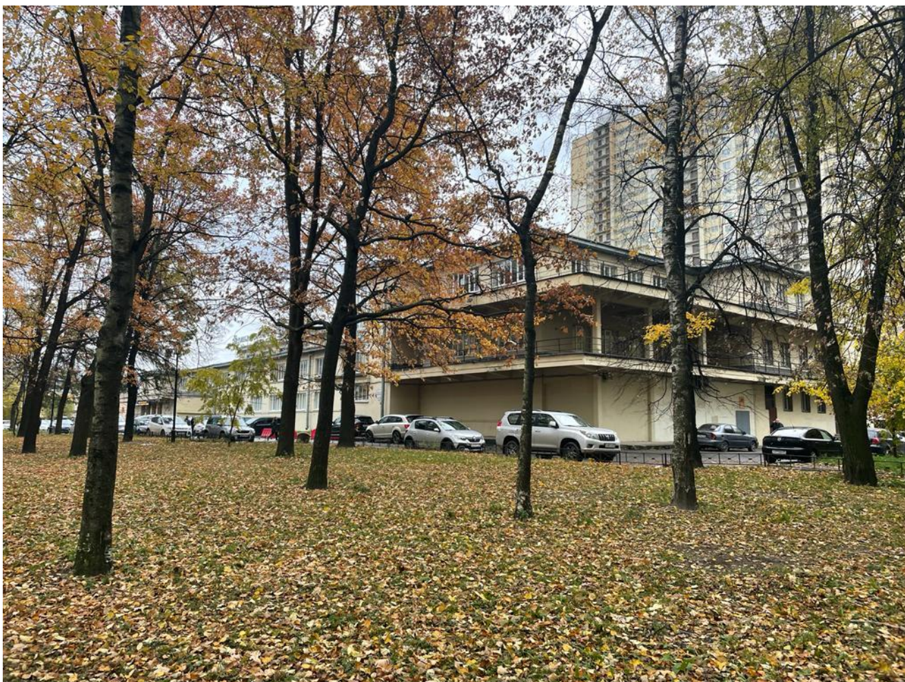
21. Выявленный объект культурного наследия «Дом культуры им. В. И. Ленина завода «Большевик», 1927–1929 гг., г. Санкт-Петербург, проспект Обуховской Обороны, 223, литера А.
