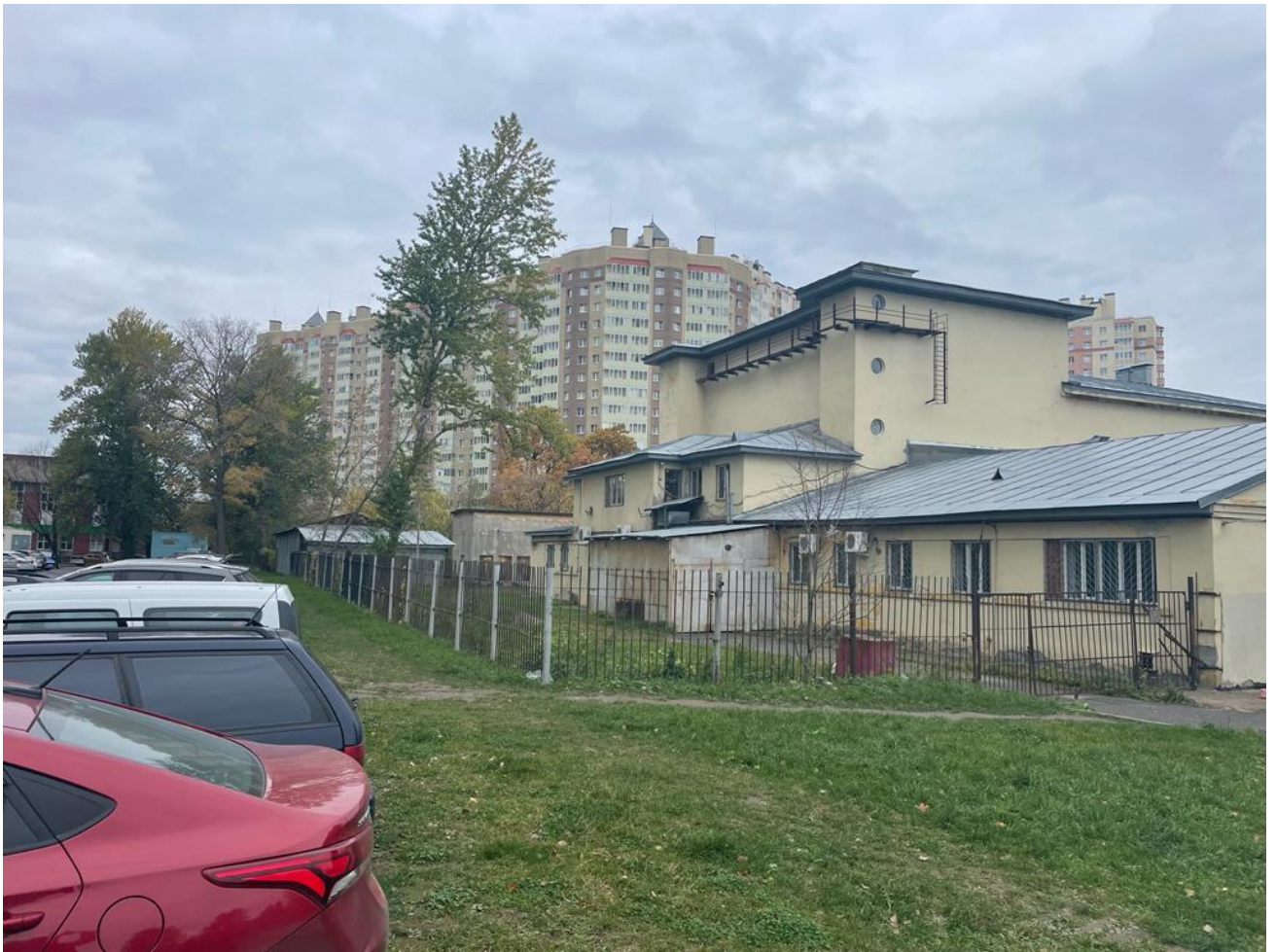
11. Выявленный объект культурного наследия «Дом культуры им. В. И. Ленина завода «Большевик», 1927–1929 гг., г. Санкт-Петербург, проспект Обуховской Обороны, 223, литера А.
