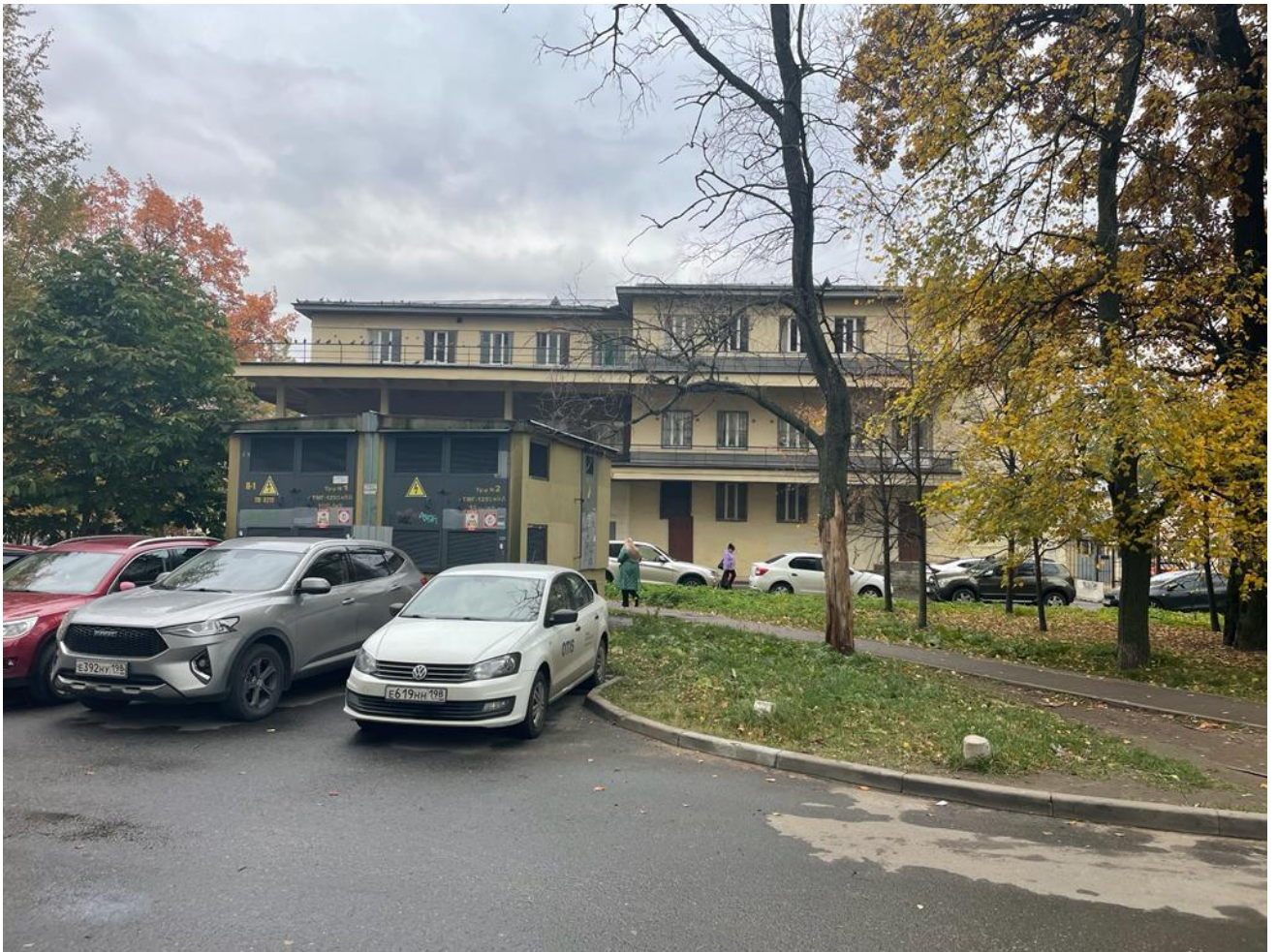
18. Выявленный объект культурного наследия «Дом культуры им. В. И. Ленина завода «Большевик», 1927–1929 гг., г. Санкт-Петербург, проспект Обуховской Обороны, 223, литера А.
