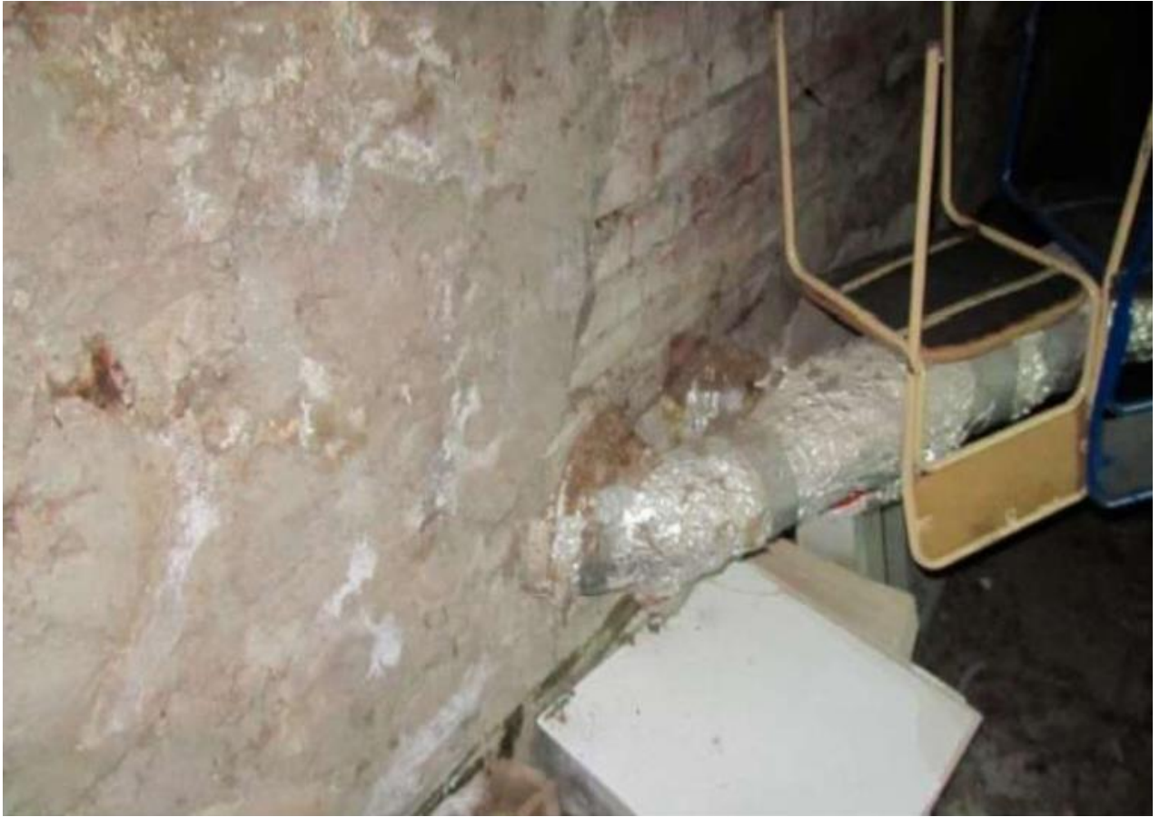
25. Выявленный объект культурного наследия «Дом культуры им. В. И. Ленина завода «Большевик», 1927–1929 гг., г. Санкт-Петербург, проспект Обуховской Обороны, 223, литера А. Вход в подвальное помещение.
