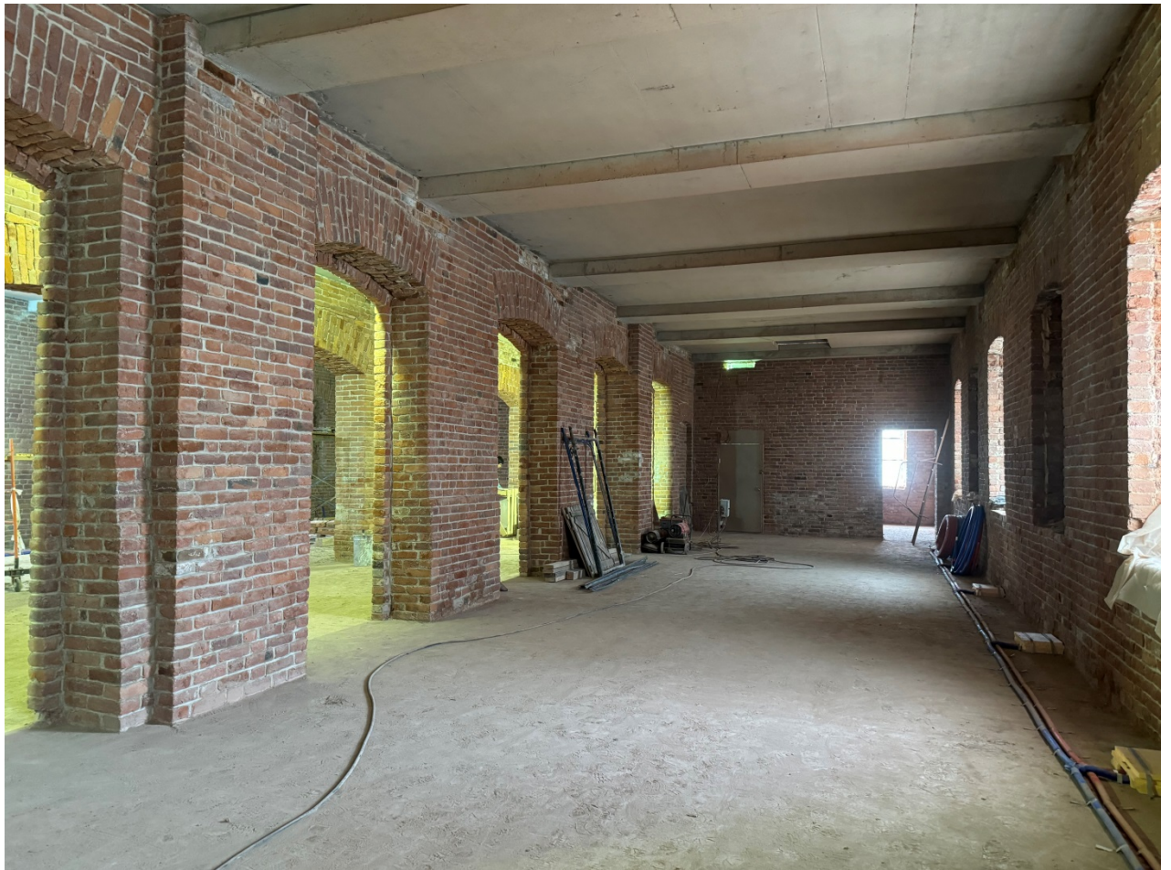
11. Объект культурного наследия регионального значения «Товарная контора Варшавского вокзала».
