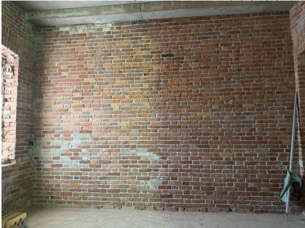
15. Объект культурного наследия регионального значения «Товарная контора Варшавского вокзала».
