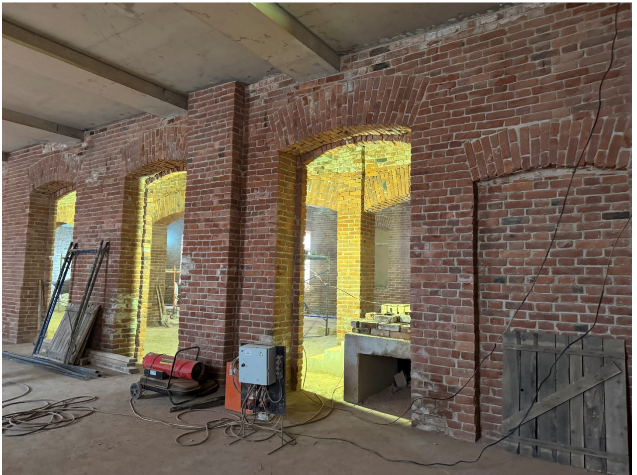
12. Объект культурного наследия регионального значения «Товарная контора Варшавского вокзала».
