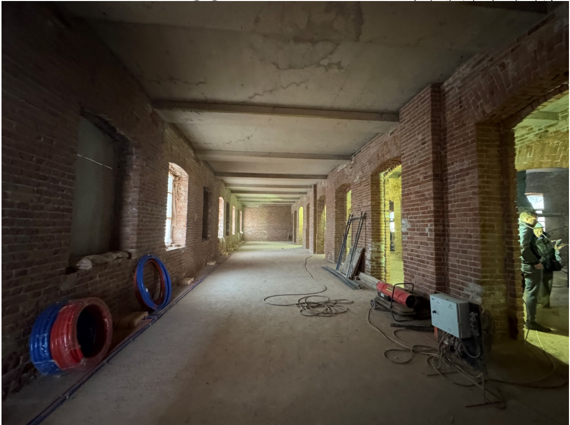
14. Объект культурного наследия регионального значения «Товарная контора Варшавского вокзала».
