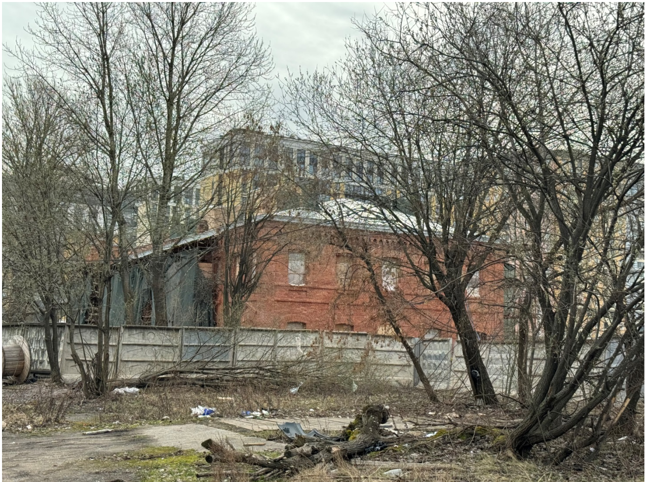
3. Объект культурного наследия регионального значения «Товарная контора Варшавского вокзала».
