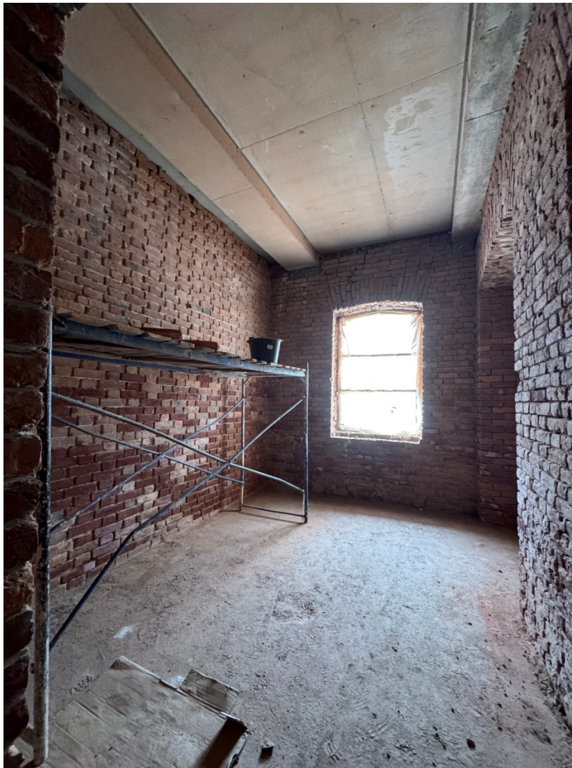
13. Объект культурного наследия регионального значения «Товарная контора Варшавского вокзала».
