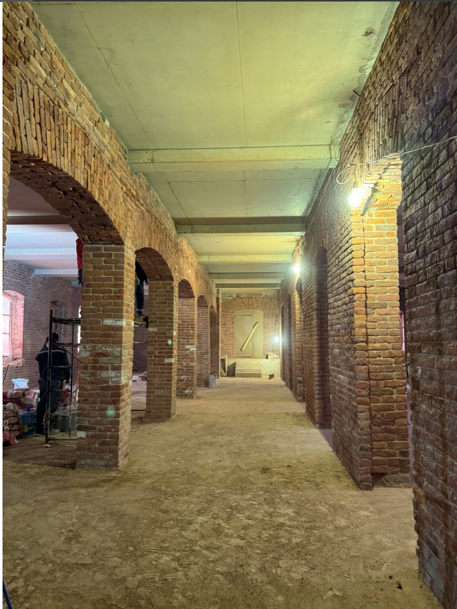
10. Объект культурного наследия регионального значения «Товарная контора Варшавского вокзала».
