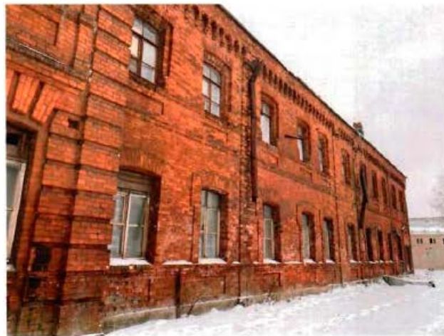
2. Общий вид на объект культурного наследия.
