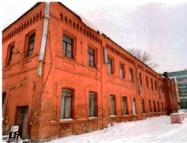
1. Общий вид на объект культурного наследия.
