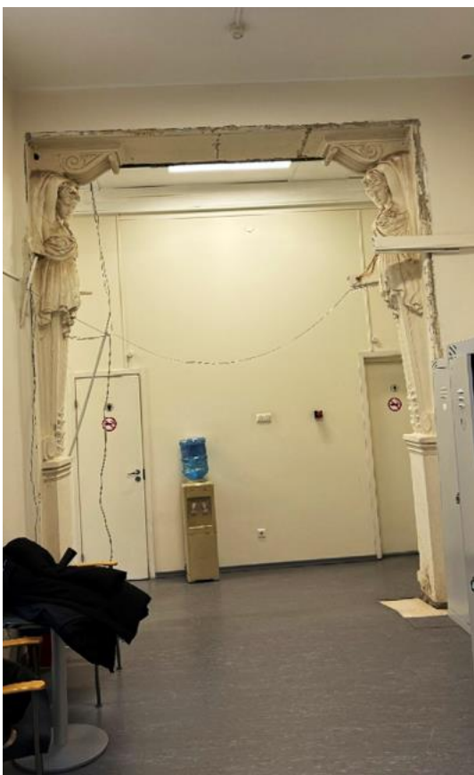
5. «Дом Волконской», Графский переулок, дом 2/48, литера А. Второй этаж. Помещение №106. Общий вид. Фото 01.12.2023г.
