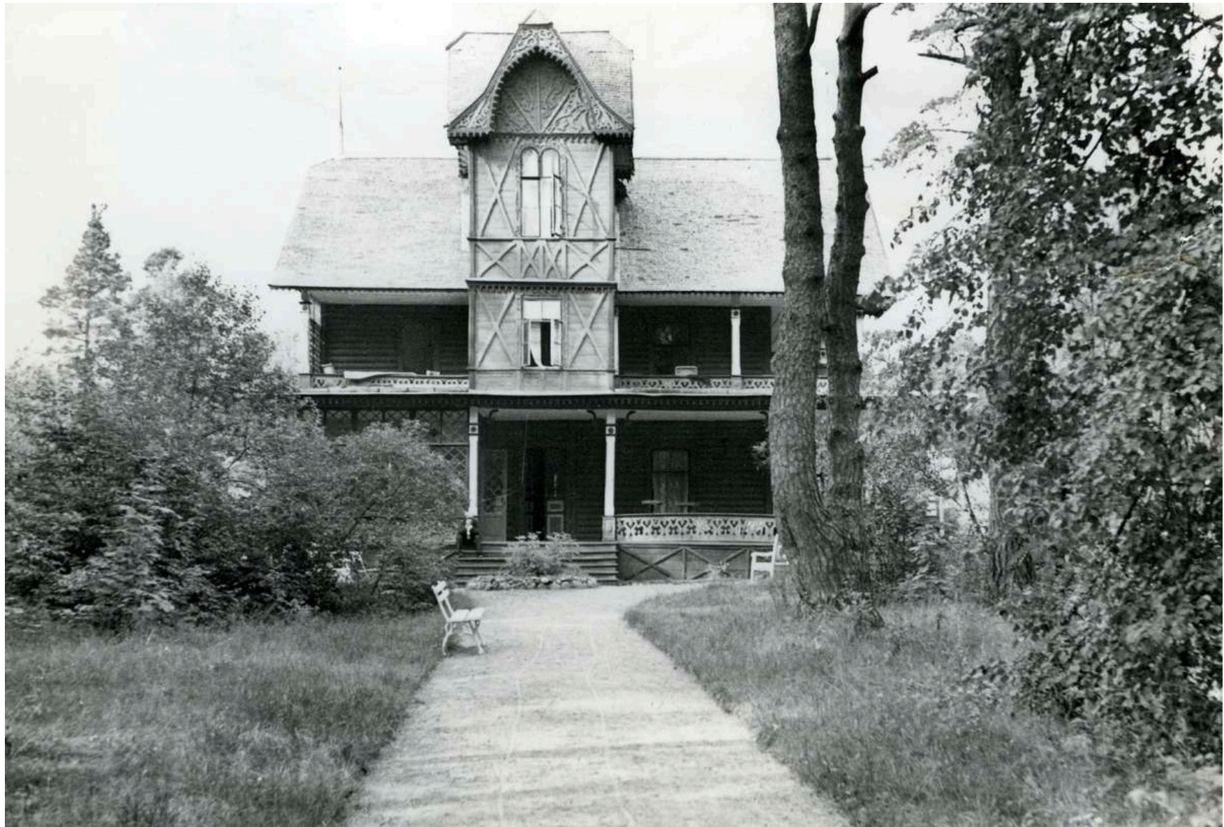
19. Бывшая вилла Мюзера в глубине участка в Терийоки (Театральная ул., 7). Не сохранилась. 1937 г. // Источник: Lappeenranta museums. Identifier: KUVKVV2206:6. URL: https://finna.fi/Record/lappeenrannanmuseot.7D665D2A-4A54-4186-B6DA-3CC095FBBA67?imgid=1 .
