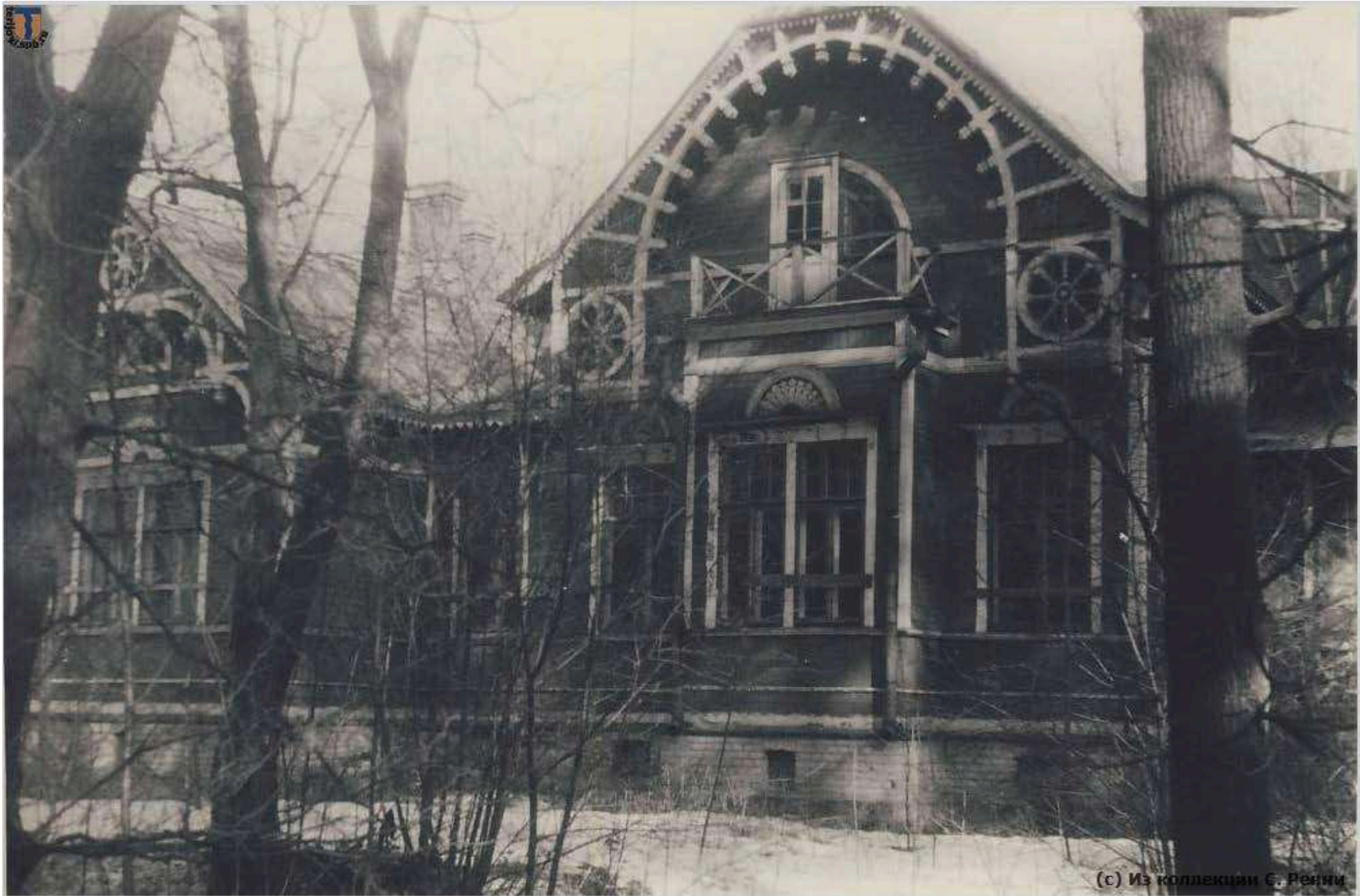
36. Дача Мюзера. Западный фасад. Конец 1980-х гг. // Источник: Из личного архива С. Ренни. Электронный ресурс: Зеленогорск СПб: История и современность. URL: https://terijoki.spb.ru/photos/picture.php?/70227/category/1881 . Дата обращения: 13.02.2024.
