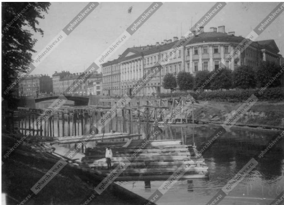
Илл. 15. Вид ремонтных работ на набережной реки Мойки. На заднем плане - дом Антонова. 1933 г. (источник: ЦГАКФФД СПб. Фотодокумент Вр 25087).
