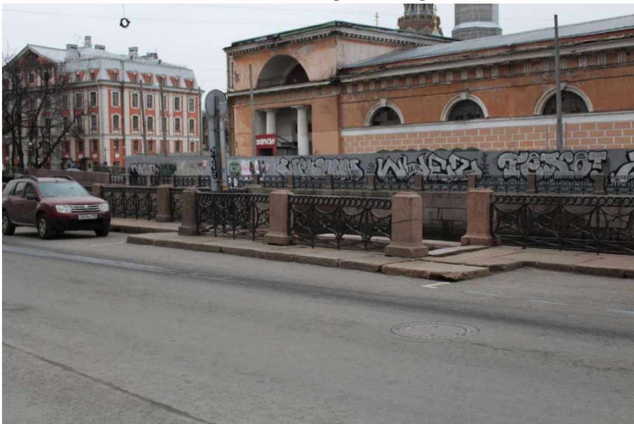
Фото 6. Вид на спуск № 1 объекта культурного наследия федерального значения «Набережные со спусками» на уч. наб. р. Мойки «Мало-Конюшенный-Большой Конюшенный мост», литера А с северо-запада.
