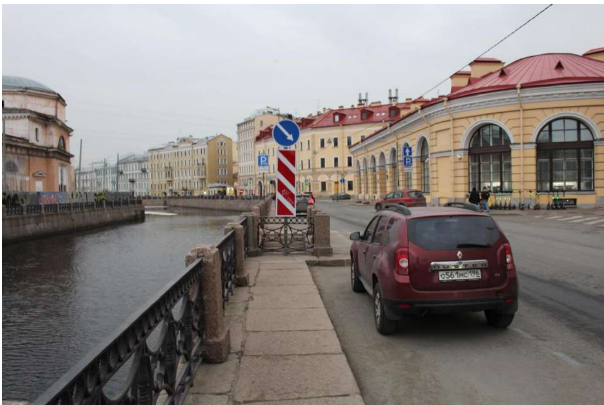
Фото 3. Вид на спуск № 1 объекта культурного наследия федерального значения «Набережные со спусками» на уч. наб. р. Мойки «Мало-Конюшенный-Большой Конюшенный мост», литера А с востока.
