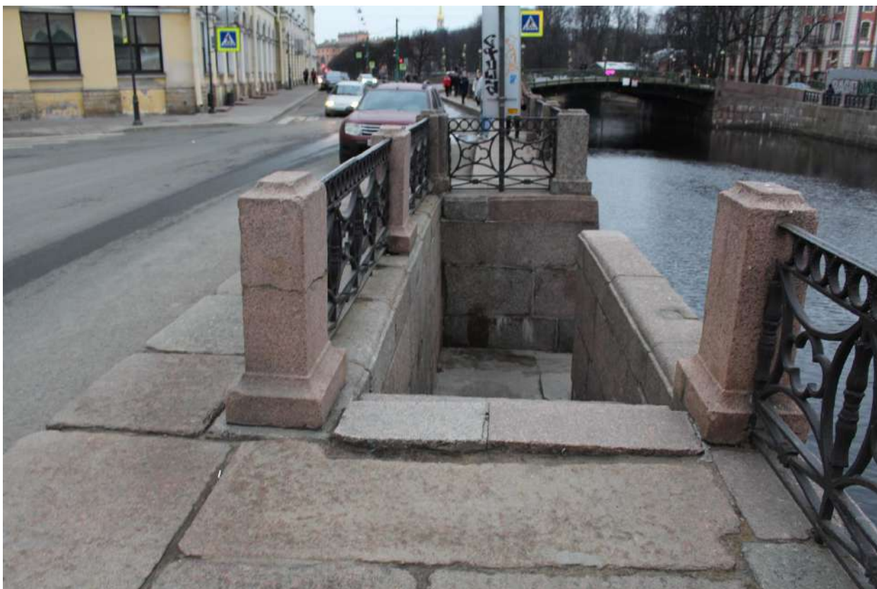
Фото 7. Вид на спуск № 1 объекта культурного наследия федерального значения «Набережные со спусками» на уч. наб. р. Мойки «Мало-Конюшенный-Большой Конюшенный мост», литера А с северо-запада.
