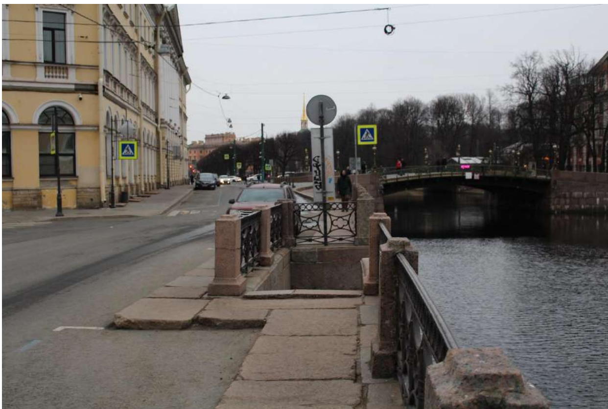
Фото 10. Вид на спуск № 1 объекта культурного наследия федерального значения «Набережные со спусками» на уч. наб. р. Мойки «Мало-Конюшенный-Большой Конюшенный мост», литера А с северо-запада.
