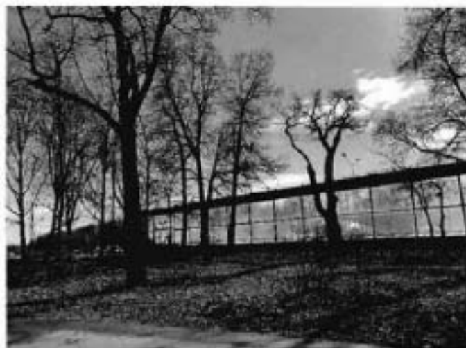
3. Вид на объект культурного наследия с южной стороны.
