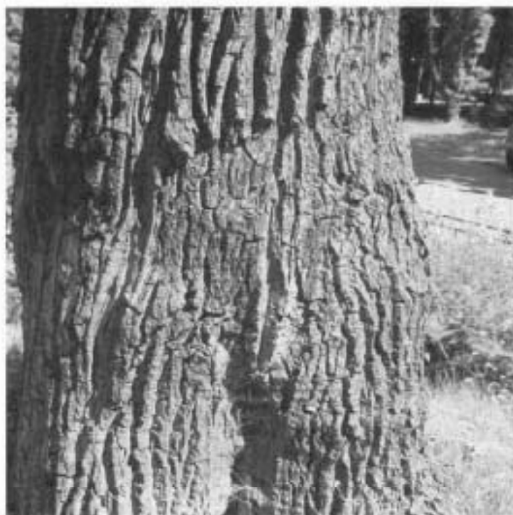
Фото 6. Заросшие раны и морозные трещины.
