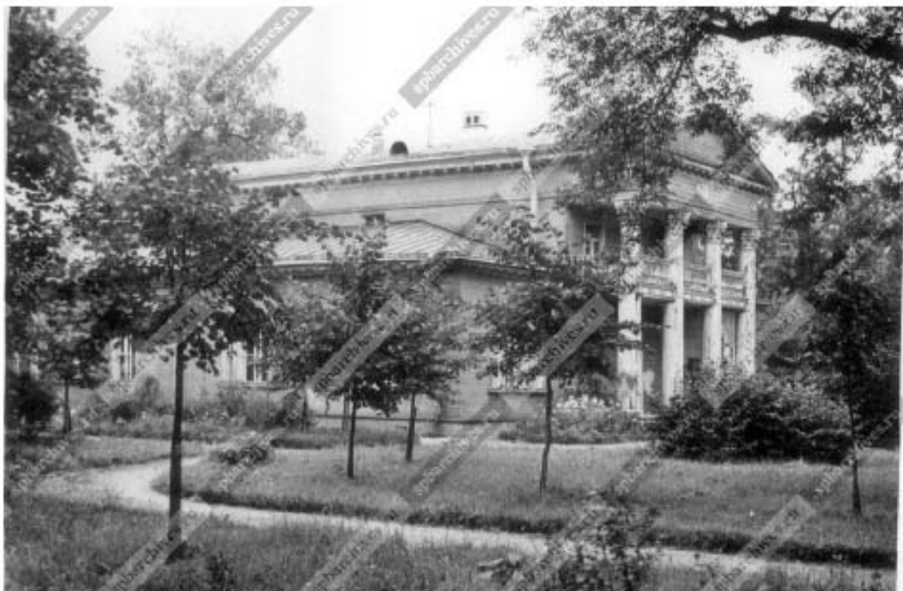
26. Вид части территории и здания дачи Шишмарева на Приморском проспекте дом №87. Архитектор А.И. Мельников. Фотография 1960-х гг. ЦГАКФФД СПб. Бр 50159.
