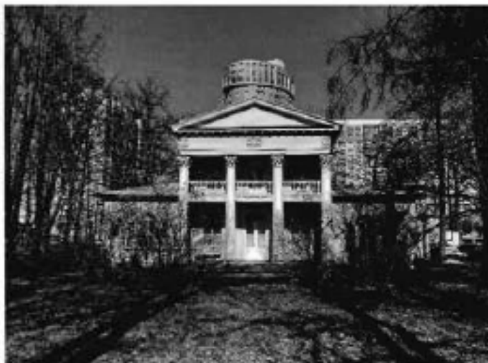
1. Вид на объект культурного наследия с южной стороны
