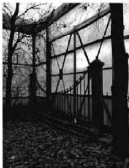
1. Вид на объект культурного наследия с южной стороны
