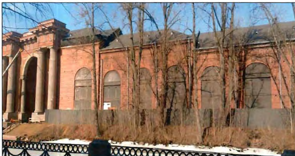
14. Фрагмент южного лицевого фасада объекта культурного наследия.
