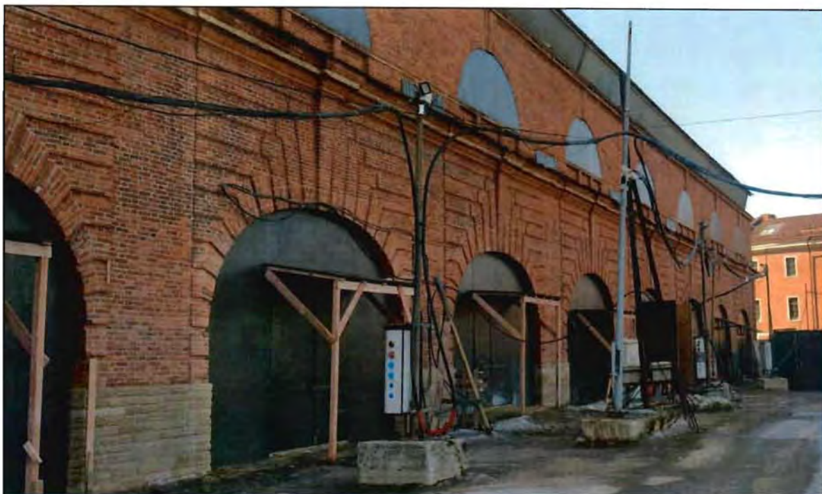
26. Фрагмент северного дворового фасада объекта культурного наследия.
