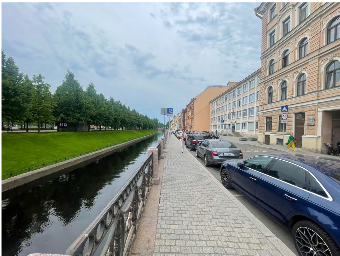
7. Вид на объект культурного наследия регионального значения «Набережная Адмиралтейского канала» по адресу: от Ново-Адмиралтейского канала до Крюкова канала;
