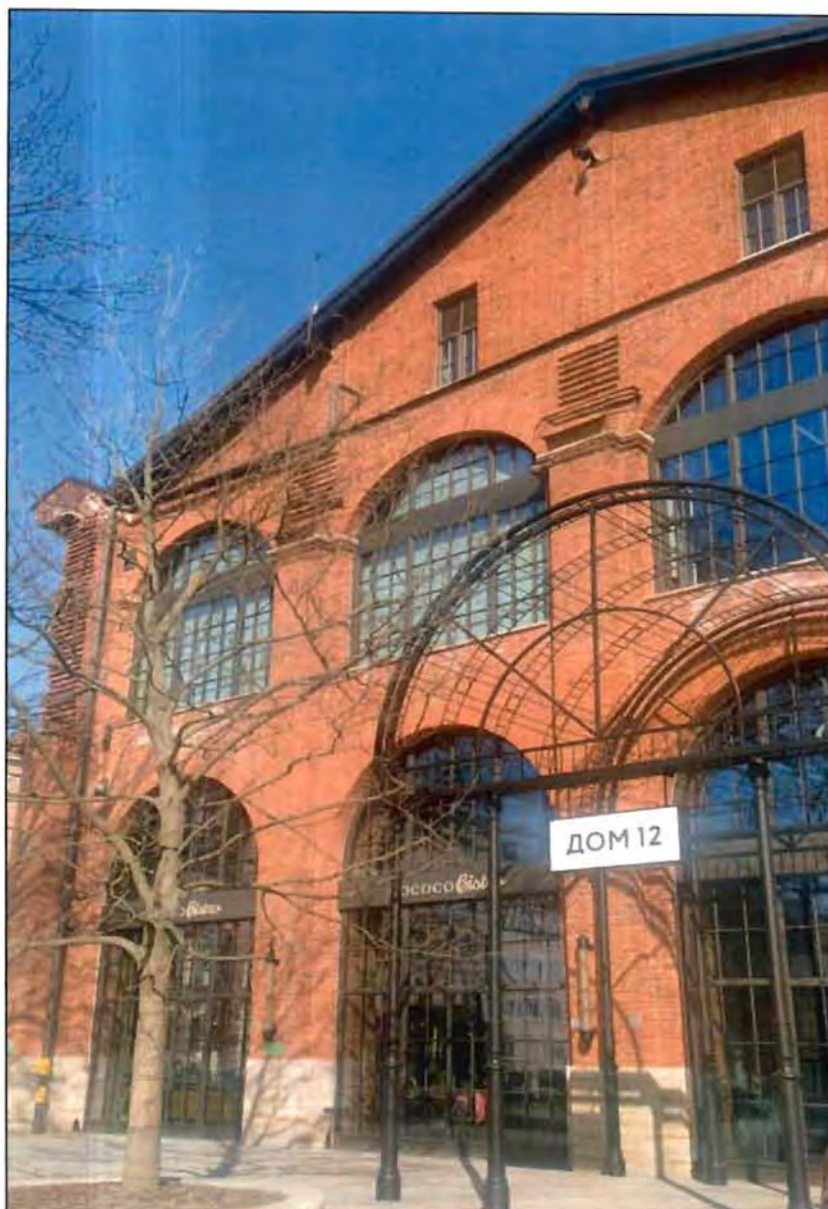
6. Фрагмент западного фасада объекта культурного наследия.
