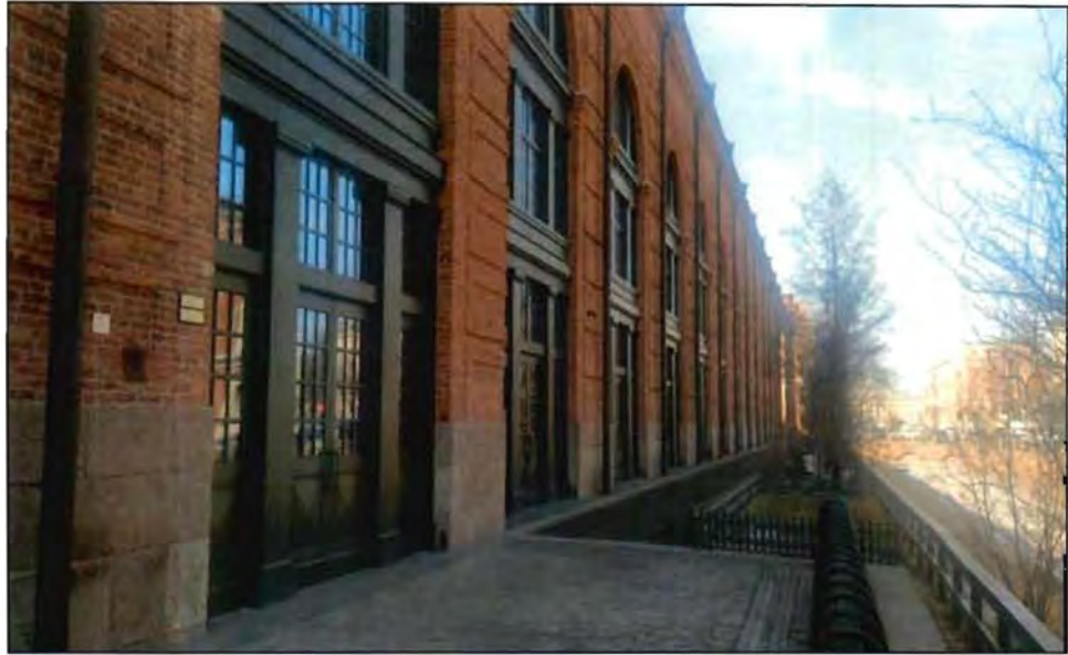
8. Восточный фасад объекта культурного наследия.
