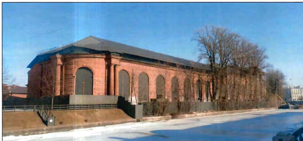
23. Южный и западный лицевые фасады объекта культурного наследия.
