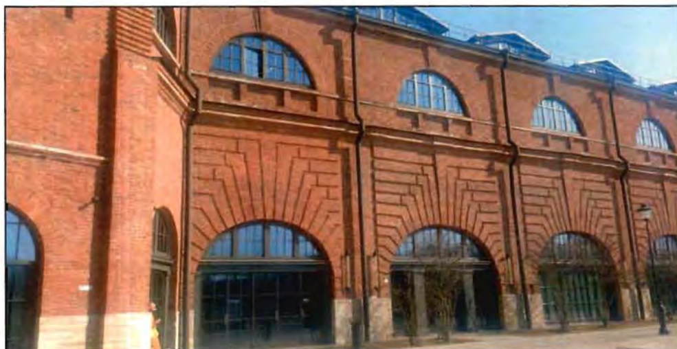
5. Фрагмент западного фасада объекта культурного наследия.
