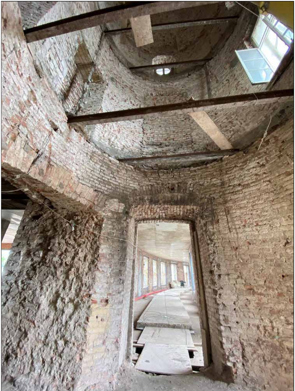
20. Центральный корпус. 1-й этаж. Восточная башня. Вход в восточную галерею. 30.03.2024 г.
