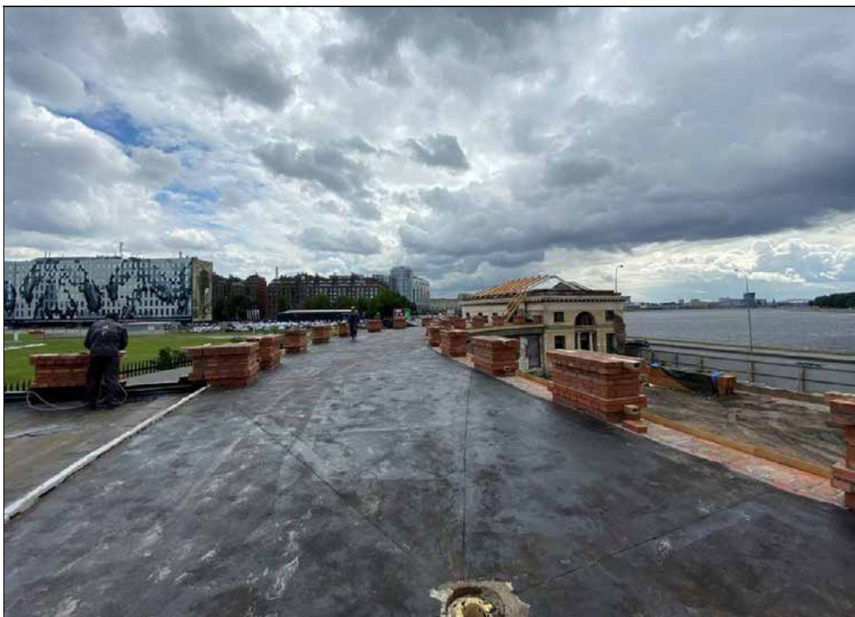
97. Плоское перекрытие восточной галереи. Вид в сторону восточного флигеля от центрального корпуса. 30.03.2024 г.
