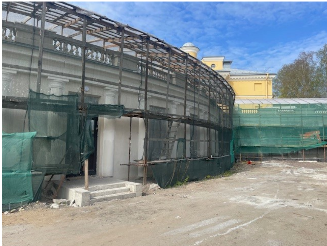
23. Дворовый фасад восточной галереи. Вид на северо-запад. 30.03.2024 г.
