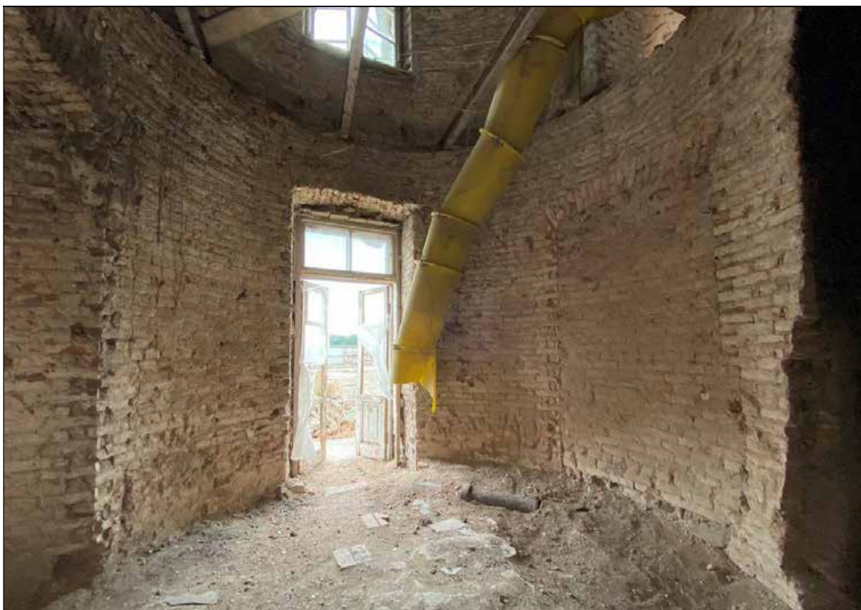
22. Центральный корпус. 1-й этаж. Восточная башня. Дверной проем в южной части башни. 30.03.2024 г.
