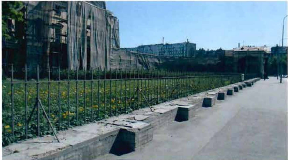
1. Известняковый цоколь объекта культурного наследия.
