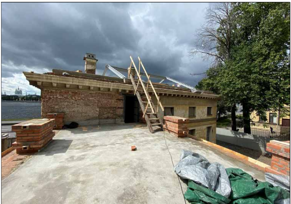
96. Плоское перекрытие западной галереи. Северный фасад западного флигеля. 30.03.2024 г.
