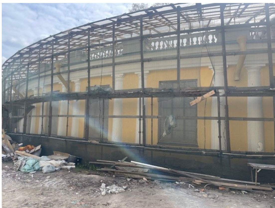
26. Дворовый фасад западной галереи. Вид на восток. 30.03.2024 г.
