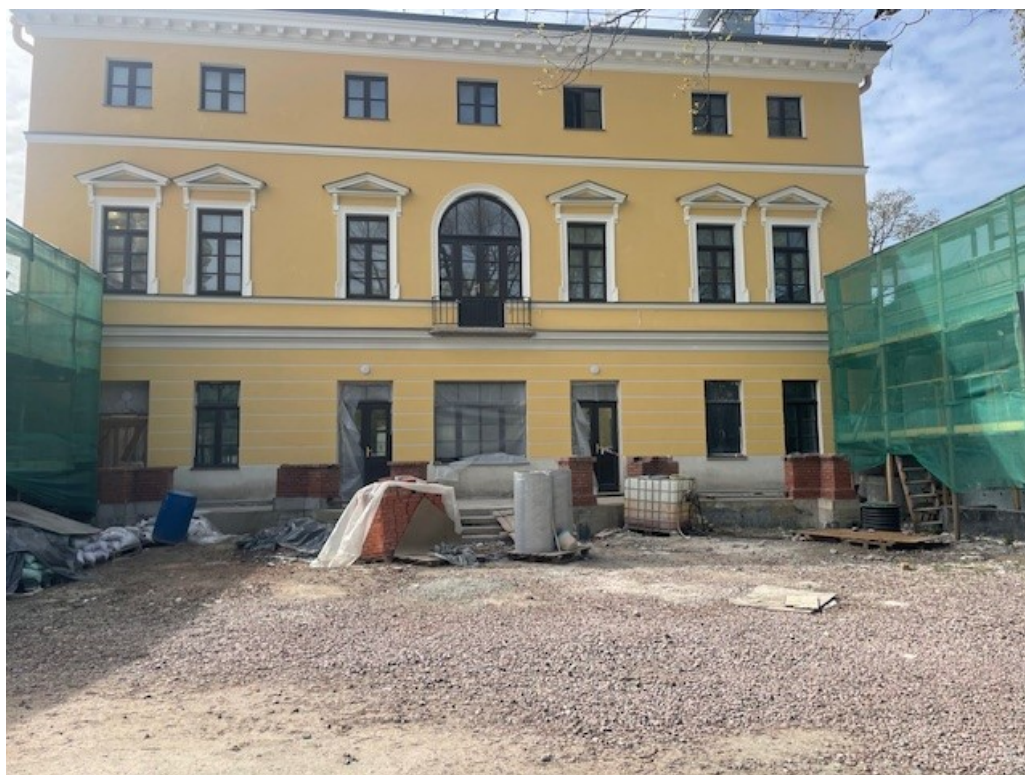
24. Северный фасад центрального корпуса. Вид на юго-запад. 30.03.2024 г.
