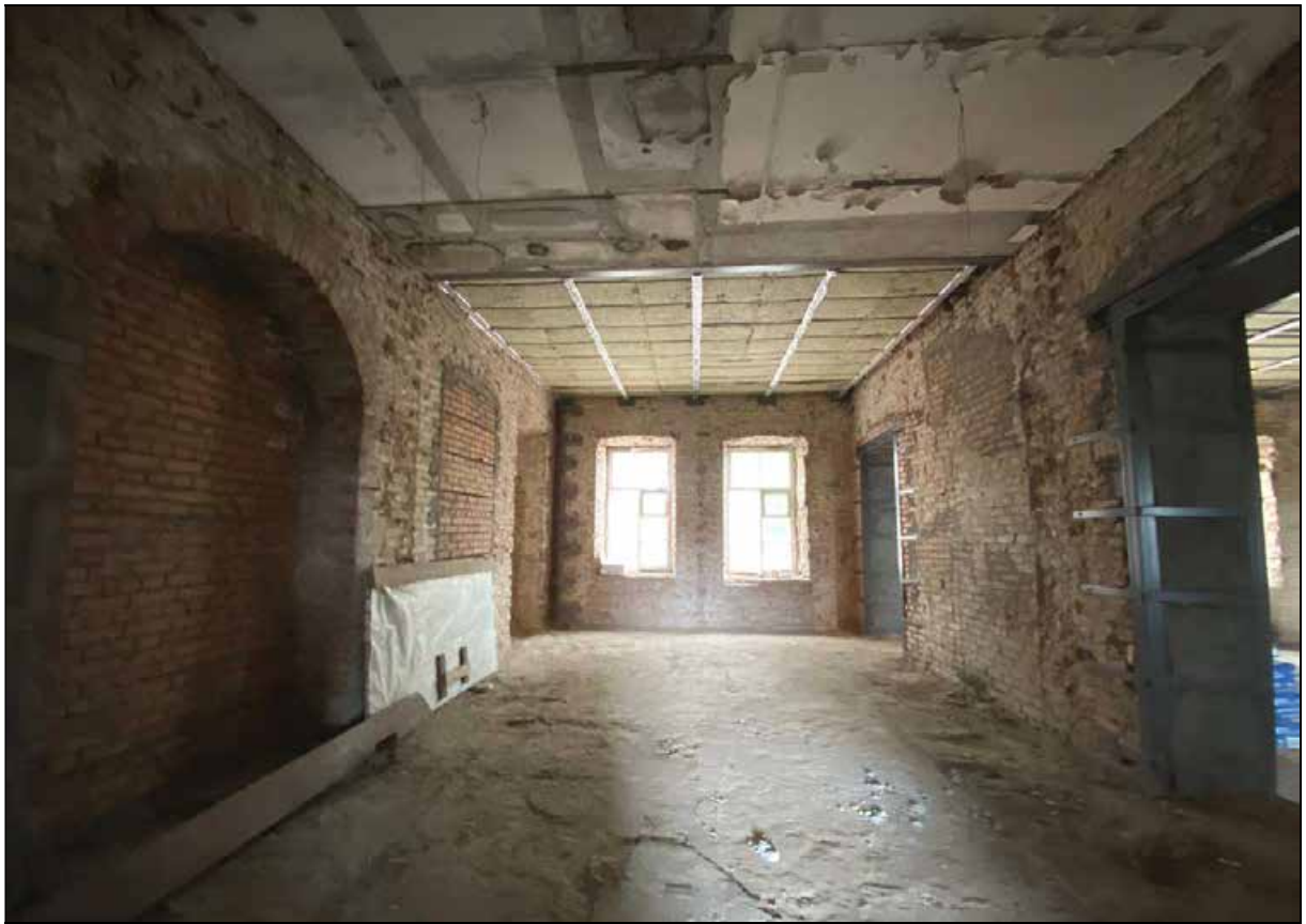
13. Центральный корпус. 1-й этаж. Помещение с северо-западной стороны от центрального помещения. Северная часть помещения. 30.03.2024 г.
