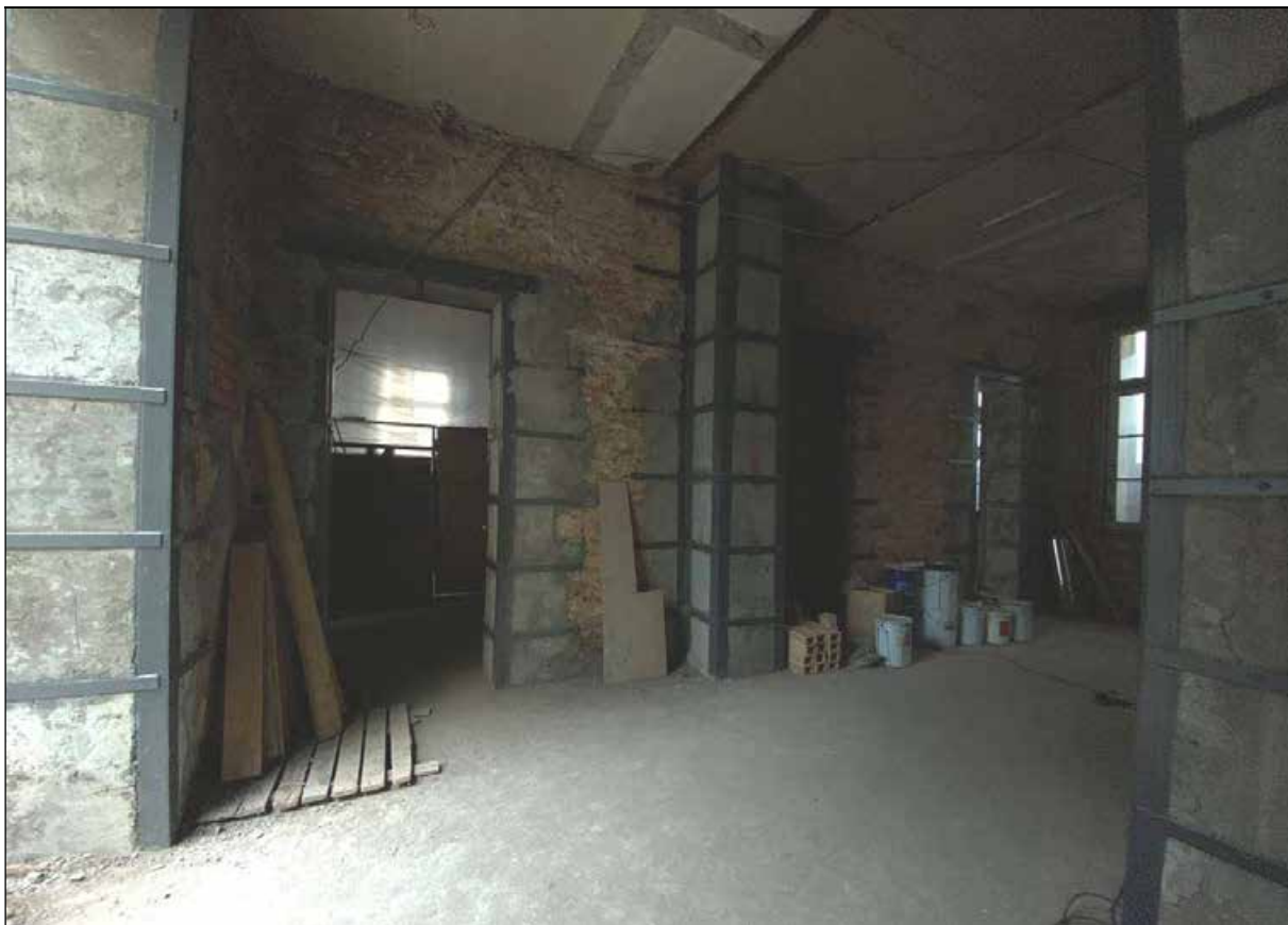
37. Западный флигель. 1-й этаж. Северо-восточная часть центрального помещения. Проемы в восточной стене. 30.03.2024 г.
