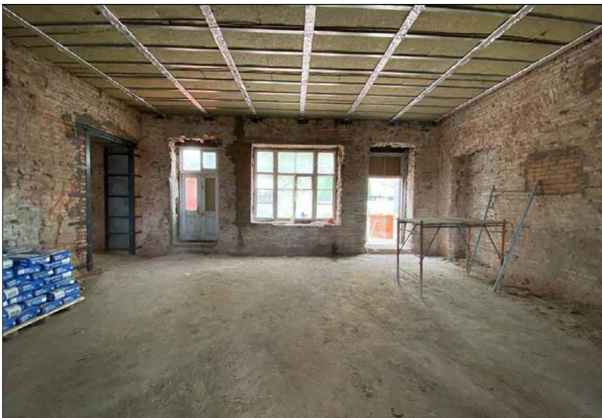
9. Центральный корпус. 1-й этаж. Проемы в северной части центрального помещения. 30.03.2024 г.
