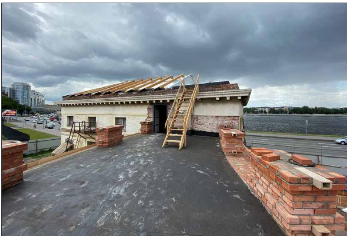
98. Плоское перекрытие восточной галереи. Северный фасад восточного флигеля. 30.03.2024 г.
