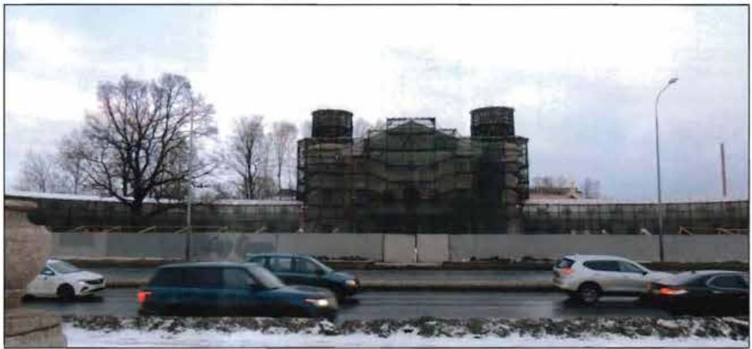
1. Южный фасад объекта культурного наследия.
