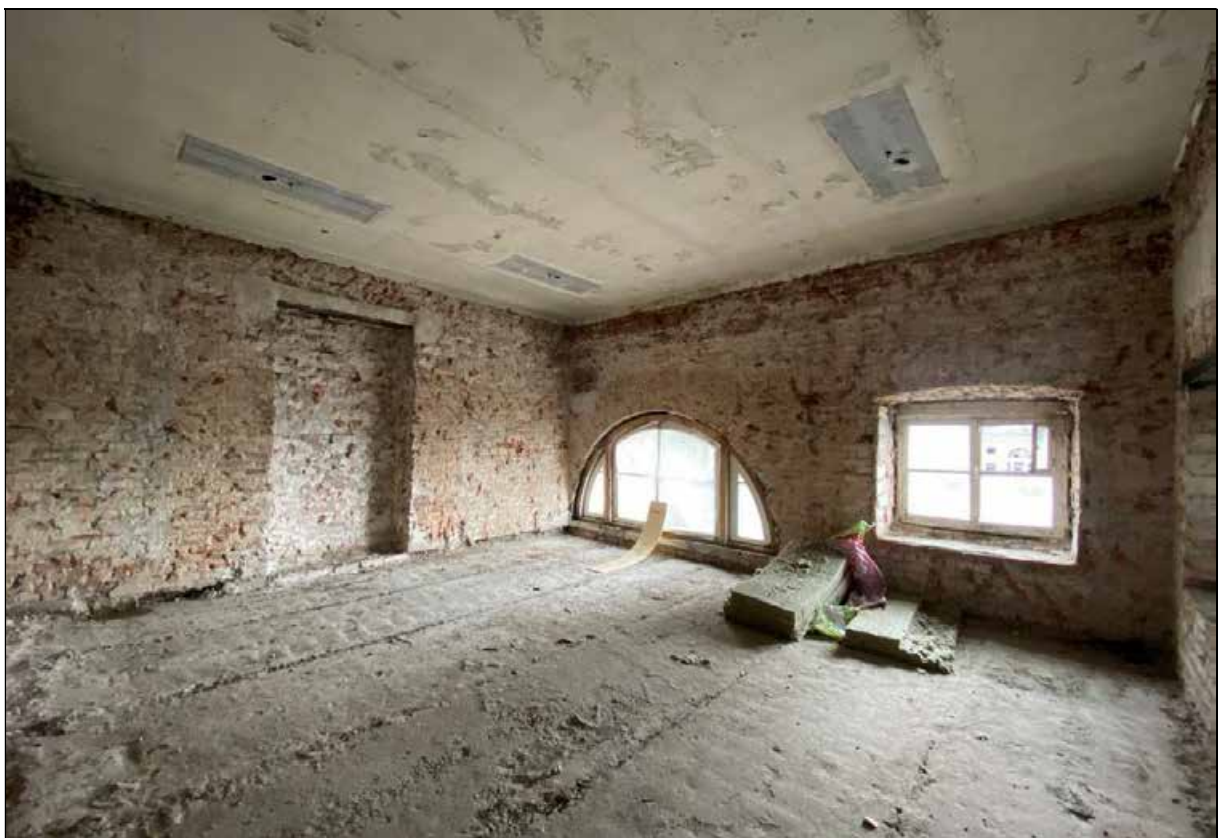
110. Западный флигель. 2-й этаж. Помещение с юго-восточной стороны от центрального помещения. Северо-восточная часть помещения. 30.03.2024 г.
