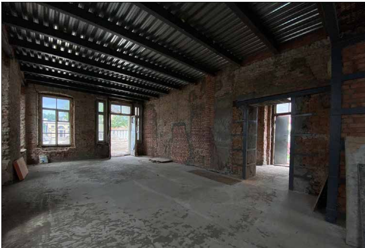
53. Восточный флигель. 1-й этаж. Юго-западное помещение. Северо-западная часть помещения. 30.03.2024 г.
