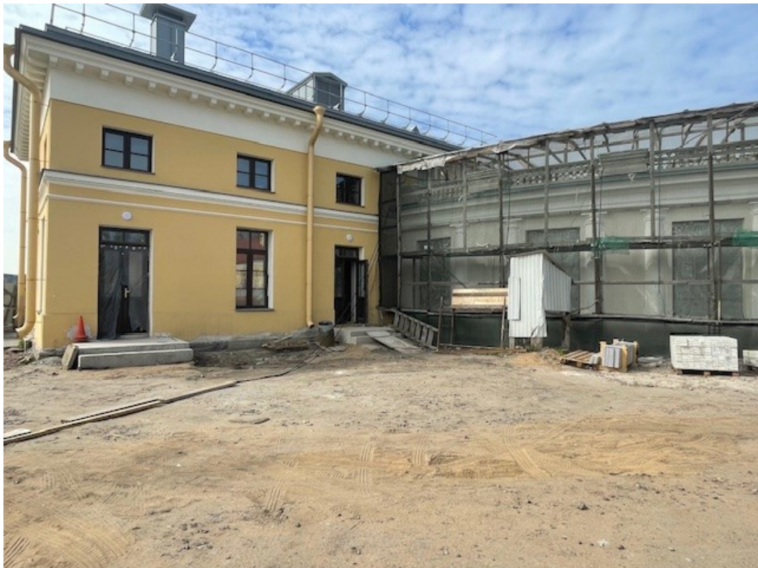
21. Северный фасад восточного флигеля и дворový фасад восточной галереи. Вид на север. 30.03.2024 г.
