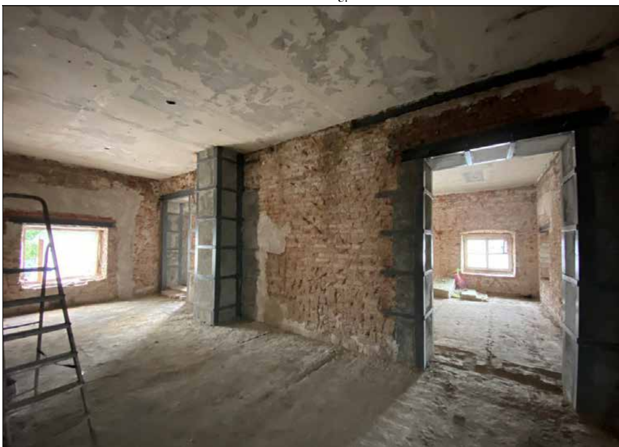
108. Западный флигель. 2-й этаж. Центральное помещение. Проемы в восточной стене. 30.03.2024 г.
