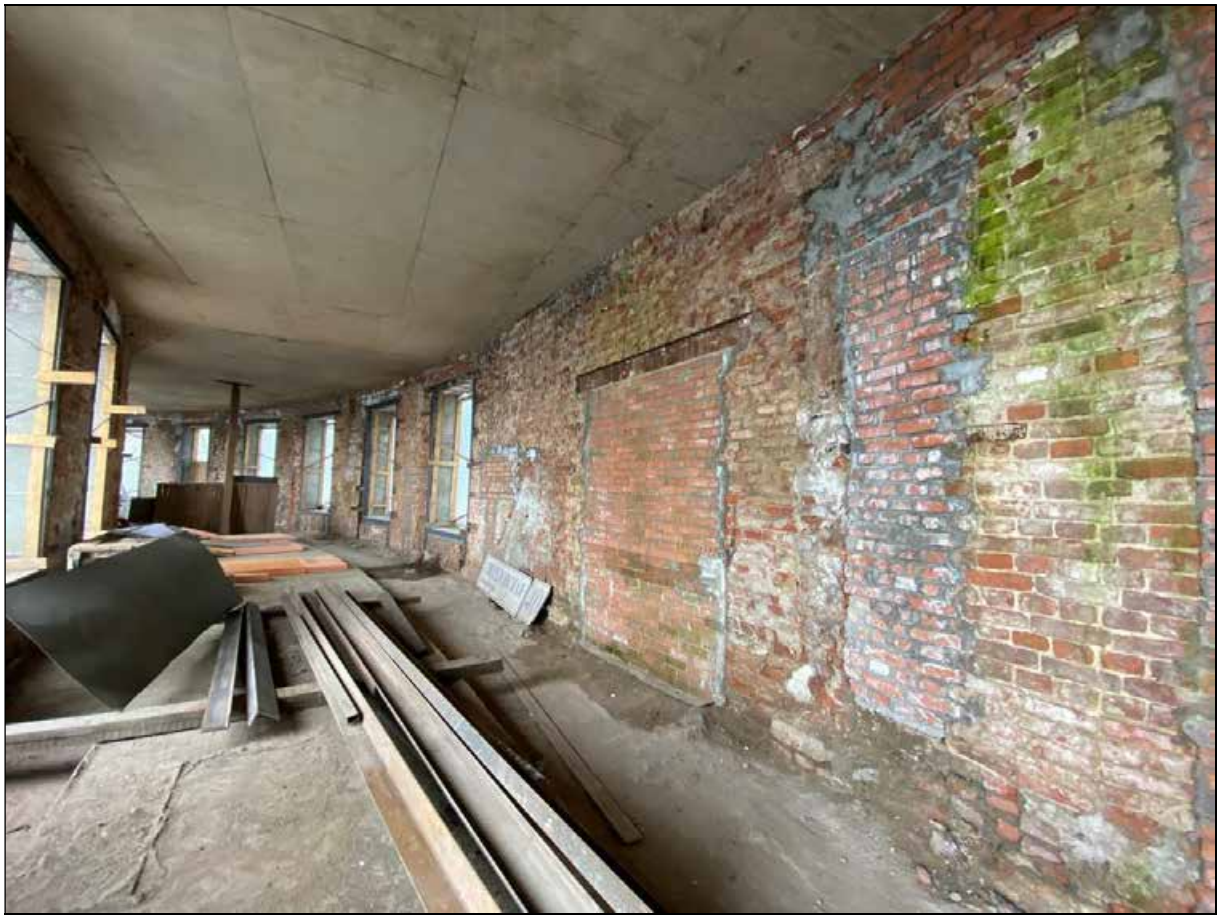
31. Западная галерея. 1-й этаж. Вид от центрального корпуса. 30.03.2024 г.
