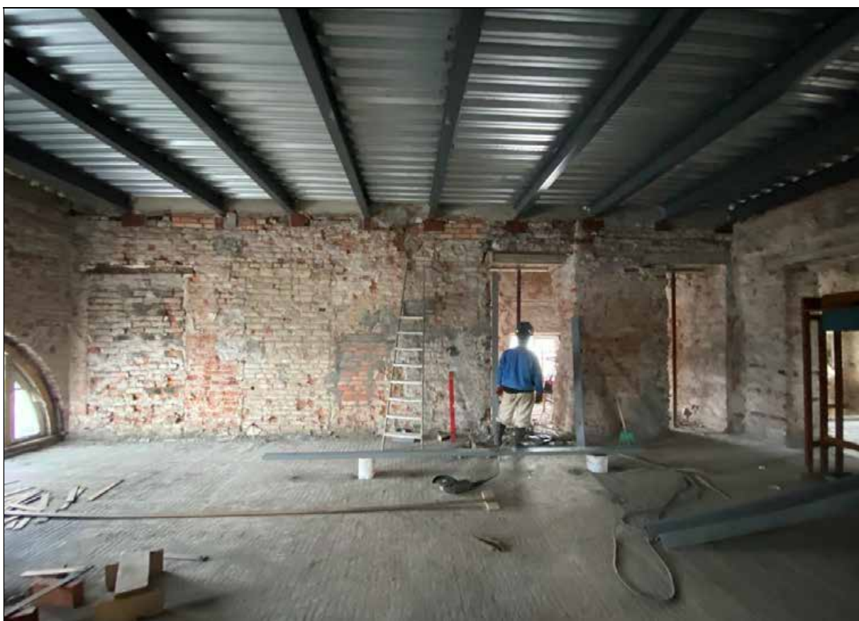
120. Восточный флигель. 2-й этаж. Юго-западное помещение. Северная часть помещения. 30.03.2024 г.
