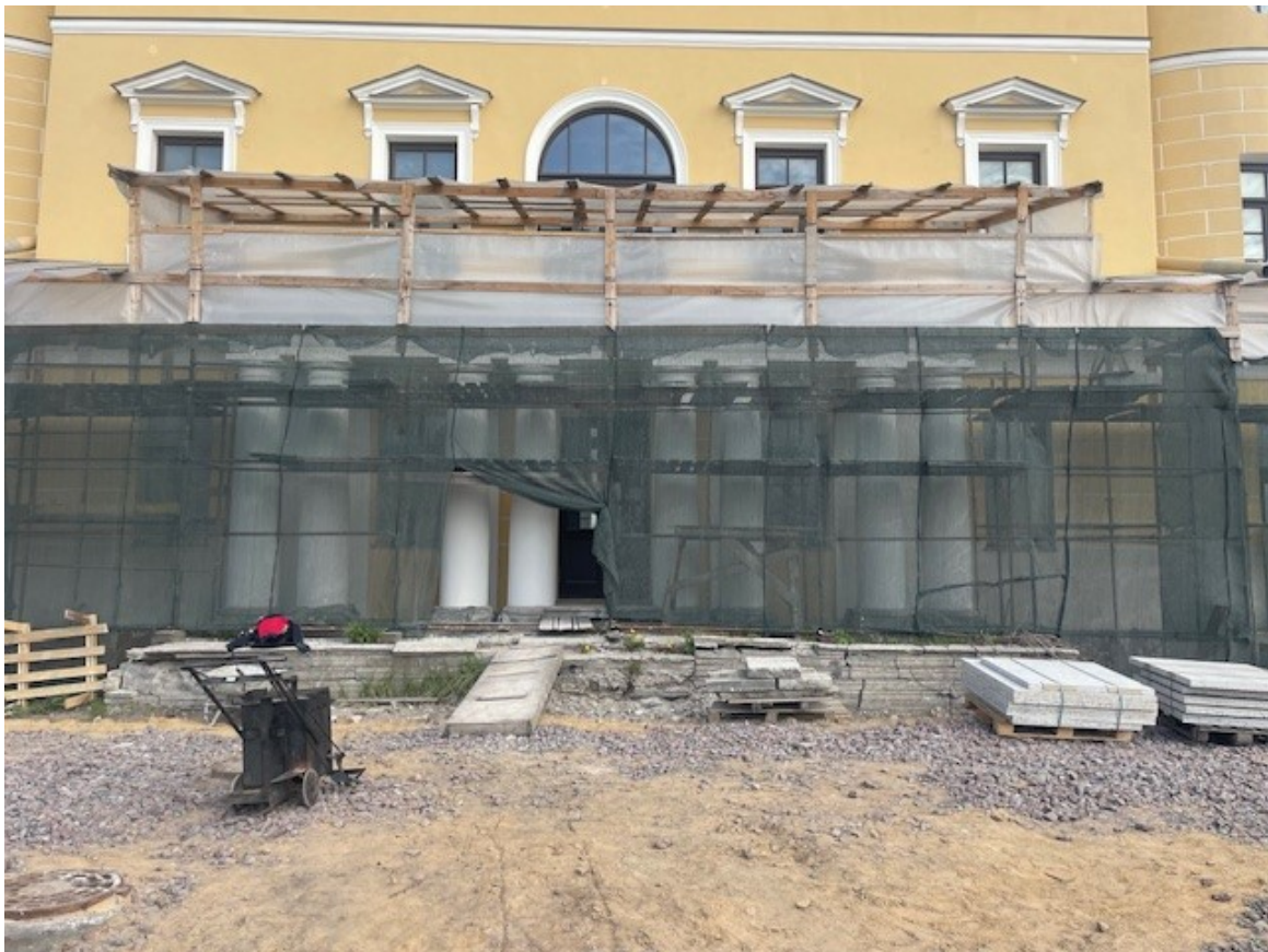
6. Фрагмент южного фасада центрального корпуса. Восьмиколонный портик. 30.03.2024 г.
