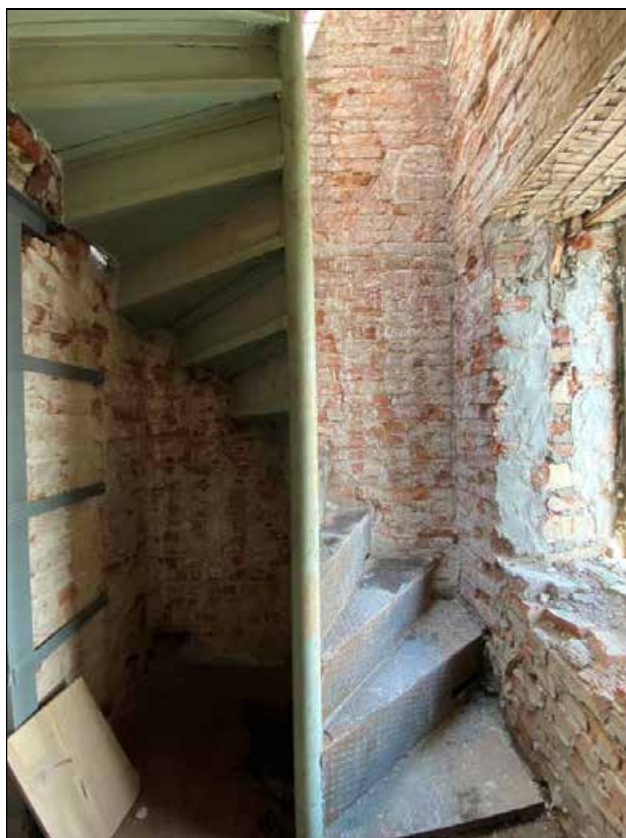
151. Центральный корпус. 3-й этаж. Помещение с северной стороны от восточной башни. Северная часть помещения. Металлическая винтовая лестница. 30.03.2024 г.
