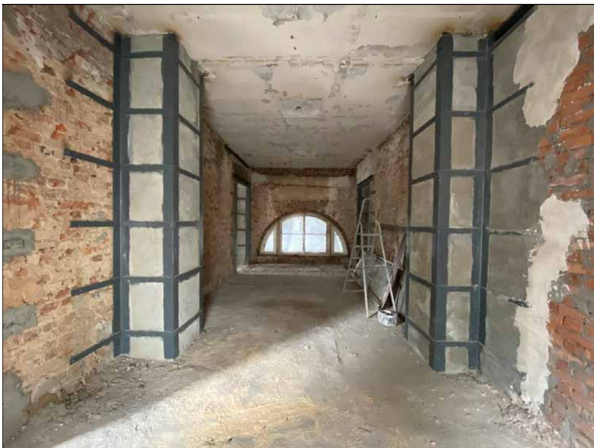
103. Западный флигель. 2-й этаж. Центральное помещение. Южная часть помещения. 30.03.2024 г.
