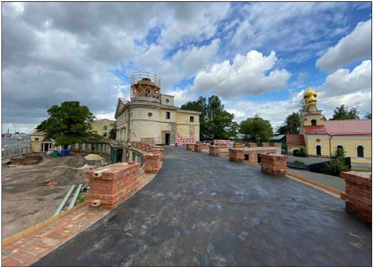
99. Плоское перекрытие восточной галереи. Вид в сторону центрального корпуса от восточного флигеля. 30.03.2024 г.
