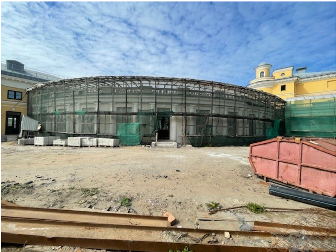
22. Дворовый фасад восточной галереи. Вид на юго-запад. 30.03.2024 г.
