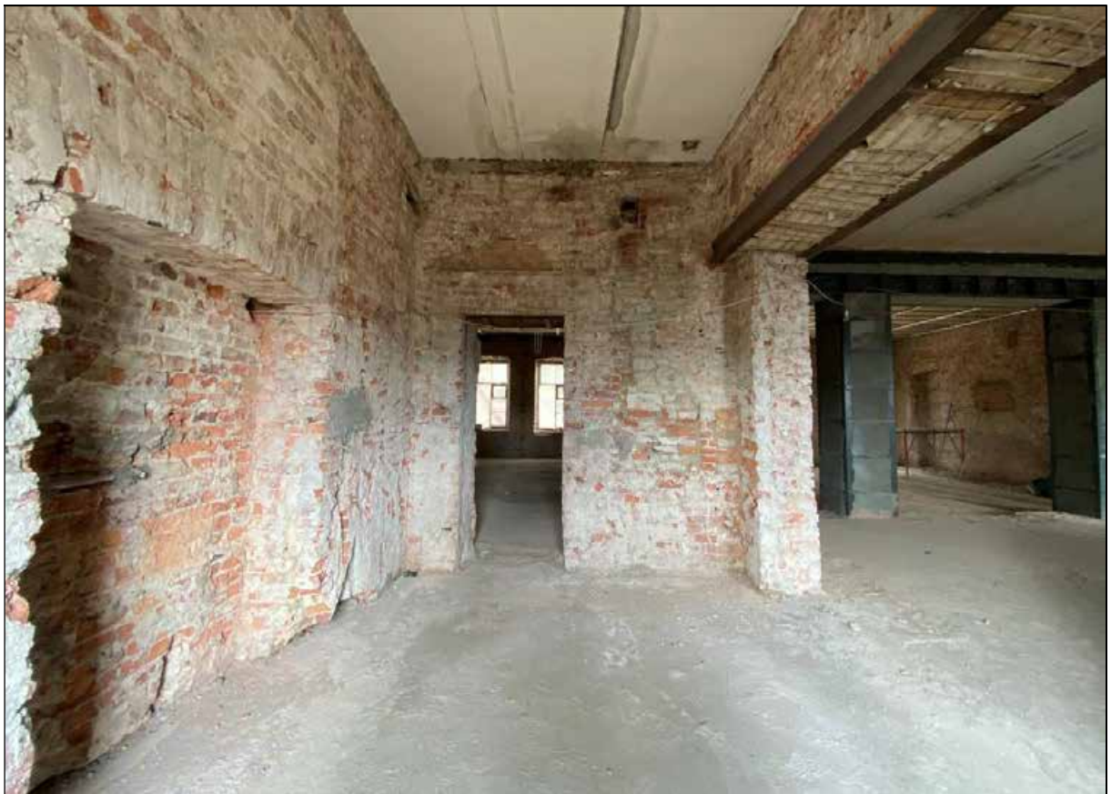
8. Центральный корпус. 1-й этаж. Помещение с юго-западной стороны от центрального помещения. Северная часть помещения. 30.03.2024 г.
