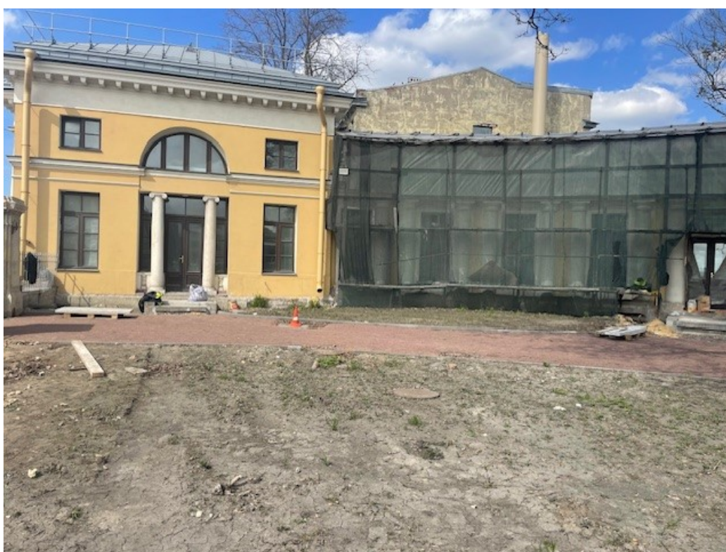
13. Восточный фасад западного флигеля. Вид на северо-запад. 30.03.2024 г.
