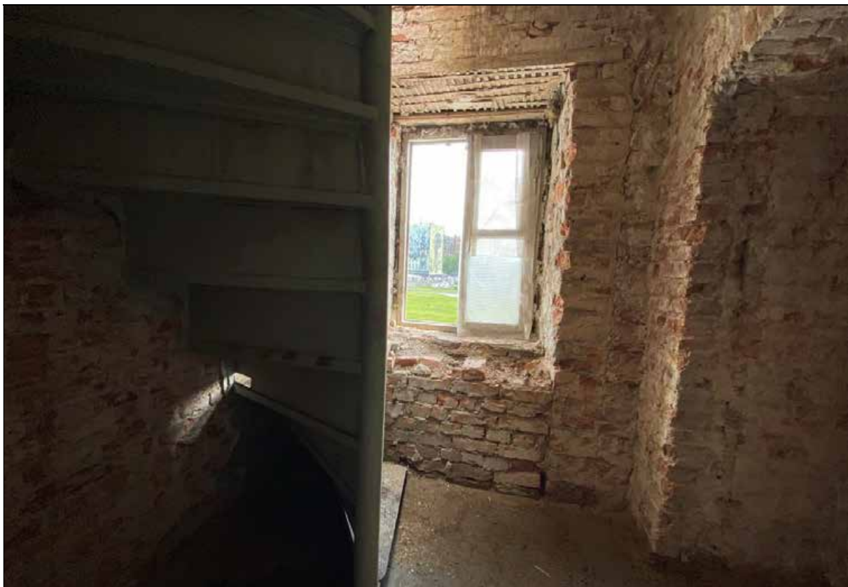
149. Центральный корпус. 3-й этаж. Помещение с северной стороны от восточной башни. Восточная часть помещения. 30.03.2024 г.
