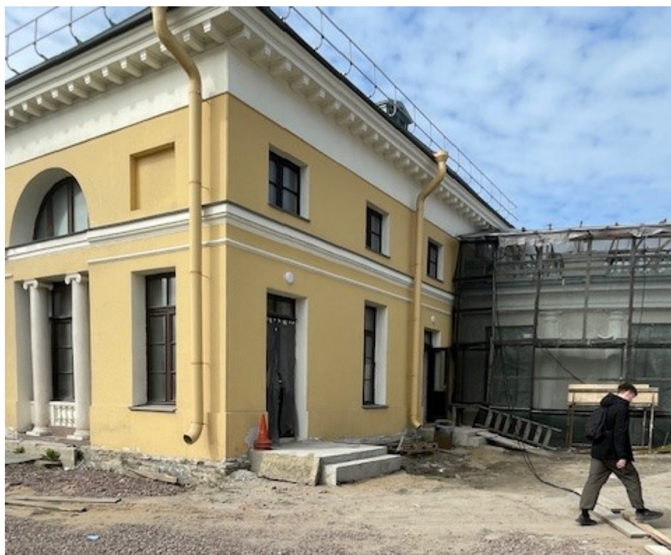
20. Восточный и северный фасады восточного флигеля. Вид на северо-запад. 30.03.2024 г.
