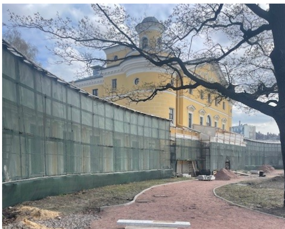
7. Южный фасад центрального корпуса. Вид на северо-восток. 30.03.2024 г.
