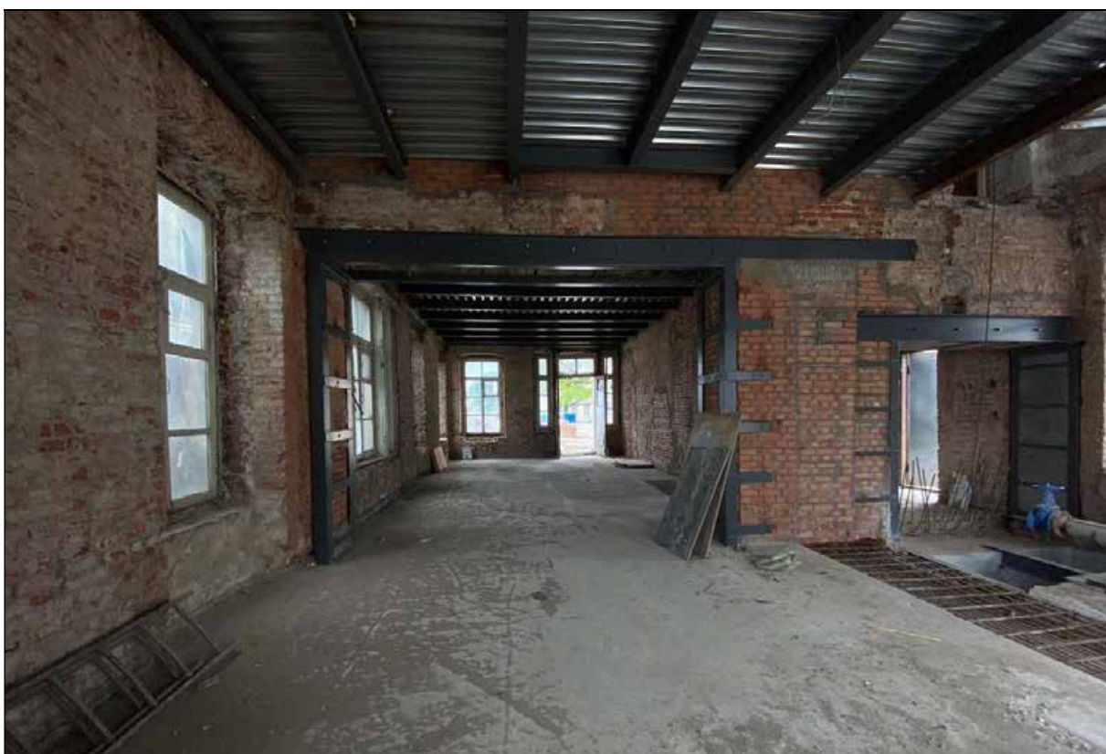
56. Восточный флигель. 1-й этаж. Восточное помещение. Проемы в западной стене. 30.03.2024 г.
