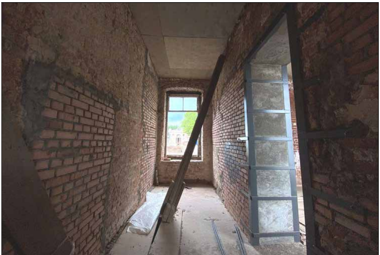
50. Восточный флигель. 1-й этаж. Северо-западное помещение. Западная часть помещения. 30.03.2024 г.
