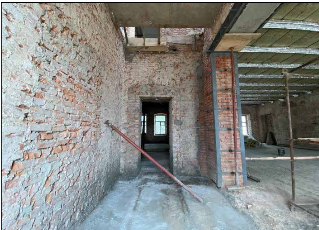
77. Центральный корпус. 2-й этаж. Помещение с юго-западной стороны от центрального помещения. Северная часть помещения. 30.03.2024 г.
