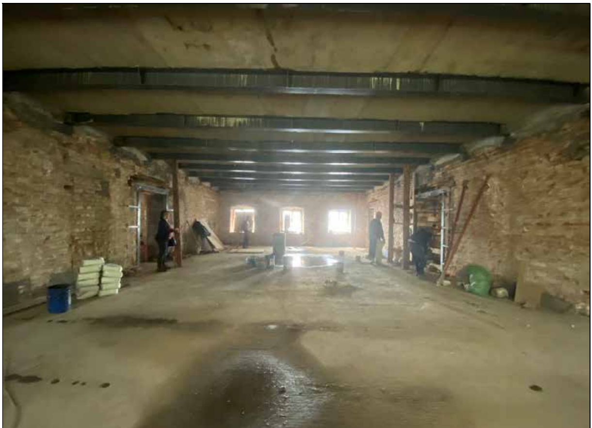
127. Центральный корпус. 3-й этаж. Центральное помещение. Южная часть помещения. 30.03.2024 г.
