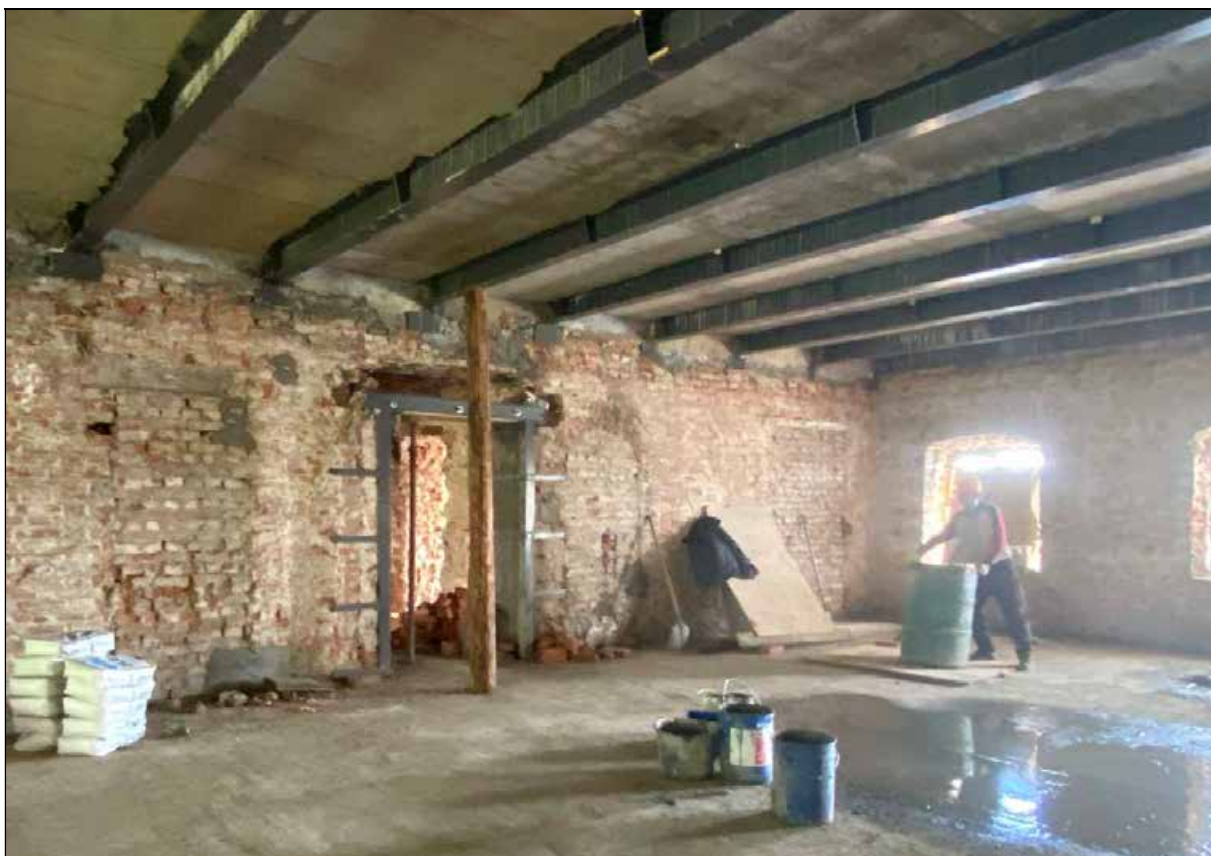
129. Центральный корпус. 3-й этаж. Центральное помещение. Юго-восточная часть помещения. 30.03.2024 г.
