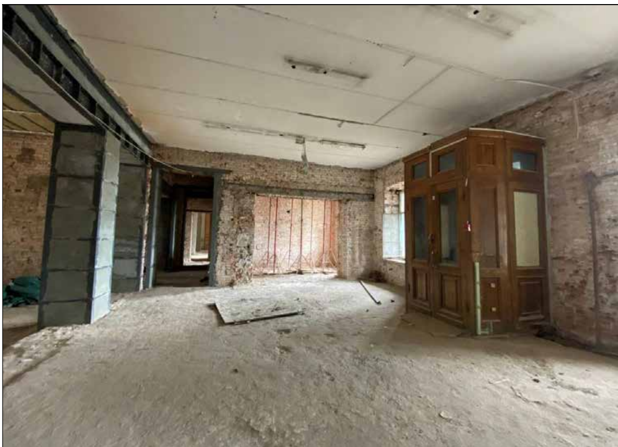
3. Центральный корпус. 1-й этаж. Юго-восточная часть центрального помещения. 30.03.2024 г.
