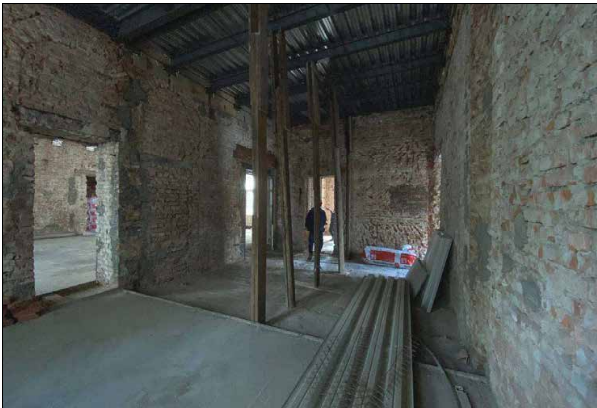
82. Центральный корпус. 2-й этаж. Помещение с северо-западной стороны от центрального помещения. Юго-восточная часть помещения. 30.03.2024 г.
