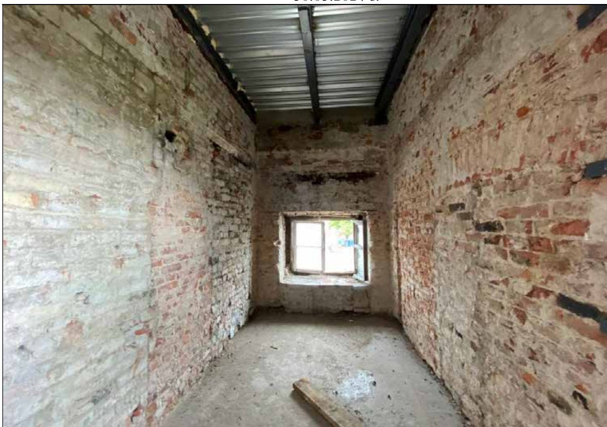
126. Восточный флигель. 2-й этаж. Северо-западное помещение. Западная часть помещения. 30.03.2024 г.
