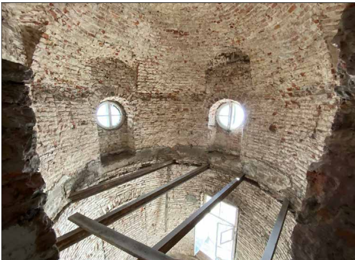
147. Центральный корпус. 3-й этаж. Купольный свод в восточной башне. Окна-люкарны. 30.03.2024 г.
