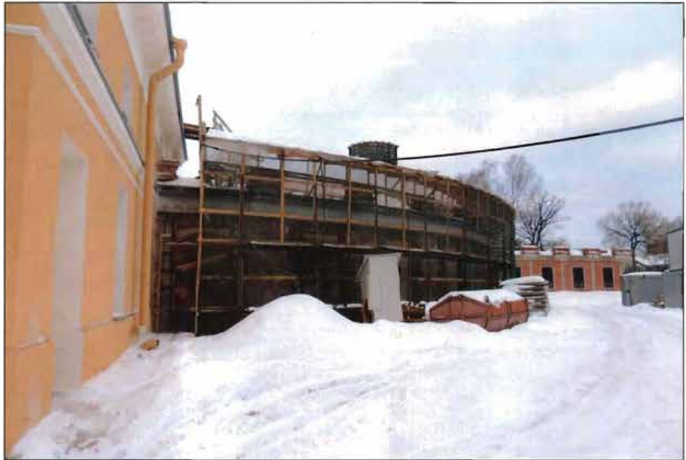
7. Часть территории объекта культурного наследия федерального значения «Дача Безбородко А.А. (Кушелевых–Безбородко)».
