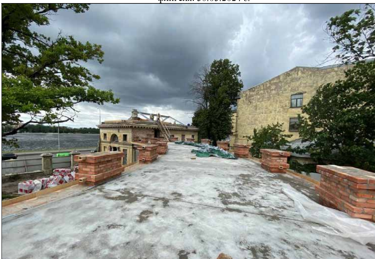
94. Плоское перекрытие западной галереи. Вид в сторону западного флигеля от центрального корпуса. 30.03.2024 г.
