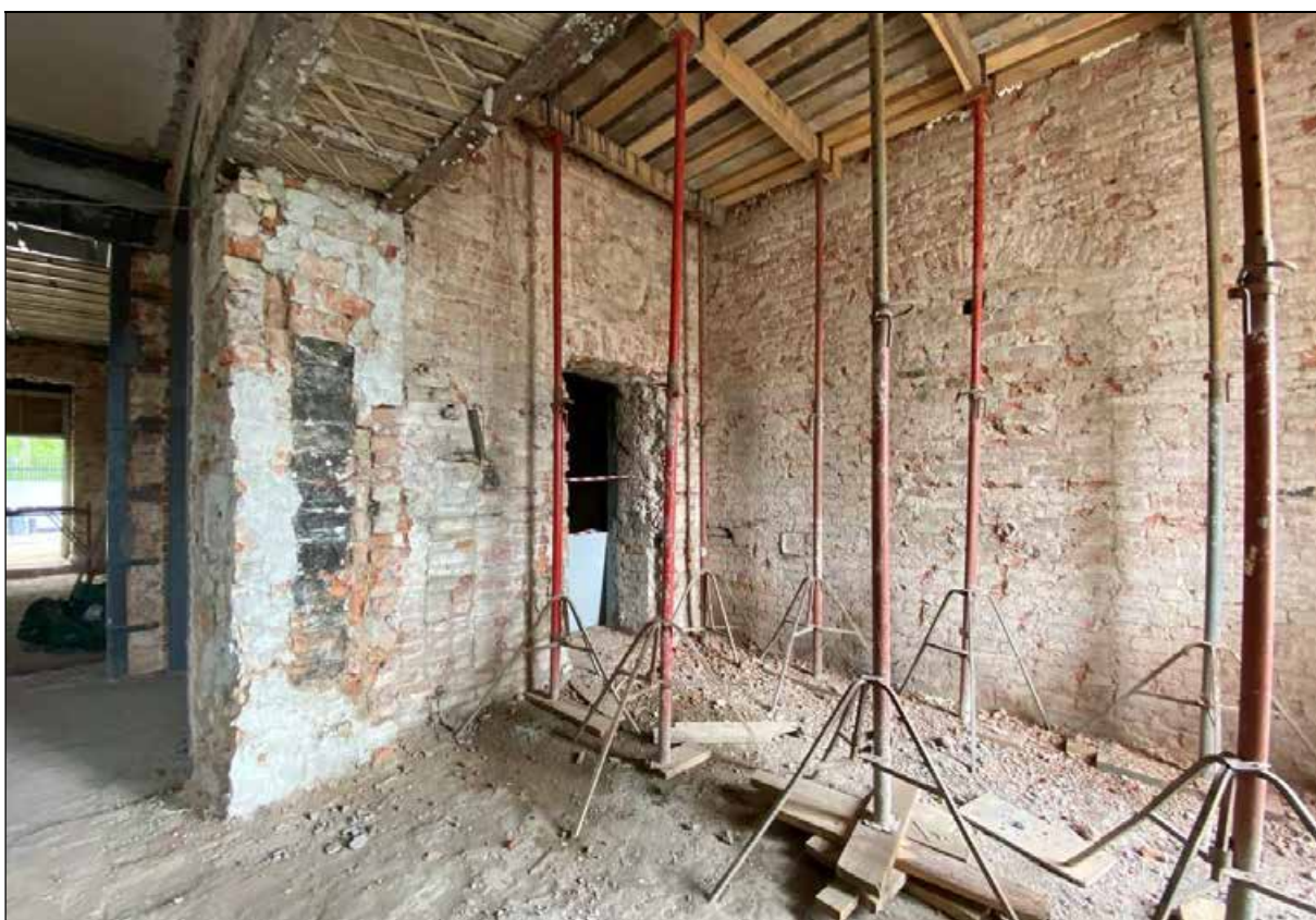
6. Центральный корпус. 1-й этаж. Помещение с юго-восточной стороны от центрального помещения. Северная часть помещения. 30.03.2024 г.
