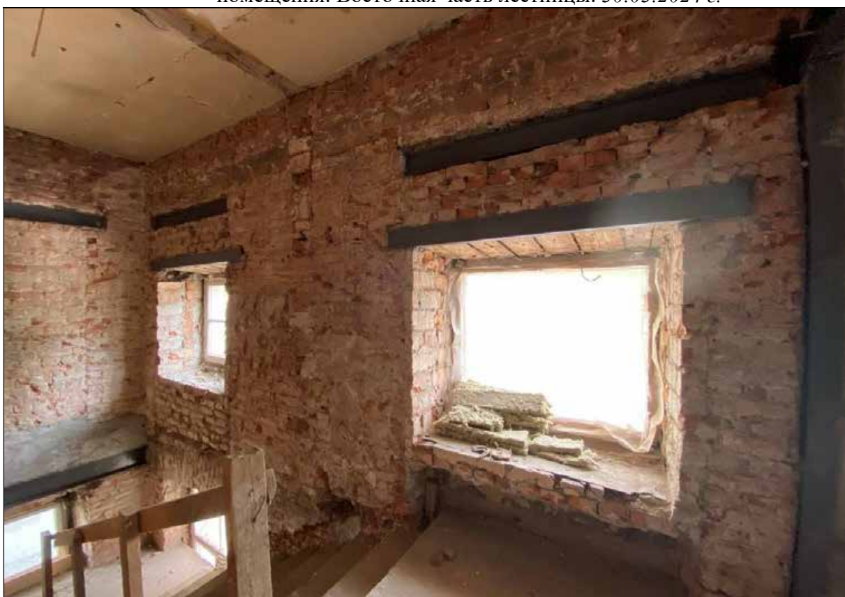
102. Западный флигель. 2-й этаж. Лестница с северо-западной стороны от центрального помещения. Оконные проемы в северной части лестницы. 30.03.2024 г.
