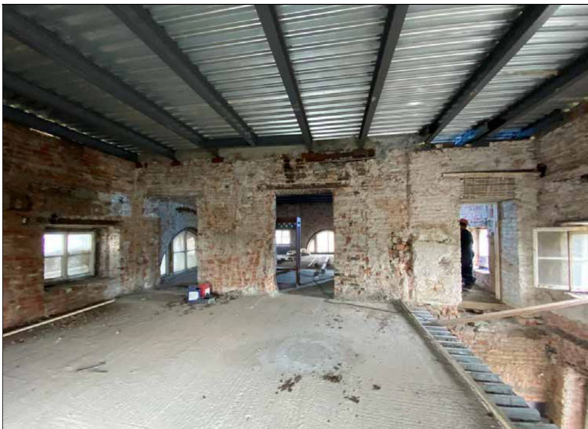
123. Восточный флигель. 2-й этаж. Юго-западное помещение. Западная часть помещения. 30.03.2024 г.
