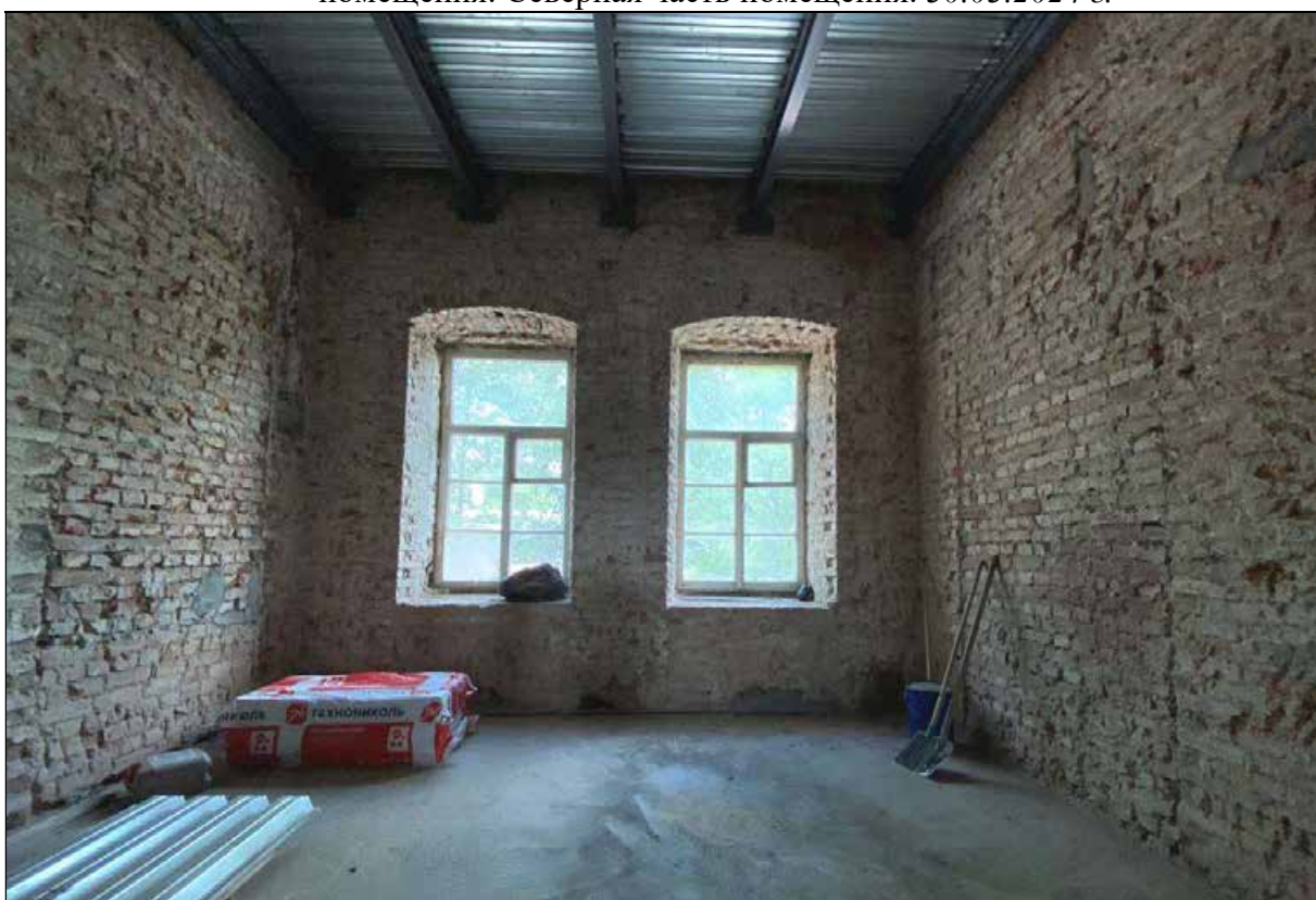
80. Центральный корпус. 2-й этаж. Помещение с северо-западной стороны от центрального помещения. Оконные проемы в северной части помещения. 30.03.2024 г.
