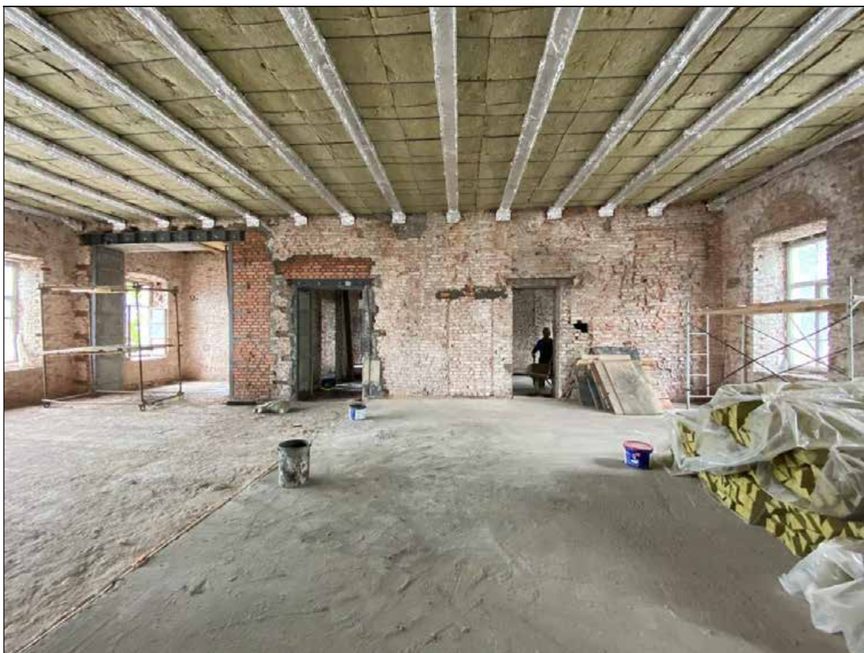
69. Центральный корпус. 2-й этаж. Центральное помещение. Западная часть помещения. 30.03.2024 г.
