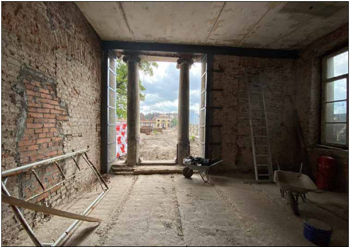
43. Западный флигель. 1-й этаж. Юго-восточное помещение. Проем в восточной стене. Колонны ионического ордера. 30.03.2024 г.
