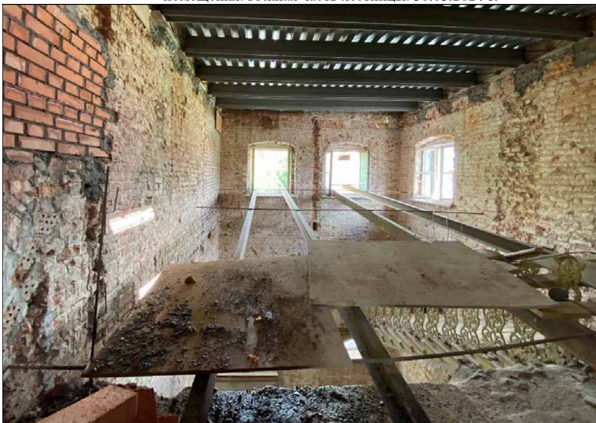
146. Центральный корпус. 3-й этаж. Лестница с северо-восточной стороны от центрального помещения. Северная часть лестницы. 30.03.2024 г.
