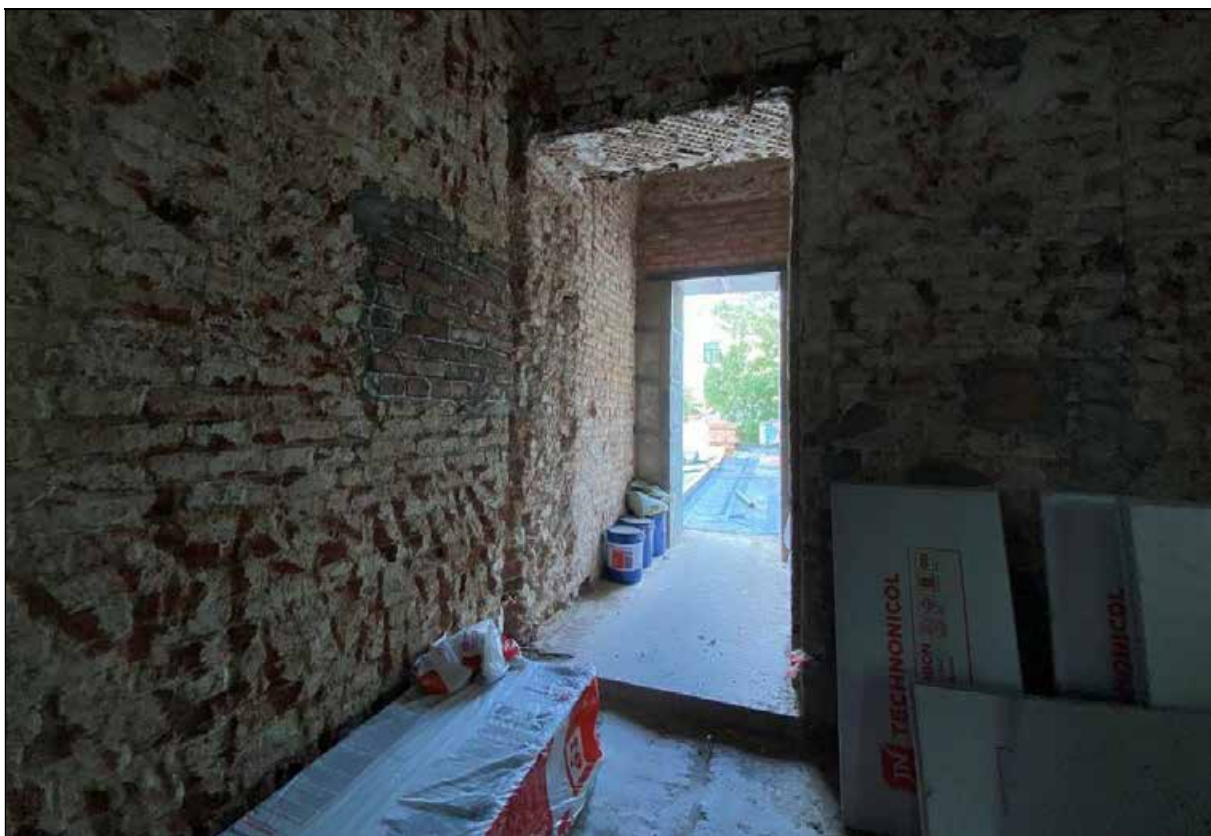
84. Центральный корпус. 2-й этаж. Помещение с северо-западной стороны от центрального помещения. Юго-западная часть помещения. Выход на галерею. 30.03.2024 г.
