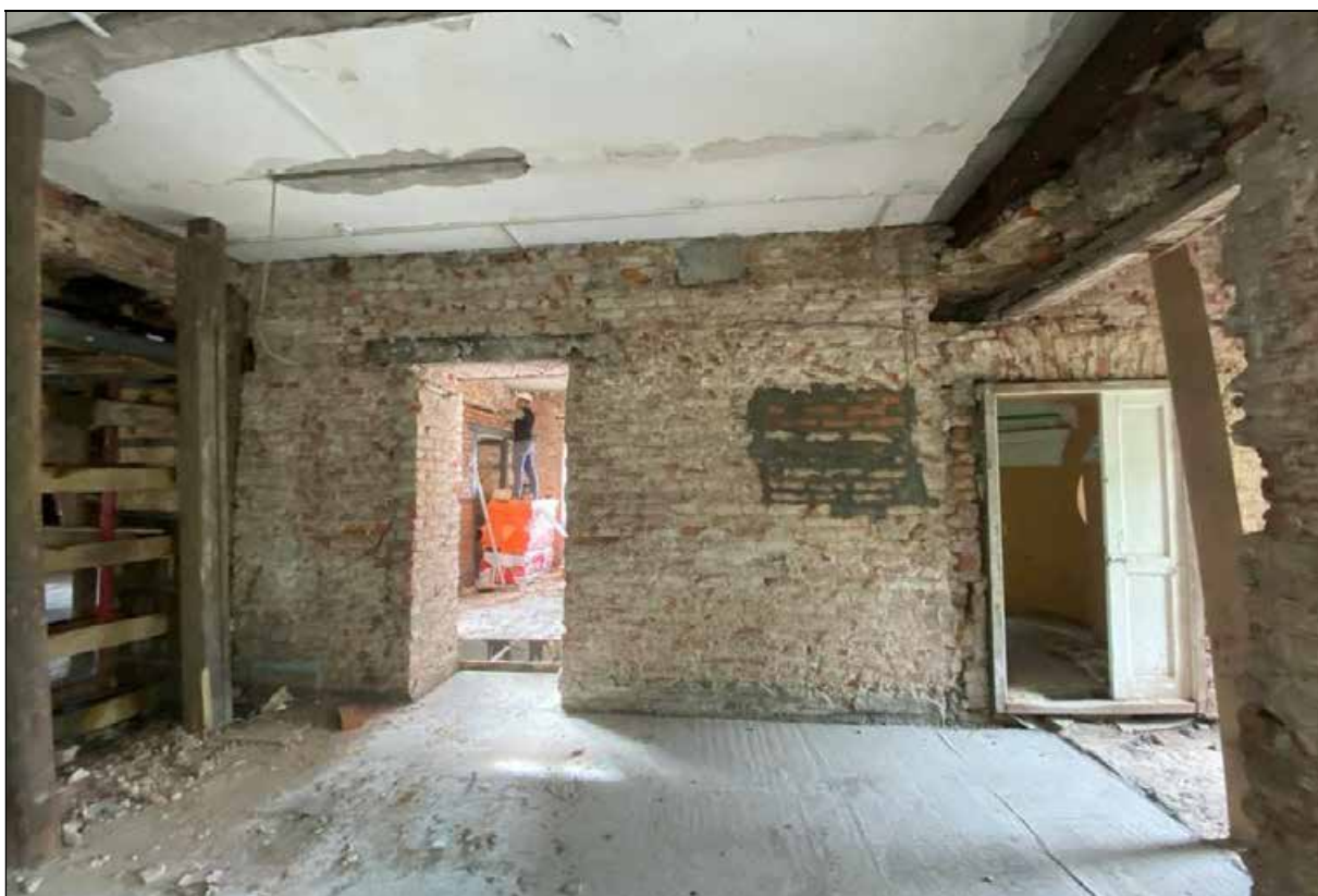
140. Центральный корпус. 3-й этаж. Помещение с северо-западной стороны от центрального помещения. Дверные проемы в южной части помещения. 30.03.2024 г.
