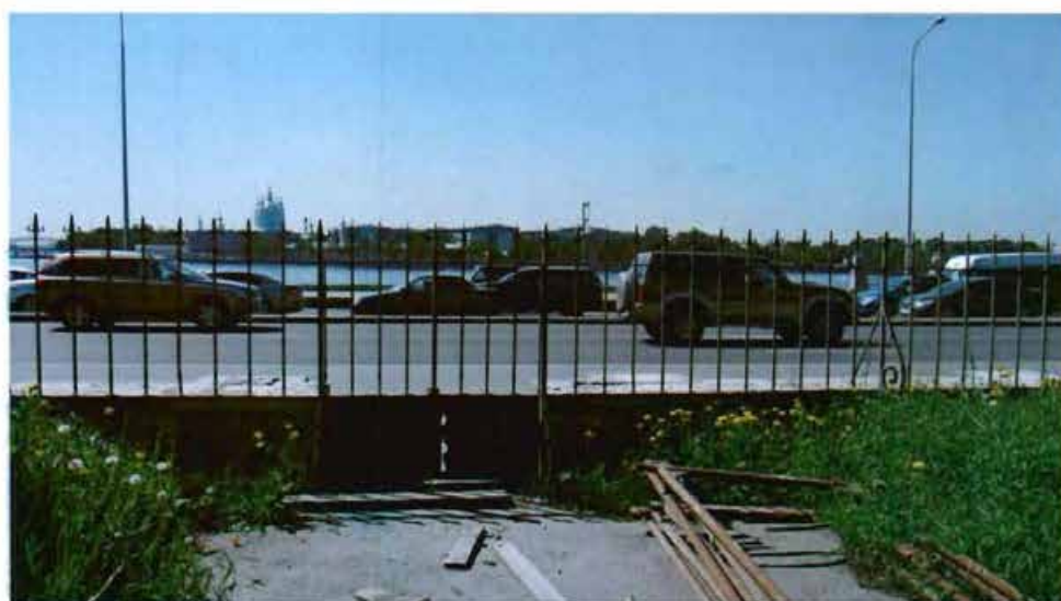
4. Фрагмент северо-восточного фасада объекта культурного наследия.
