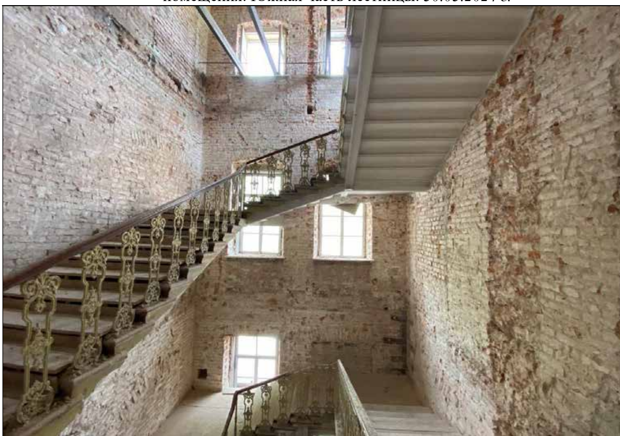
86. Центральный корпус. 2-й этаж. Лестница с северо-восточной стороны от центрального помещения. Северная часть лестницы. 30.03.2024 г.
