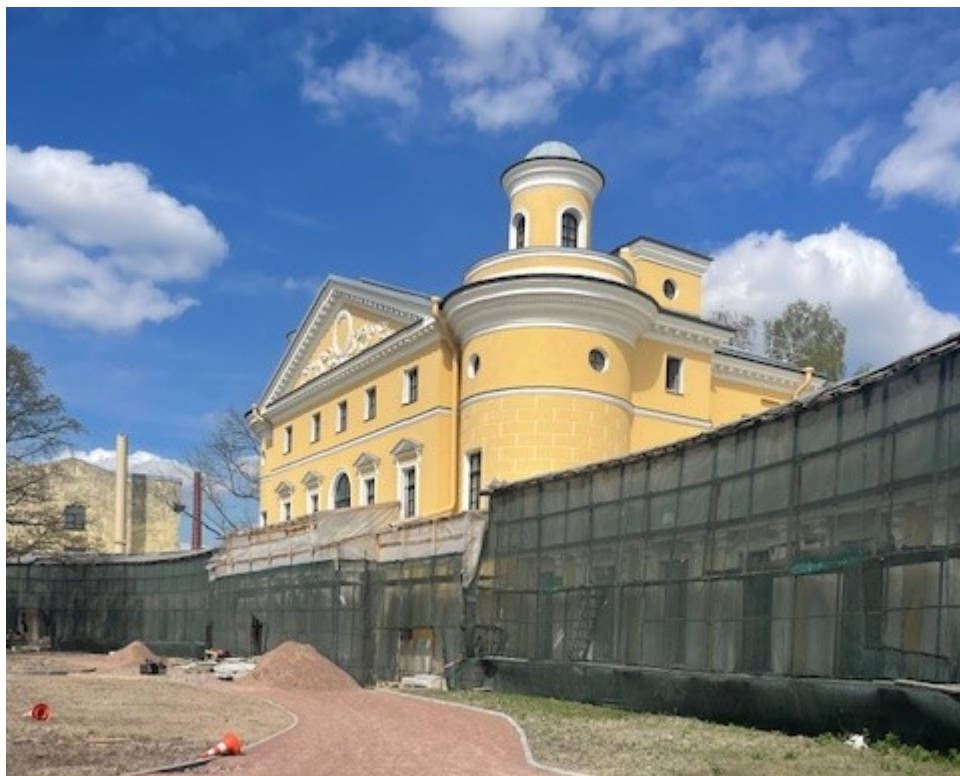
4. Вид на северо-запад от восточного флигеля. 30.03.2024 г.
