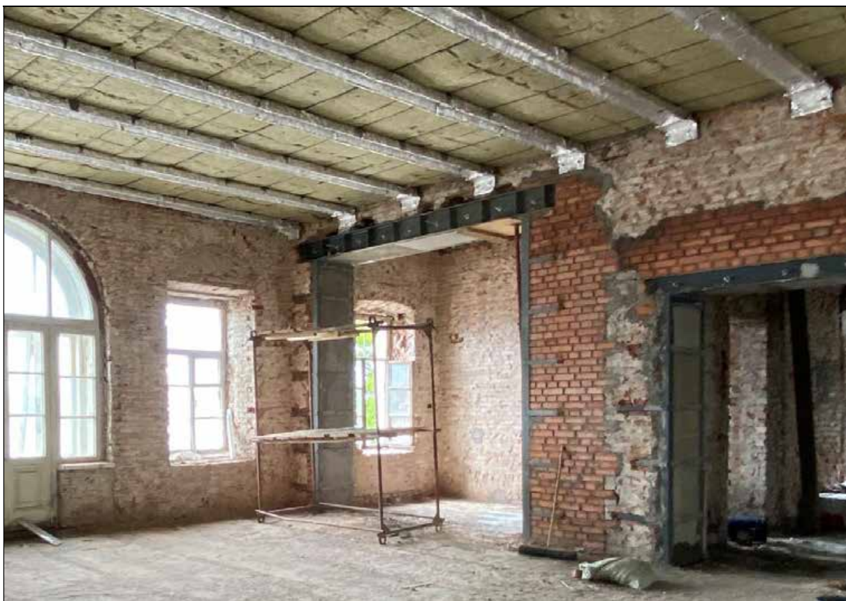
75. Центральный корпус. 2-й этаж. Помещение с юго-западной стороны от центрального помещения. 30.03.2024 г.
