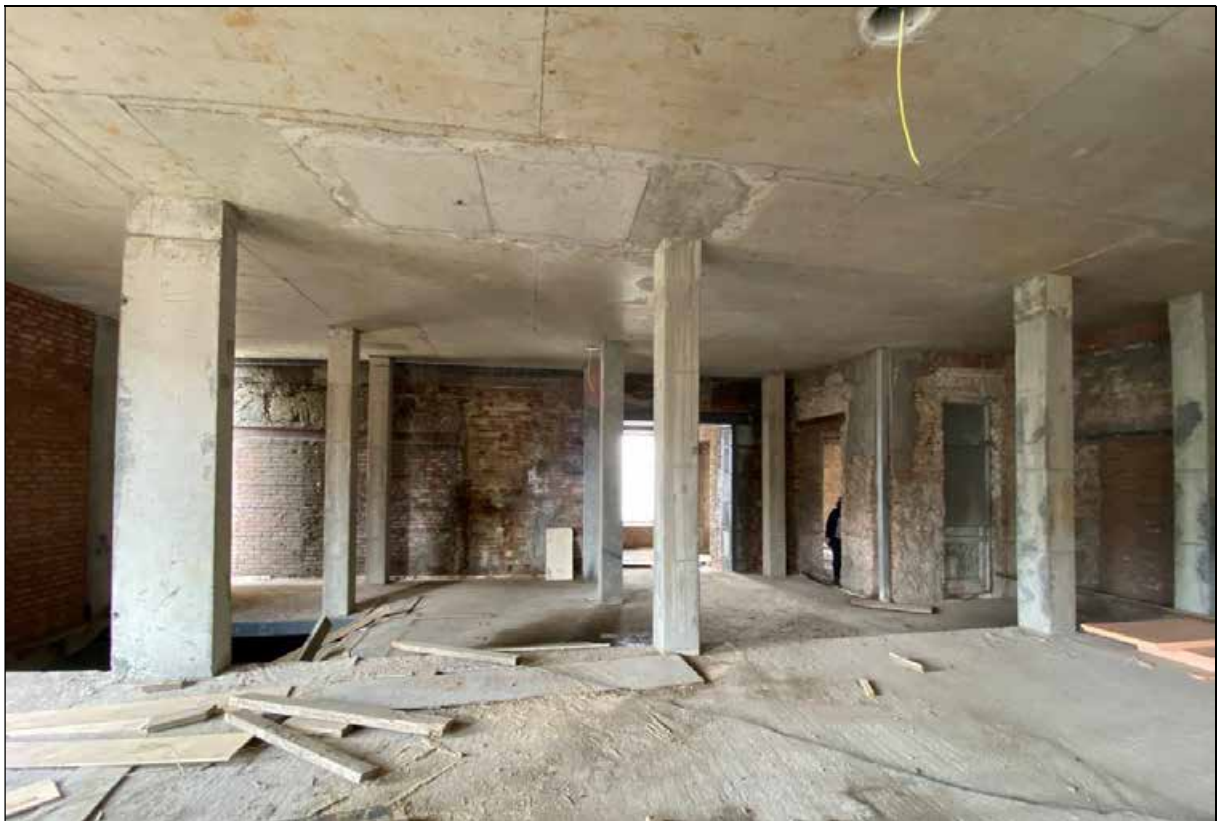
62. Восточное помещение. 1-й этаж. Южная часть помещения. 30.03.2024 г.
