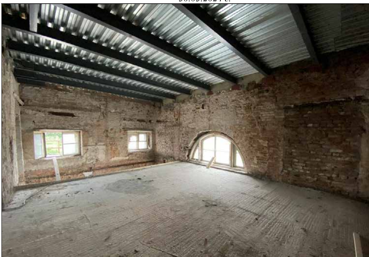
122. Восточный флигель. 2-й этаж. Юго-западное помещение. Северо-восточная часть помещения. 30.03.2024 г.
