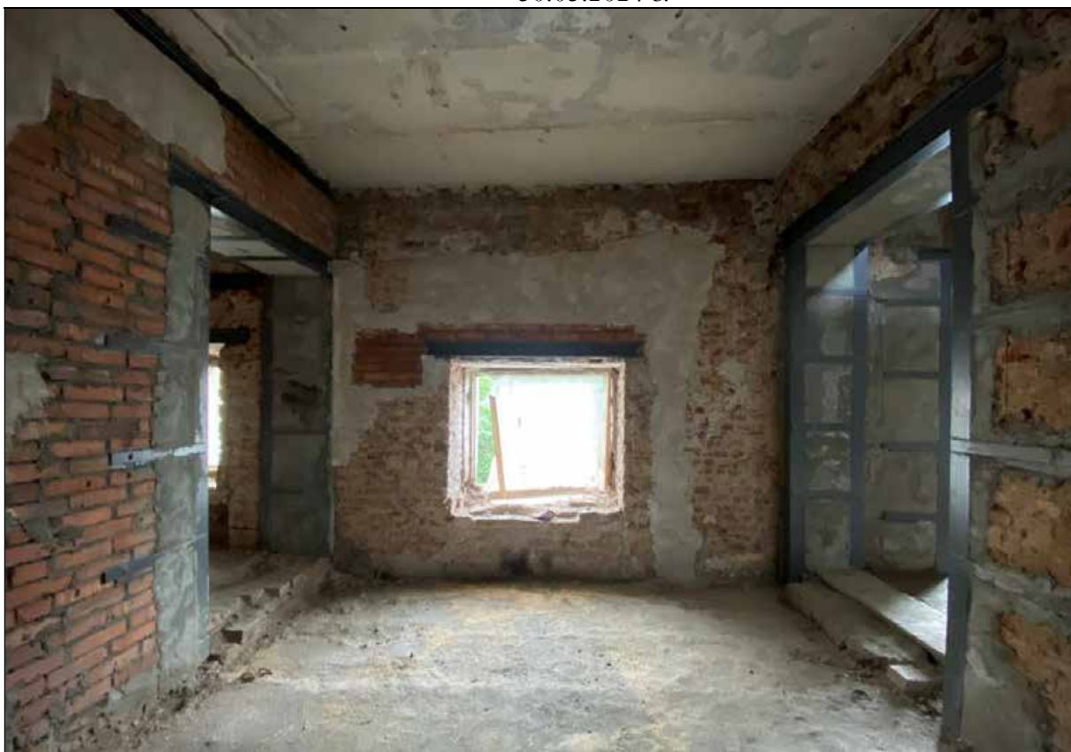
106. Западный флигель. 2-й этаж. Центральное помещение. Оконный проем в северной части помещения. 30.03.2024 г.
