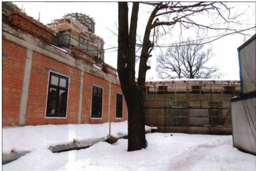
8. Часть территории объекта культурного наследия федерального значения «Дача Безбородко А.А. (Кушелевых–Безбородко)».
