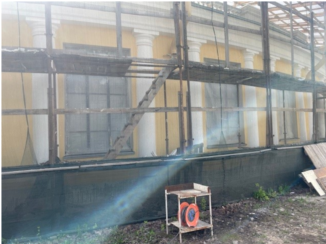
27. Фрагмент дворового фасада западной галереи. Вид на юг. 30.03.2024 г.
