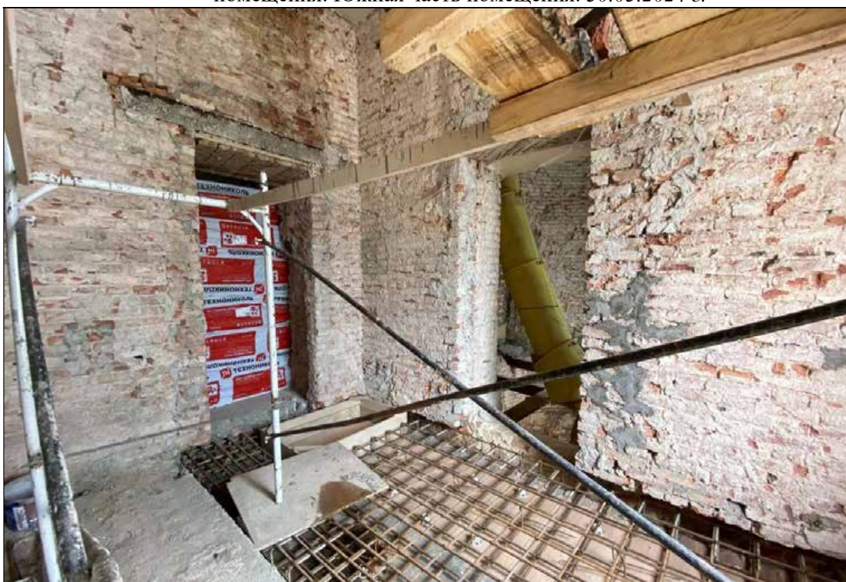
74. Центральный корпус. 2-й этаж. Помещение с юго-восточной стороны от центрального помещения. Северо-восточная часть помещения. 30.03.2024 г.
