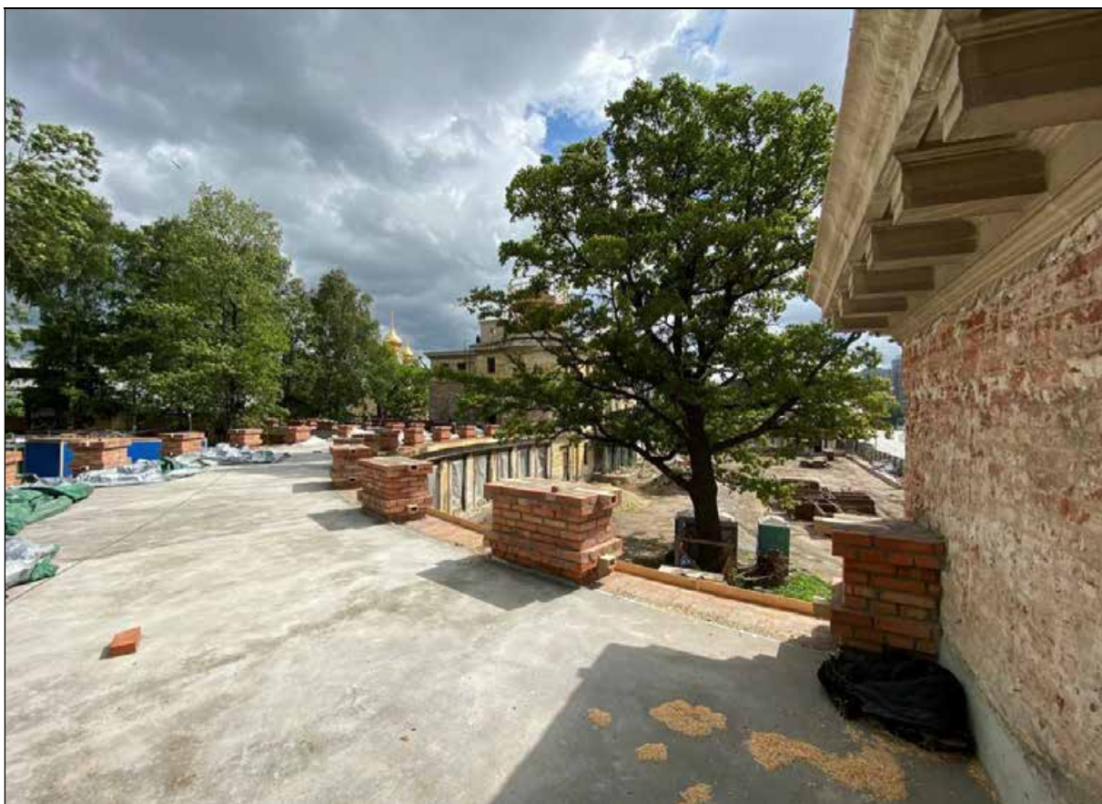
93. Плоское перекрытие западной галереи. Вид в сторону центрального корпуса от западного флигеля. 30.03.2024 г.
