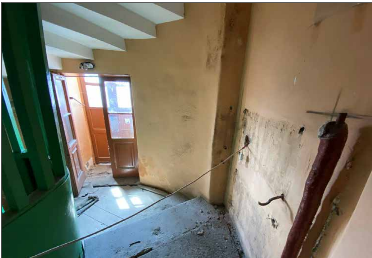
23. Центральный корпус. 1-й этаж. Винтовая лестница в западной башне. Выход в парадный двор в южной части башни. 30.03.2024 г.
