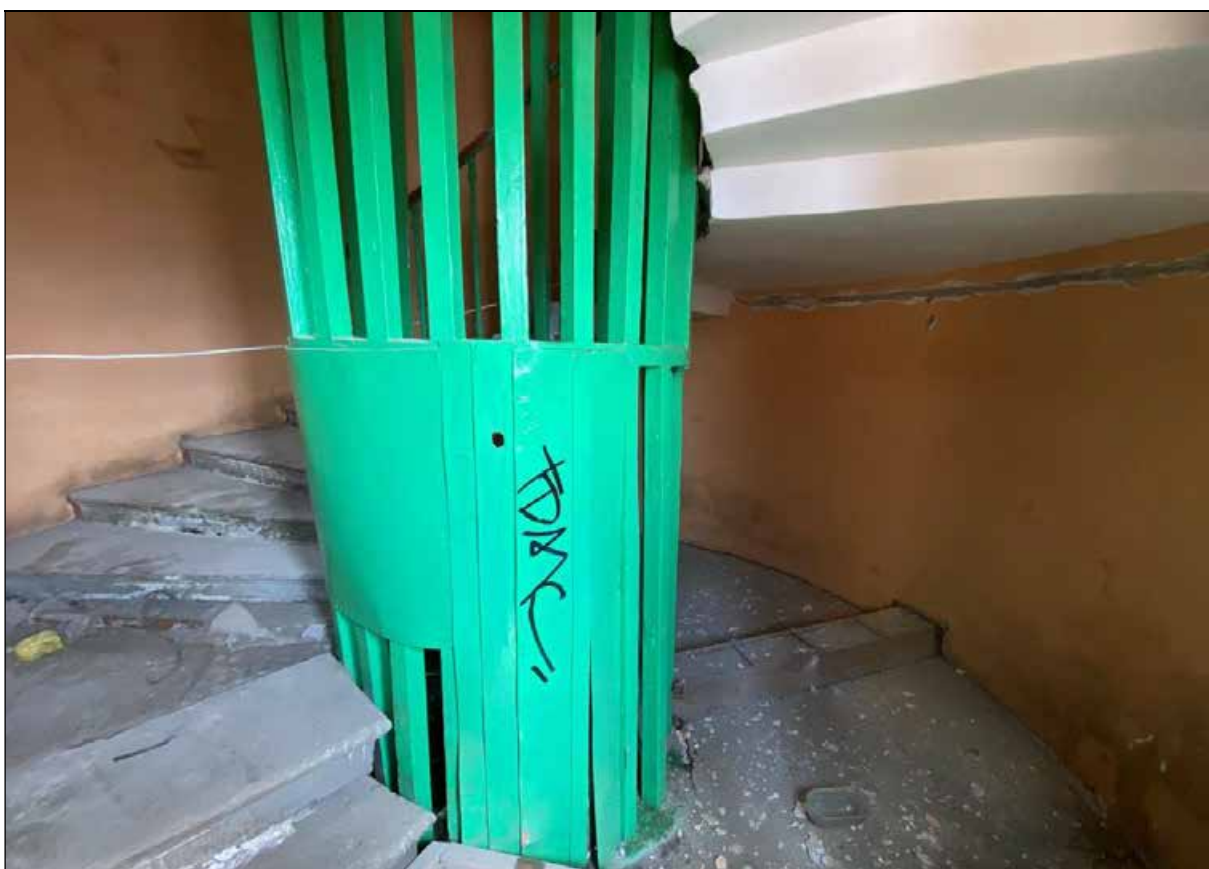
24. Центральный корпус. 1-й этаж. Винтовая лестница в западной башне. 30.03.2024 г.
