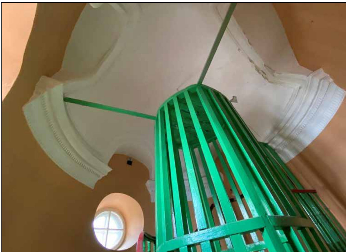
153. Центральный корпус. 3-й этаж. Винтовая лестница в западной башне. Купольный свод с распалубками. 30.03.2024 г.
