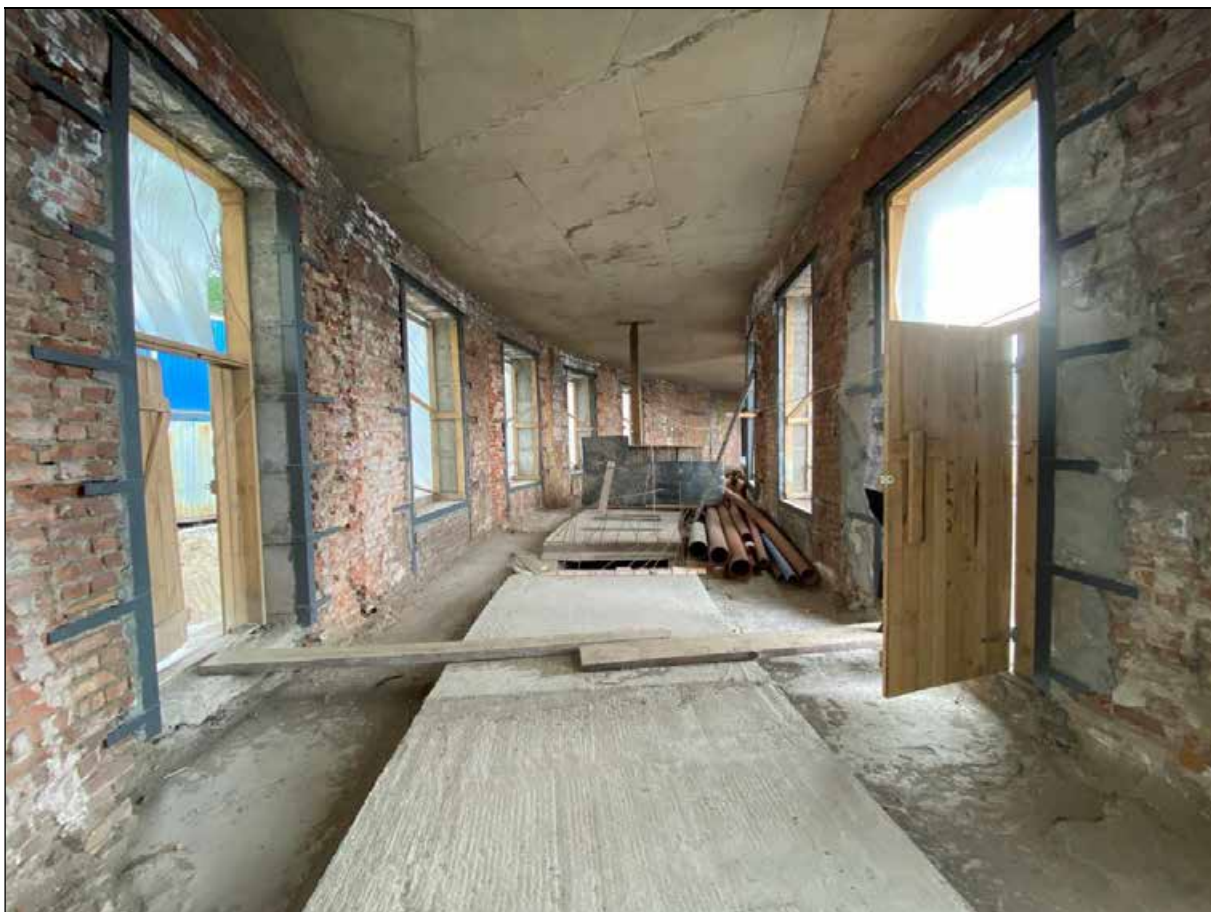
29. Западная галерея. 1-й этаж. Дверные проемы в центральной части галереи. 30.03.2024 г.
