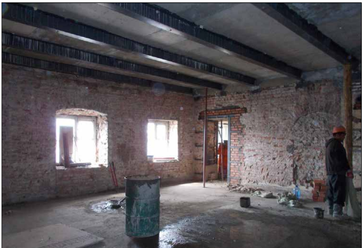
128. Центральный корпус. 3-й этаж. Центральное помещение. Юго-западная часть помещения. 30.03.2024 г.
