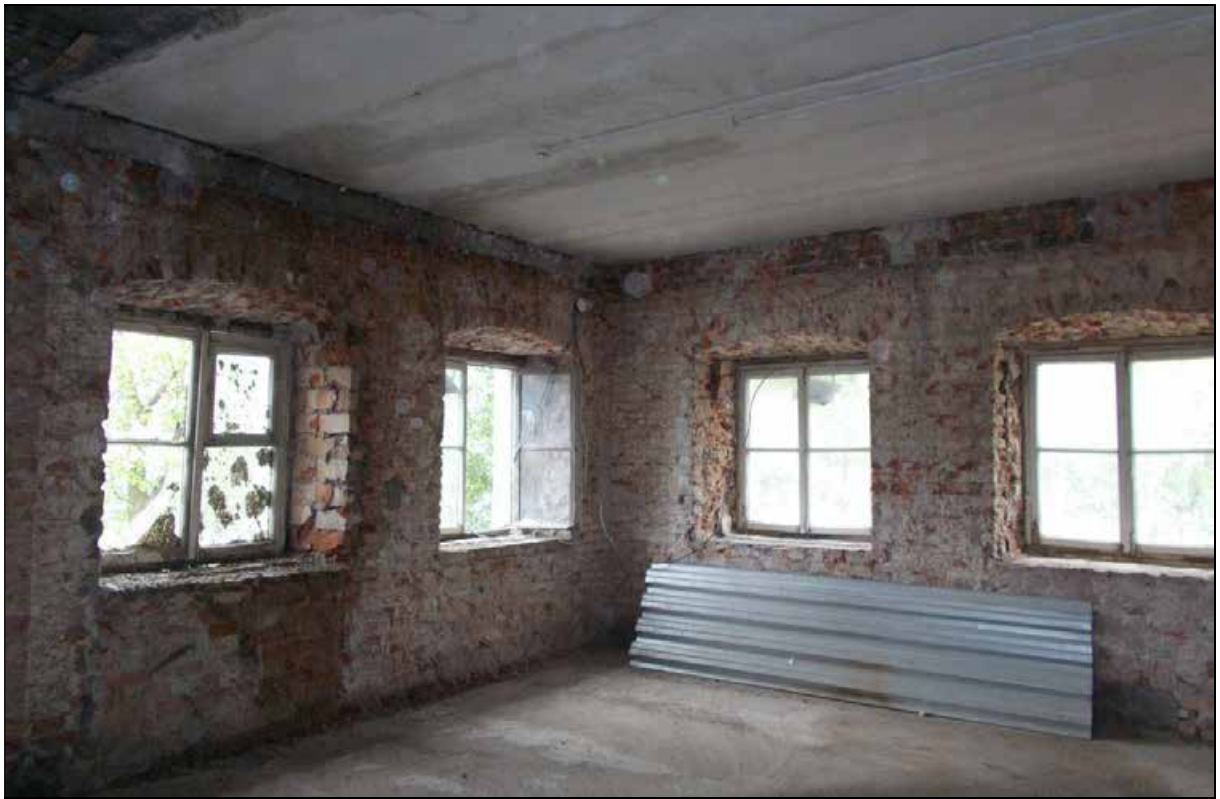
137. Центральный корпус. 3-й этаж. Помещение с северо-западной стороны от центрального помещения. Оконные проемы в северо-западной части помещения. 30.03.2024 г.
