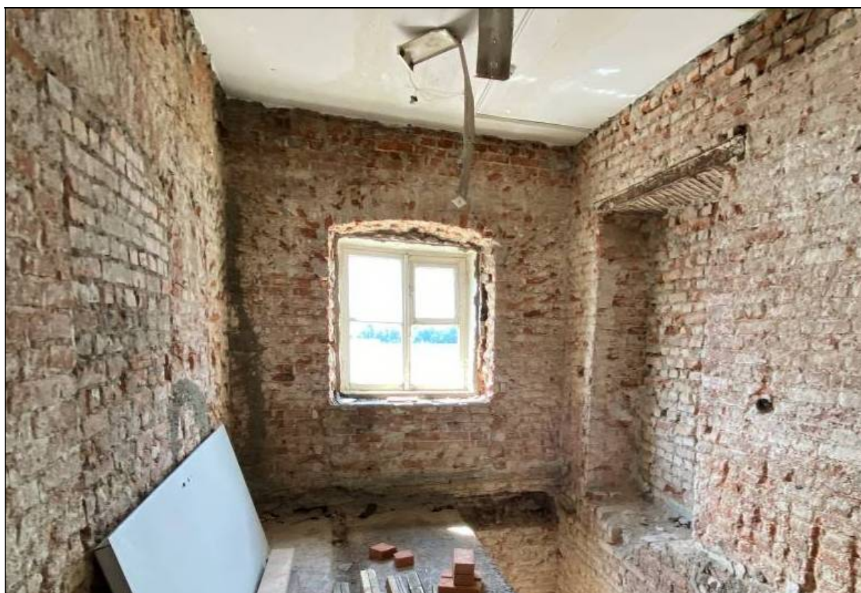
144. Центральный корпус. 3-й этаж. Помещение с юго-восточной стороны от центрального помещения. Южная часть помещения. Оконный проем и ниша. 30.03.2024 г.
