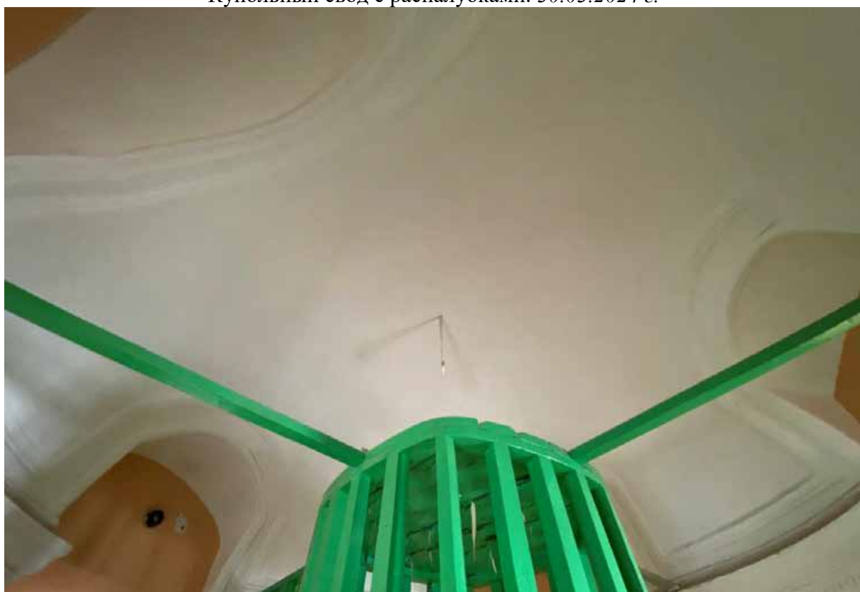
154. Центральный корпус. 3-й этаж. Винтовая лестница в западной башне. Купольный свод с распалубками. 30.03.2024 г.
