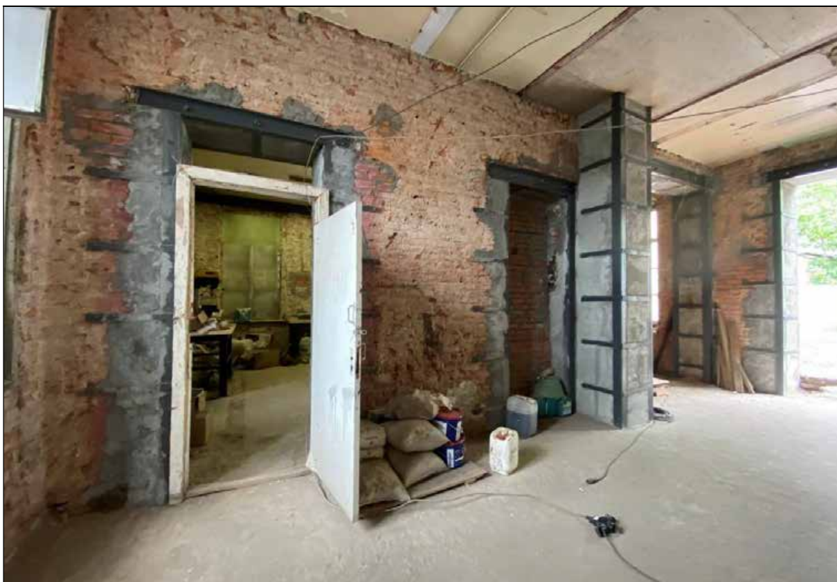
39. Западный флигель. 1-й этаж. Северо-западная часть центрального помещения. Проемы в западной стене. 30.03.2024 г.
