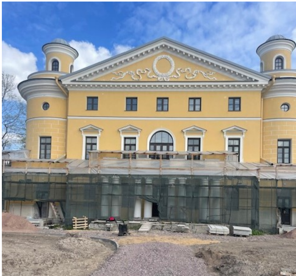
5. Вид от центральных ворот на северо-восток. Южный фасад центрального корпуса. 30.03.2024 г.
