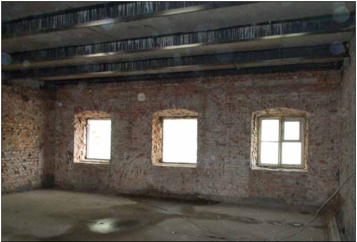
131. Центральный корпус. 3-й этаж. Центральное помещение. Оконные проемы в северной части помещения. 30.03.2024 г.
