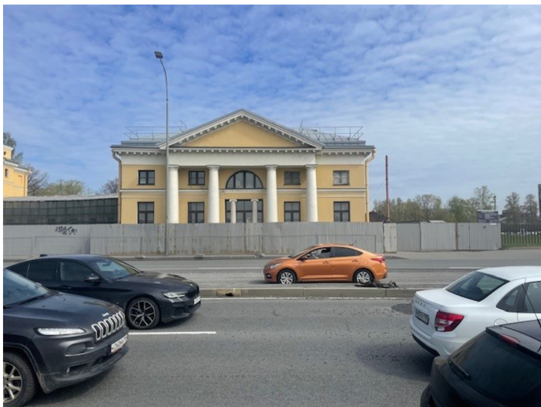
17. Южный фасад восточного флигеля. Вид на северо-восток от Свердловской набережной. 30.03.2024 г.
