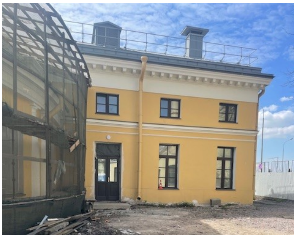
14. Северный фасад западного флигеля. Вид на юг. 30.03.2024 г.
