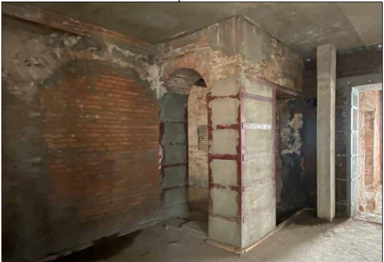
60. Западное помещение. 1-й этаж. Юго-восточная часть помещения. Проход в центральный корпус. 30.03.2024 г.
