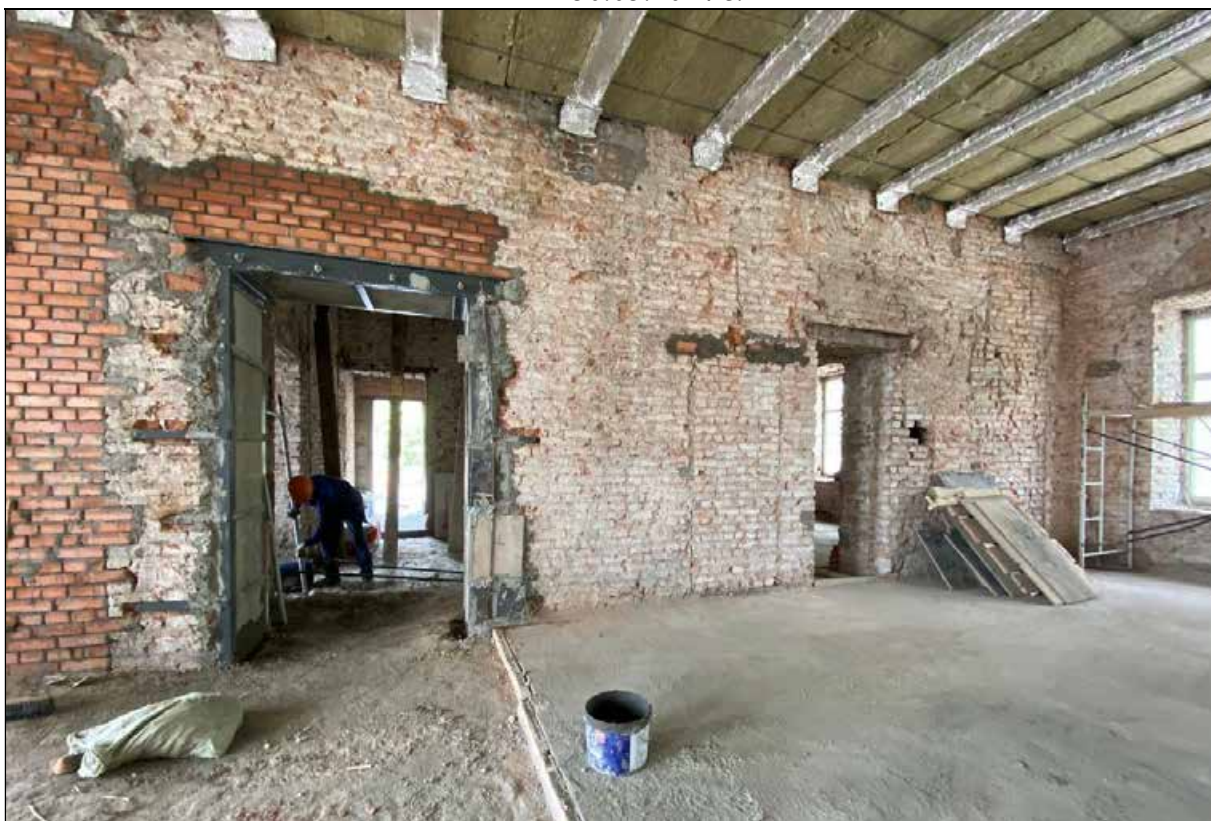
70. Центральный корпус. 2-й этаж. Центральное помещение. Северо-западная часть помещения. Проемы в западной стене. 30.03.2024 г.
