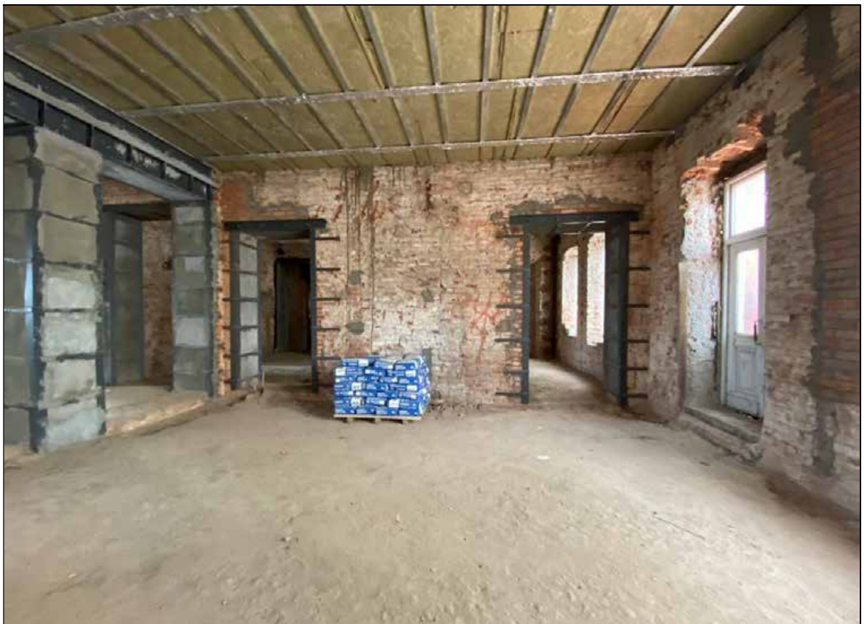
11. Центральный корпус. 1-й этаж. Северо-западная часть центрального помещения. 30.03.2024 г.
