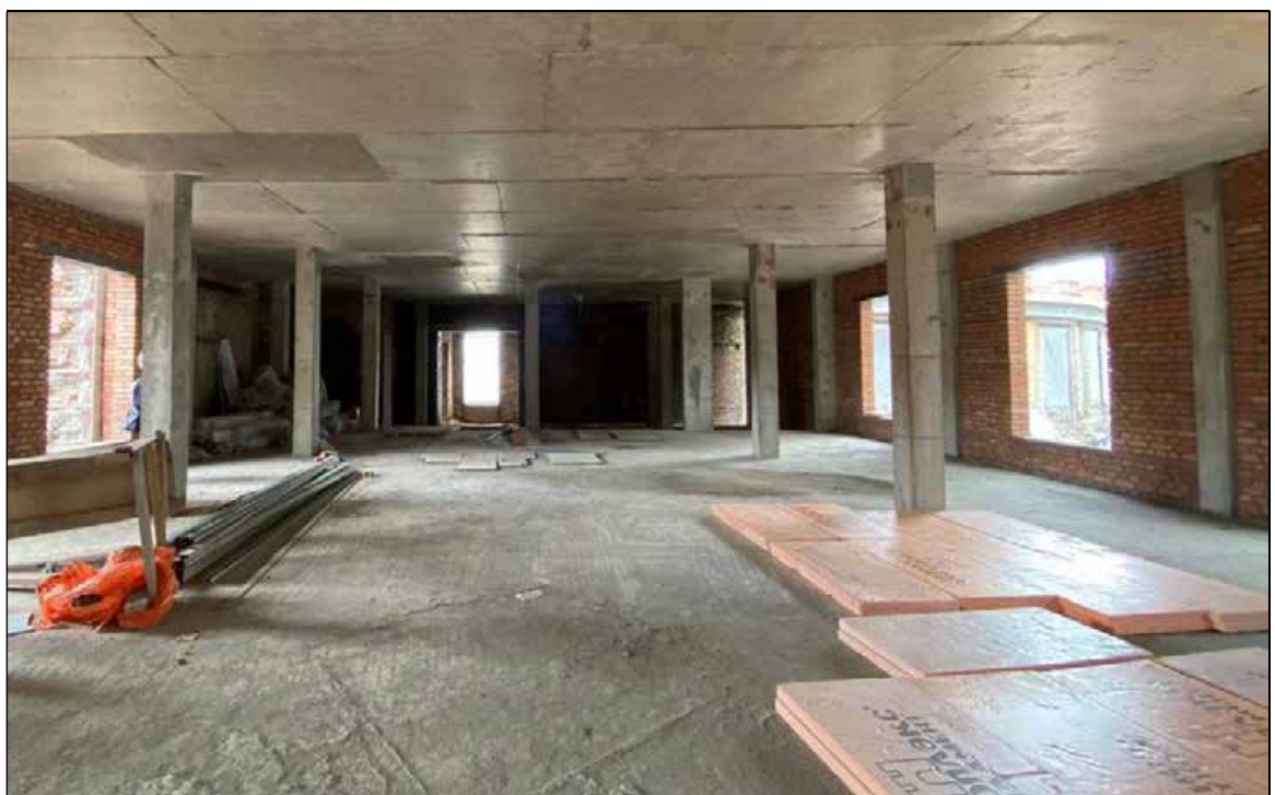
58. Западное помещение. 1-й этаж. Южная часть помещения. 30.03.2024 г.
