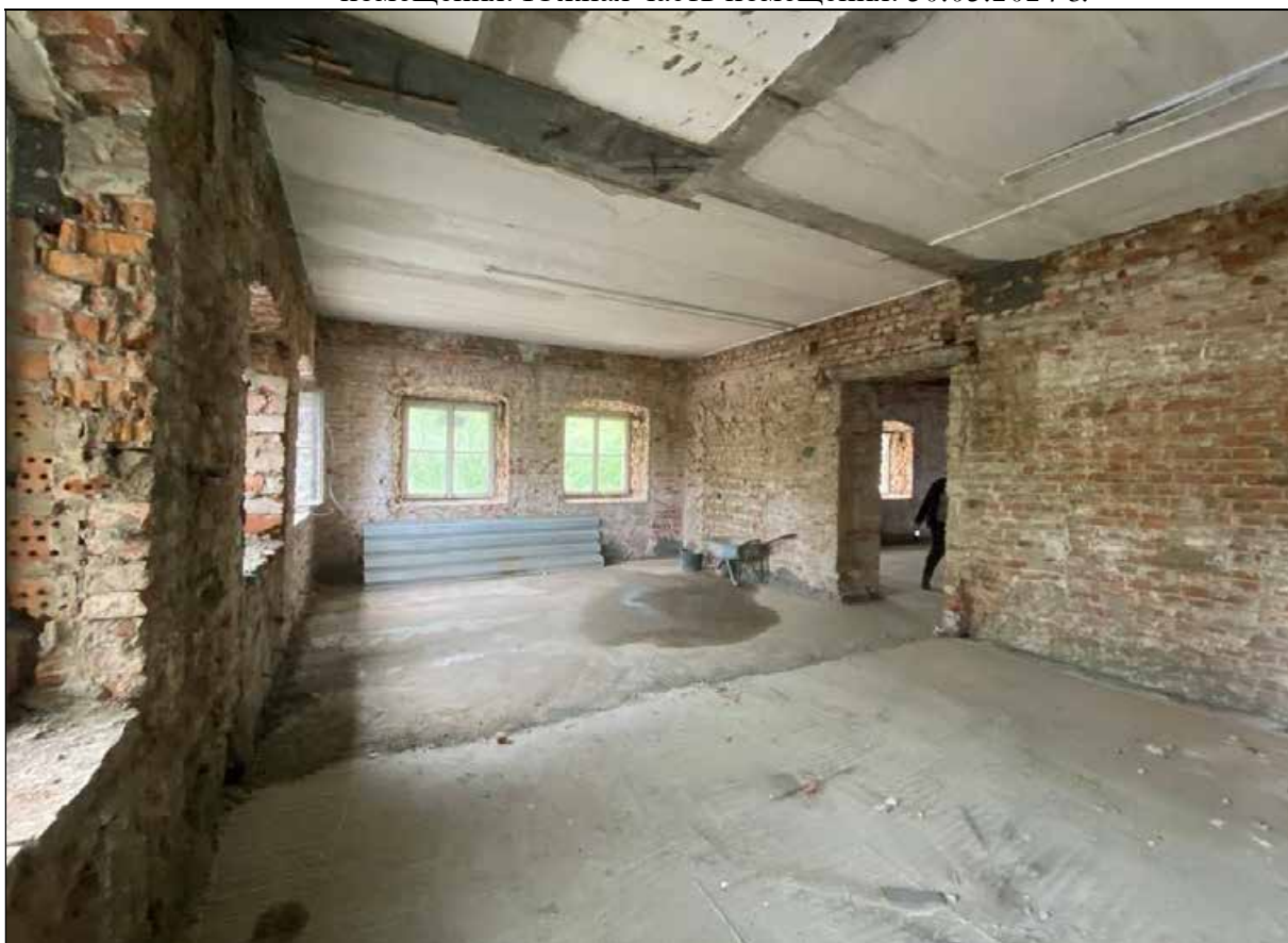
136. Центральный корпус. 3-й этаж. Помещение с северо-западной стороны от центрального помещения. Северная часть помещения. 30.03.2024 г.
