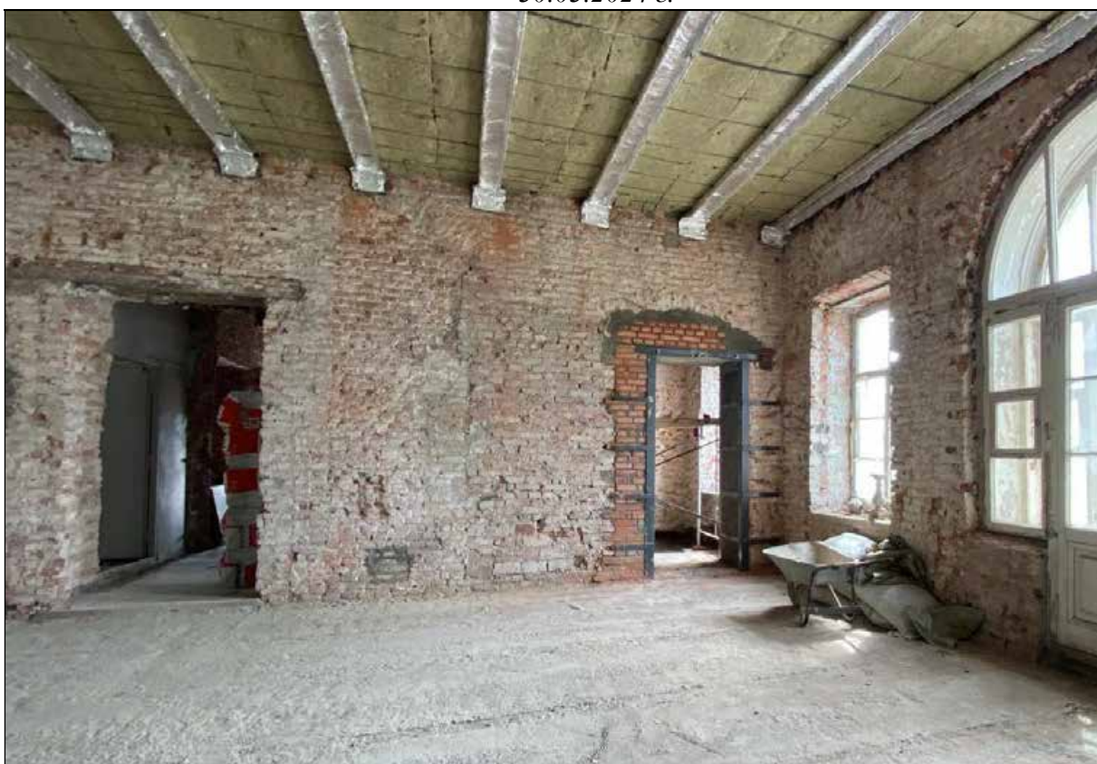
72. Центральный корпус. 2-й этаж. Центральное помещение. Юго-восточная часть помещения. Проемы в восточной стене. 30.03.2024 г.
