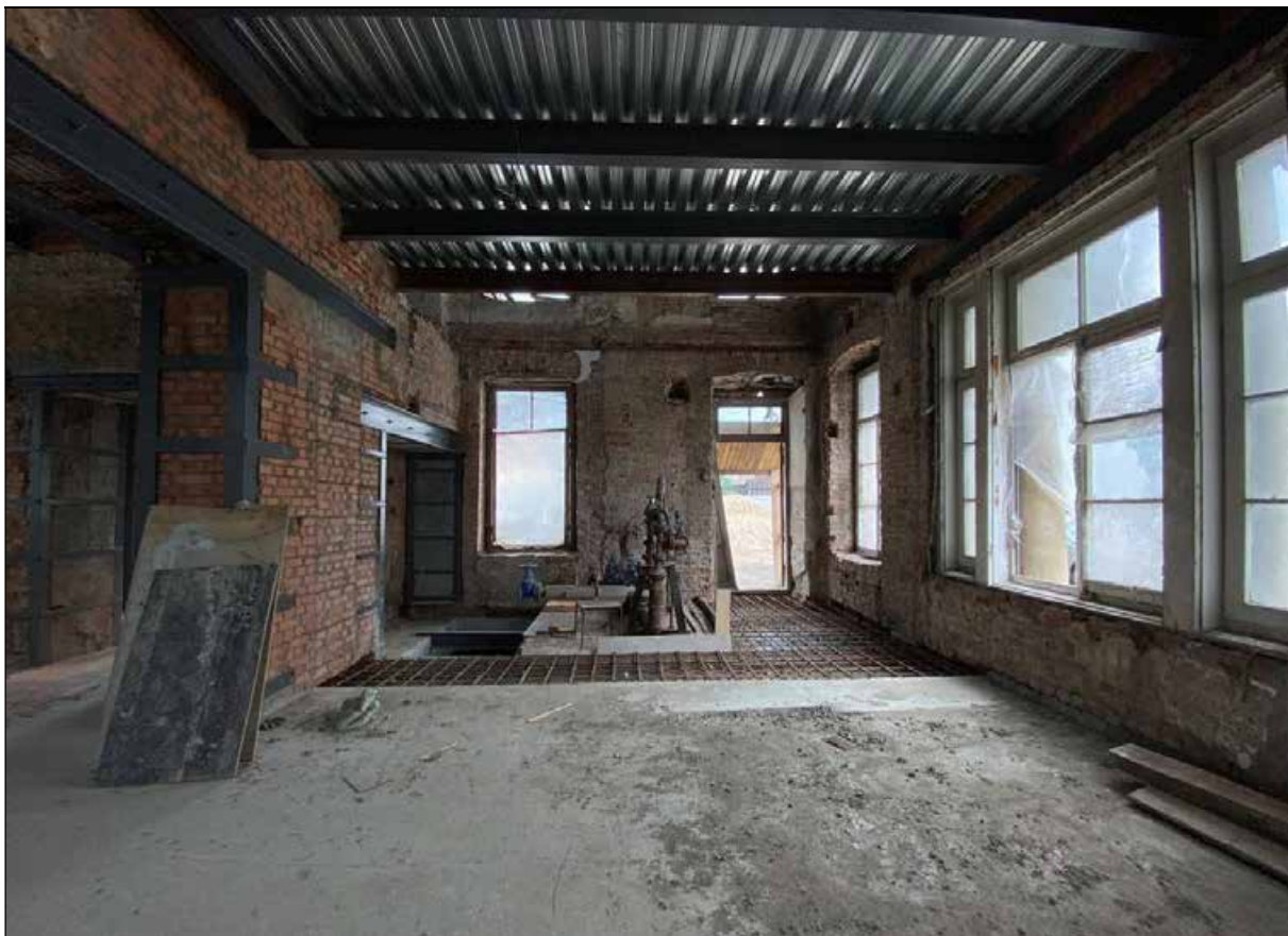
55. Восточный флигель. 1-й этаж. Восточное помещение. Северная помещения. 30.03.2024 г.
