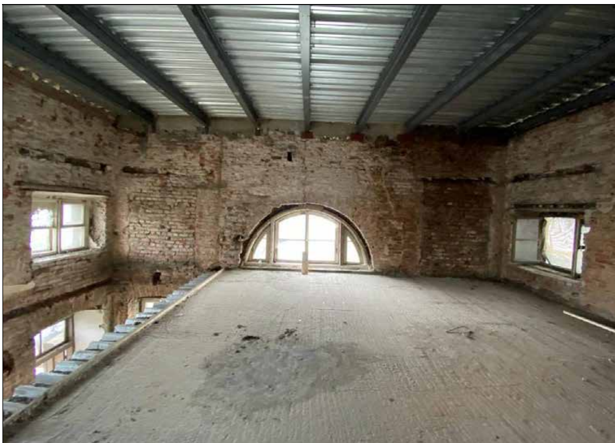
121. Восточный флигель. 2-й этаж. Юго-западное помещение. Восточная часть помещения. 30.03.2024 г.
