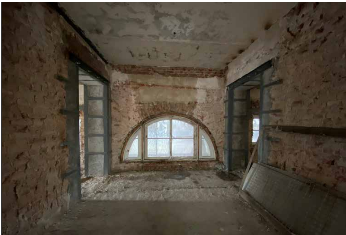
104. Западный флигель. 2-й этаж. Центральное помещение. Арочный оконный проем в южной части помещения. 30.03.2024 г.
