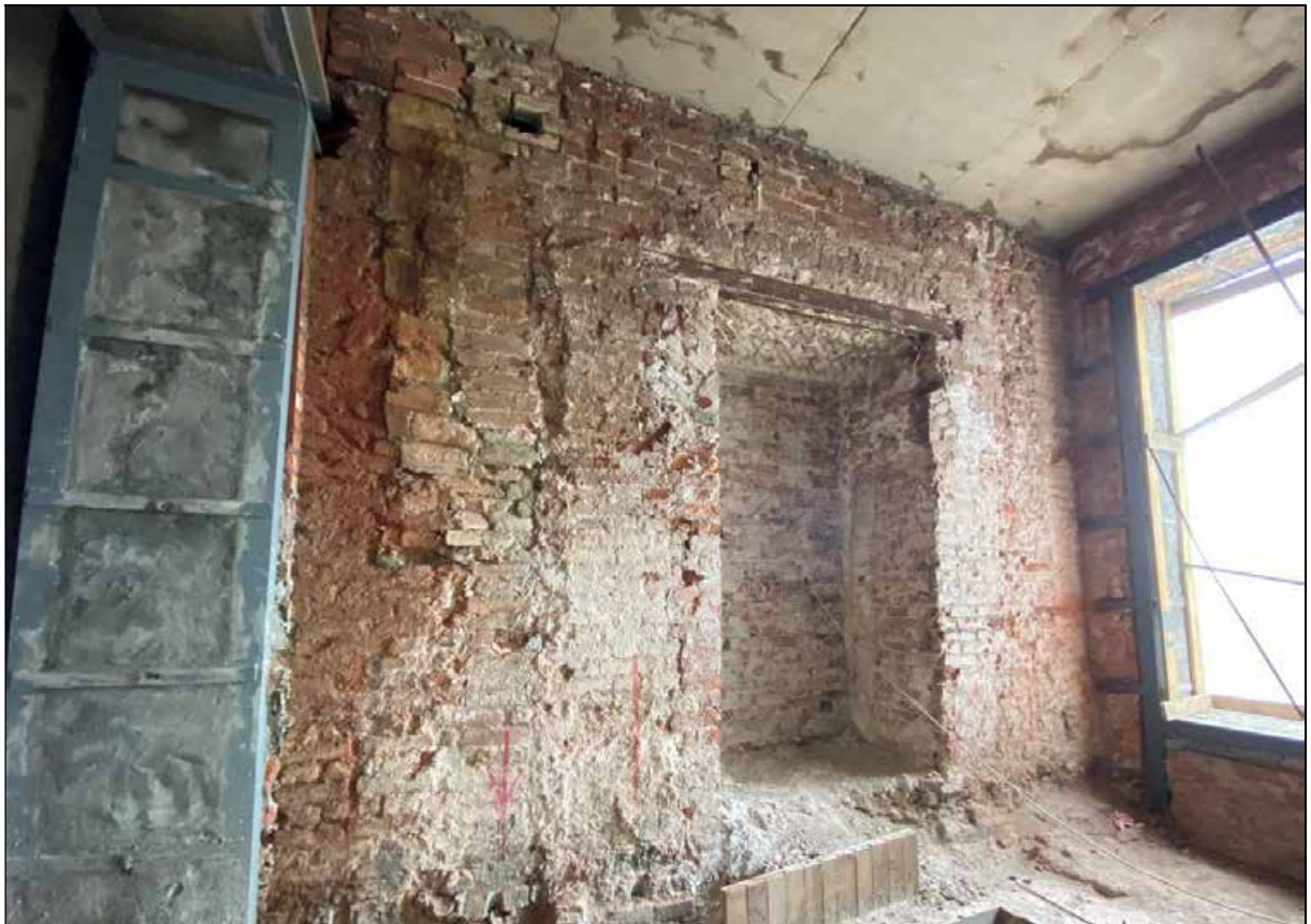
32. Западная галерея. 1-й этаж. Ниша в восточной стене. 30.03.2024 г.
