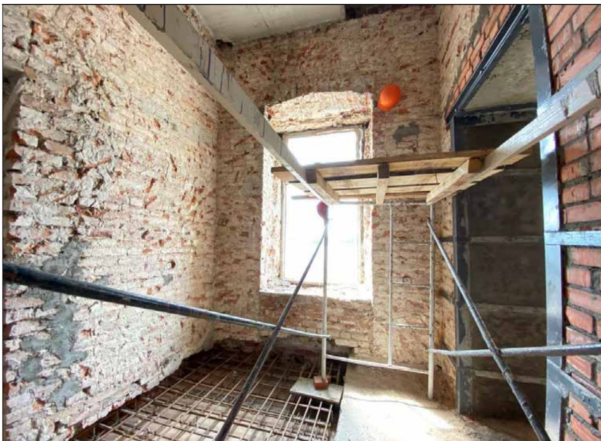
73. Центральный корпус. 2-й этаж. Помещение с юго-восточной стороны от центрального помещения. Южная часть помещения. 30.03.2024 г.
