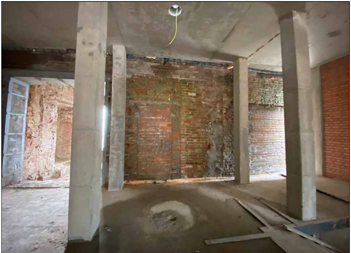
59. Западное помещение. 1-й этаж. Юго-западная часть помещения. Проход в западную галерею. 30.03.2024 г.
