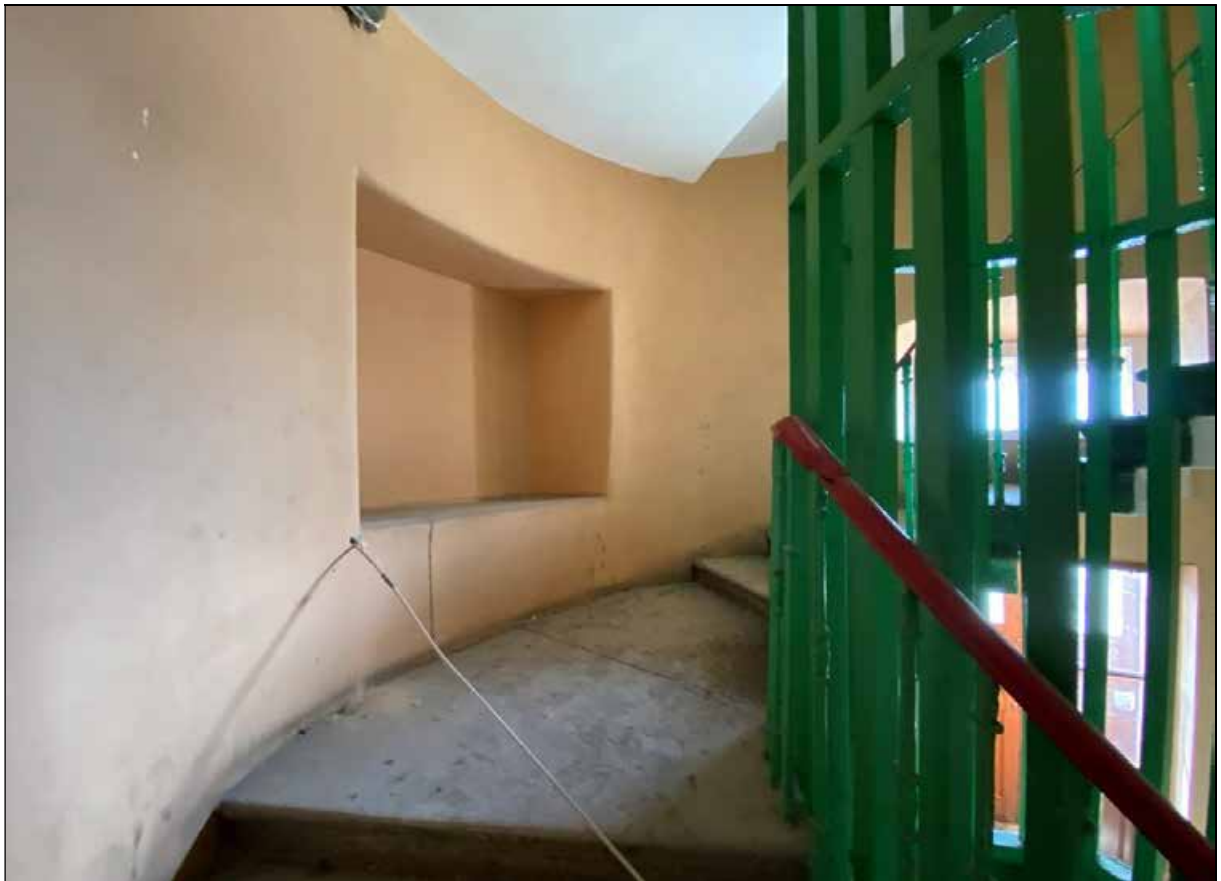
25. Центральный корпус. 1-й этаж. Винтовая лестница в западной башне. Ниша. 30.03.2024 г.
