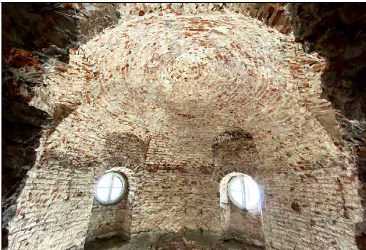
148. Центральный корпус. 3-й этаж. Купольный свод в восточной башне. Окна-люкарны. 30.03.2024 г.
