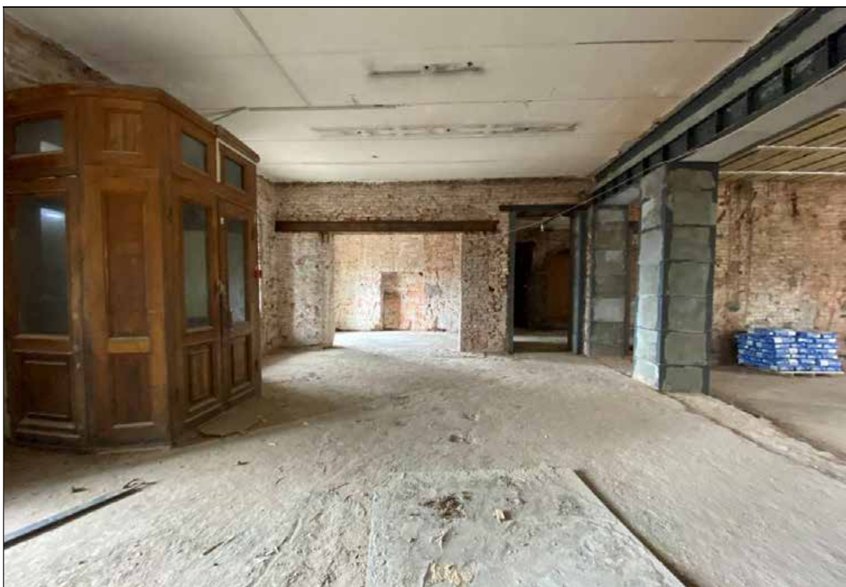
4. Центральный корпус. 1-й этаж. Юго-западная часть центрального помещения. 30.03.2024 г.
