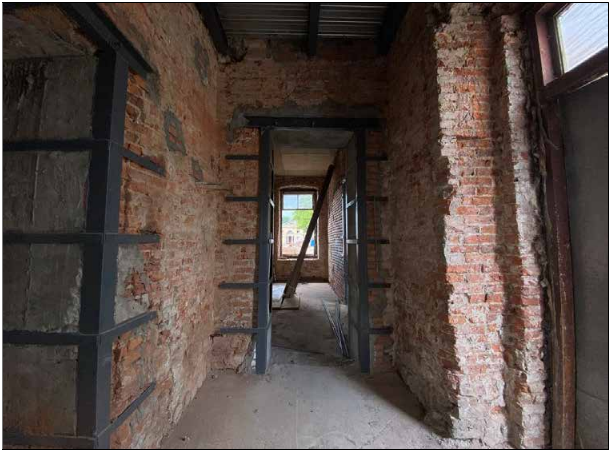
49. Восточный флигель. 1-й этаж. Центральное северное помещение. Вид в сторону северо-западного помещения. 30.03.2024 г.
