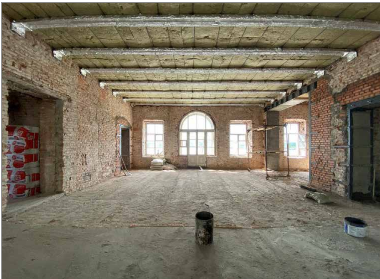
65. Центральный корпус. 2-й этаж. Центральное помещение. Южная часть помещения. 30.03.2024 г.
