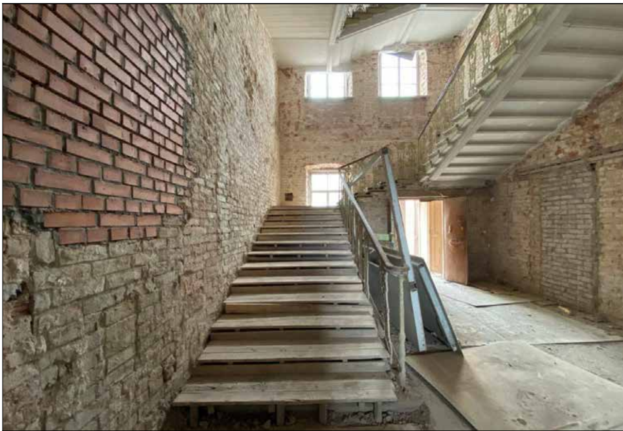
17. Центральный корпус. 1-й этаж. Лестница с северо-восточной стороны от центрального помещения. Северная часть лестницы. 30.03.2024 г.
