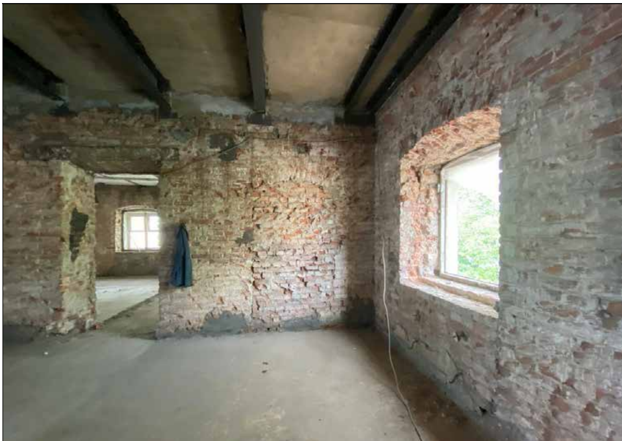
133. Центральный корпус. 3-й этаж. Центральное помещение. Дверной проем в северо-западной части помещения. 30.03.2024 г.
