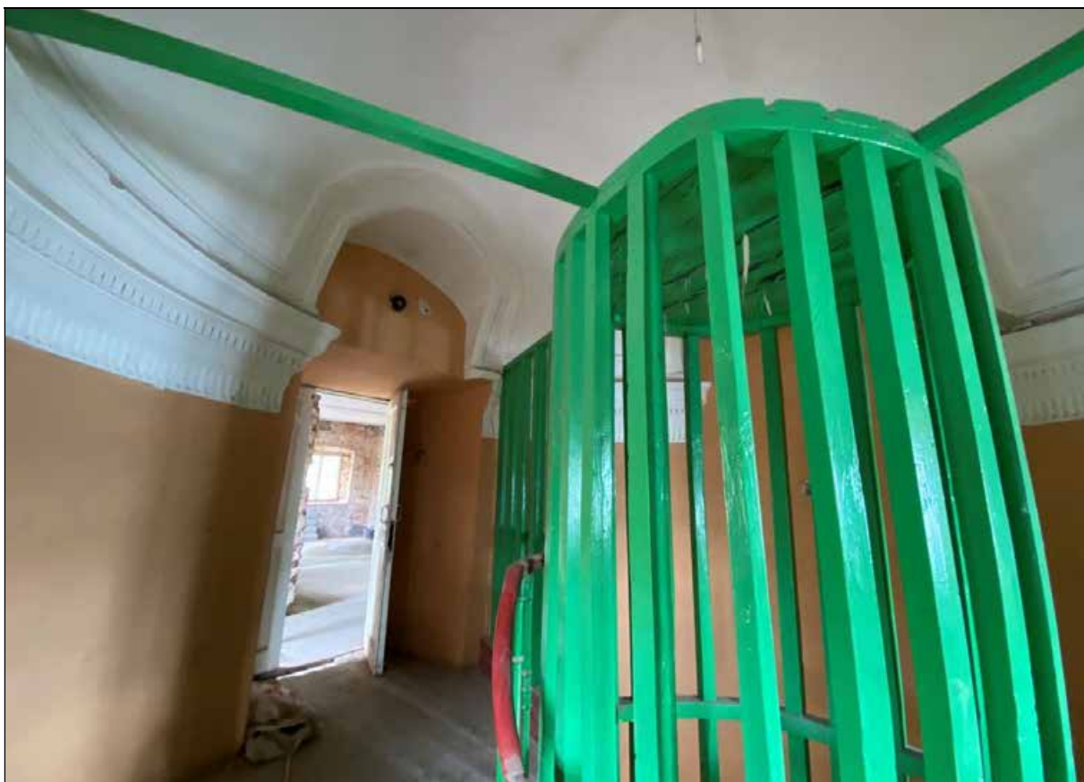
155. Центральный корпус. 3-й этаж. Винтовая лестница в западной башне. Дверной проем на лестничной площадке. 30.03.2024 г.
