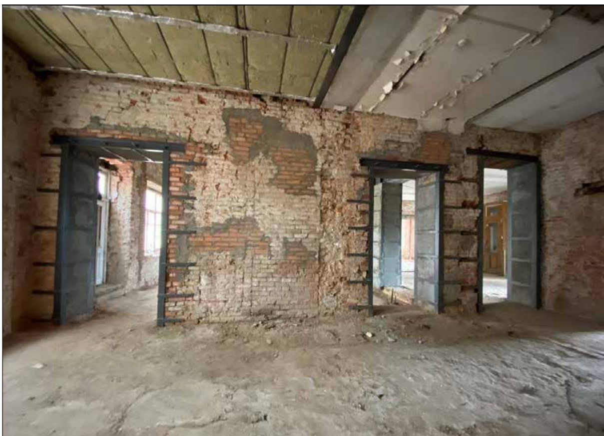
16. Центральный корпус. 1-й этаж. Помещение с северо-западной стороны от центрального помещения. Проемы в восточной стене. 30.03.2024 г.
