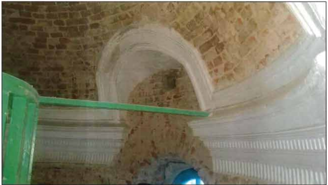
6. Интерьер. объекта культурного наследия. Фрагмент. Профилированный карниз с поясами зубчиков в западной башне.
