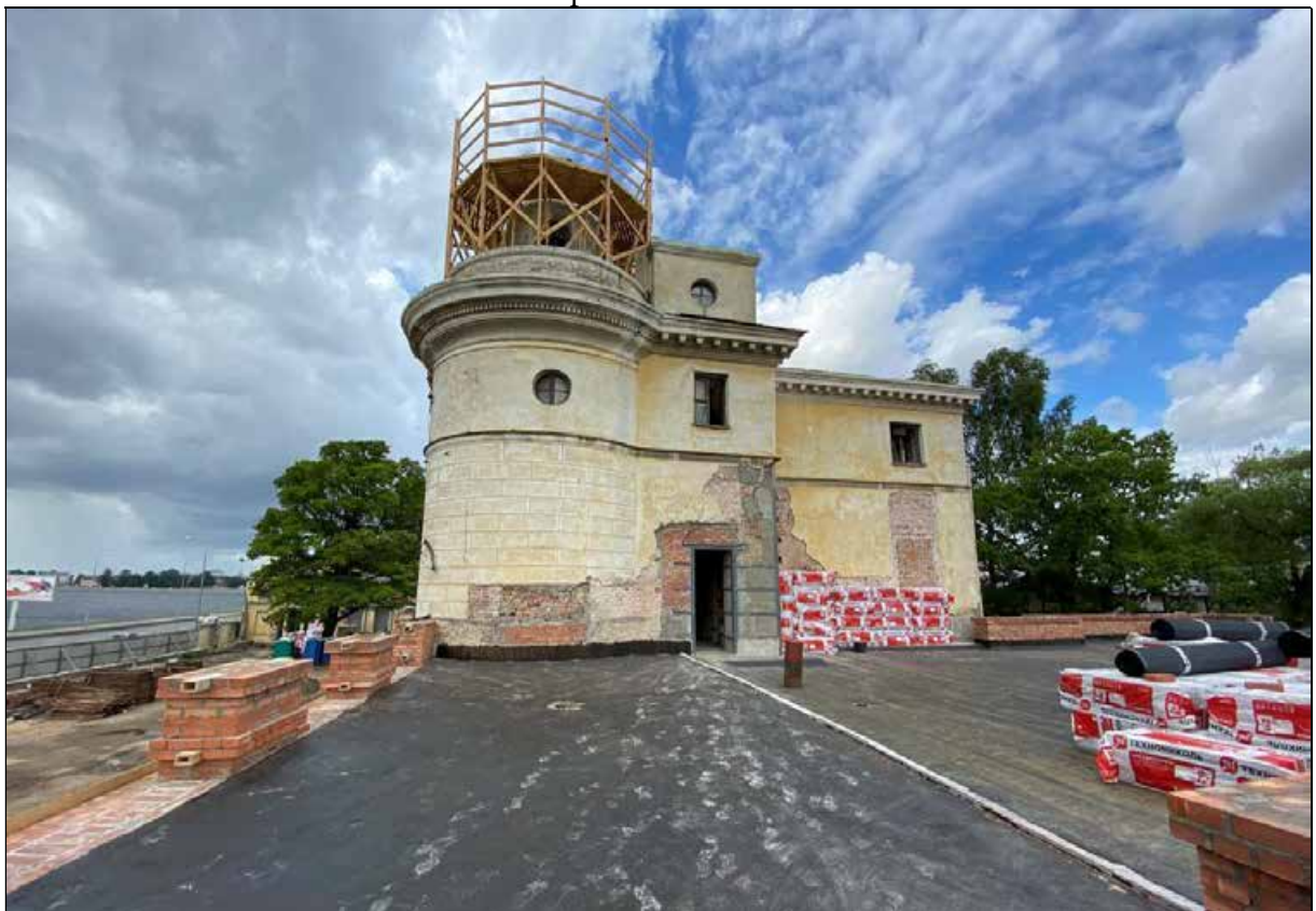
100. Плоское перекрытие восточной галереи. Восточный фасад центрального корпуса. 30.03.2024 г.
