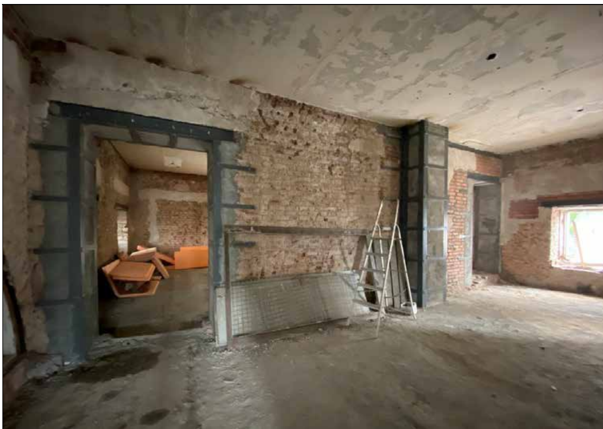
107. Западный флигель. 2-й этаж. Центральное помещение. Проемы в западной стене. 30.03.2024 г.
