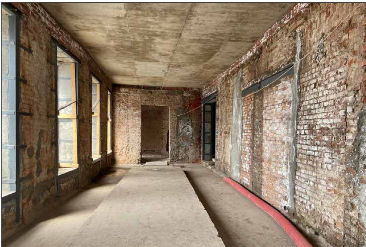
34. Восточная галерея. 1-й этаж. Вход в восточную башню в западной стене. 30.03.2024 г.
