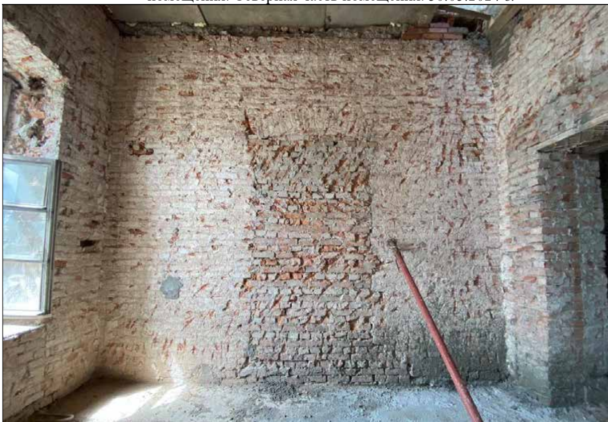
78. Центральный корпус. 2-й этаж. Помещение с юго-западной стороны от центрального помещения. Заложенный проем в западной стене. 30.03.2024 г.
