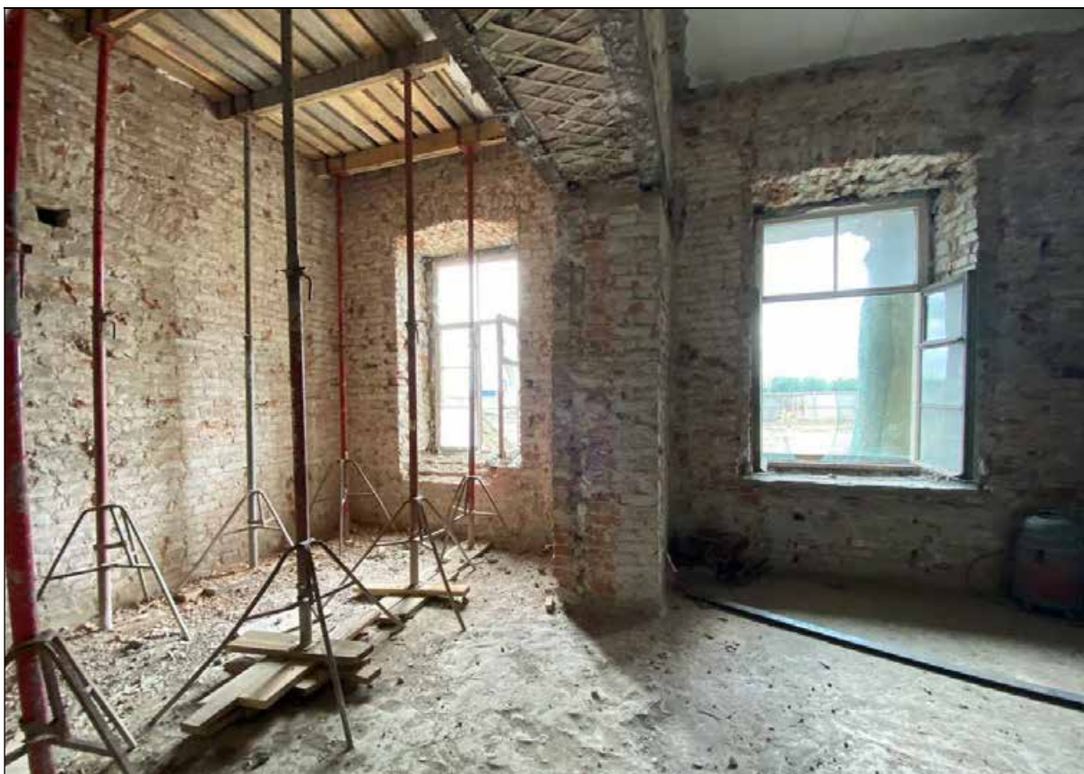
5. Центральный корпус. 1-й этаж. Помещение с юго-восточной стороны от центрального помещения. Южная часть помещения. 30.03.2024 г.
