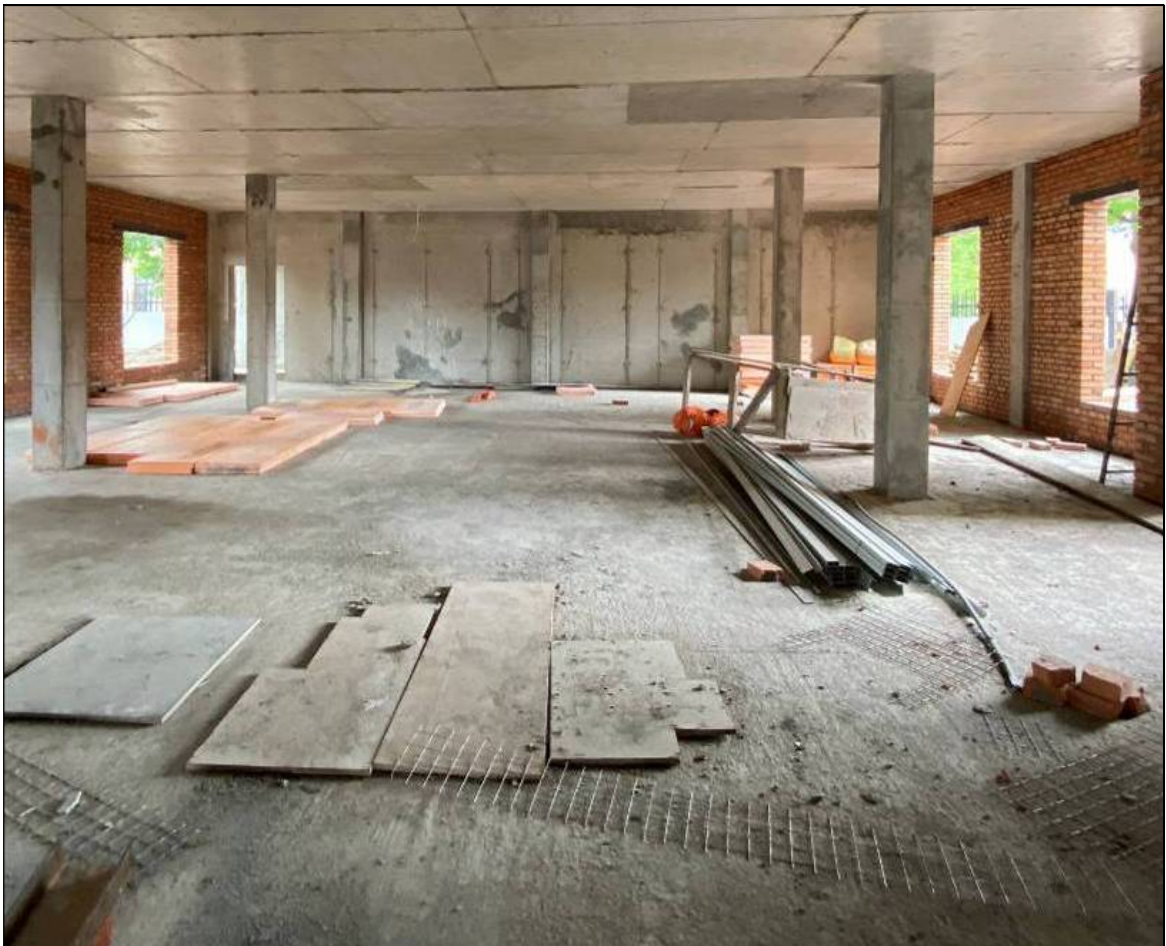
57. Западное помещение. 1-й этаж. Северная часть помещения. 30.03.2024 г.
