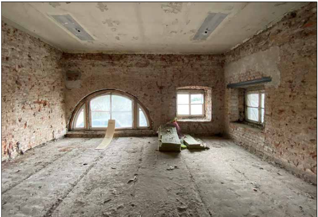
109. Западный флигель. 2-й этаж. Помещение с юго-восточной стороны от центрального помещения. Оконные проемы в восточной части помещения. 30.03.2024 г.
