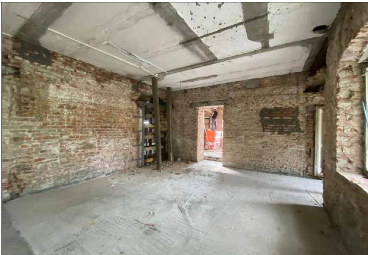
139. Центральный корпус. 3-й этаж. Помещение с северо-западной стороны от центрального помещения. Юго-восточная часть помещения. 30.03.2024 г.
