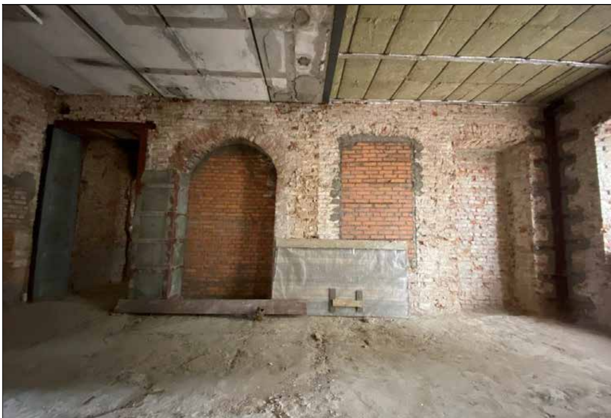
15. Центральный корпус. 1-й этаж. Помещение с северо-западной стороны от центрального помещения. Проемы в западной стене. 30.03.2024 г.
