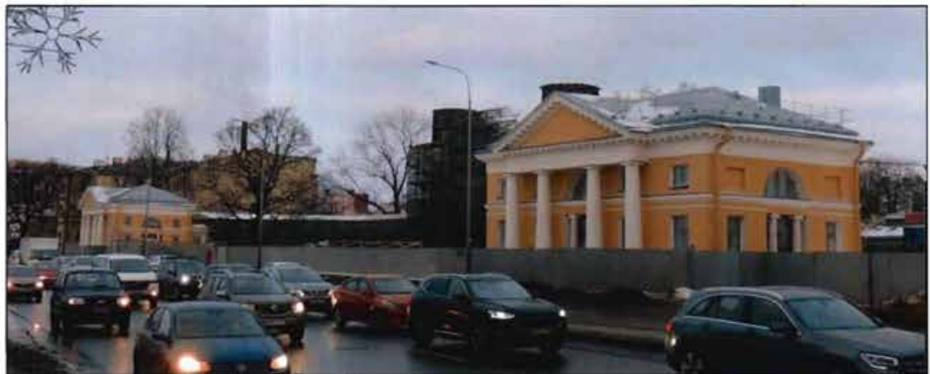
2. Общий вид объекта культурного наследия с юго-востока.
