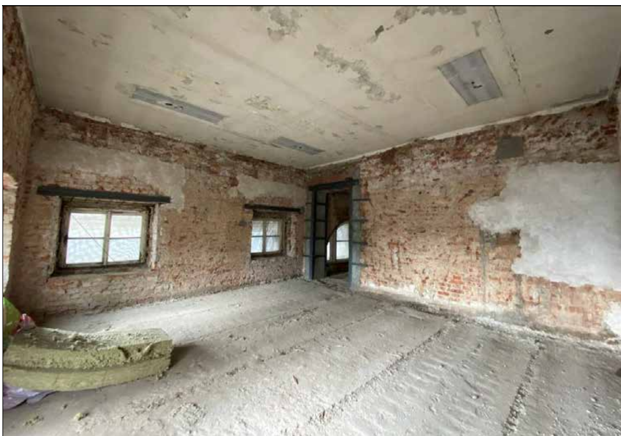
112. Западный флигель. 2-й этаж. Помещение с юго-восточной стороны от центрального помещения. Юго-западная часть помещения. 30.03.2024 г.
