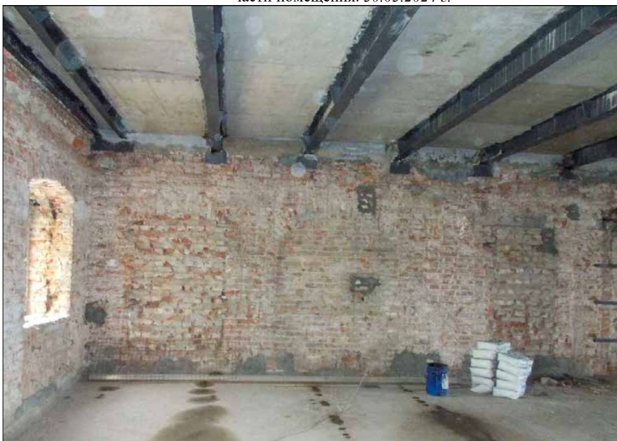
134. Центральный корпус. 3-й этаж. Центральное помещение. Заложённые дверные проемы в северо-восточной части помещения. 30.03.2024 г.
