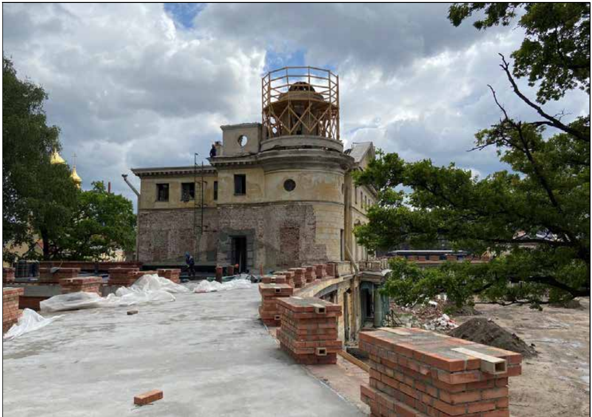
95. Плоское перекрытие западной галереи. Западный фасад центрального корпуса. 30.03.2024 г.
