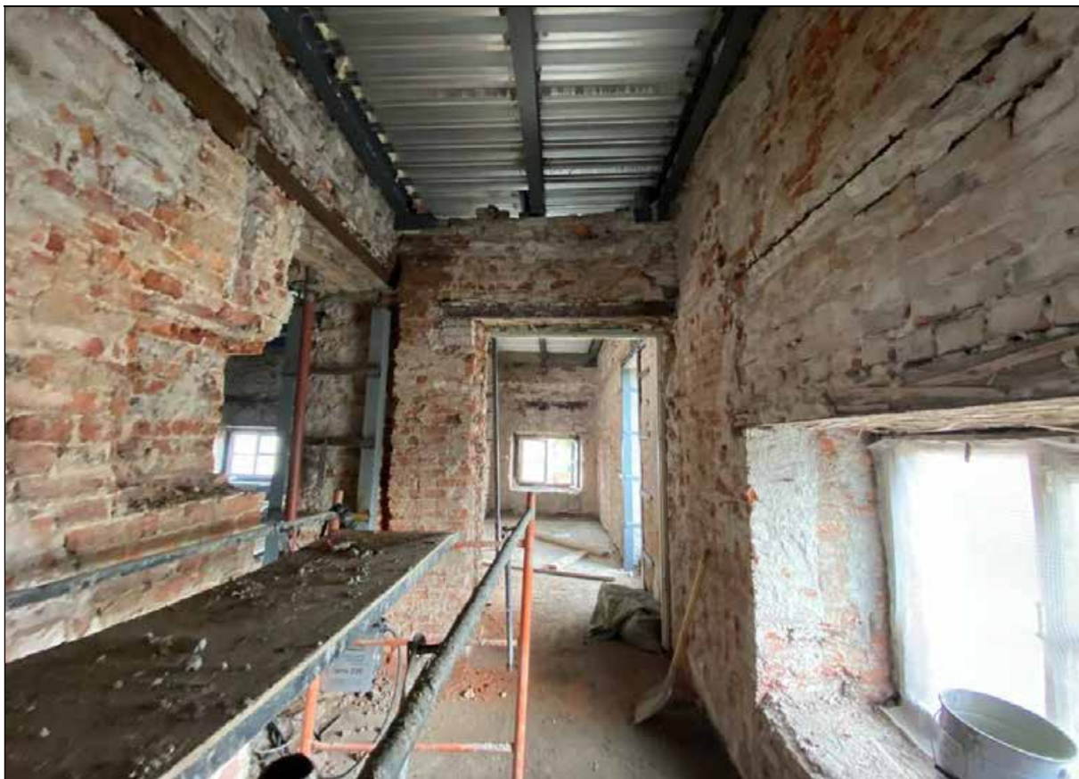
125. Восточный флигель. 2-й этаж. Северо-восточное помещение. Западная часть помещения. 30.03.2024 г.
