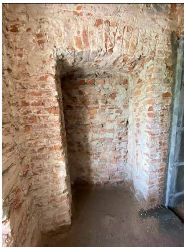
152. Центральный корпус. 3-й этаж. Помещение с северной стороны от восточной башни. Ниша в южной стене. 30.03.2024 г.
