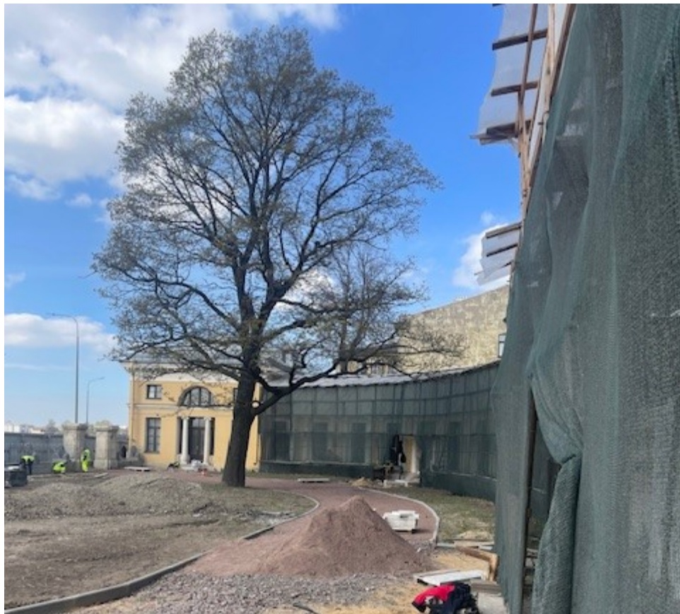
9. Западная галерея и западный флигель. Вид на северо-запад. 30.03.2024 г.
