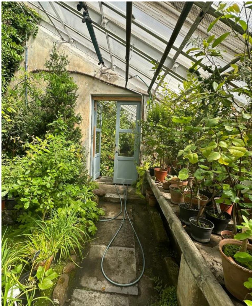
22. Выявленный объект культурного наследия «Здание Ботанической аудитории с оранжерей», по адресу: Санкт-Петербург, Университетская наб., 7-9, лит. А1, Б0, входящий в состав выявленного объекта культурного наследия «Здания Университета» по адресу: Университетская наб., 7-9. Помещение оранжереи. Вид на дверной проем между помещениями оранжереи.
