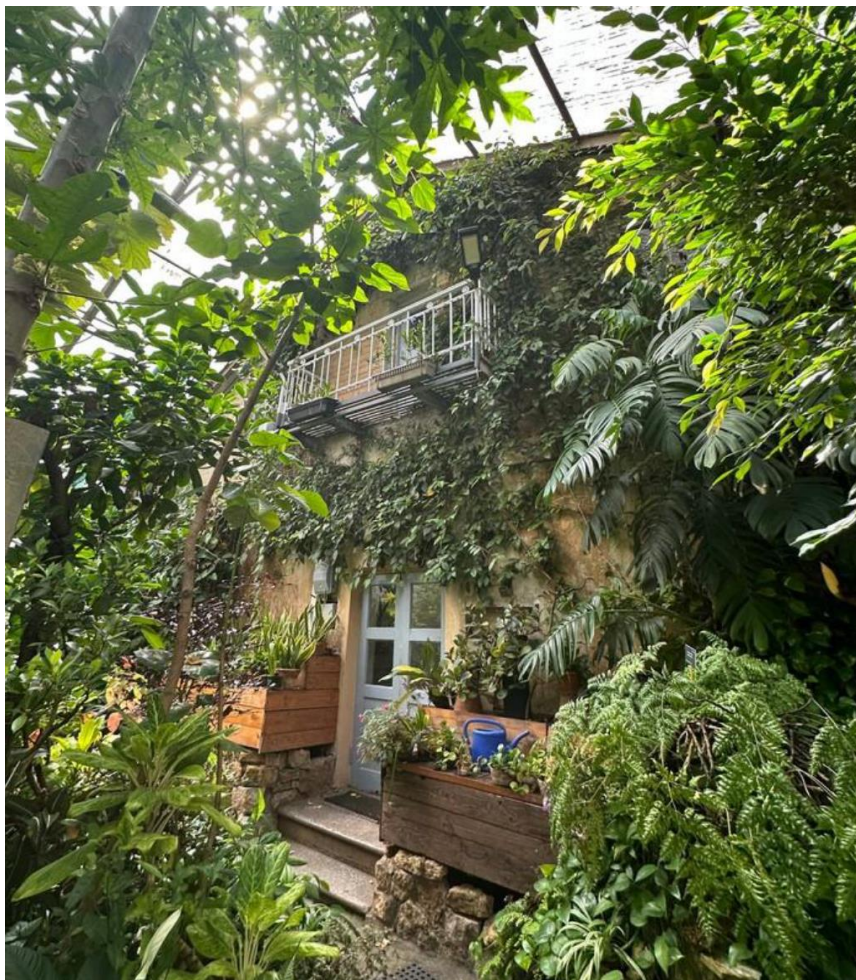
28. Выявленный объект культурного наследия «Здание Ботанической аудитории с оранжереей», по адресу: Санкт-Петербург, Университетская наб., 7-9, лит. А1, Б0, входящий в состав выявленного объекта культурного наследия «Здания Университета» по адресу: Университетская наб., 7-9. Место примыкания оранжереи к административной части здания.
