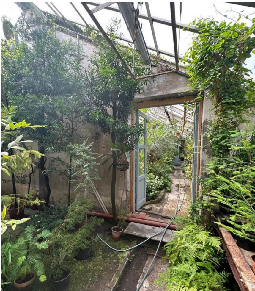
15. Выявленный объект культурного наследия «Здание Ботанической аудитории с оранжереями», по адресу: Санкт-Петербург, Университетская наб., 7-9, лит. А1, Б0, входящий в состав выявленного объекта культурного наследия «Здания Университета» по адресу: Университетская наб., 7-9. Вид на дверной проем между помещениями оранжереи.
