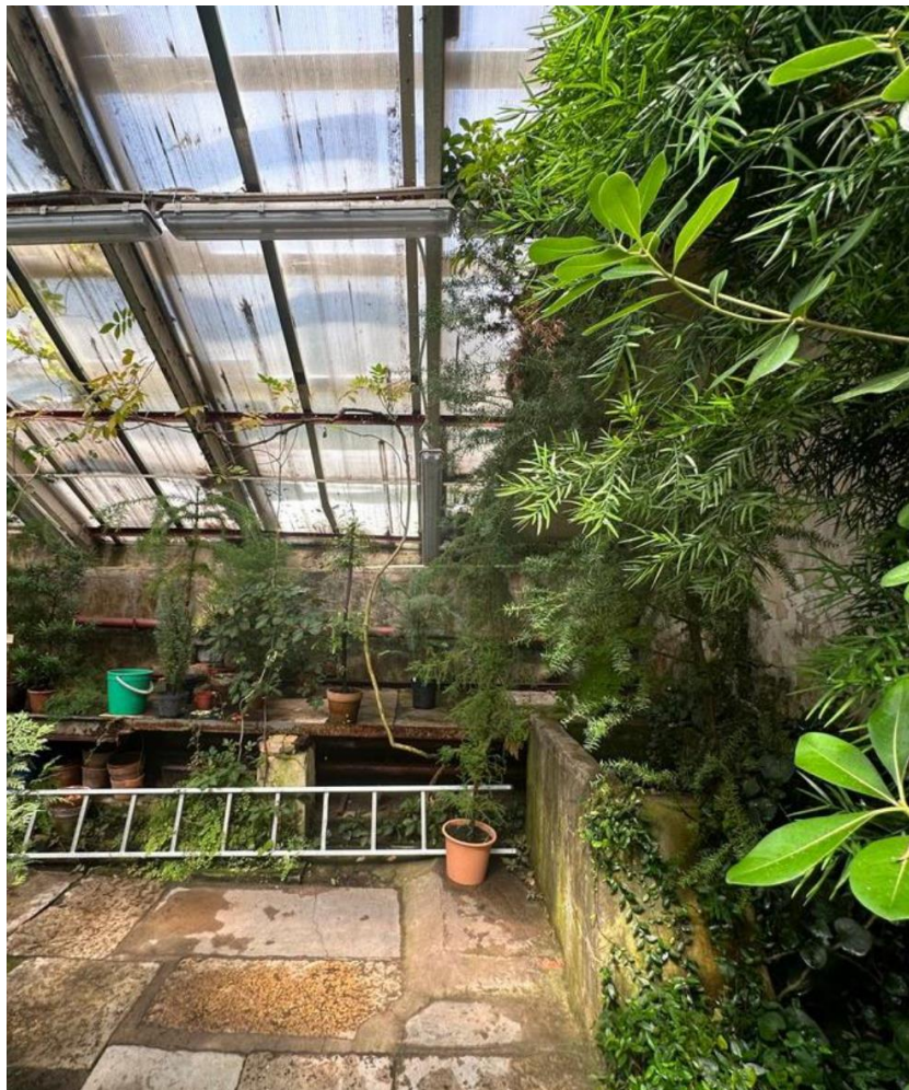
17. Выявленный объект культурного наследия «Здание Ботанической аудитории с оранжереей», по адресу: Санкт-Петербург, Университетская наб., 7-9, лит. А1, Б0, входящий в состав выявленного объекта культурного наследия «Здания Университета» по адресу: Университетская наб., 7-9. Помещение оранжереи. Торцевой проход.
