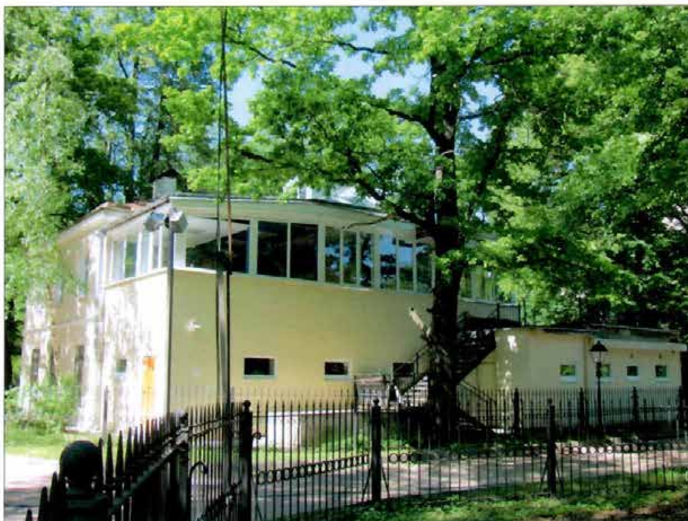
3. «Кухонный корпус». Общий вид с юга.
