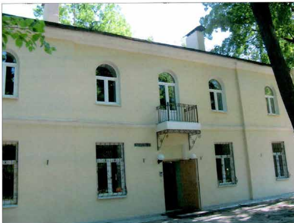
2. «Кухонный корпус». Северо-западный фасад. Фрагмент.
