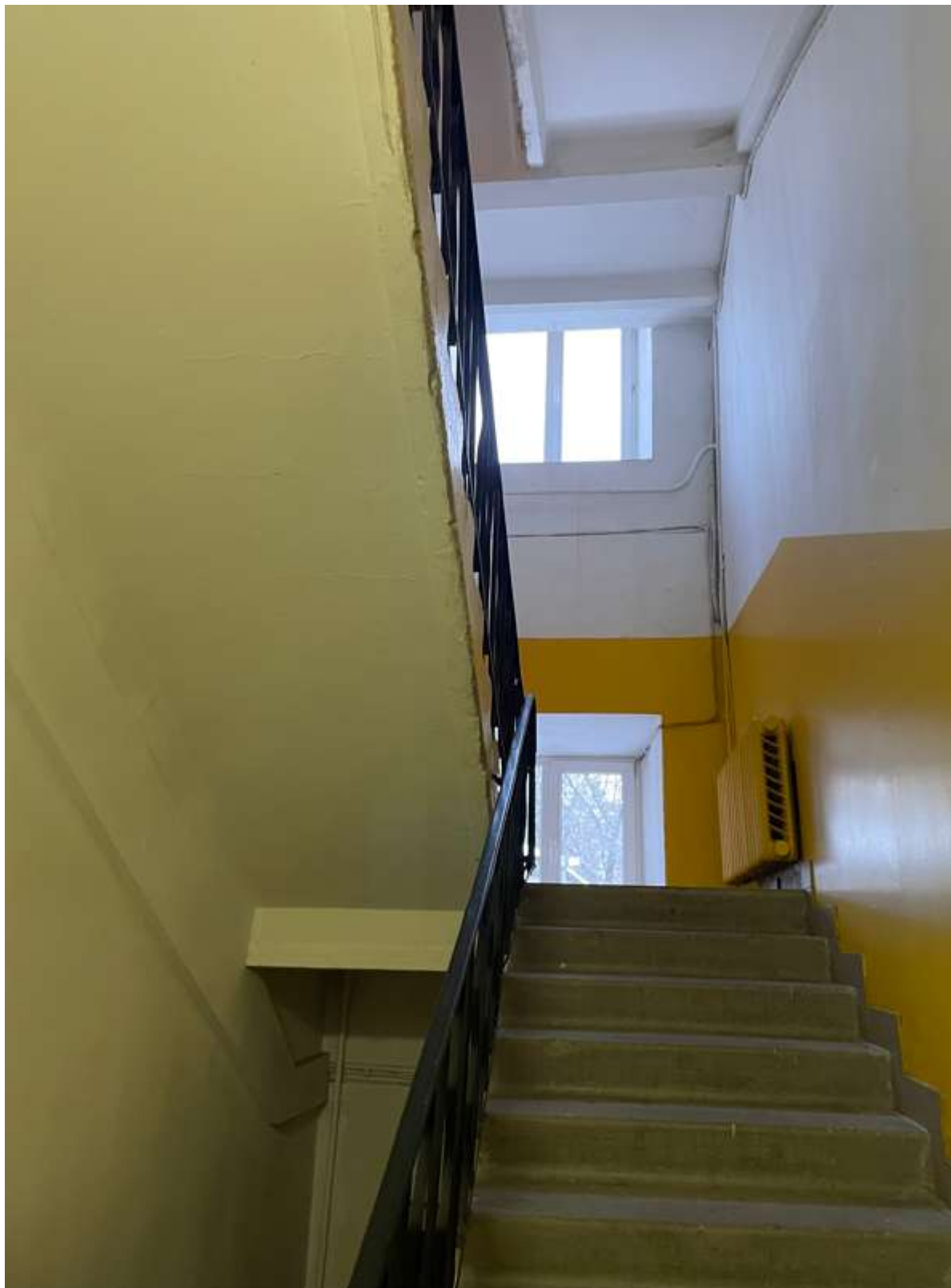
70. Фрагмент интерьера лестницы ЗЛК
