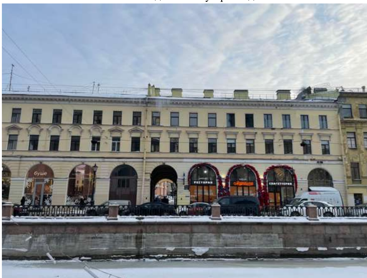
17. Фрагмент фасада по каналу Грибоедова
