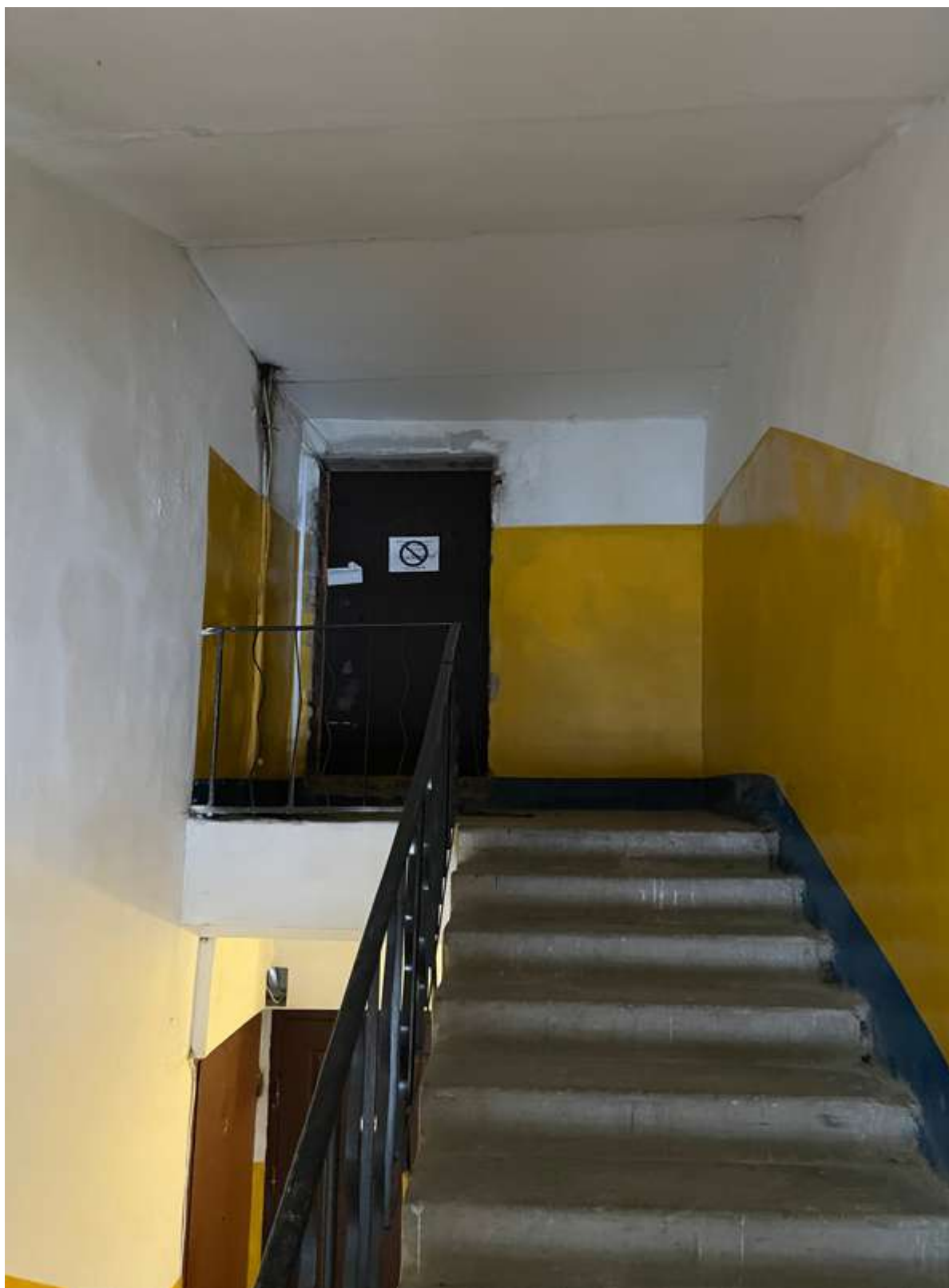
75. Фрагмент интерьера лестницы ЗЛК
