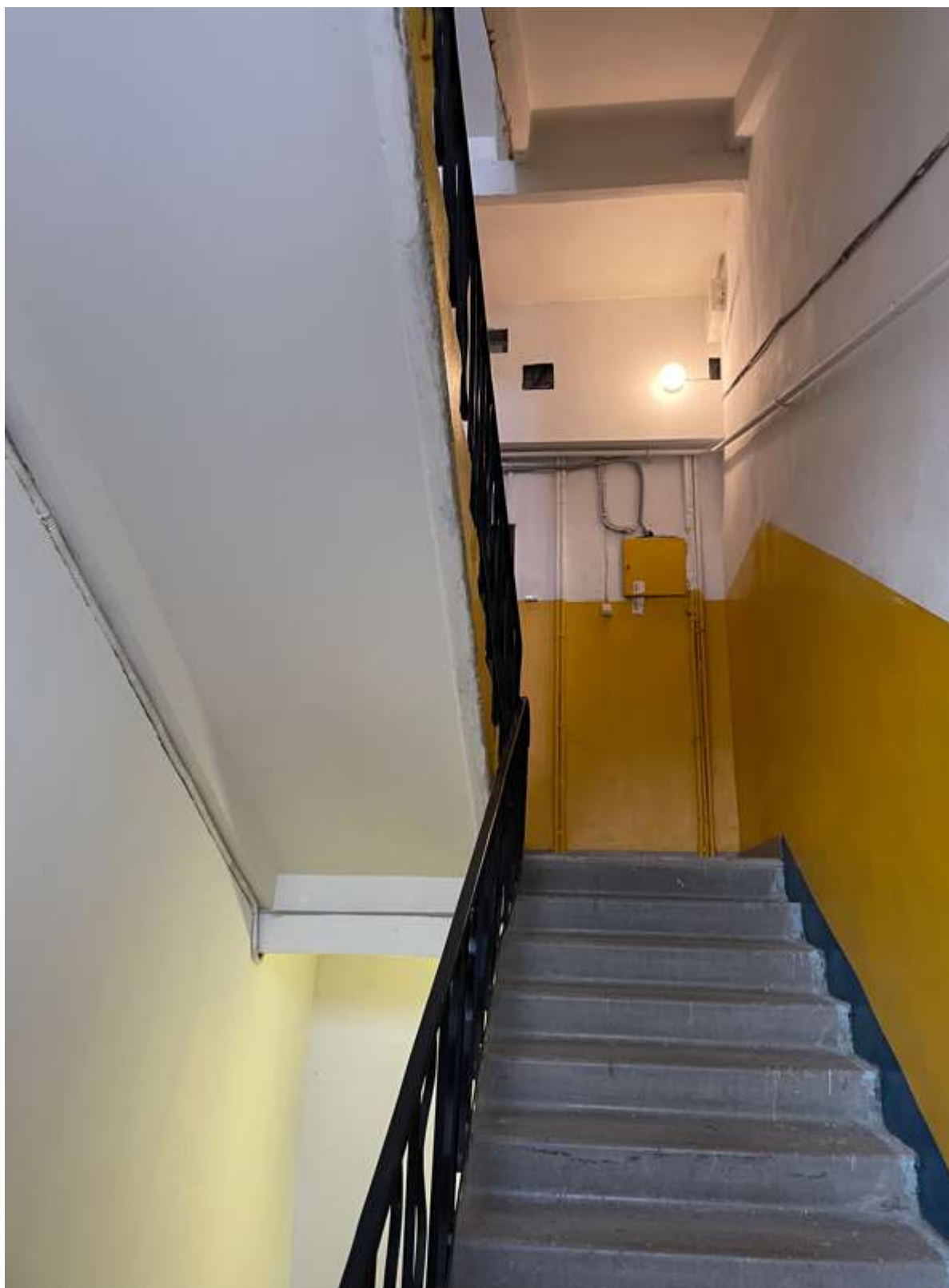
71. Фрагмент интерьера лестницы ЗЛК
