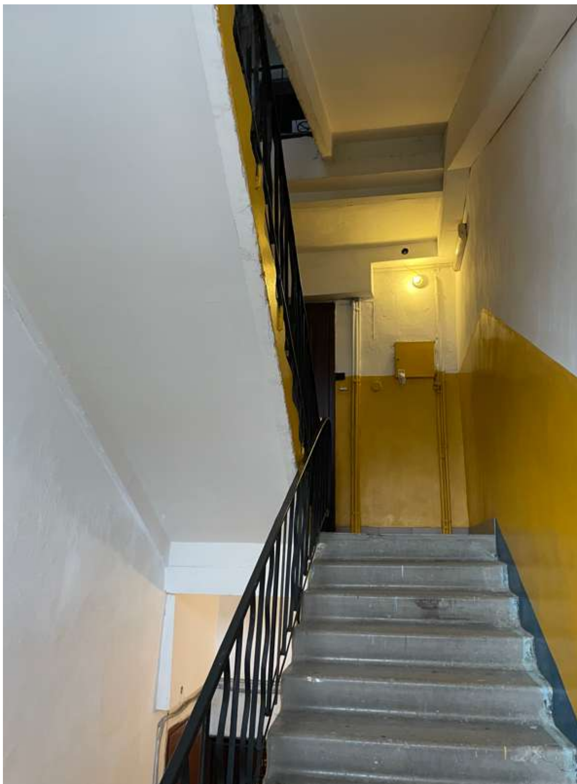
73. Фрагмент интерьера лестницы ЗЛК
