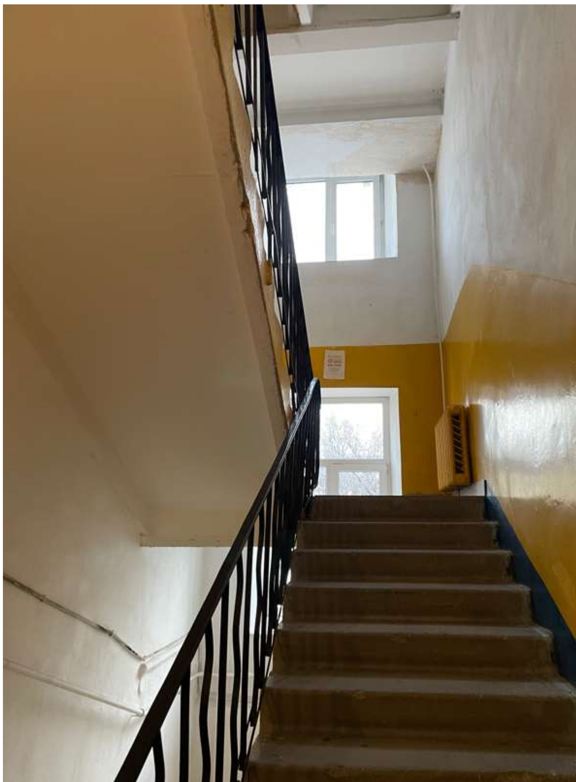
72. Фрагмент интерьера лестницы ЗЛК
