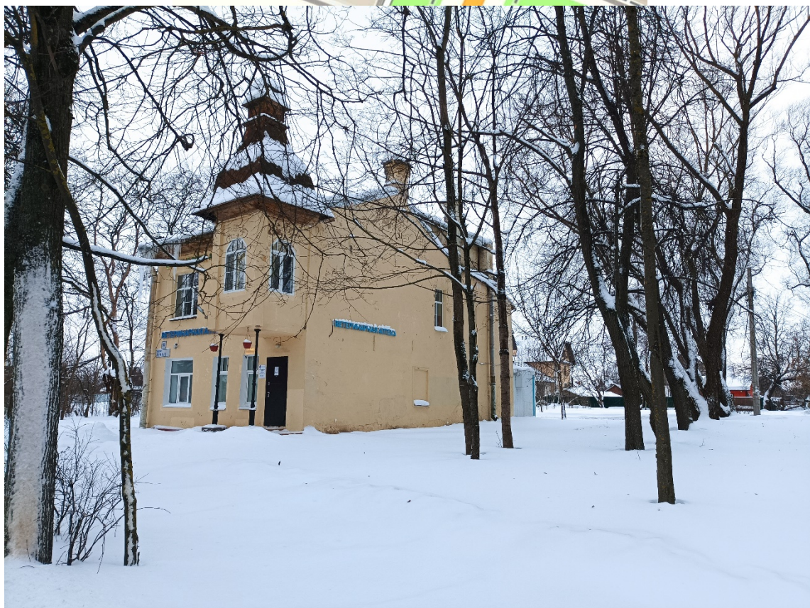
9. Выявленный объект культурного наследия «Жилой дом», по адресу: Санкт-Петербург, город Красное Село, проспект Ленина, д. 93 литера А (г. Красное Село, Ленина пр., 93). Общий вид. Дата съемки: 27.12.2023 г.
