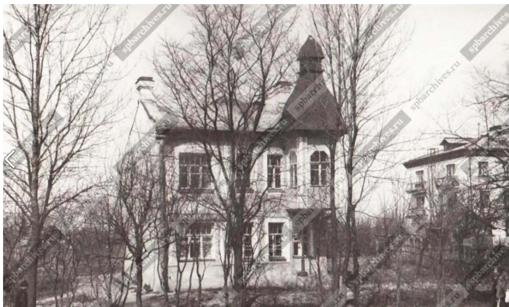
15. «Жилой дом», по адресу: Санкт-Петербург, город Красное Село, проспект Ленина, д. 93 литера А (г. Красное Село, Ленина пр., 93). Май 1979 г. ЦГАКФФД СПб. Ар 230394.
