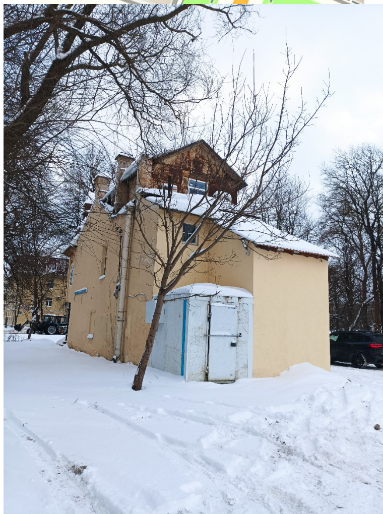
5. Выявленный объект культурного наследия «Жилой дом», по адресу: Санкт-Петербург, город Красное Село, проспект Ленина, д. 93 литера А (г. Красное Село, Ленина пр., 93). Общий вид. Дата съемки: 27.12.2023 г.
