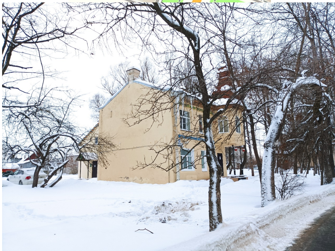
7. Выявленный объект культурного наследия «Жилой дом», по адресу: Санкт-Петербург, город Красное Село, проспект Ленина, д. 93 литера А (г. Красное Село, Ленина пр., 93). Общий вид. Дата съемки: 27.12.2023 г.
