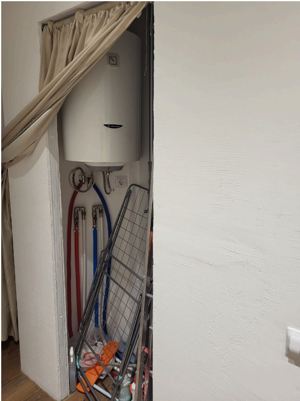
5. Выявленный объект культурного наследия «Дом по набережной канала Грибоедова», входящий в состав выявленного объекта культурного наследия «Дома Я.А. Фохтса (Ф.М. и М.М. Богомольцев)», расположенный по адресу: г. Санкт-Петербург, наб. канала Грибоедова, дом № 119-121, квартира № 84. Дата съемки: 12.03.2024 г.
