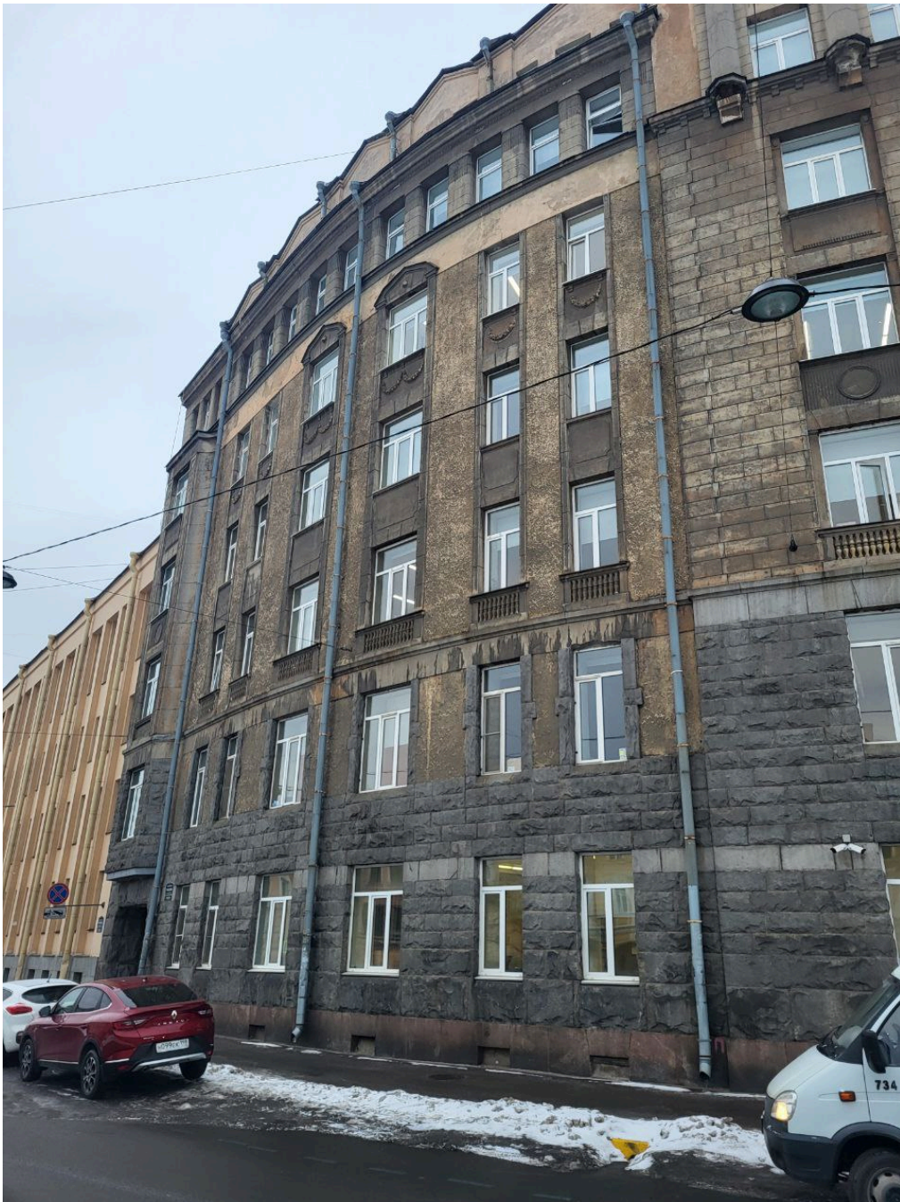
2. Выявленный объект культурного наследия «Дом по набережной канала Грибоедова», входящий в состав выявленного объекта культурного наследия «Дома Я.А. Фохтса (Ф.М. и М.М. Богомольцев)», расположенный по адресу: г. Санкт-Петербург, наб. канала Грибоедова, дом № 119-121. Вид с северо-востока. Дата съемки: 12.03.2024г.
