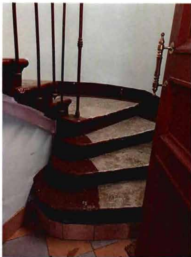
40, 41. Лестница западного флигеля.
