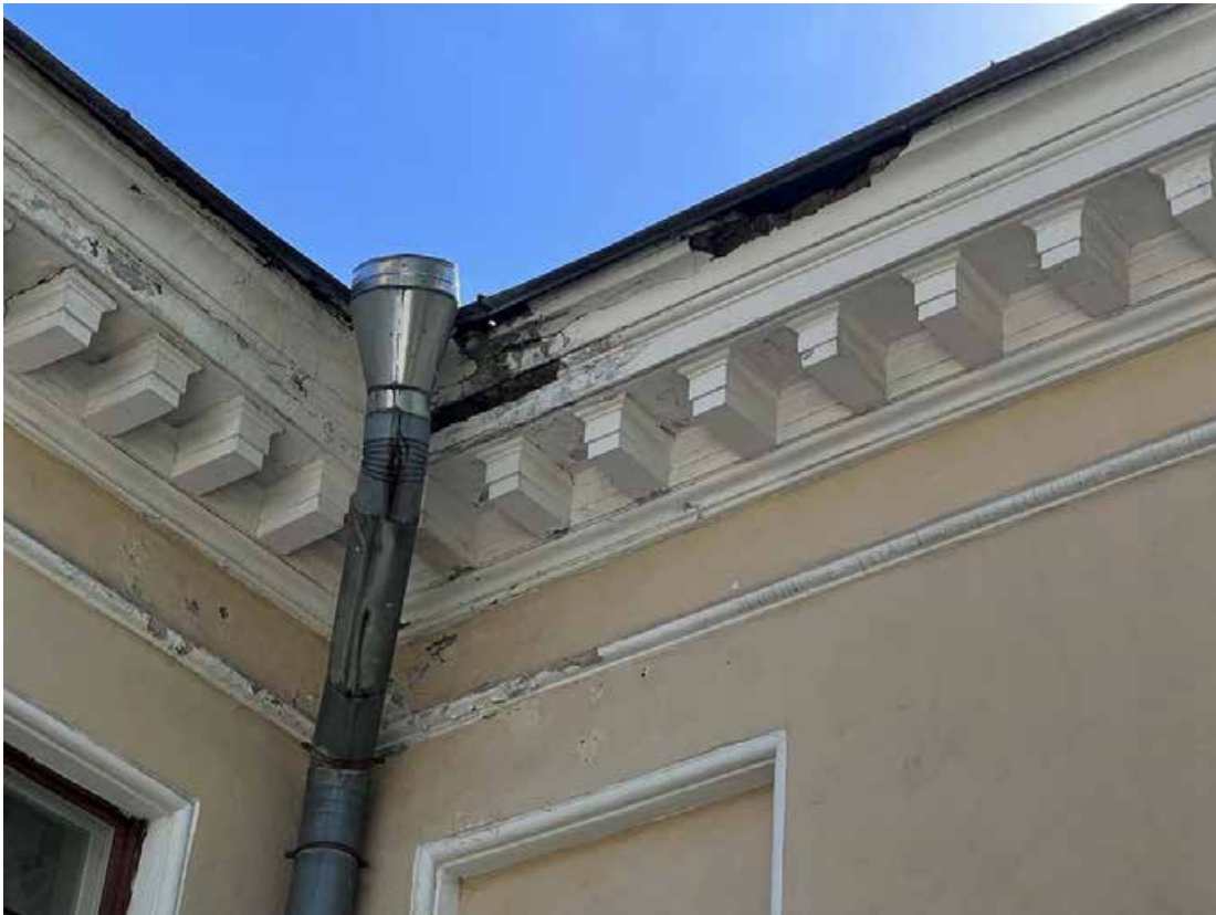
Фото 55. «Дворец Юсуповых», входящий в состав объекта культурного наследия федерального значения «Дворец с флигелями», Московский пр., д. 9, литера В. Фрагмент внутреннего северного угла главного здания дворца. Фото с севера. Дата съемки: 26.07.2022 г. Автор съемки: Куваева Ю.П.
