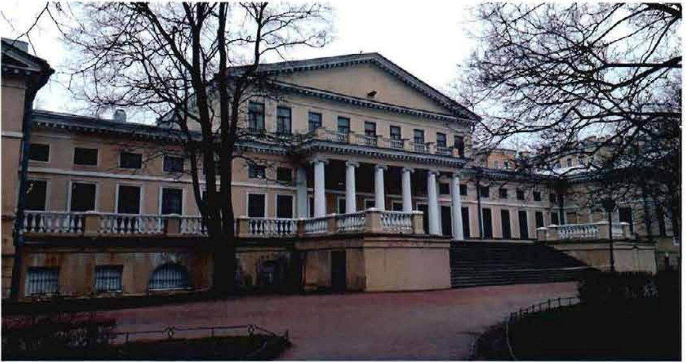
9. Общий вид северного фасада.
