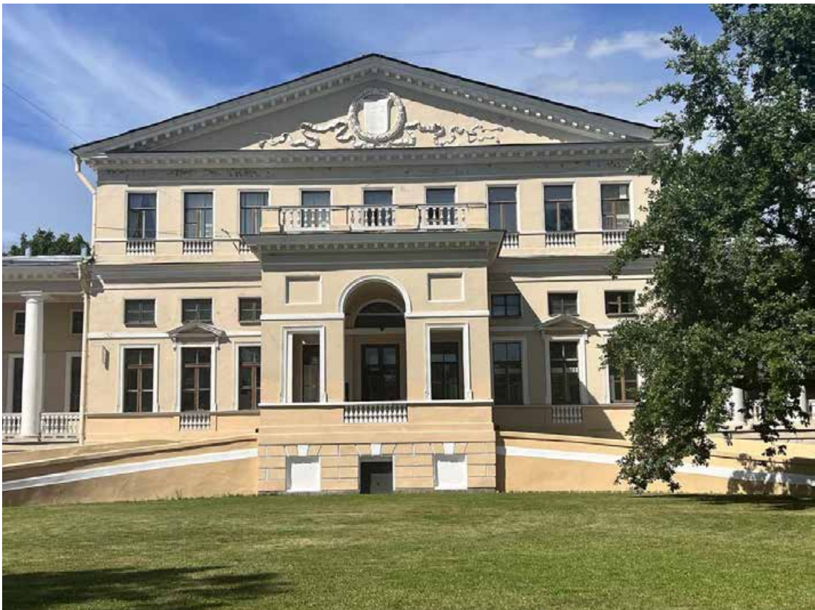
Фото 10. «Дворец Юсуповых», входящий в состав объекта культурного наследия федерального значения «Дворец с флигелями», Московский пр., д. 9, литера В. Центральная часть юго-восточного фасада главного здания дворца. Дата съемки: 26.07.2022 г. Автор съемки: Куваева Ю.П.
