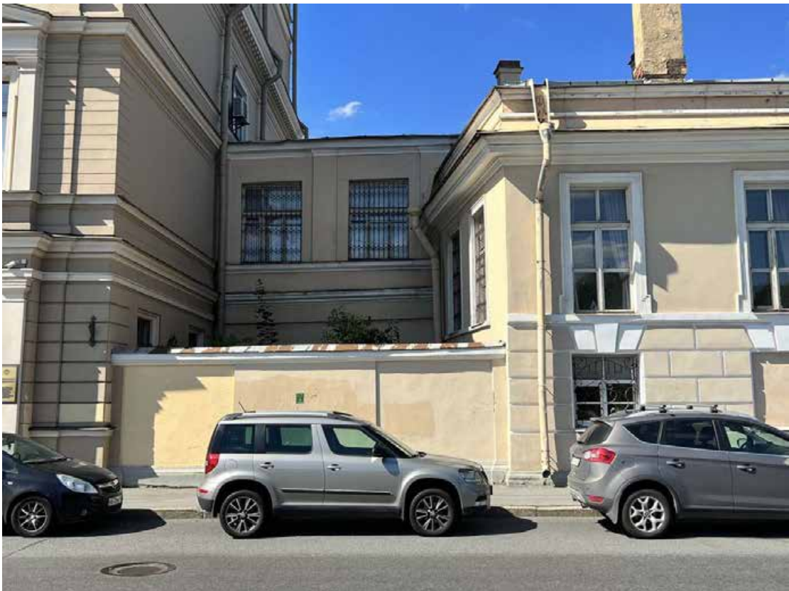
Фото 4. «Дворец Юсуповых», входящий в состав объекта культурного наследия федерального значения «Дворец с флигелями», Московский пр., д. 9, литера В. Общий вид южной пристройки к юго-западному флигелю здания дворца с юго-востока. Дата съемки: 26.07.2022 г. Автор съемки: Куваева Ю.П.
