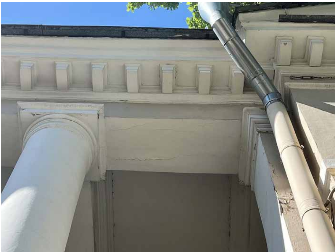
Фото 24. «Дворец Юсуповых», входящий в состав объекта культурного наследия федерального значения «Дворец с флигелями», Московский пр., д. 9, литера В. Фрагмент портика центральной части здания дворца. Дата съемки: 26.07.2022 г. Автор съемки: Куваева Ю.П.
