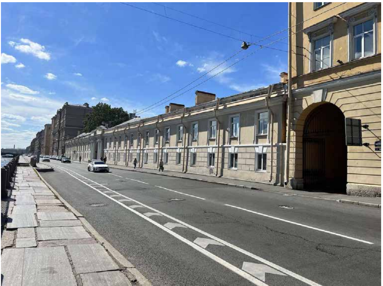
Фото 2. «Дворец Юсуповых», входящий в состав объекта культурного наследия федерального значения «Дворец с флигелями», Московский пр., д. 9, литера В. Общий вид уличных юго-восточных фасадов крыльев здания и восточного флигеля. Фото с востока, с наб. р. Фонтанки. . Дата съемки: 26.07.2022 г. Автор съемки: Куваева Ю.П.
