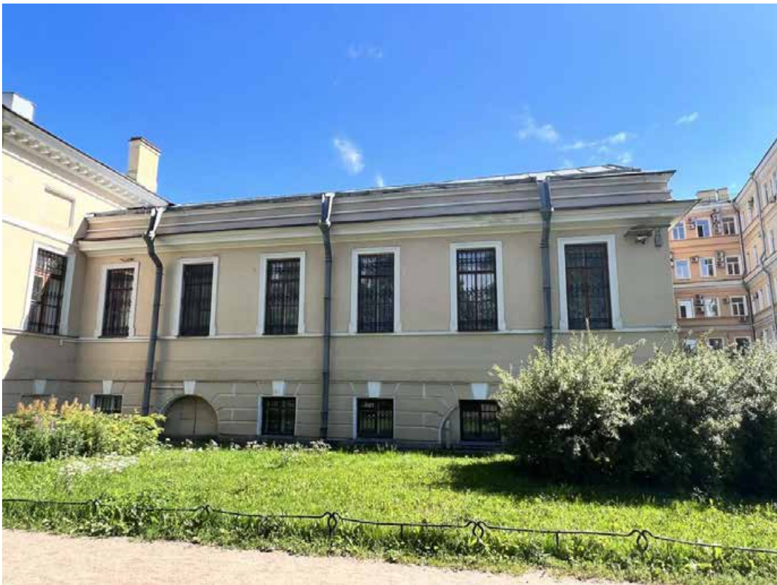
Фото 66. «Дворец Юсуповых», входящий в состав объекта культурного наследия федерального значения «Дворец с флигелями», Московский пр., д. 9, литера В. Юго-западный фасад западной пристройки к юго-западному крылу здания. Дата съемки: 26.07.2022 г. Автор съемки: Куваева Ю.П.
