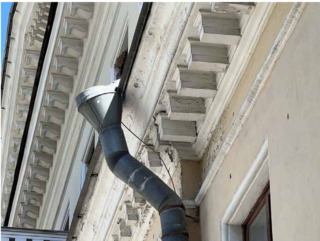
Фото 59. «Дворец Юсуповых», входящий в состав объекта культурного наследия федерального значения «Дворец с флигелями», Московский пр., д. 9, литера В. Фрагмент правой части северо-западного фасада главного здания дворца. Фото с запада. Дата съемки: 26.07.2022 г. Автор съемки: Куваева Ю.П.
