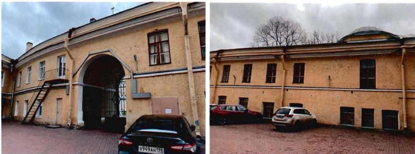
6. Общий вид северного флигеля.
