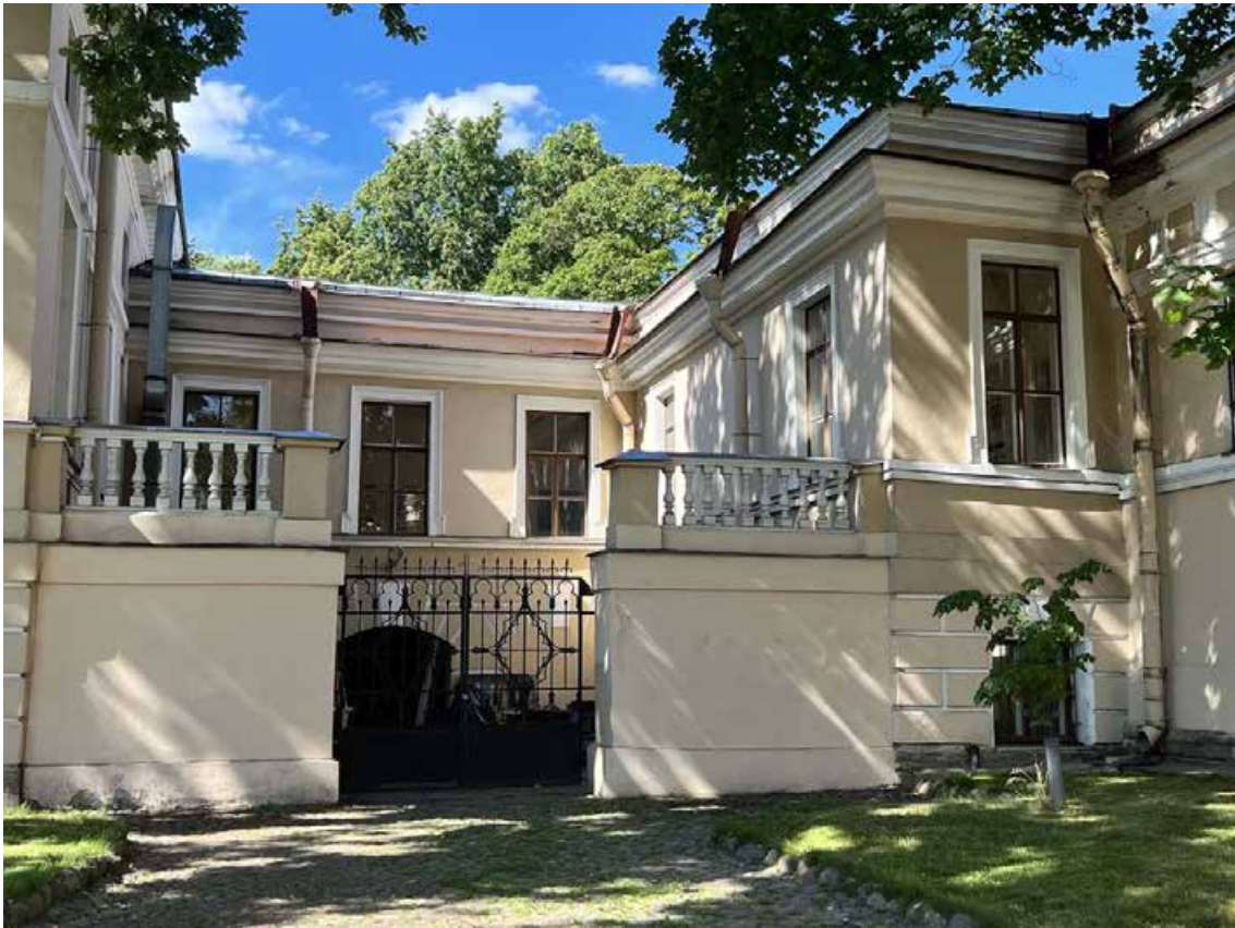
Фото 19. «Дворец Юсуповых», входящий в состав объекта культурного наследия федерального значения «Дворец с флигелями», Московский пр., д. 9, литера В. Общий вид пристройки между главным зданием дворца и восточного крыла. Фото с юго-востока. Дата съемки: 26.07.2022 г. Автор съемки: Куваева Ю.П.
