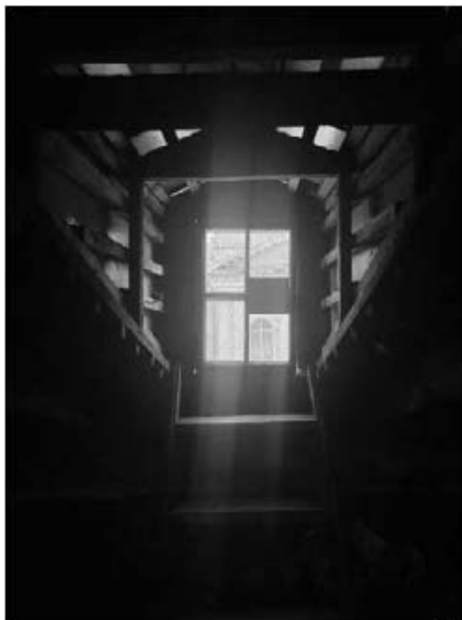
Фото 7. Объект культурного наследия регионального значения «Солдатская казарма» (г. Санкт-Петербург, Загородный пр., д. 48 лит. А), входящий в состав объекта культурного наследия регионального значения «Комплекс казарм Семеновского и Егерского полков». Чердак.
