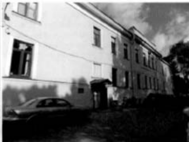
4. Юго-восточный дворовый фасад.
