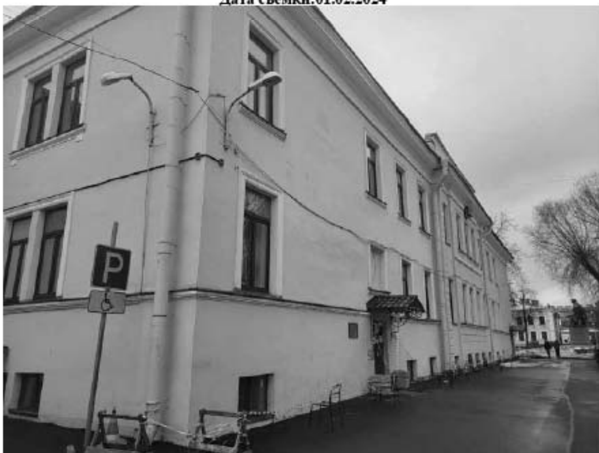
Фото 6. Объект культурного наследия регионального значения «Солдатская казарма» (г. Санкт-Петербург, Загородный пр., д. 48 лит. А), входящий в состав объекта культурного наследия регионального значения «Комплекс казарм Семеновского и Егерского полков». Дворовый фасад. Дата съемки:01.02.2024
