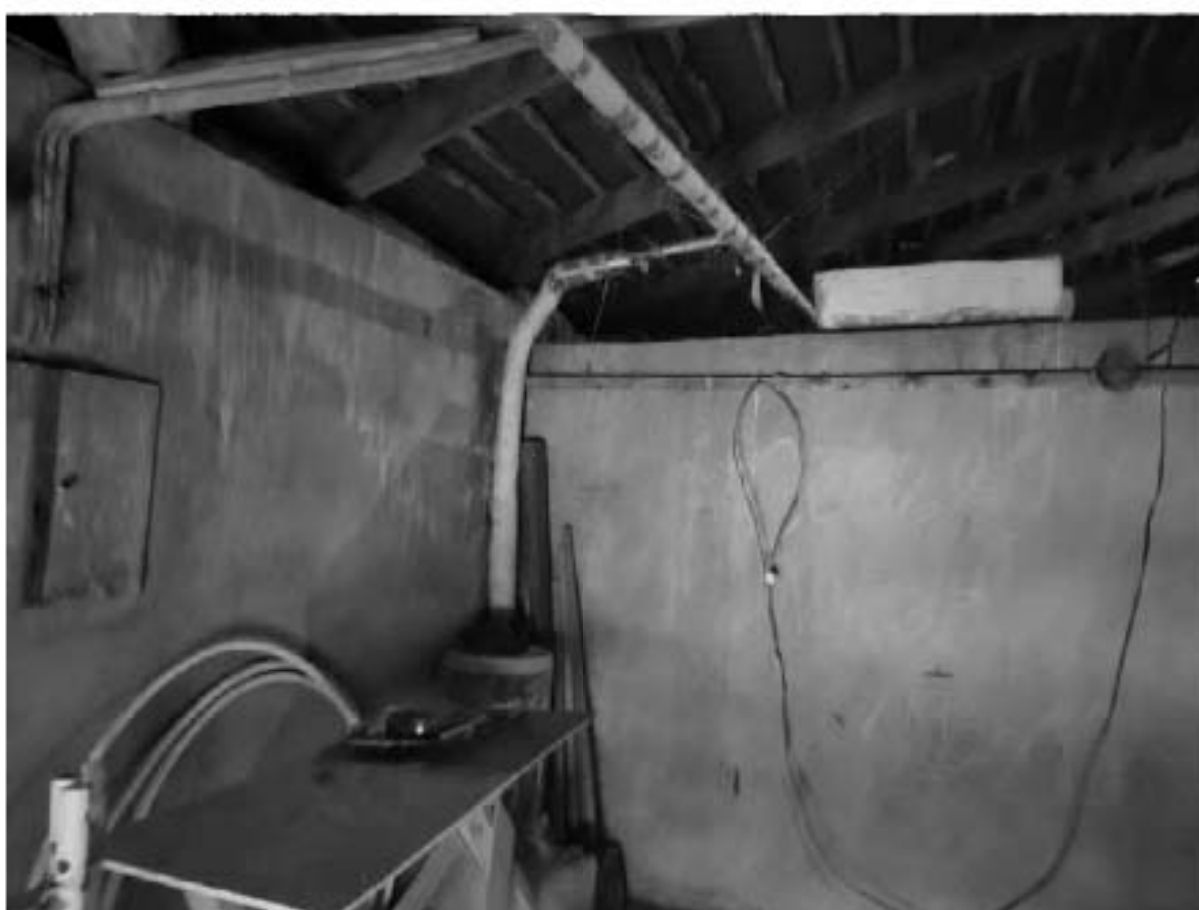
Фото 1. Объект культурного наследия регионального значения «Солдатская казарма» (г. Санкт-Петербург, Загородный пр., д. 48 лит. А), входящий в состав объекта культурного наследия регионального значения «Комплекс казарм Семеновского и Егерского полков». Чердак.
