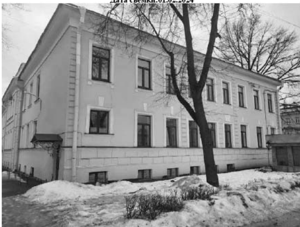
Фото 4. Объект культурного наследия регионального значения «Солдатская казарма» (г. Санкт-Петербург, Загородный пр., д. 48 лит. А), входящий в состав объекта культурного наследия регионального значения «Комплекс казарм Семеновского и Егерского полков». Боковой фасад.
