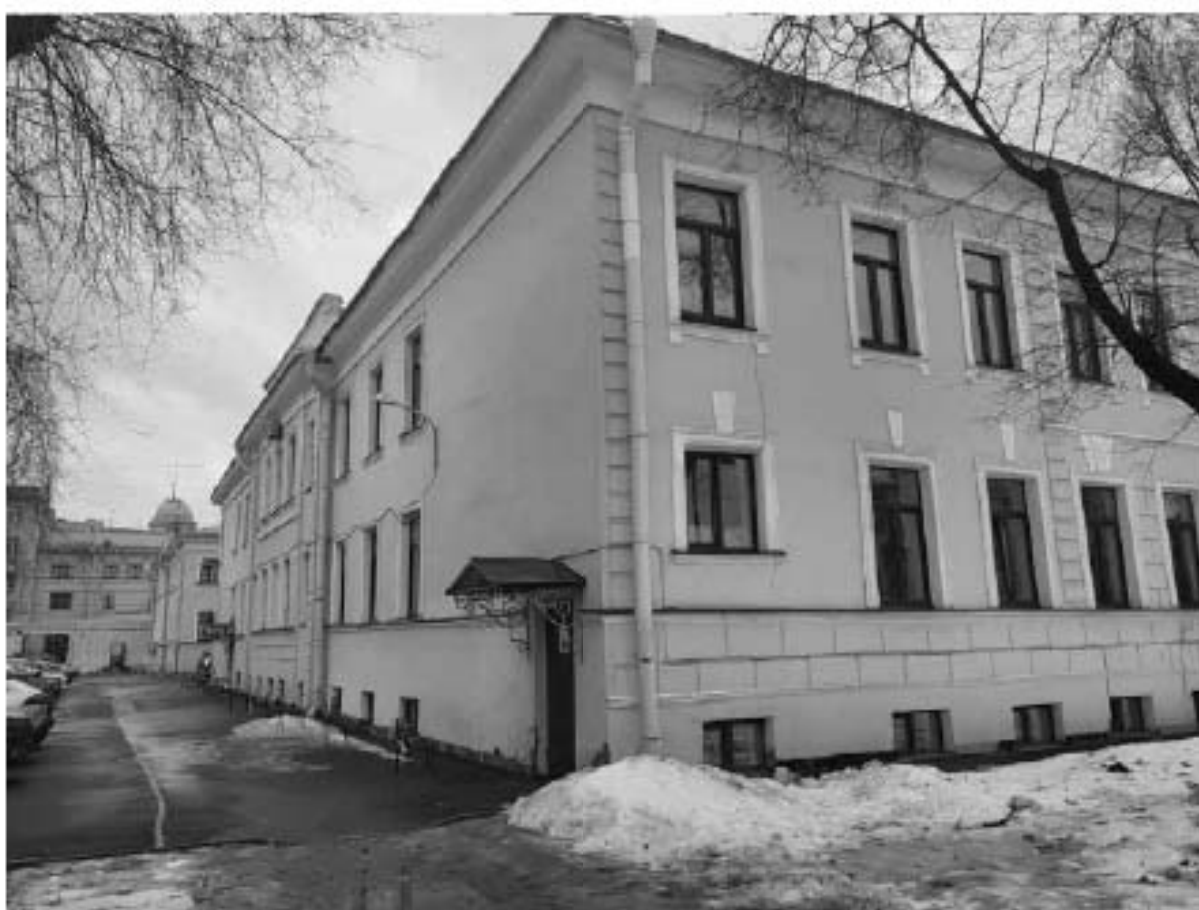
Фото 5. Объект культурного наследия регионального значения «Солдатская казарма» (г. Санкт-Петербург, Загородный пр., д. 48 лит. А), входящий в состав объекта культурного наследия регионального значения «Комплекс казарм Семеновского и Егерского полков». Боковой и дворовый фасады. Дата съемки:01.02.2024
