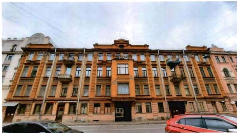
1. Общий вид на северо-восточный фасад объекта культурного наследия
