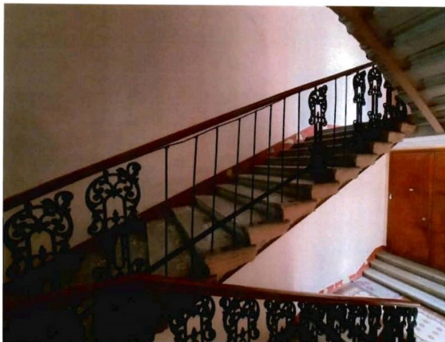
10. Интерьеры объекта культурного наследия. Помещения парадной лестницы 1ЛК
