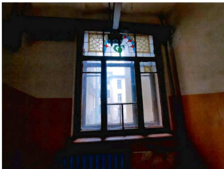
19. Интерьеры объекта культурного наследия. Помещения парадной лестницы 7ЛК
