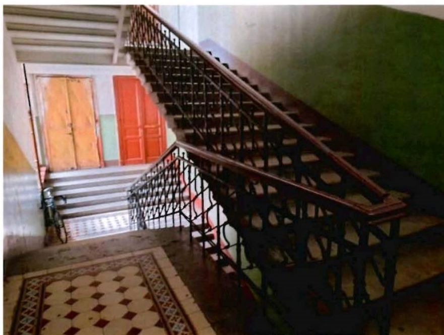
21. Интерьеры объекта культурного наследия. Помещения парадной лестницы 9ЛК
