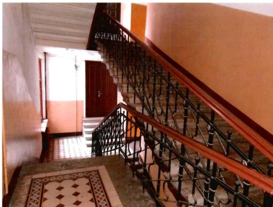
18. Интерьеры объекта культурного наследия. Помещения парадной лестницы 7ЛК
