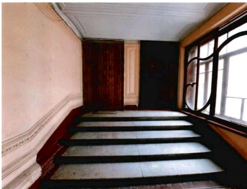
13. Интерьеры объекта культурного наследия. Помещения парадной лестницы 2ЛК
