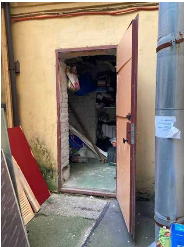
Фото 11. Фрагмент дворового фасада объекта культурного наследия регионального значения «Дом И.Д. Коробкова, В.Н. Самоцветовой», вход в квартиру
