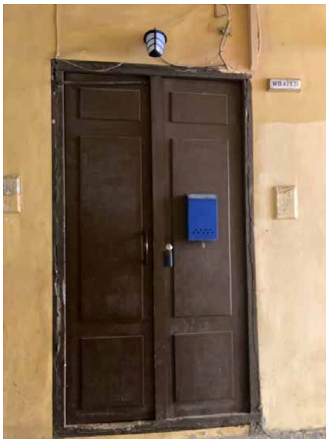
Фото 10. Фрагмент дворового фасада объекта культурного наследия регионального значения «Дом И.Д. Коробкова, В.Н. Самоцветовой», вход в квартиру
