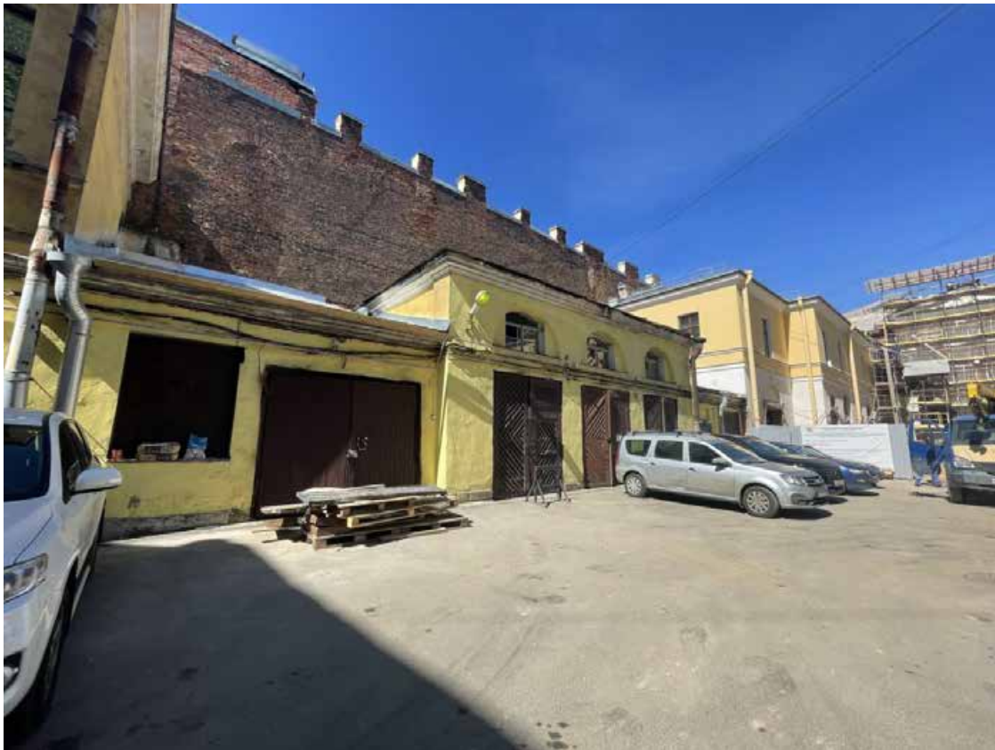
Фото 4. Фрагмент дворового фасада о объекта культурного наследия федерального значения «Корпуса служебные (два)» , входящего в состав объекта культурного наследия федерального значения «Церковь англиканская Иисуса Христа»
