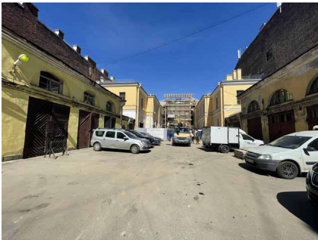
Фото 5. Фрагмент дворового фасада о объекта культурного наследия федерального значения «Корпуса служебные (два)» , входящего в состав объекта культурного наследия федерального значения «Церковь англиканская Иисуса Христа»
