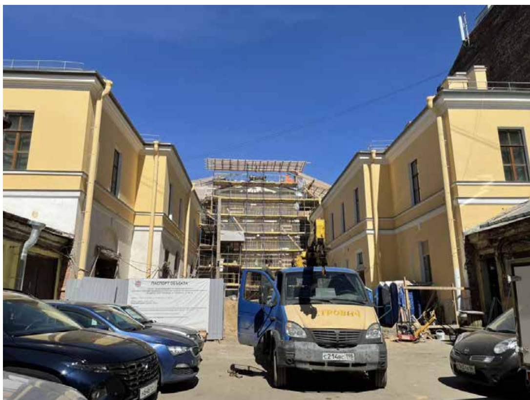
Фото 8. Фрагмент дворового фасада о объекта культурного наследия федерального значения «Корпуса служебные (два)», входящего в состав объекта культурного наследия федерального значения «Церковь англиканская Иисуса Христа»
