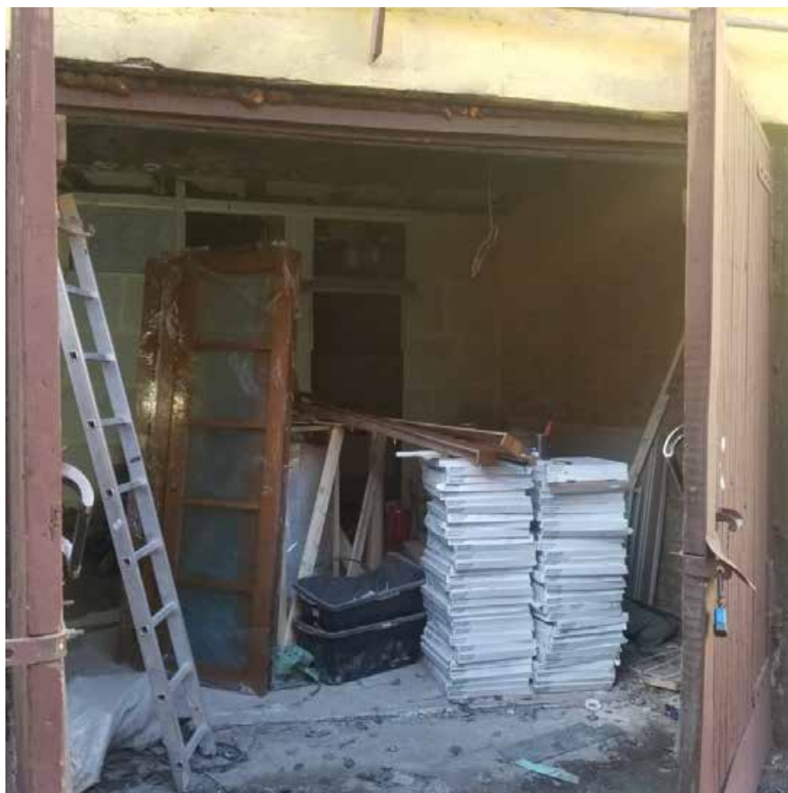
Фото 11. Интерьер пом.19-Н объекта культурного наследия федерального значения «Корпуса служебные (два)», входящего в состав объекта культурного наследия федерального значения «Церковь англиканская Иисуса Христа»
