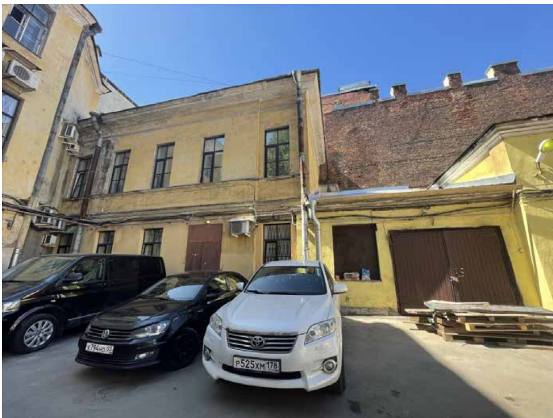
Фото 3. Фрагмент дворового фасада о объекта культурного наследия федерального значения «Корпуса служебные (два)» , входящего в состав объекта культурного наследия федерального значения «Церковь англиканская Иисуса Христа»
