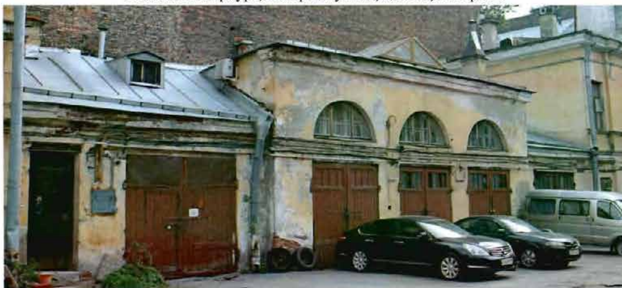
Фото №2. Вид на западный фасад со стороны внутреннего двора.
