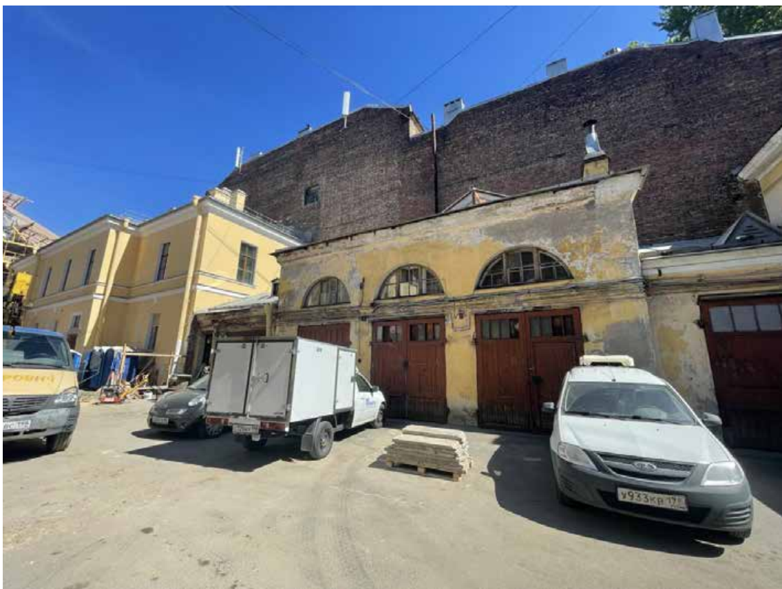
Фото 7. Фрагмент дворового фасада о объекта культурного наследия федерального значения «Корпуса служебные (два)», входящего в состав объекта культурного наследия федерального значения «Церковь англиканская Иисуса Христа»
