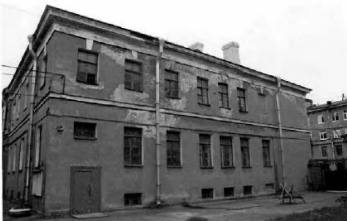
Фото №2. Северо-западный фасад. Вид со стороны двора.
