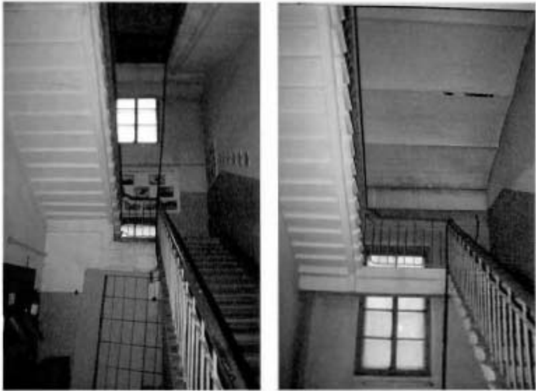
Фото №18, 19. Лестничная клетка Л-1.
