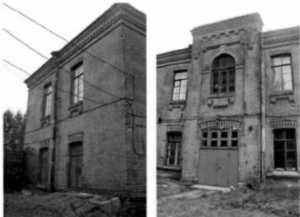
Фото №15, 16. Торцевой (северо-западный) и центральный ризалит юго-западного фасада. Вид со стороны двора.
