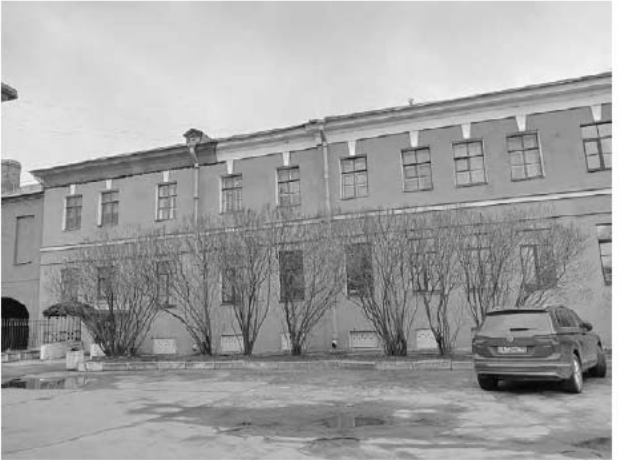
Фото 11. Объект культурного наследия регионального значения «Солдатская казарма» по адресу: Санкт-Петербург, Рузовская ул., д.10-12, литера А. Северо-восточный фасад.
