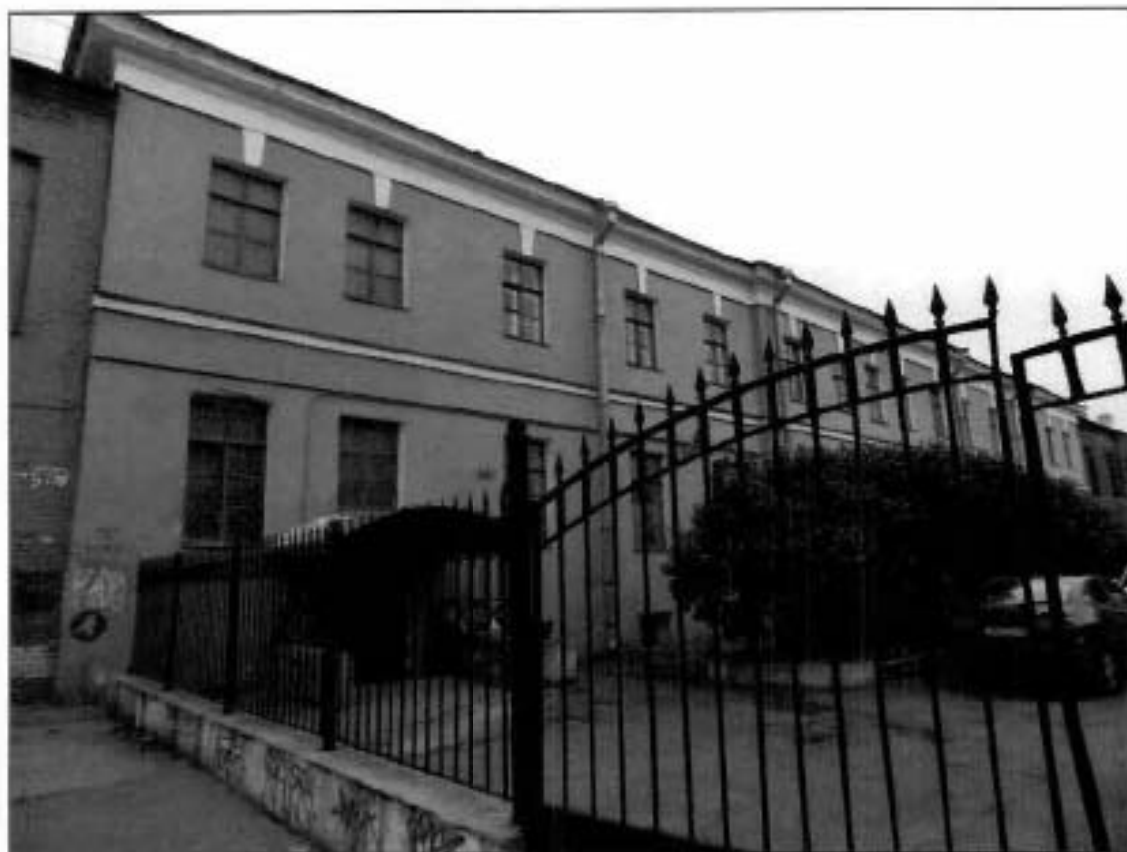
Фото 3. Фрагмент северо-восточного фасада.
