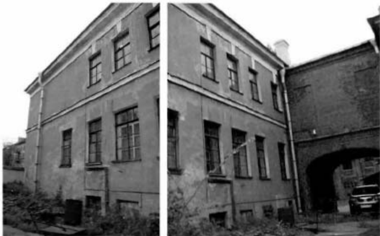
Фото №4, 5. Фрагменты юго-восточного фасада. Вид со стороны двора.
