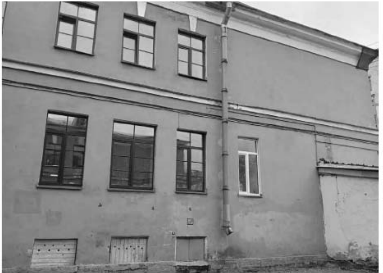
Фото 12. Объект культурного наследия регионального значения «Солдатская казарма» по адресу: Санкт-Петербург, Рузовская ул., д.10-12, литера А. Северо-западный фасад.
