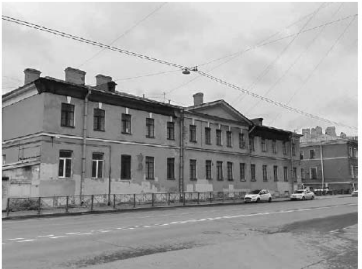
Фото 9. Объект культурного наследия регионального значения «Солдатская казарма» по адресу: Санкт-Петербург, Рузовская ул., д.10-12, литера А. Юго-западный фасад.
