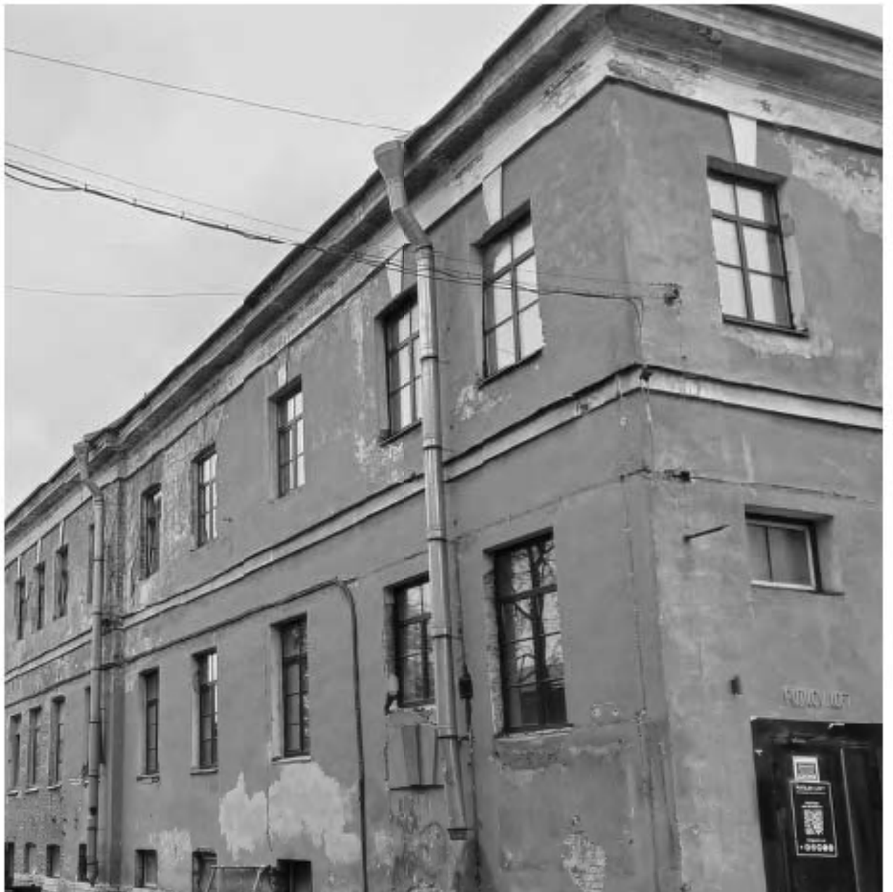
Фото 3. Объект культурного наследия регионального значения «Солдатская казарма с флигелем для неприкосновенного запаса», корпус по адресу: Санкт-Петербург, Рузовская ул., д.10-12, литера А. Северо-восточный фасад, фрагмент.
