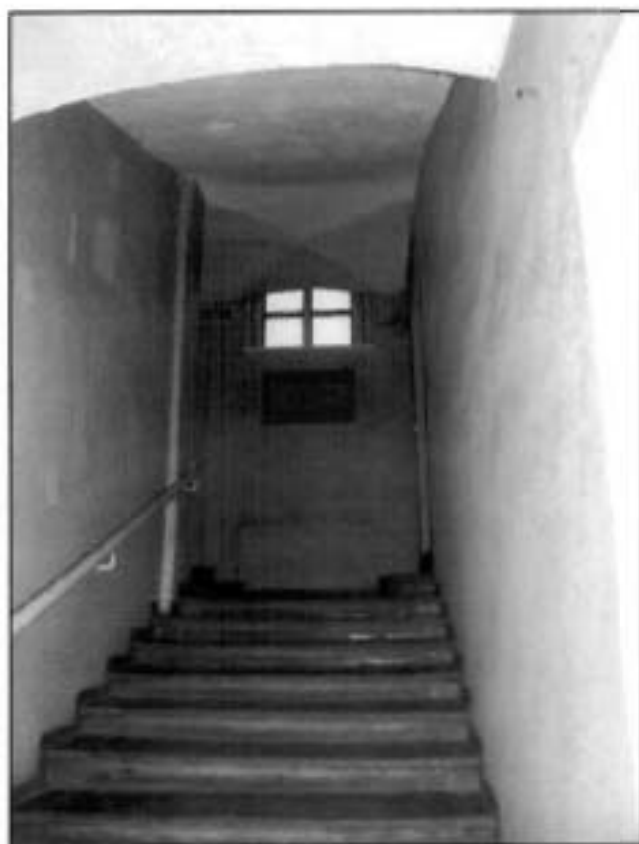
Фото 6. Интерьер. Северная лестница.
