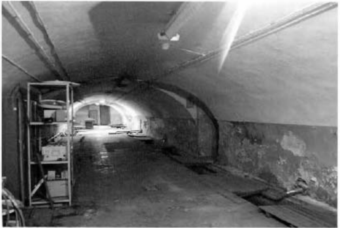
Фото № 6. Помещение 6-Н цокольного этажа.
