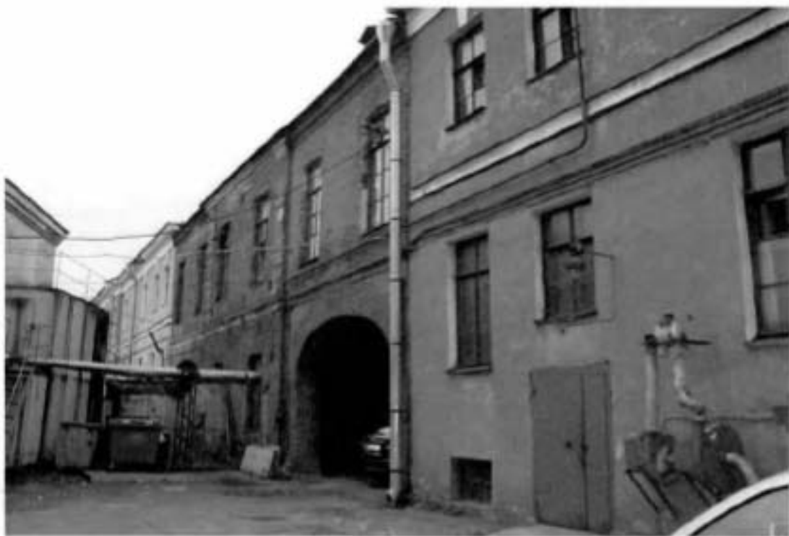
Фото №3. Фрагмент северо-восточного фасада. Вид со стороны двора.
