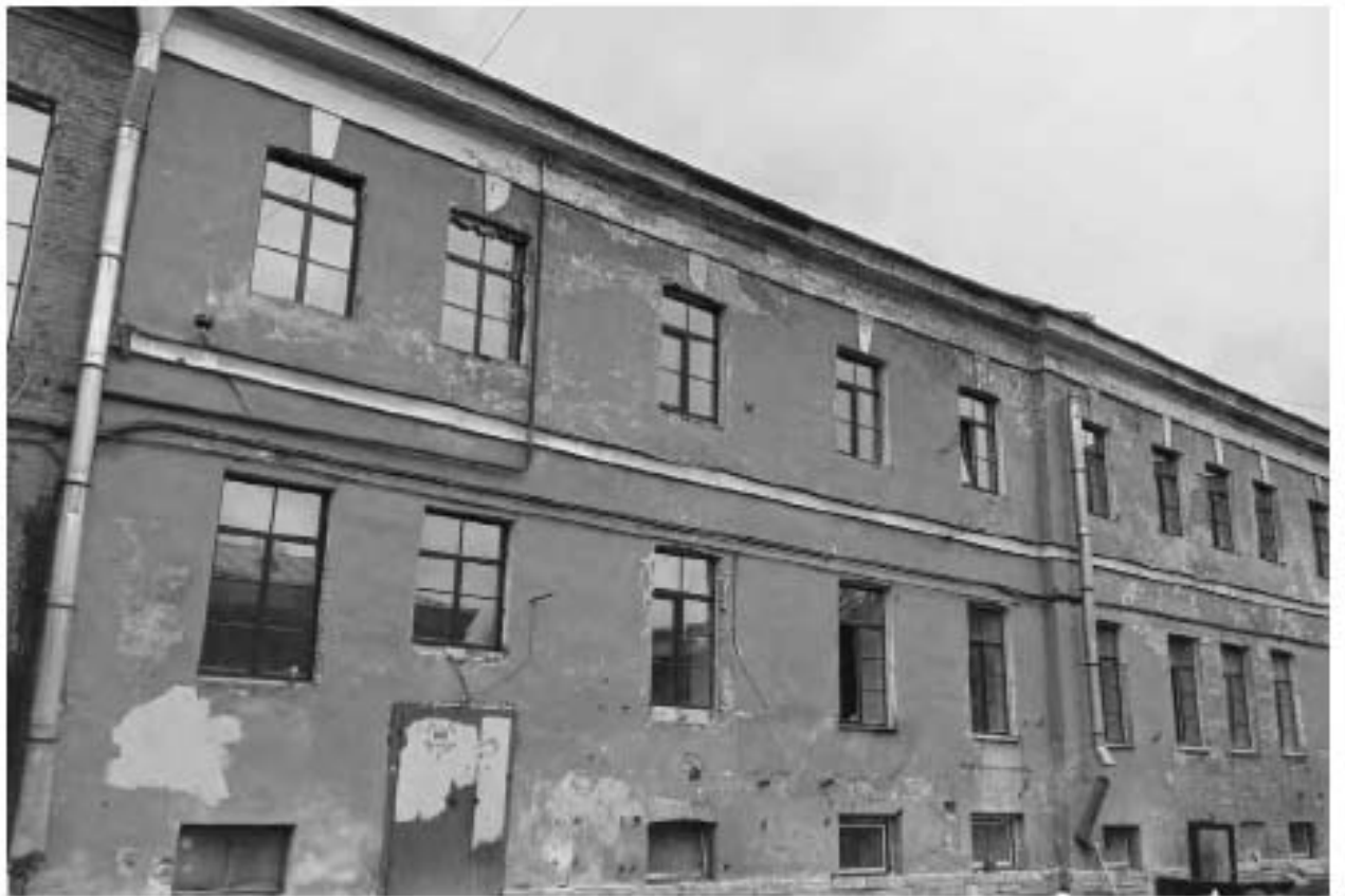
Фото 2. Объект культурного наследия регионального значения «Солдатская казарма с флигелем для неприкосновенного запаса», корпус по адресу: Санкт-Петербург, Рузовская ул., д 10-12, литера А. Северо-восточный фасад.
