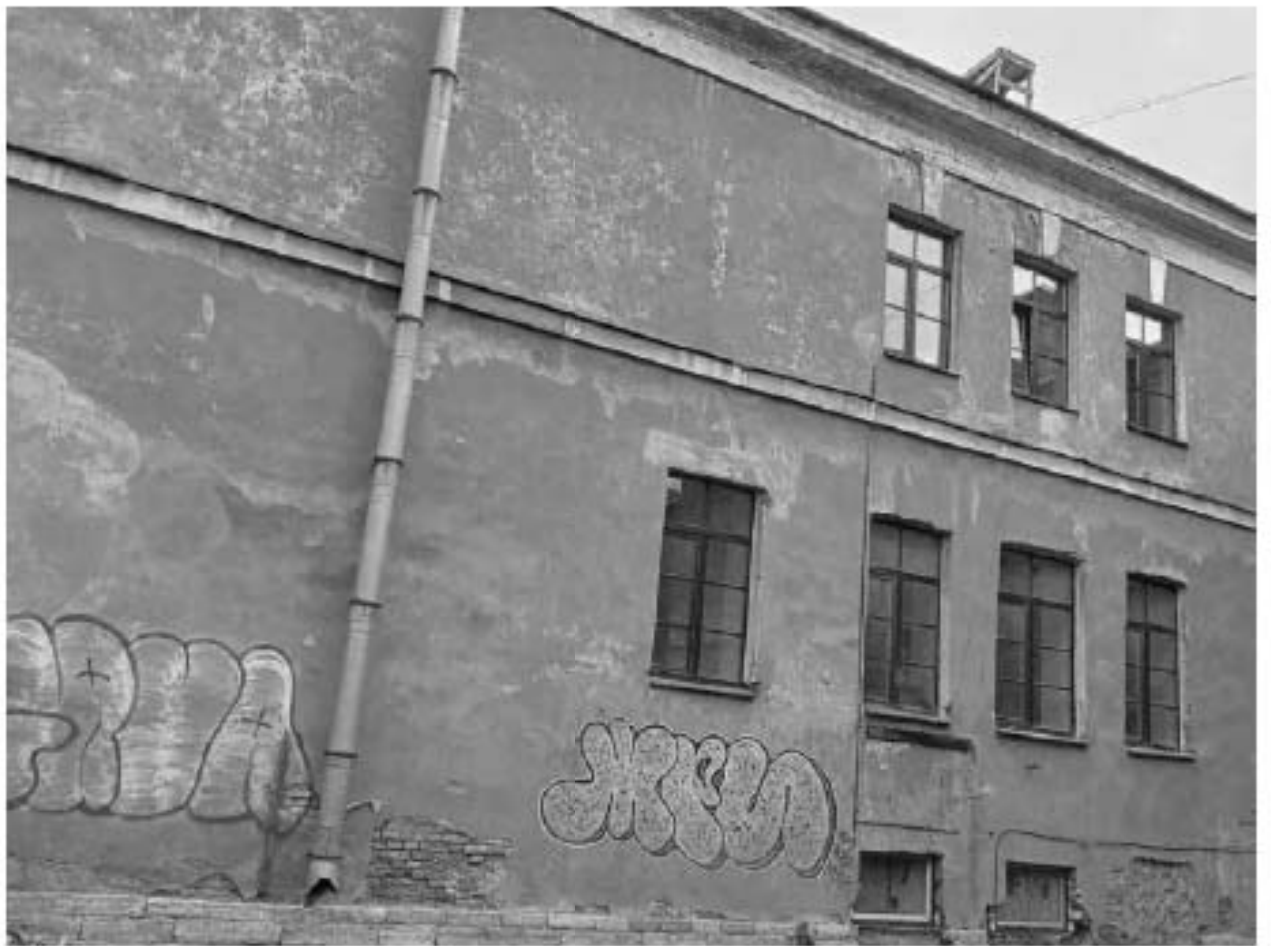
Фото 5. Объект культурного наследия регионального значения «Солдатская казарма с флигелем для неприкосновенного запаса», корпус по адресу: Санкт-Петербург, Рузовская ул., д.10-12, литера А. Северо-западный фасад.
