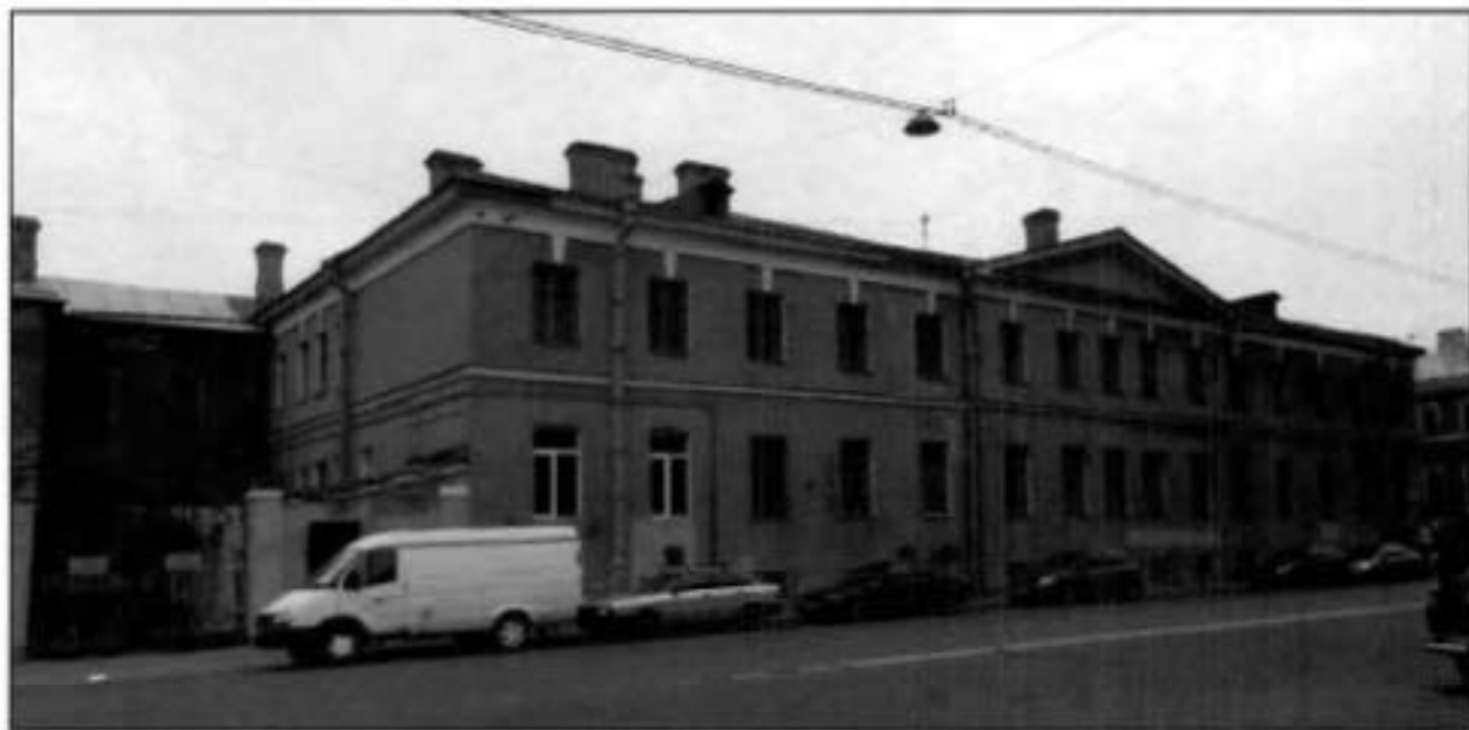
Фото 1. Общий вид (северо-западный и юго-западный фасады).
