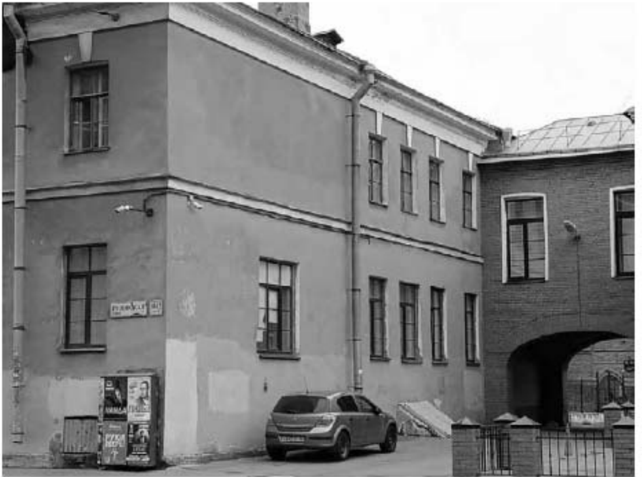
Фото 10. Объект культурного наследия регионального значения «Солдатская казарма» по адресу: Санкт-Петербург, Рузовская ул., д.10-12, литера А. Северо-западный фасад.
