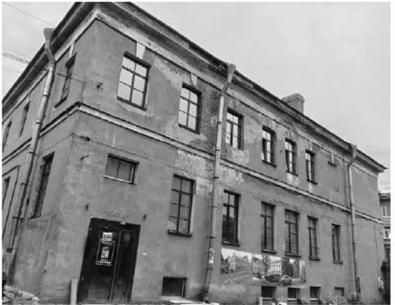
Фото 4. Объект культурного наследия регионального значения «Солдатская казарма с флигелем для неприкосновенного запаса», корпус по адресу: Санкт-Петербург, Рузовская ул., д.10-12, литера А. Северо-западный фасад.
