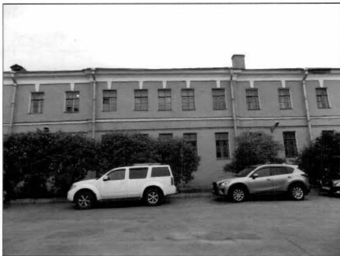
Фото 4. Фрагмент северо-восточного фасада.
