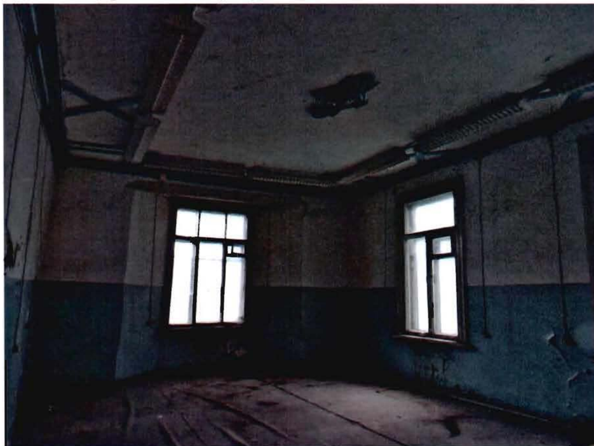
2. Помещение 1-го этажа.
