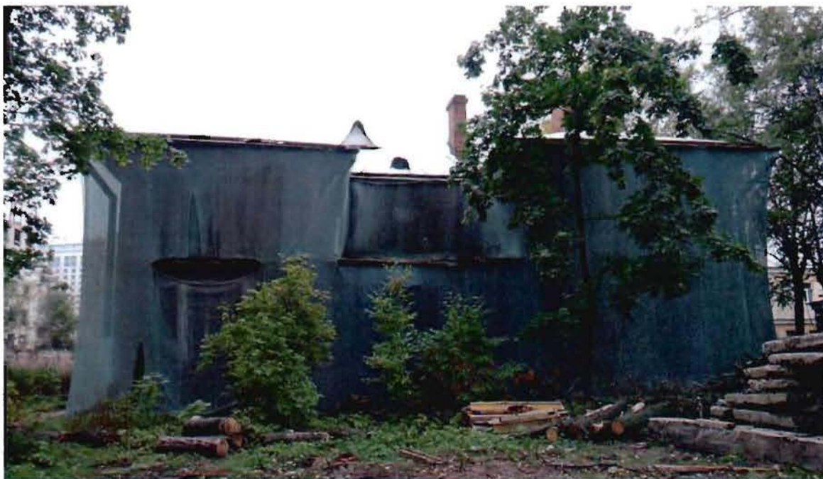
1. Восточный фасад объекта культурного наследия.
