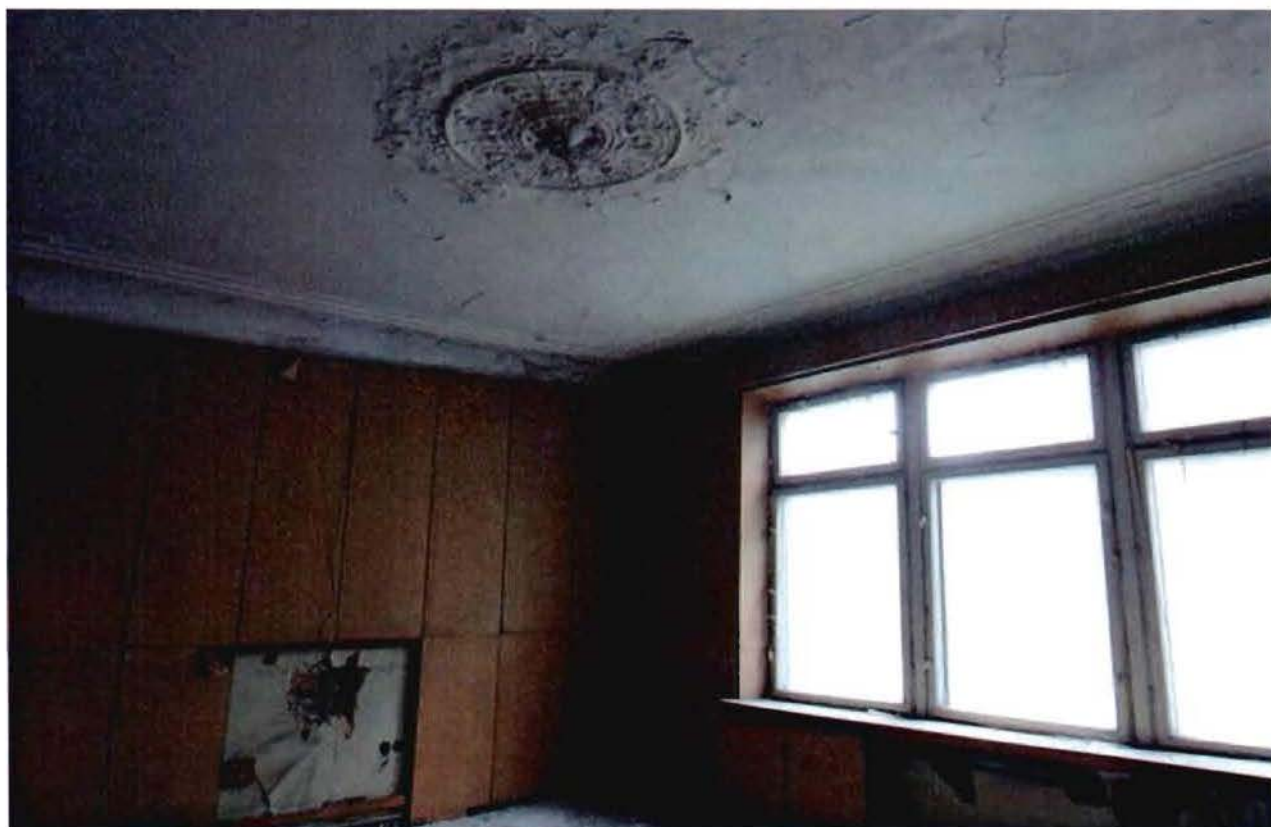
5. Помещение 2-го этажа.
