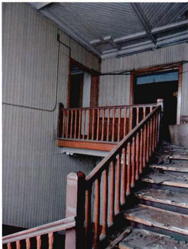
3. Парадная лестница в западной части объекта культурного наследия.
