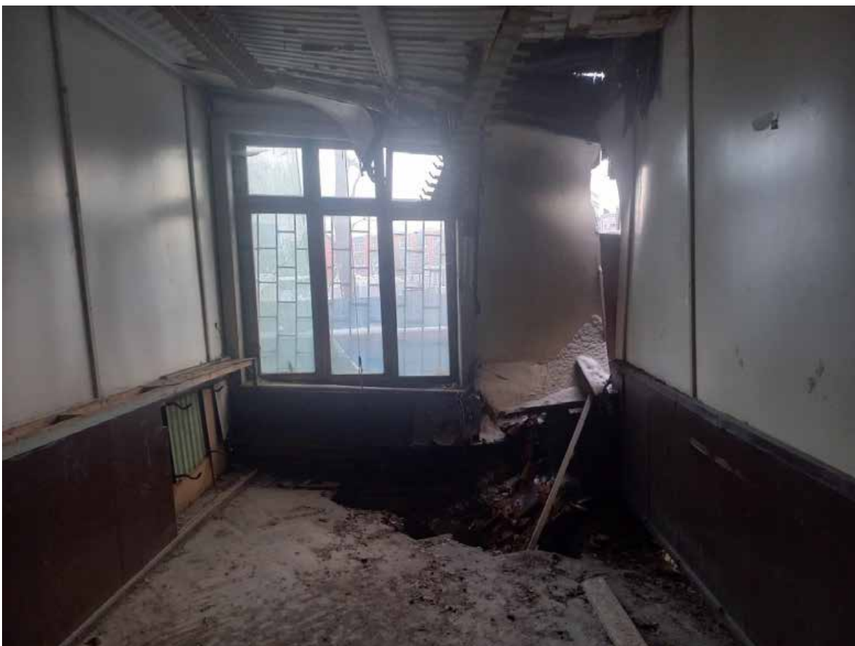
Фото 18. Внутренние помещения. 1 этаж.
