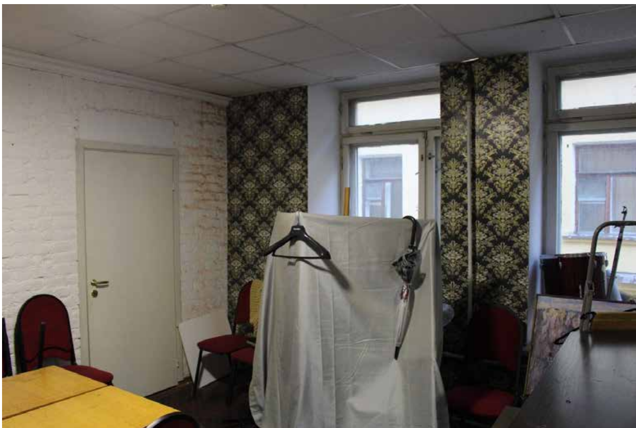
Фото 85. Внутренние помещения дворового флигеля выявленного объекта культурного наследия «Дом Зверкова (И.С. Никитина)». Нежилое помещение 34-Н. Помещение 49.
