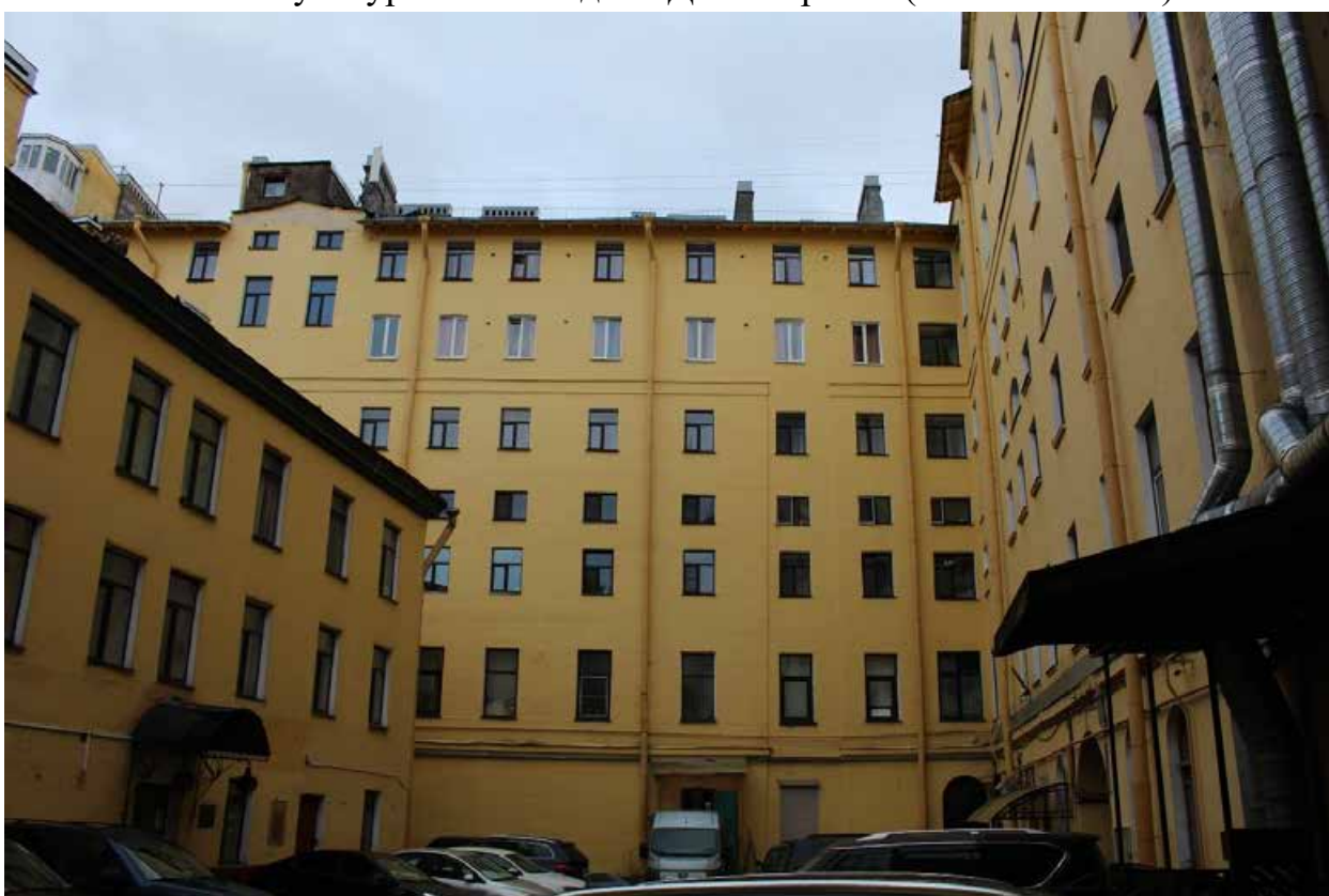
Фото 10. Вид на дворовый фасад южного лицевого корпуса выявленного объекта культурного наследия «Дом Зверкова (И.С. Никитина)».
