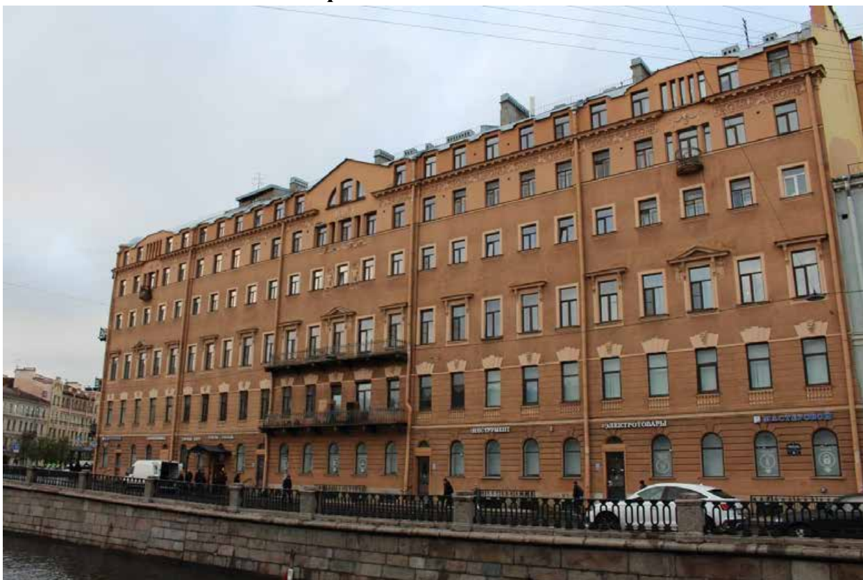
Фото 1. Вид на лицевой фасад южного лицевого корпуса выявленного объекта культурного наследия «Дом Зверкова (И.С. Никитина)».
