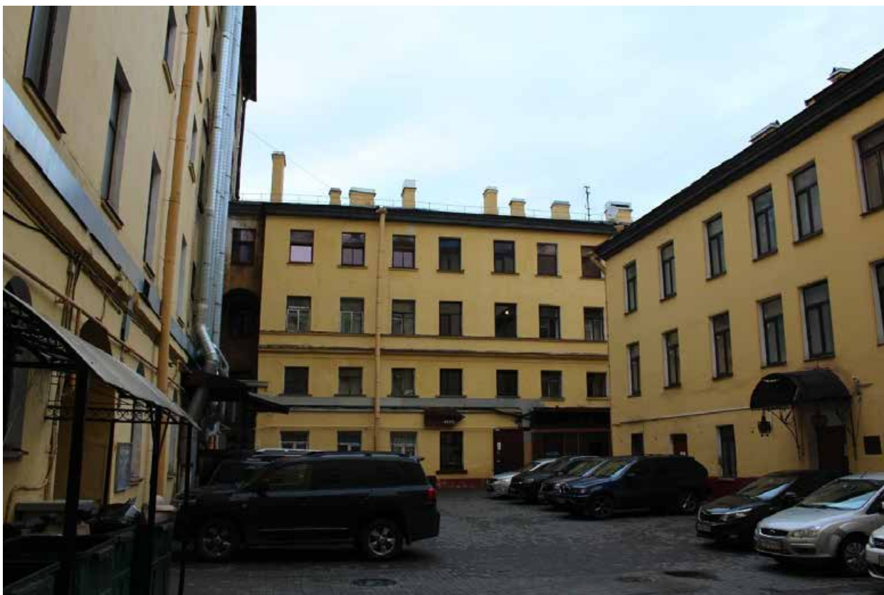
Фото 14. Вид на фасад северного дворового корпуса выявленного объекта культурного наследия «Дом Зверкова (И.С. Никитина)».
