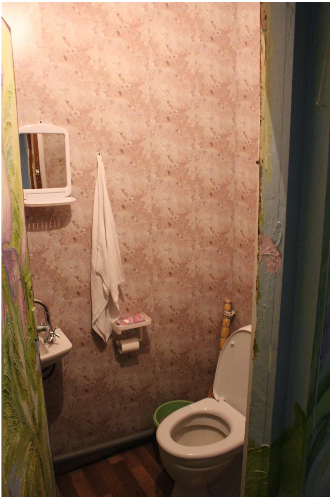
Фото 83. Внутренние помещения дворового флигеля выявленного объекта культурного наследия «Дом Зверкова (И.С. Никитина)». Нежилое помещение 34-Н. Помещение 52.
