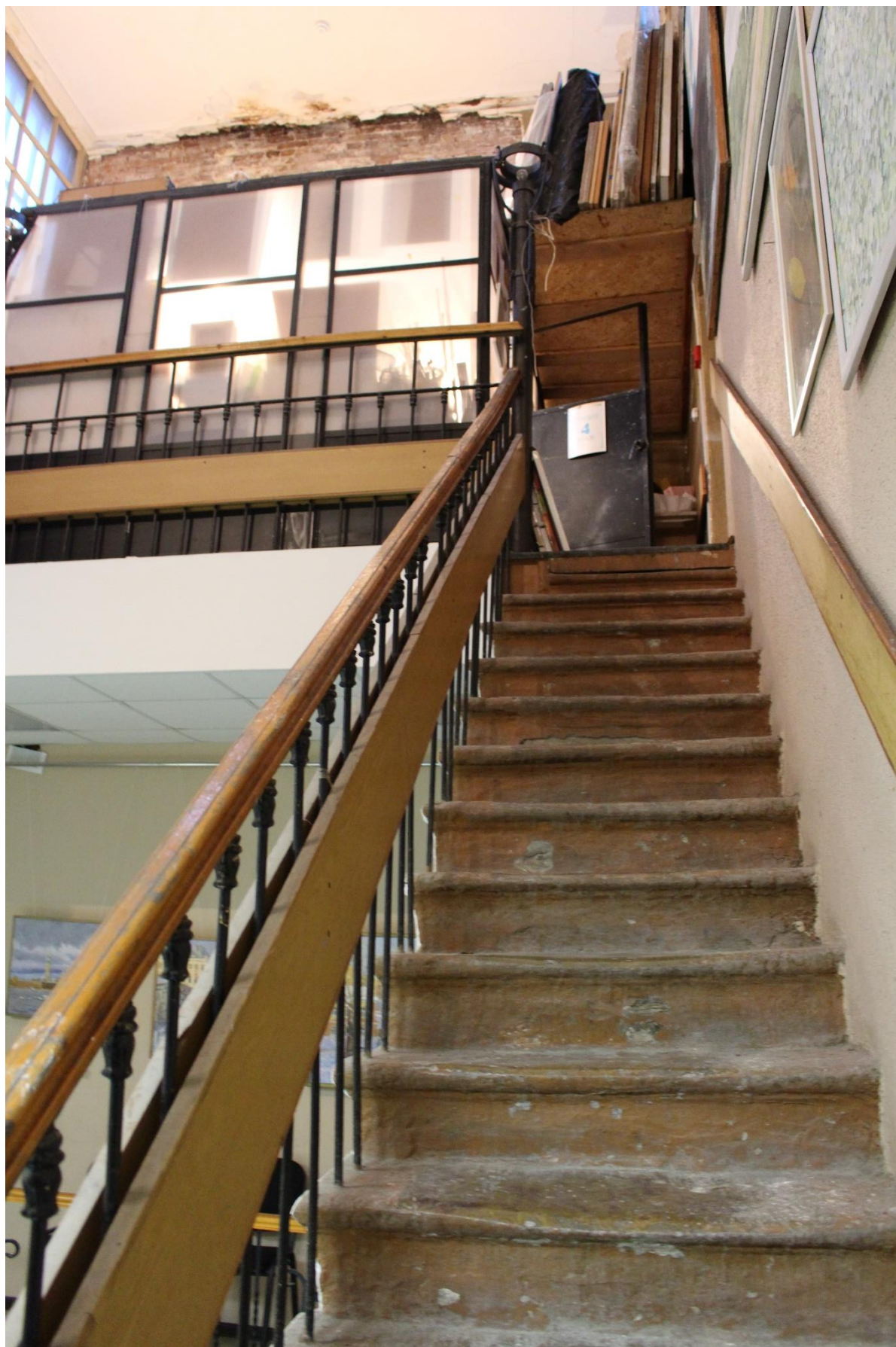
Фото 100. Внутренние помещения дворового флигеля выявленного объекта культурного наследия «Дом Зверкова (И.С. Никитина)». Нежилое помещение 34-Н. Лестница на чердачный этаж.
