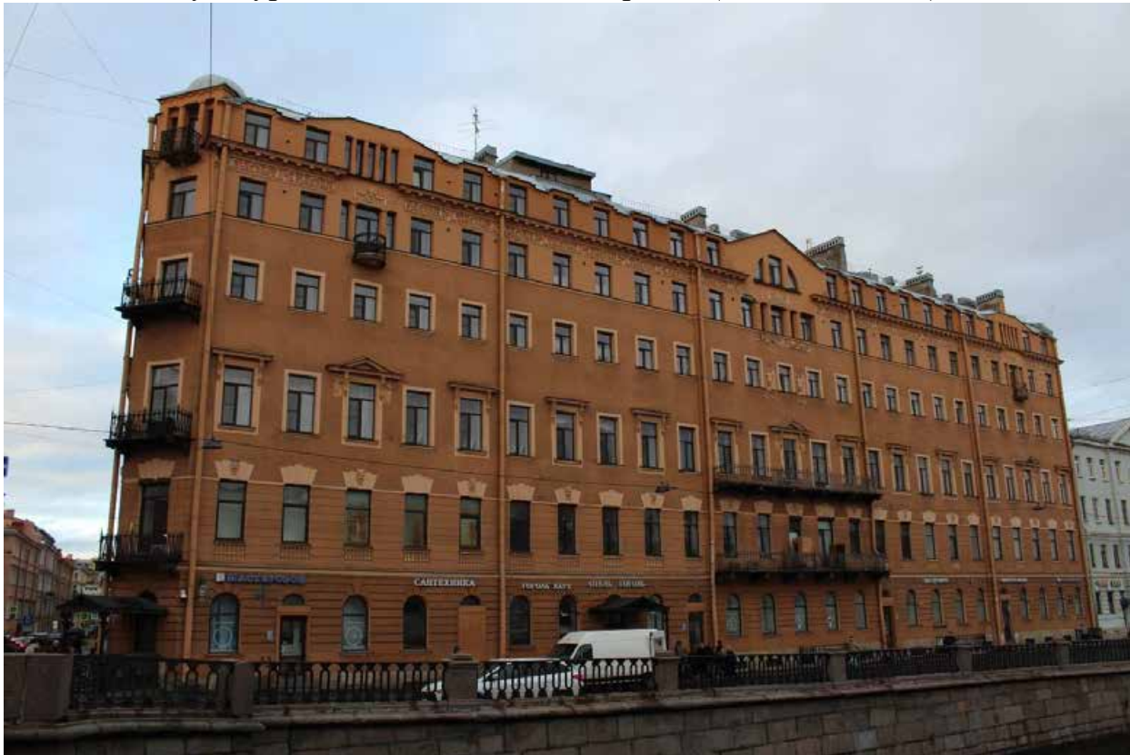
Фото 2. Вид на лицевой фасад южного лицевого корпуса выявленного объекта культурного наследия «Дом Зверкова (И.С. Никитина)».
