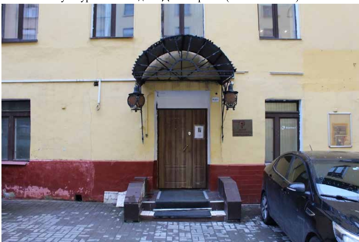
Фото 24. Вход в нежилое помещение 34-Н с западной стороны дворового флигеля выявленного объекта культурного наследия «Дом Зверкова (И.С. Никитина)».
