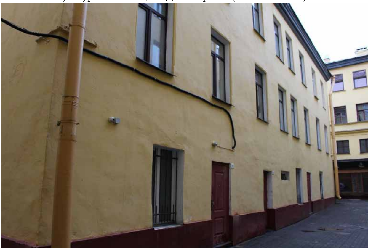
Фото 18. Вид на восточный фасад дворового флигеля выявленного объекта культурного наследия «Дом Зверкова (И.С. Никитина)».
