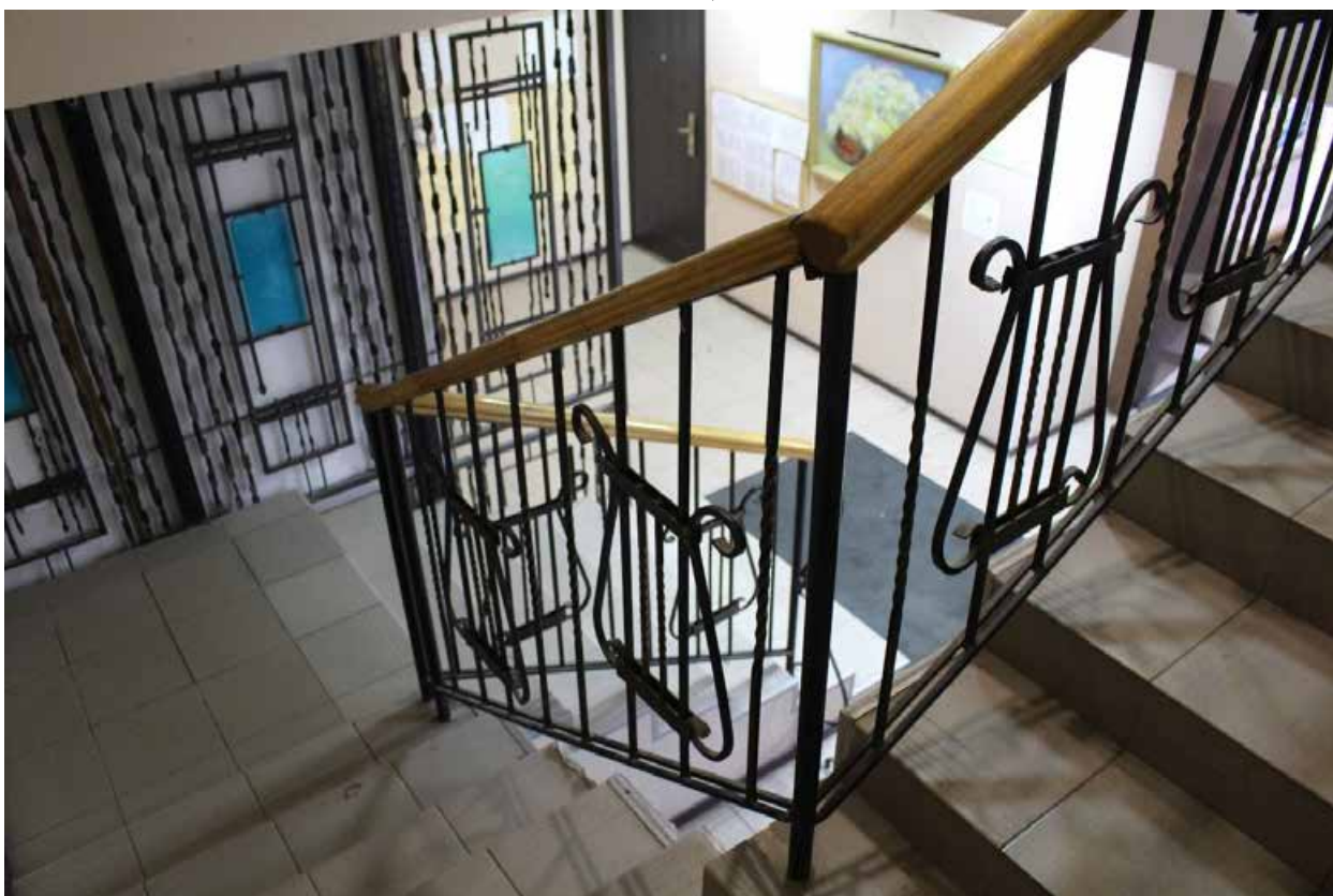
Фото 49. Внутренние помещения дворового флигеля выявленного объекта культурного наследия «Дом Зверкова (И.С. Никитина)». Нежилое помещение 34-Н. Лестница в помещениях 5, 39 (в уровне 1-го – 2-го этажей).
