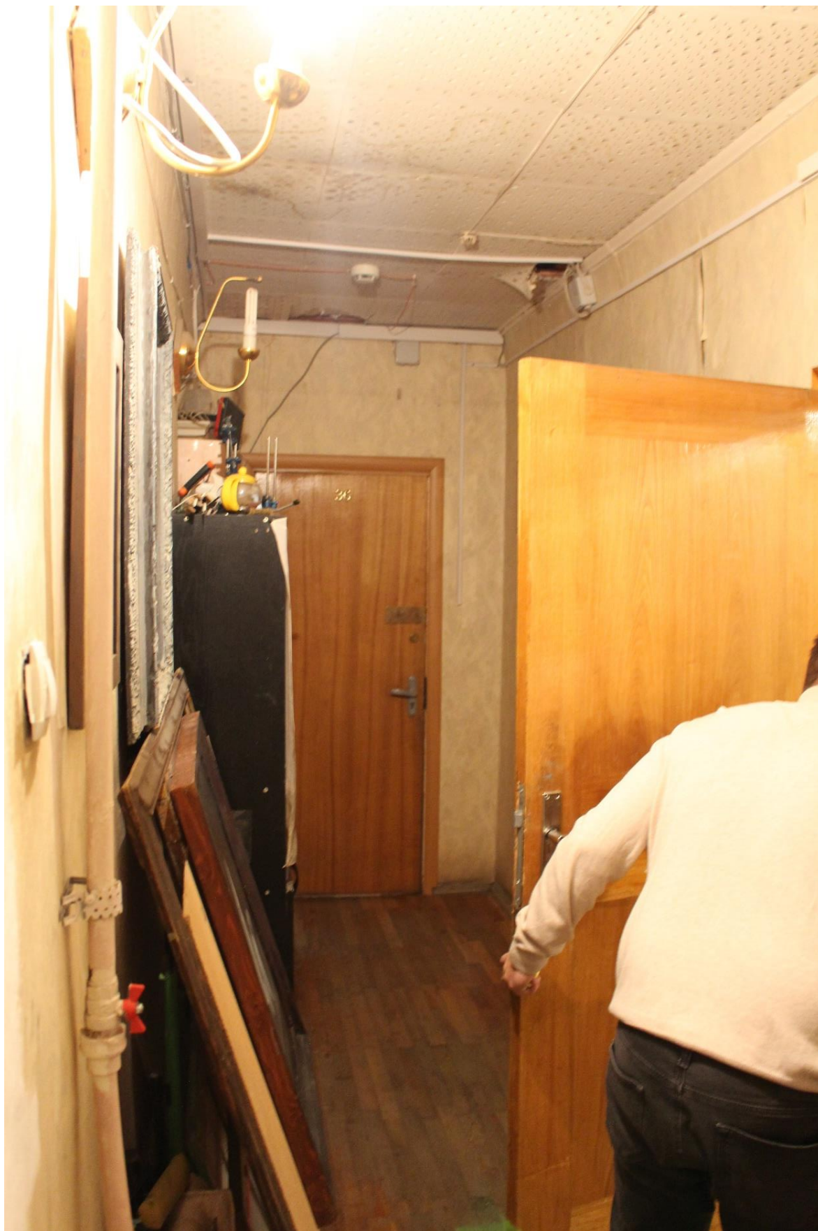
Фото 90. Внутренние помещения дворового флигеля выявленного объекта культурного наследия «Дом Зверкова (И.С. Никитина)». Нежилое помещение 34-Н. Помещение 42.
