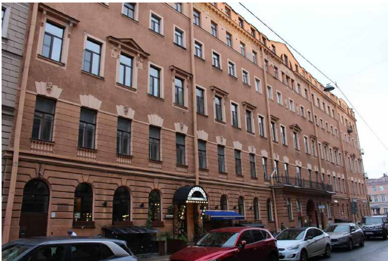
Фото 5. Вид на лицевой фасад западного лицевого корпуса выявленного объекта культурного наследия «Дом Зверкова (И.С. Никитина)».
