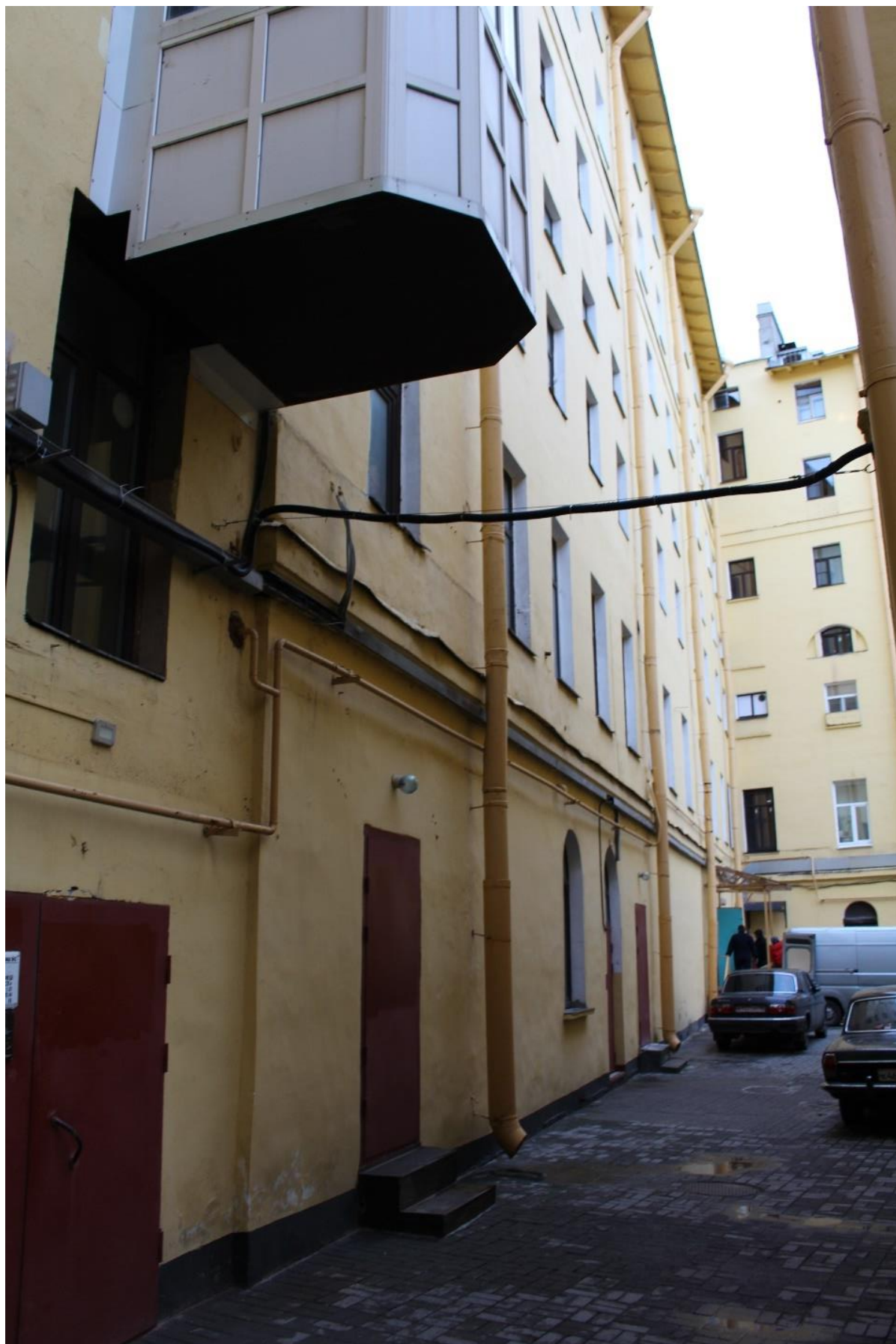
Фото 11. Вид на дворовый фасад южного лицевого корпуса выявленного объекта культурного наследия «Дом Зверкова (И.С. Никитина)».
