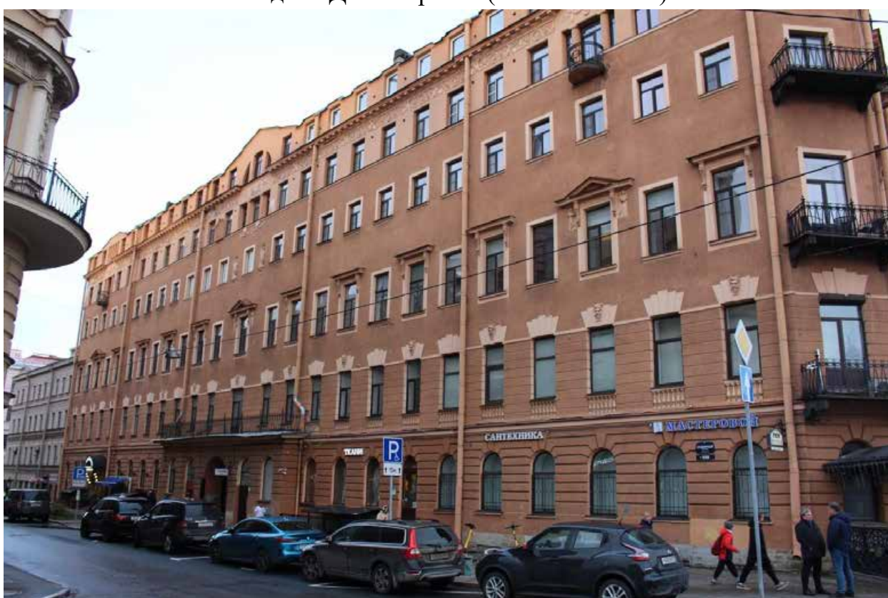
Фото 4. Вид на лицевой фасад западного лицевого корпуса выявленного объекта культурного наследия «Дом Зверкова (И.С. Никитина)».
