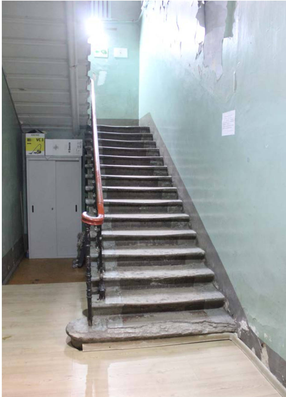
7. 1-й этаж. Вид парадной лестницы в помещении 1-Н(26). Фотофиксация: 26 апреля 2024 г.
