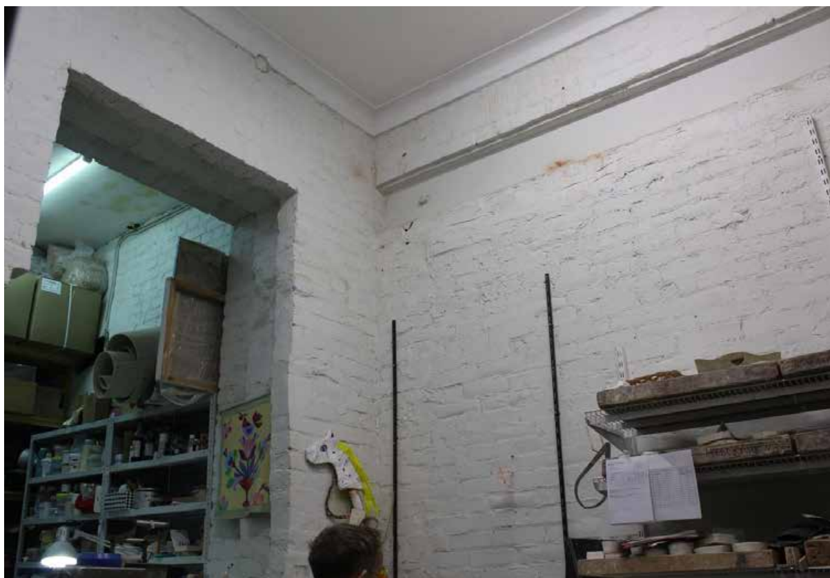
7. 1-й этаж. Помещение 5-Н(5). Заложенный воротный проем. Фотофиксация: 26 апреля 2024 г.
