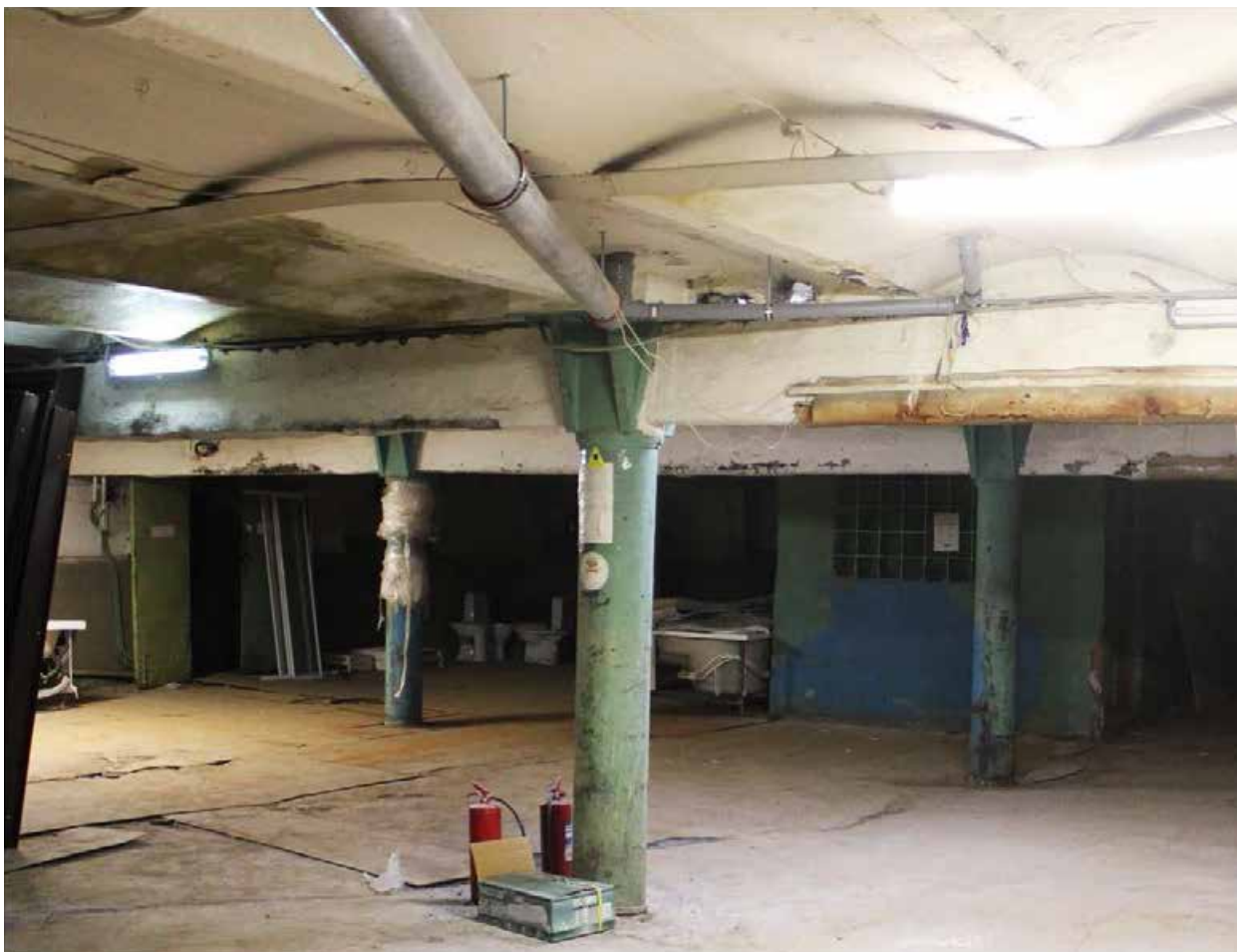
3. Подвал. Вид колонны и сводчатого перекрытия в помещении 1-Н(70). Фотофиксация: 26 апреля 2024 г.
