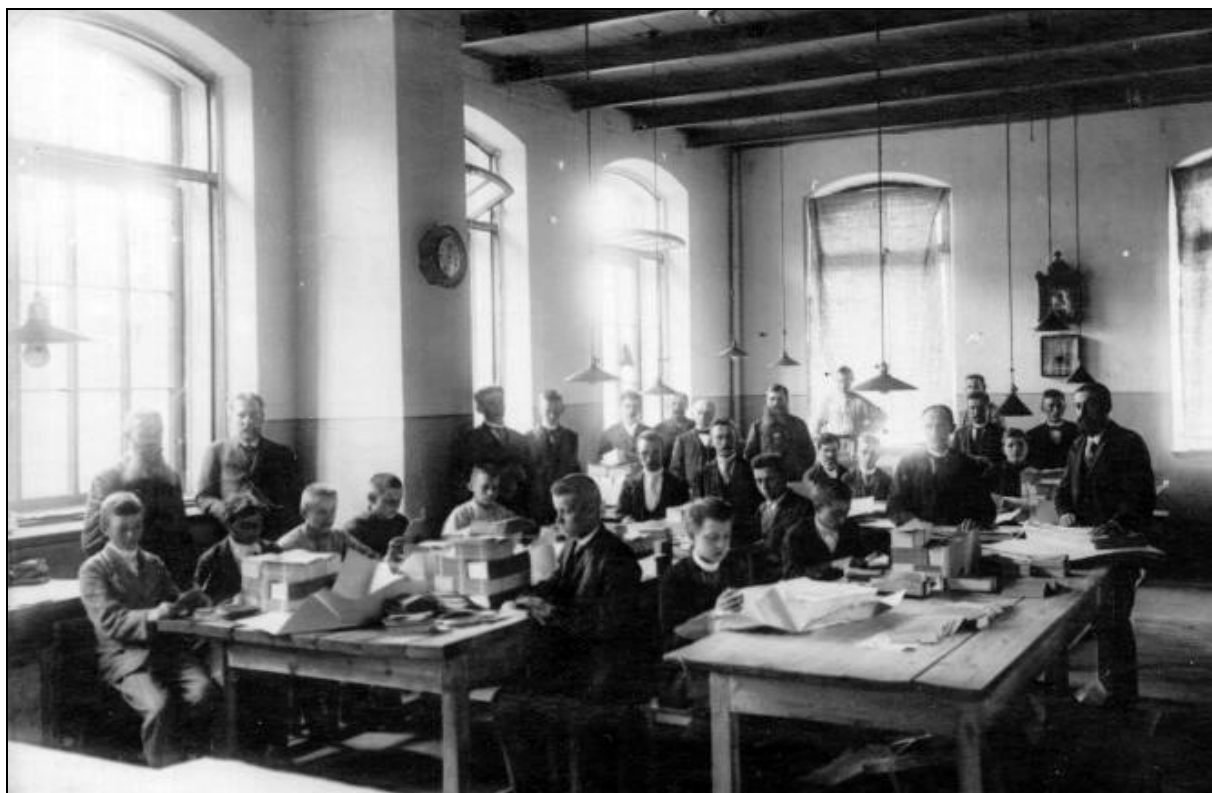
64. Цех фабрики «Отто Кирхнер» (современный корпус лит. В). 1909 г. // ЦГА КФФД СПб. Шифр: Д 14309.
