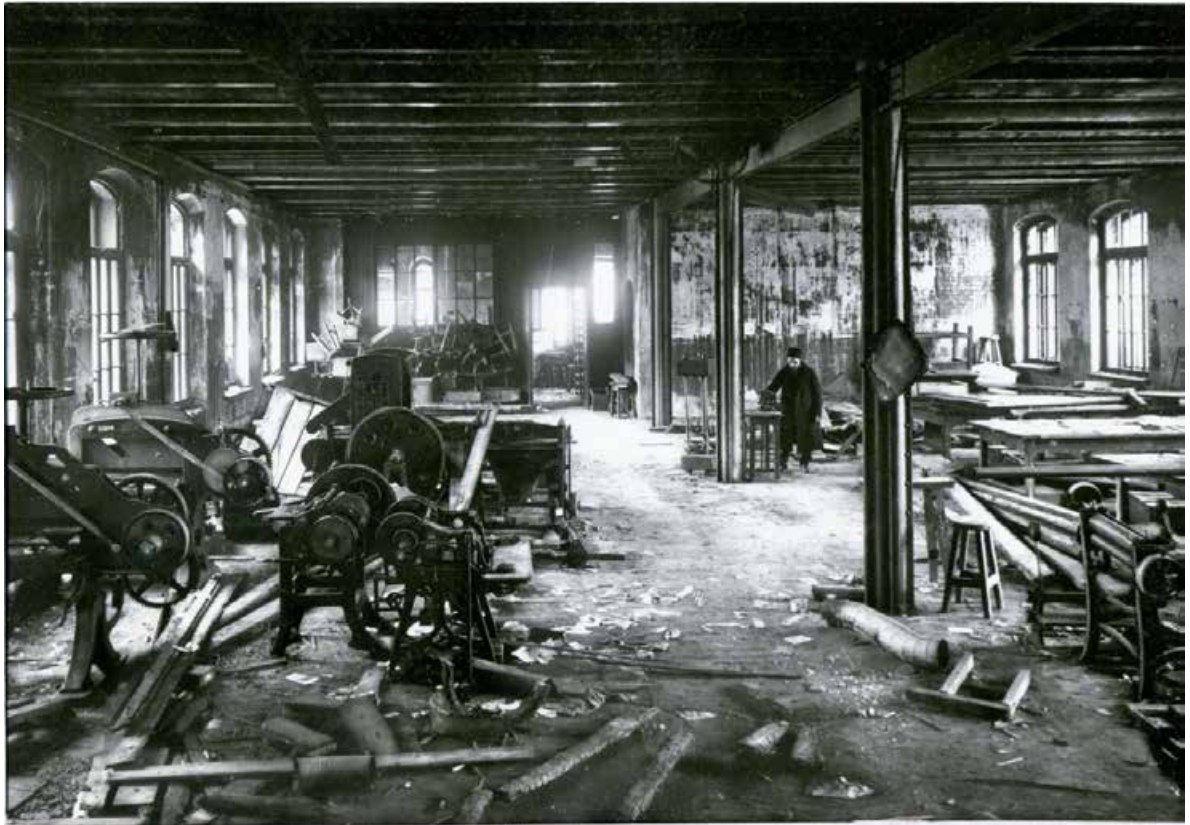
107. Внутренний вид цеха до восстановления (современный корпус лит. В). До 1924 г. // Музей фабрики «Светоч».
