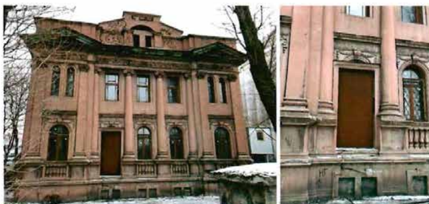
41, 42. Северо-западный фасад со стороны Песочной наб.
