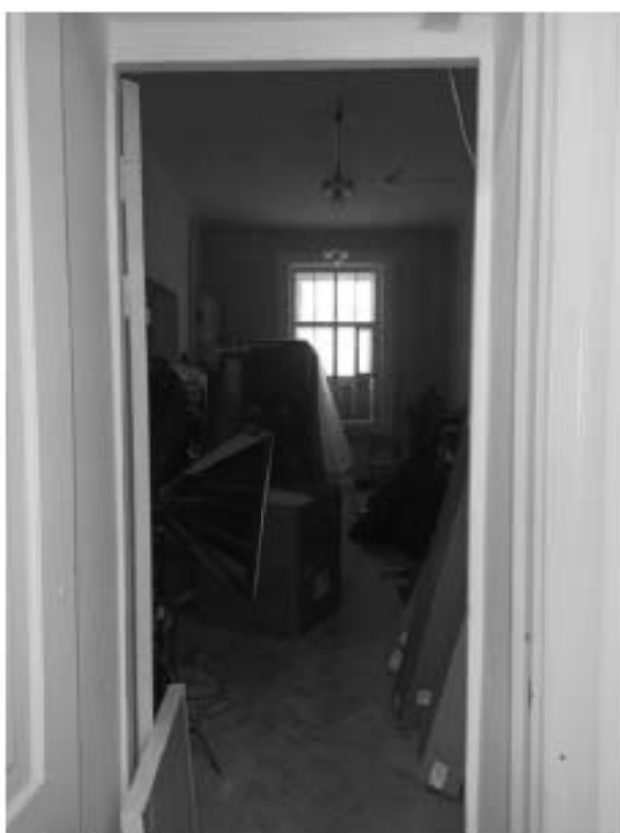
Фото 22. Интерьер 2-го этажа объекта культурного наследия регионального значения «Здание приюта для детей-иждивенцев и эпилептиков Братства во имя Царицы Небесной с примыкающей часовней при домово́й церкви Божьей Матери Скорбящих Радости»
