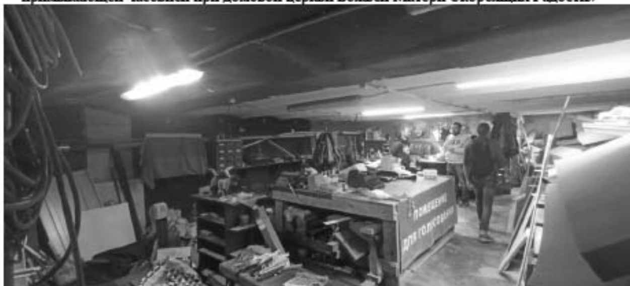
Фото 4. Интерьер подвального этажа объекта культурного наследия регионального значения «Здание приюта для детей-идиотов и эпилептиков Братства во имя Царицы Небесной с примыкающей часовней при домовой церкви Божьей Матери Скорбящих Радости»
