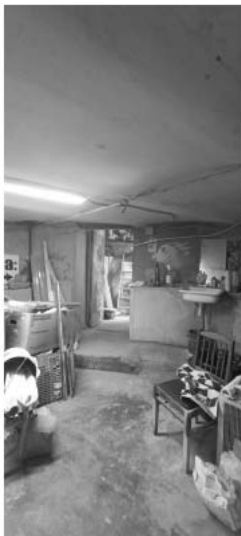
Фото 6. Интерьер подвального этажа объекта культурного наследия регионального значения «Здание приюта для детей-идиотов и эпилептиков Братства во имя Царицы Небесной с примыкающей часовней при домово́й церкви Божьей Матери Скорбящих Радости»
