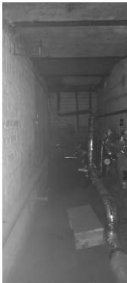
Фото 7. Интерьер подвального этажа объекта культурного наследия регионального значения «Здание приюта для детей-идиотов и эпилептиков Братства во имя Царицы Небесной с примыкающей часовней при домовой церкви Божьей Матери Скорбящих Радости»
