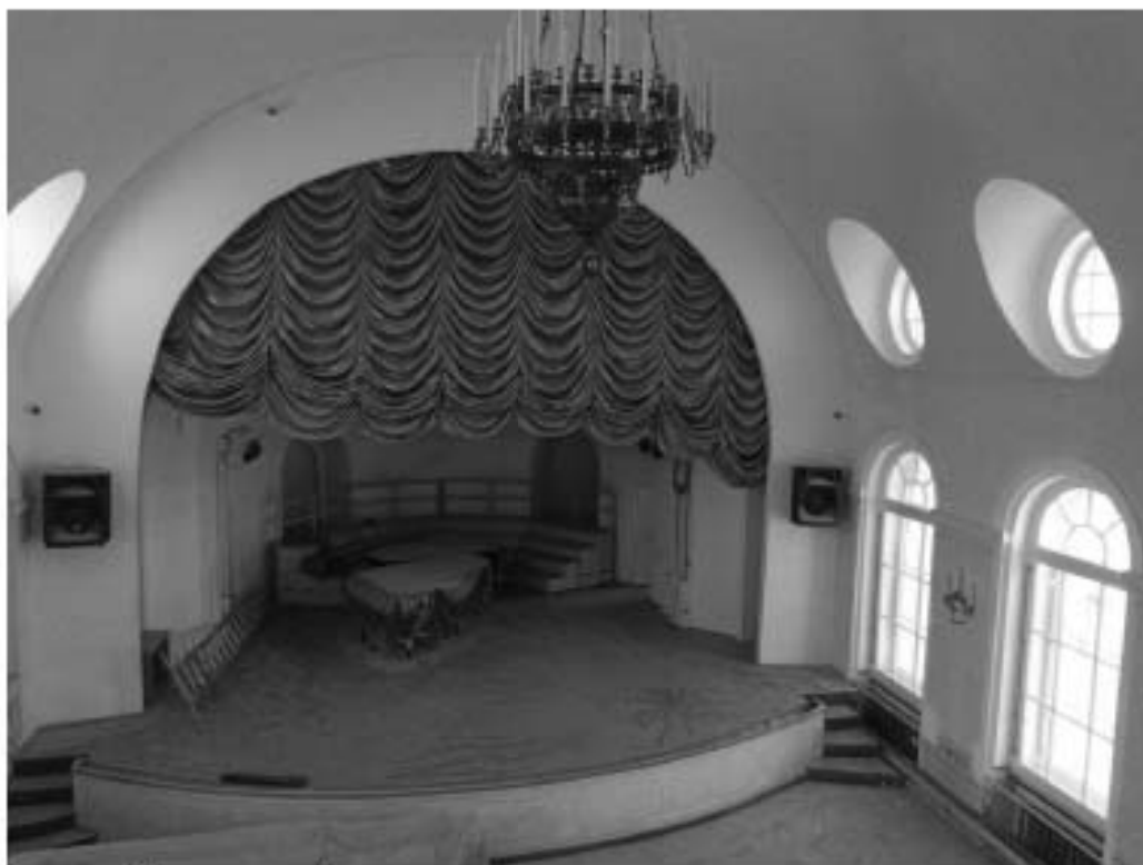
Фото 47. Интерьер 3-го этажа объекта культурного наследия регионального значения «Здание приюта для детей-иждивенцев и эпилептиков Братства во имя Царицы Небесной с примыкающей часовней при домово́й церкви Божьей Матери Скорбящих Радости»
