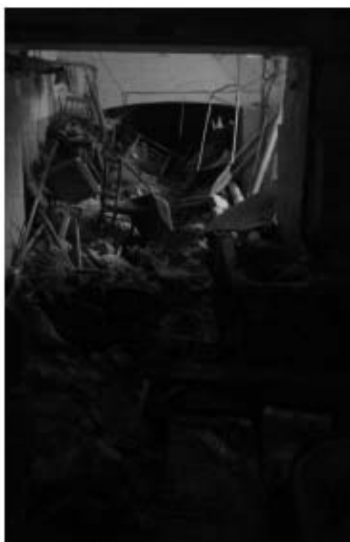
Фото 8. Интерьер подвального этажа объекта культурного наследия регионального значения «Здание приюта для детей-идиотов и эпилептиков Братства во имя Царицы Небесной с примыкающей часовней при домовой церкви Божьей Матери Скорбящих Радости»
