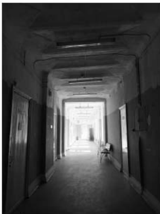
Фото 37. Интерьер 4-го этажа объекта культурного наследия регионального значения «Здание приюта для детей-иждивенцев и эпилептиков Братства во имя Царицы Небесной с примыкающей часовней при домово́й церкви Божьей Матери Скорбящих Радости»
