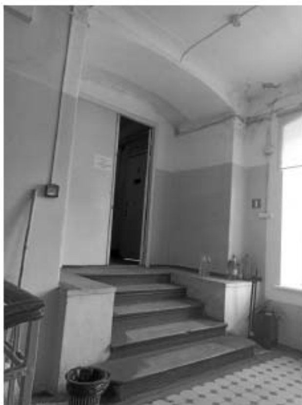
Фото 39. Интерьер 4-го этажа объекта культурного наследия регионального значения «Здание приюта для детей-иждивенцев и эпилептиков Братства во имя Царицы Небесной с примыкающей часовней при домово́й церкви Божьей Матери Скорбящих Радости»
