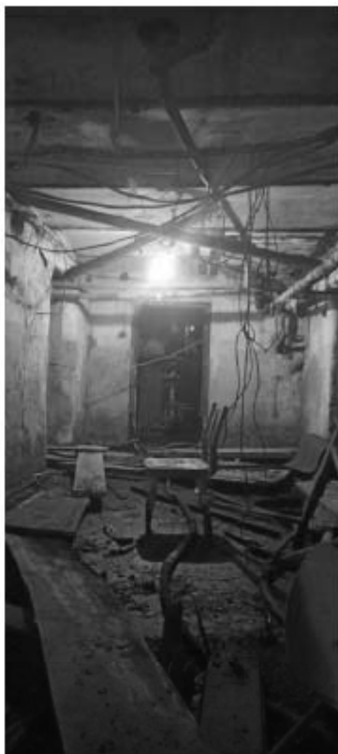
Фото 9. Интерьер подвального этажа объекта культурного наследия регионального значения «Здание приюта для детей-идиотов и эпилептиков Братства во имя Царицы Небесной с примыкающей часовней при домовой церкви Божьей Матери Скорбящих Радости»
