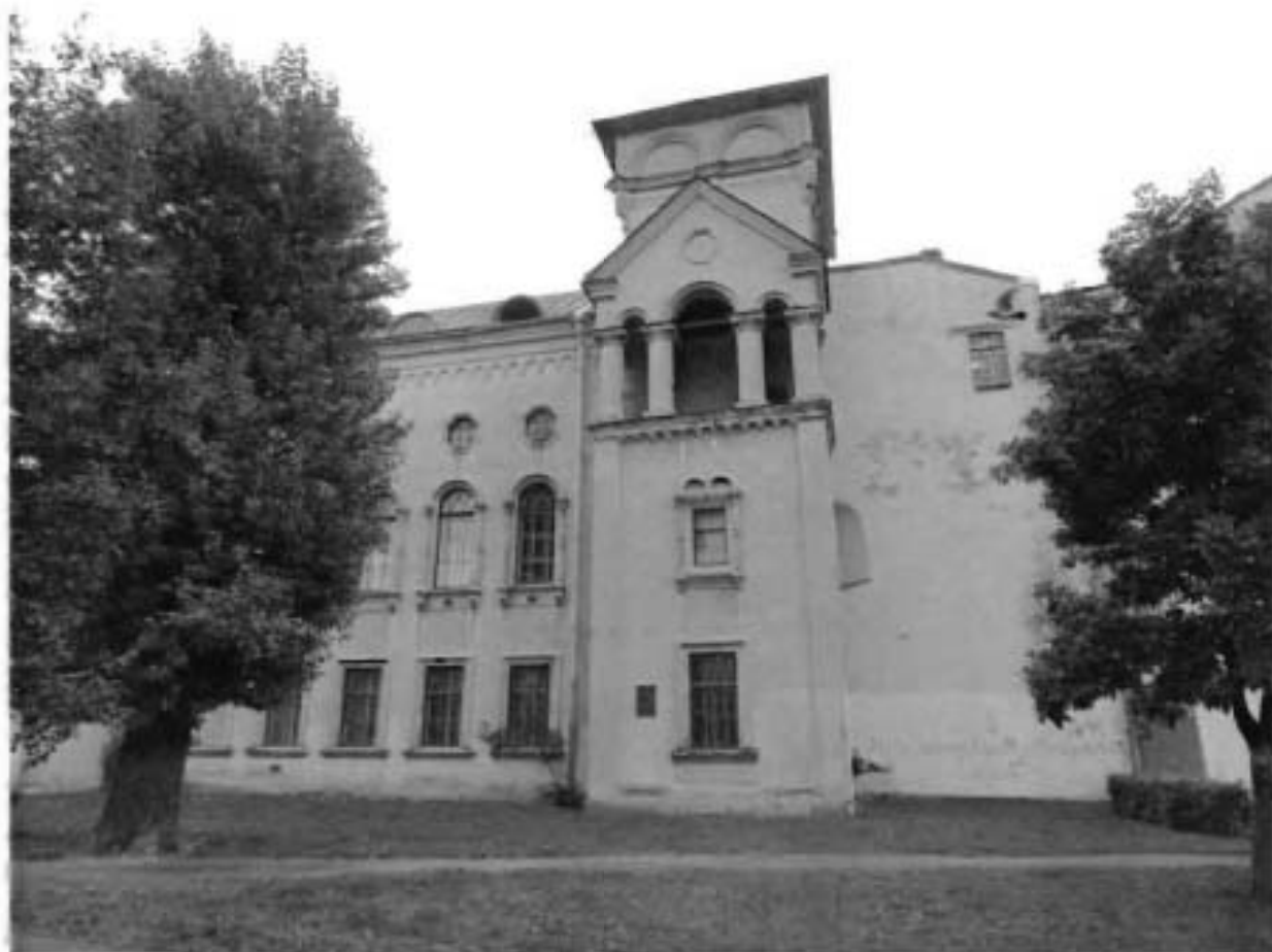
Фото 3. Часть западного фасада.
