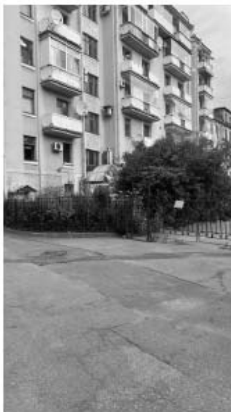
Фото 2. Вид на территорию объекта культурного наследия регионального значения «Здание приюта для детей-иждивенцев и эпилептиков Братства во имя Царицы Небесной с примыкающей часовней при домовая церкви Божьей Матери Скорбящих Радости»
