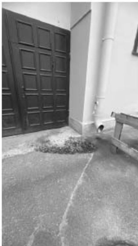
Фото 1. Вид на территорию объекта культурного наследия регионального значения «Здание приюта для детей-иждивенцев и эпилептиков Братства во имя Царицы Небесной с примыкающей часовней при домовая церкви Божьей Матери Скорбящих Радости»
