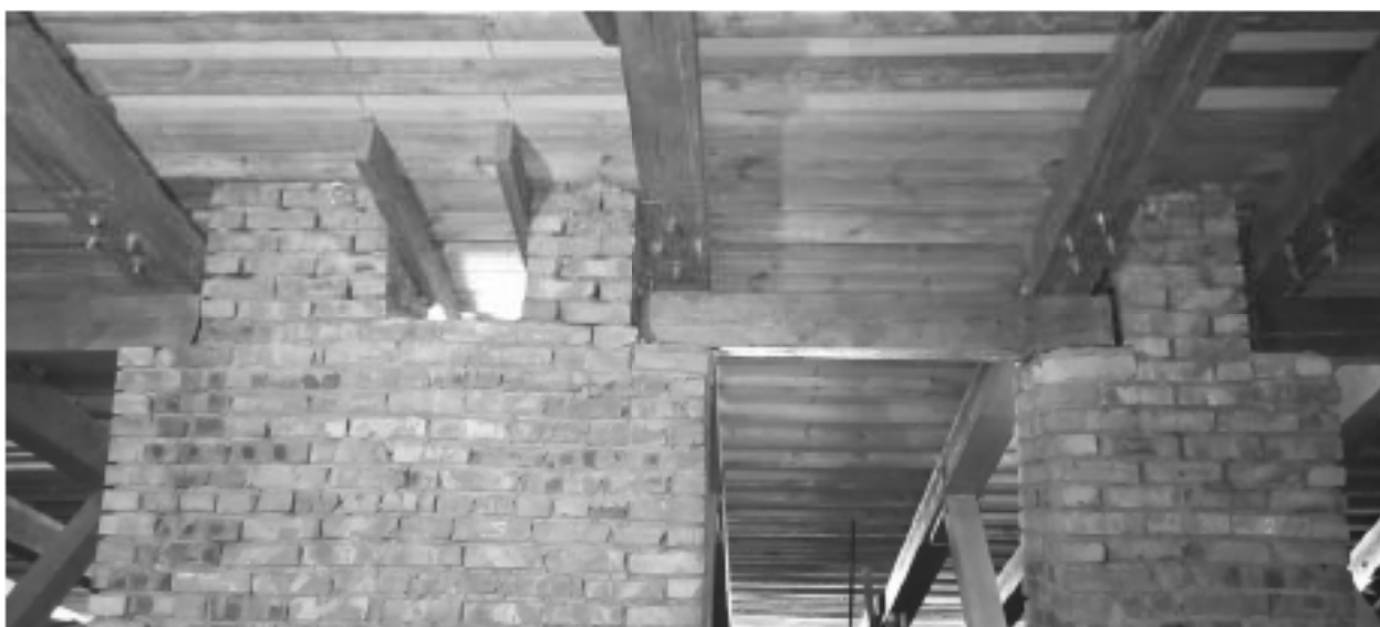
Фото 56. Интерьер чердака объекта культурного наследия регионального значения «Здание приюта для детей-сирот и эпилептиков Братства во имя Царицы Небесной с примыкающей часовней при домово́й церкви Божьей Матери Скорбящих Радости»
