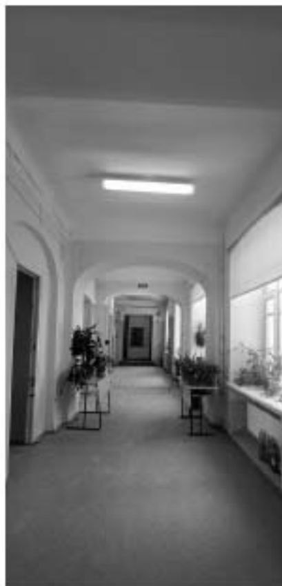
Фото 31. Интерьер 3-го этажа объекта культурного наследия регионального значения «Здание приюта для детей-иждивенцев и эпилептиков Братства во имя Царицы Небесной с примыкающей часовней при домово́й церкви Божьей Матери Скорбящих Радости»
