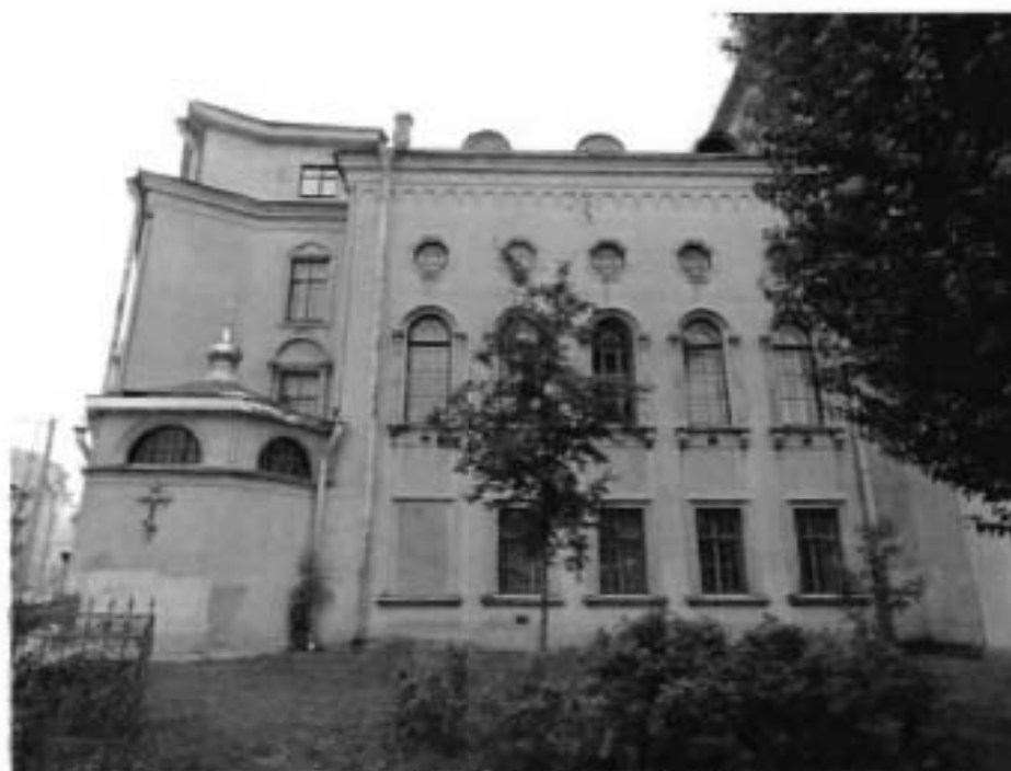
Фото 2. Часть западного фасада.
