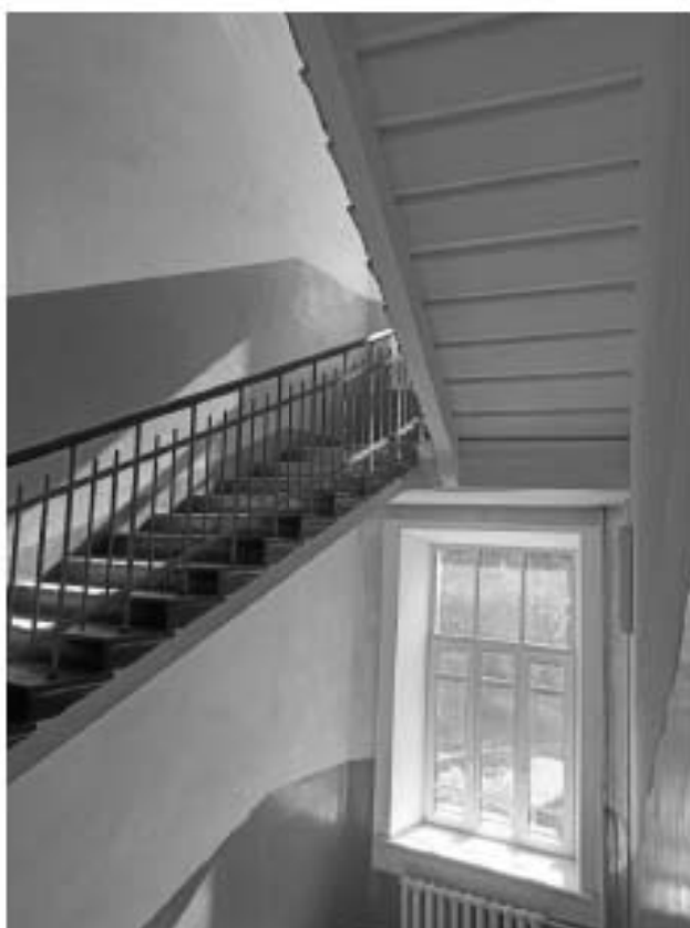
Фото 43. Интерьер 3-го этажа объекта культурного наследия регионального значения «Здание приюта для детей-иждивенцев и эпилептиков Братства во имя Царицы Небесной с примыкающей часовней при домово́й церкви Божьей Матери Скорбящих Радости»
