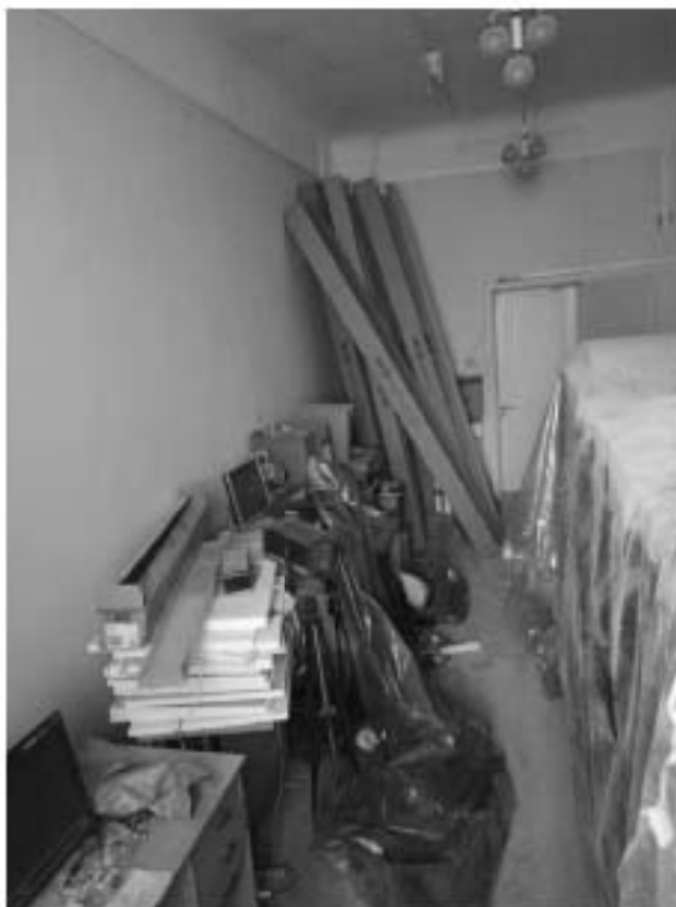
Фото 21. Интерьер 2-го этажа объекта культурного наследия регионального значения «Здание приюта для детей-иждивенцев и эпилептиков Братства во имя Царицы Небесной с примыкающей часовней при домово́й церкви Божьей Матери Скорбящих Радости»
