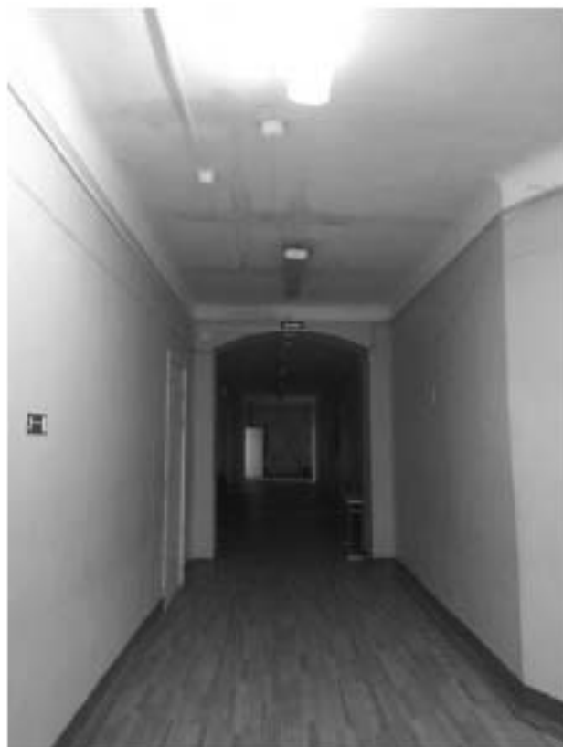
Фото 35. Интерьер 3-го этажа объекта культурного наследия регионального значения «Здание приюта для детей-иждивенцев и эпилептиков Братства во имя Царицы Небесной с примыкающей часовней при домово́й церкви Божьей Матери Скорбящих Радости»
