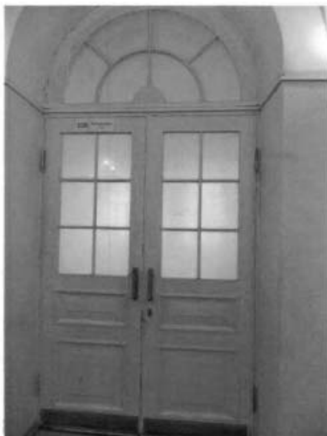
Фото 11. Двустворчатые двери с арочным завершением.
