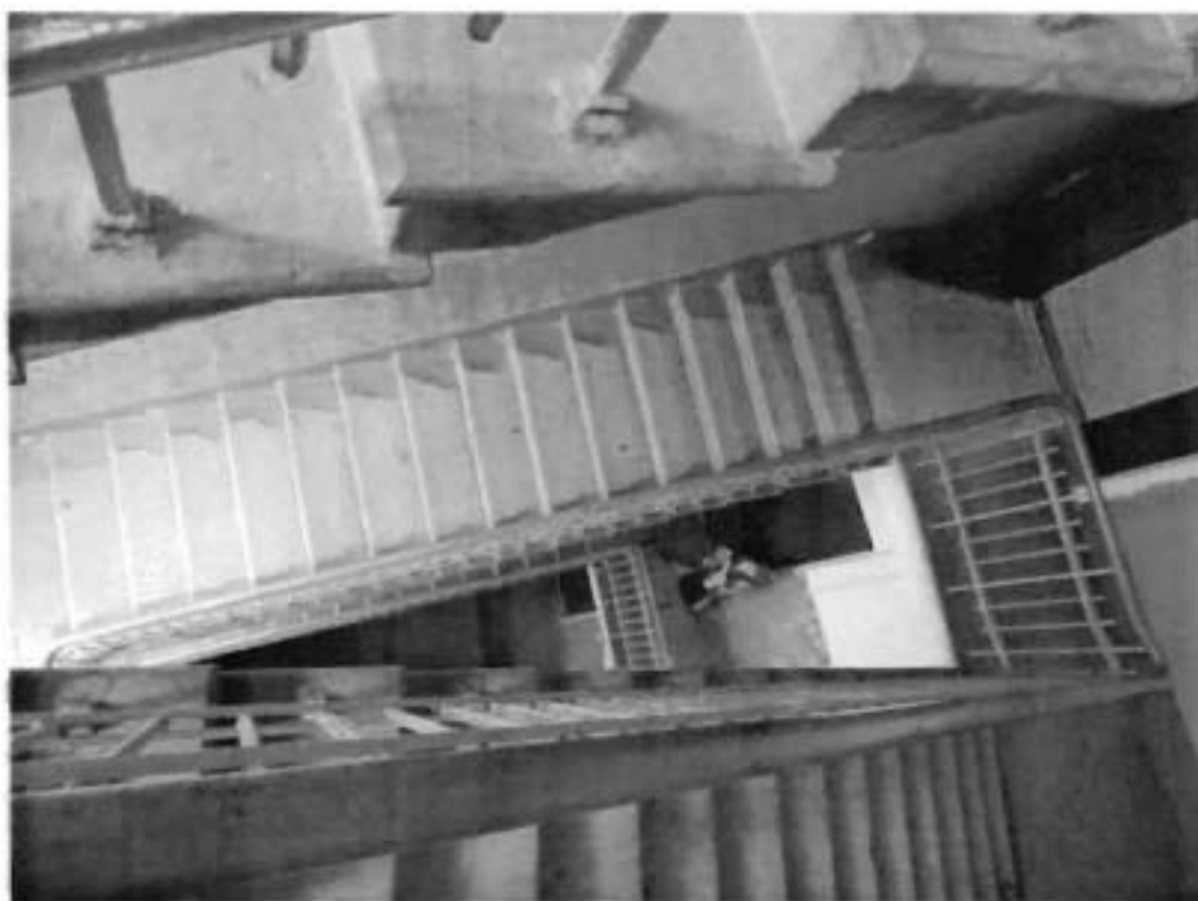
Фото 14. Лестница в южной части здания, пом. Н-2.
