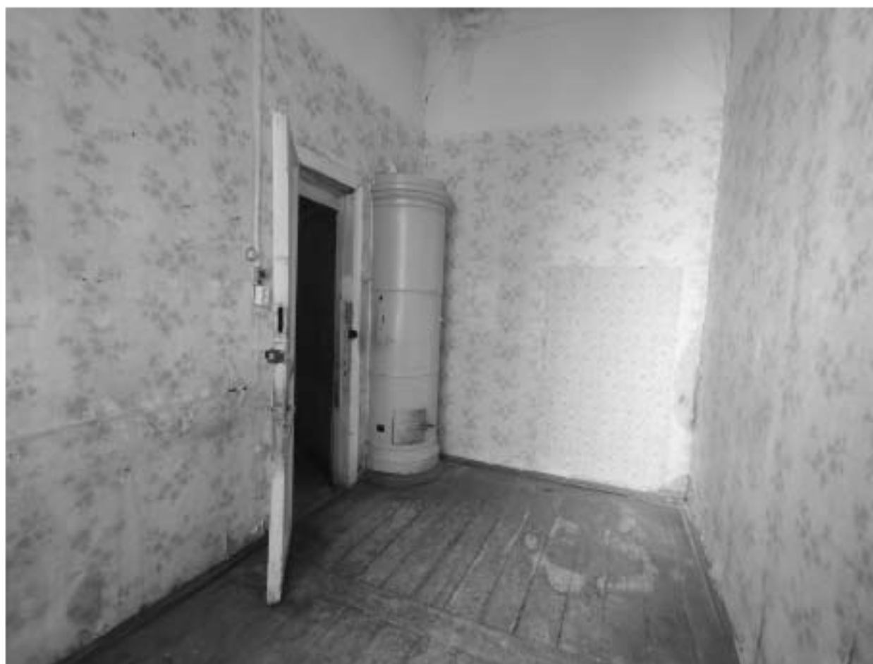
9. Фрагмент интерьера комнаты (помещение 4/10.8);
