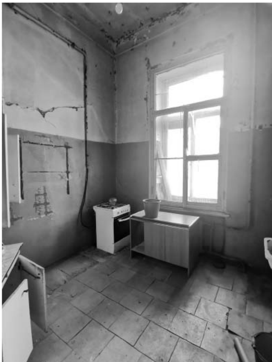
7. Фрагмент интерьера кухни (помещение 3/10.3);
