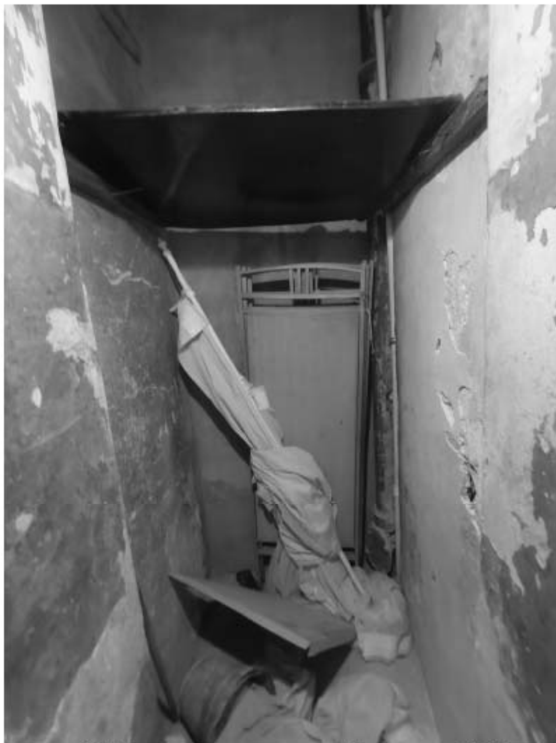
16. Фрагмент интерьера кладовой (помещение 5/0.9).
