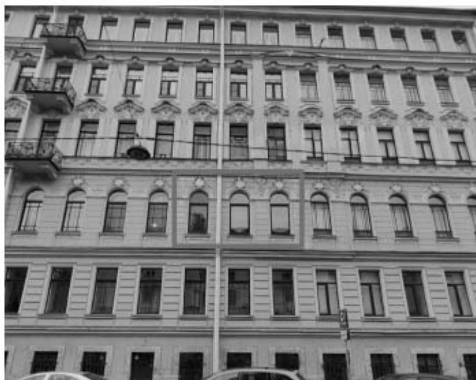
2. Фрагмент фасада объекта культурного наследия регионального значения «Дом А.И. Шульгина», расположенного по адресу: г. Санкт-Петербург, Кирочная улица, дом 45, литера А и окна квартиры №53;
