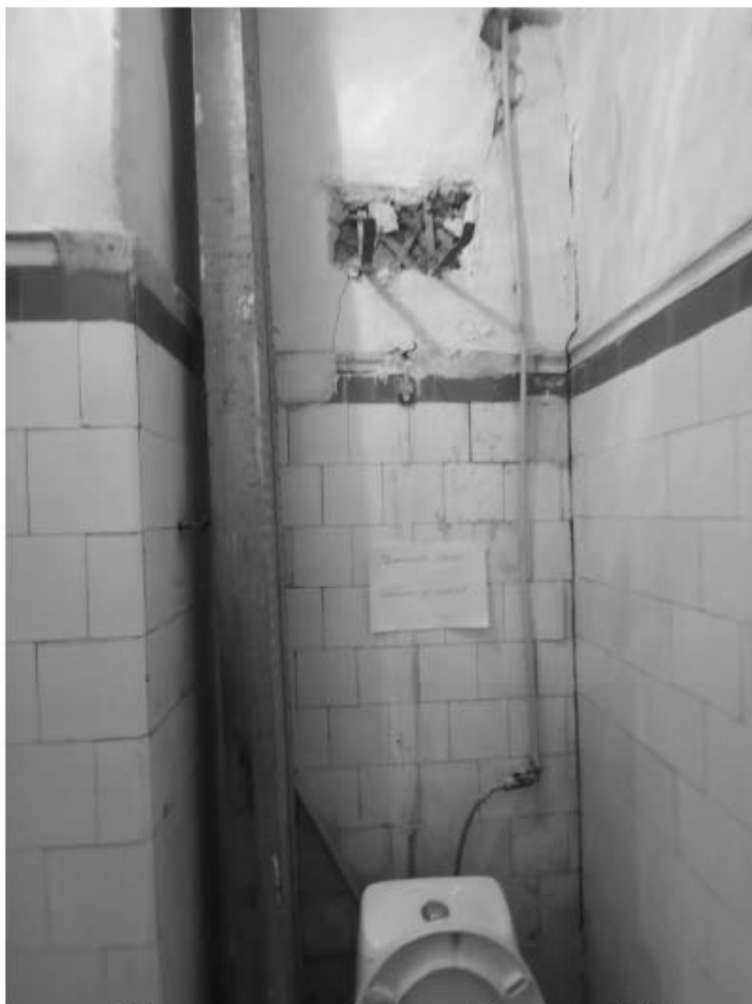
15. Фрагмент интерьера туалета (помещение 9/1.4);
