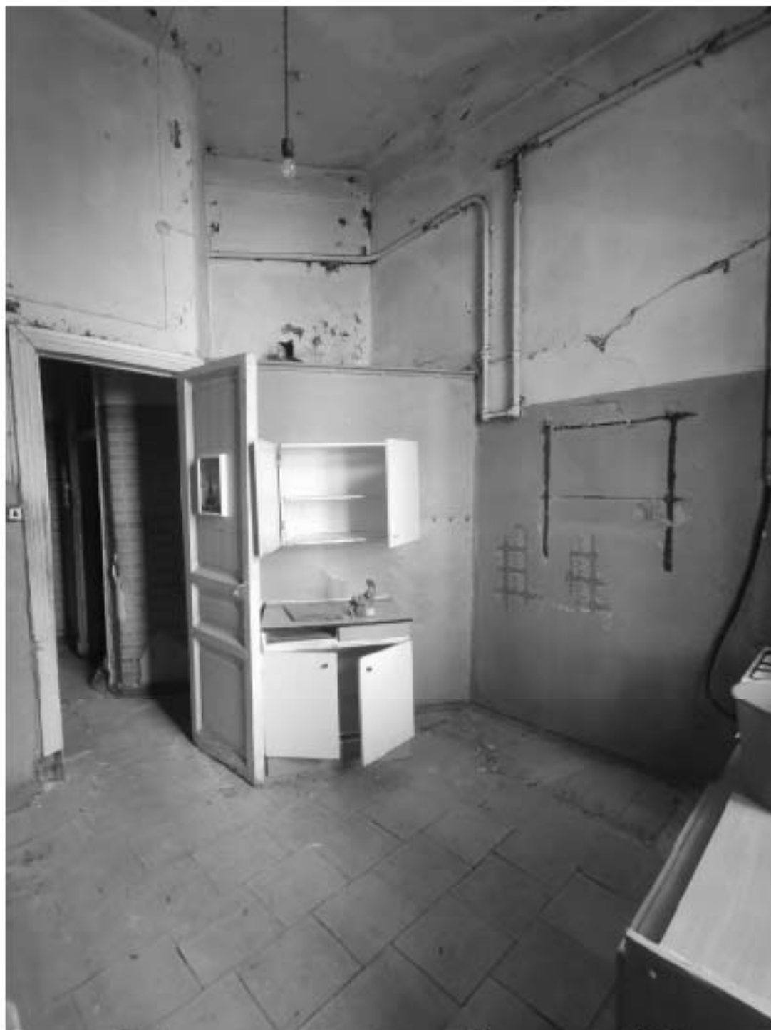
8. Фрагмент интерьера кухни (помещение 3/10.3);
