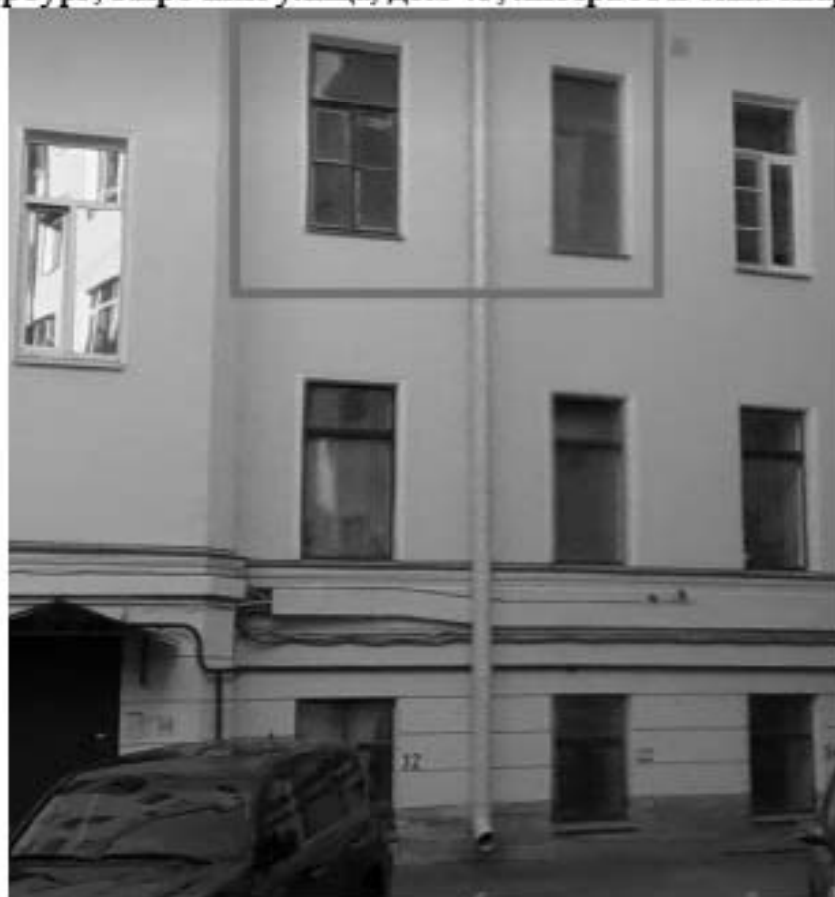
3. Фрагмент фасада объекта культурного наследия регионального значения «Дом А.И. Шульгина», расположенного по адресу: г. Санкт-Петербург, Кирочная улица, дом 45, литера А и окна квартиры №53;
