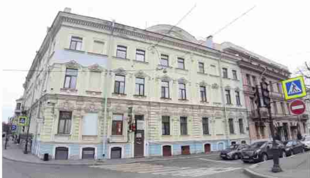
5. Дом А.П. Козлова (Большая Морская ул., д. 56, лит. А). Лицевой фасад по наб реки Мойки. Фото мест установки оборудования и кабельных трасс. Штиглиц М.С. 07.05.2024.
