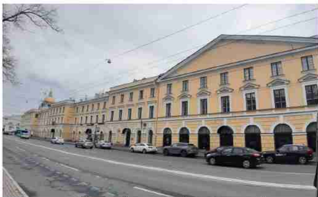
34. Казармы (Трехэскадронный корпус) (в составе «Манеж и казармы Конногвардейского полка») (Конногвардейский бульвар, д. 4, лит. А). Лицевой фасад (фрагмент) по Конногвардейскому бульвару. Штиглиц М.С. 07.05.2024.
