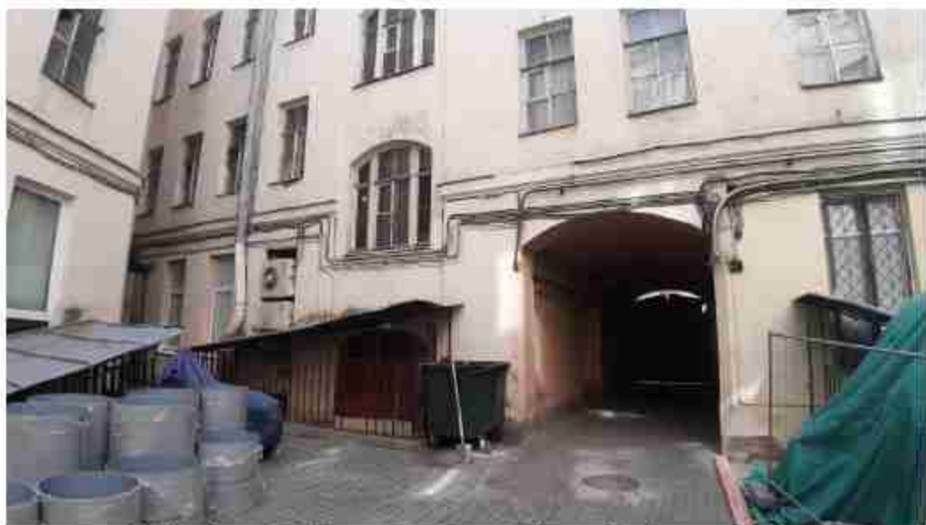
62. Дом Разевиха (Вознесенский пр., д. 28, лит. А). Дворовый фасад. Фото мест установки оборудования и кабельных трасс. Штиглиц М.С. 07.05.2024.
