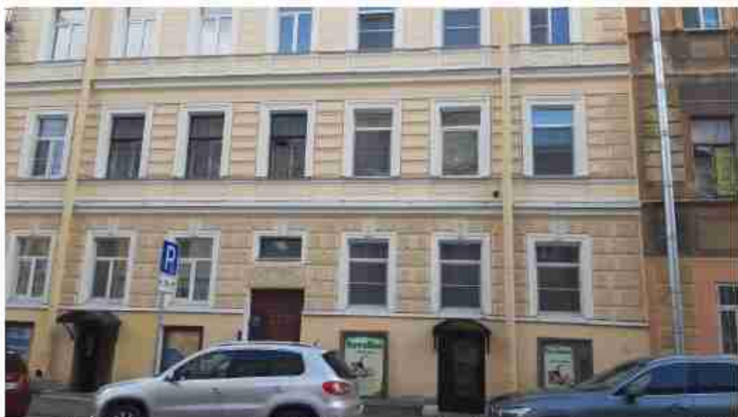
27. Особняк и доходный дом Н.Г. Кудрявцева. (4-я Красноармейская улица, д. 12/11, лит. А). Лицевой фасад (фрагмент). Фото мест установки оборудования и кабельных трасс. Штиглиц М.С. 07.05.2024.
