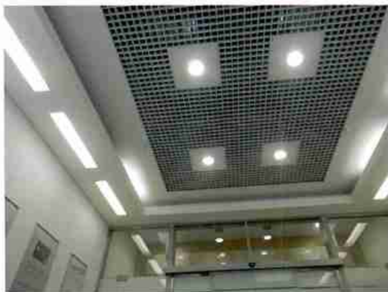
Фото №12. Перекрытие туббура 1-го этажа.
