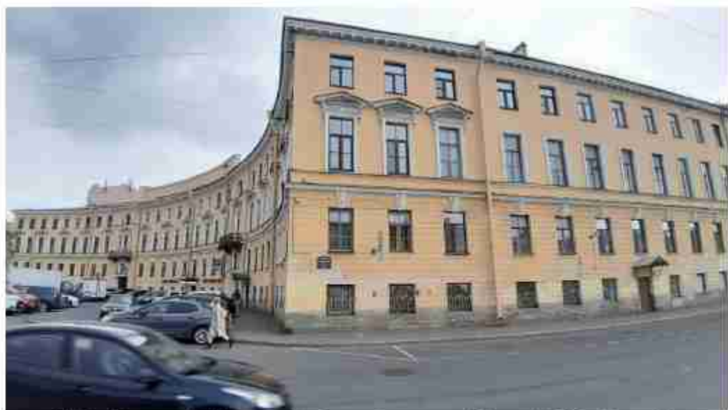
38. Дом Устинова К. (Петровых). (наб. реки Фонтанки, д. 92, лит. А). Общий вид. Штиглиц М.С. 07.05.2024.
