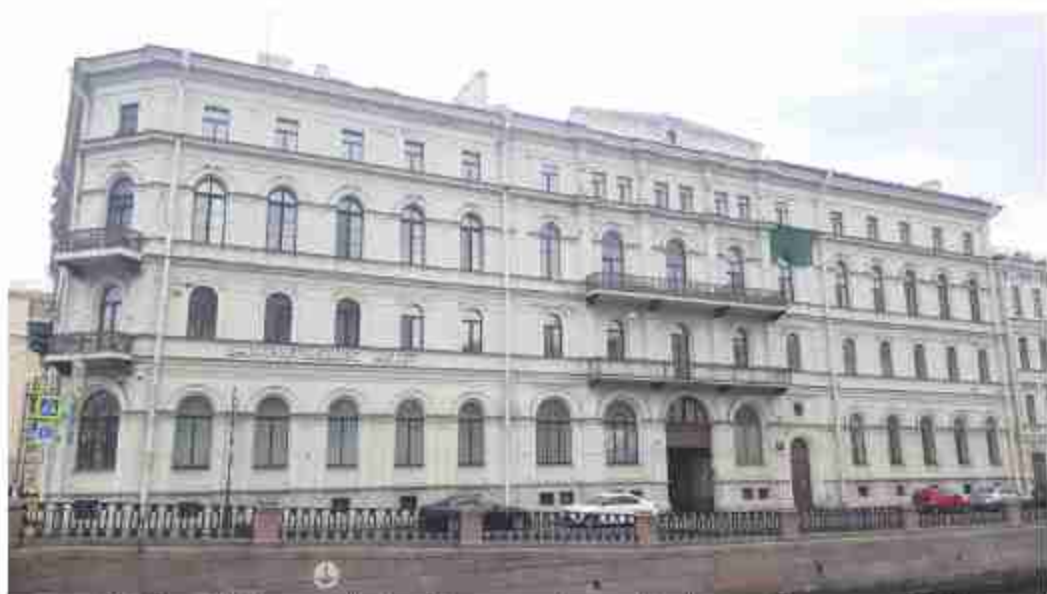
20. Дом А.Б.Фитингофа. (ул. Глики, д. 1, лит. А). Лицевой фасад по наб. Крюкова канала. Штиглиц М.С. 07.05.2024.
