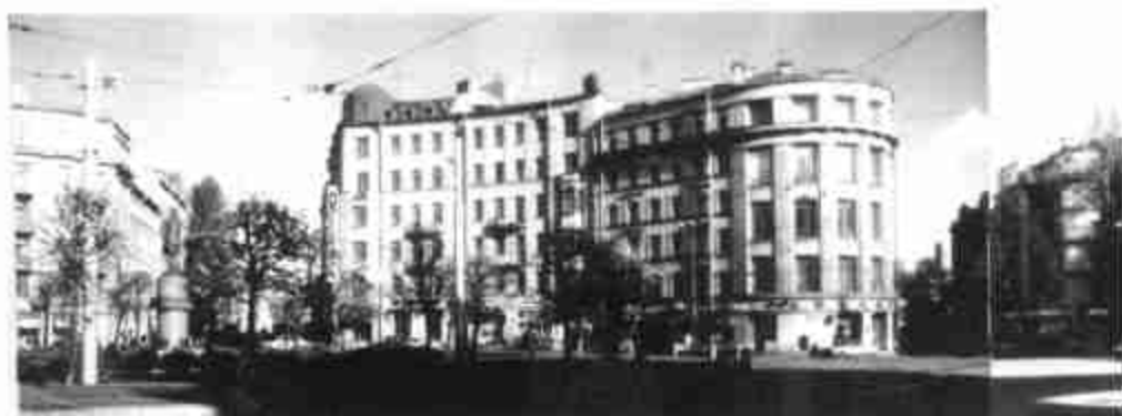
46. «Ансамбль жилых домов площади Стачек (3 здания)». Перекопская ул., д. 1, лит. А. Фото 1999 г. (23).
