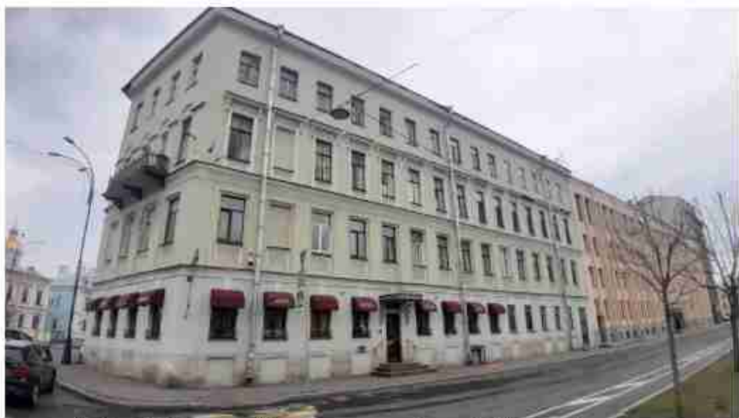
15. Дом Ф. Моровица, (Никольская пл., д. 6, лит. А). Лицевой фасад по наб. канала Грибоедова. Фото мест установки оборудования и кабельных трасс. Штиглиц М.С. 07.05.2024.
