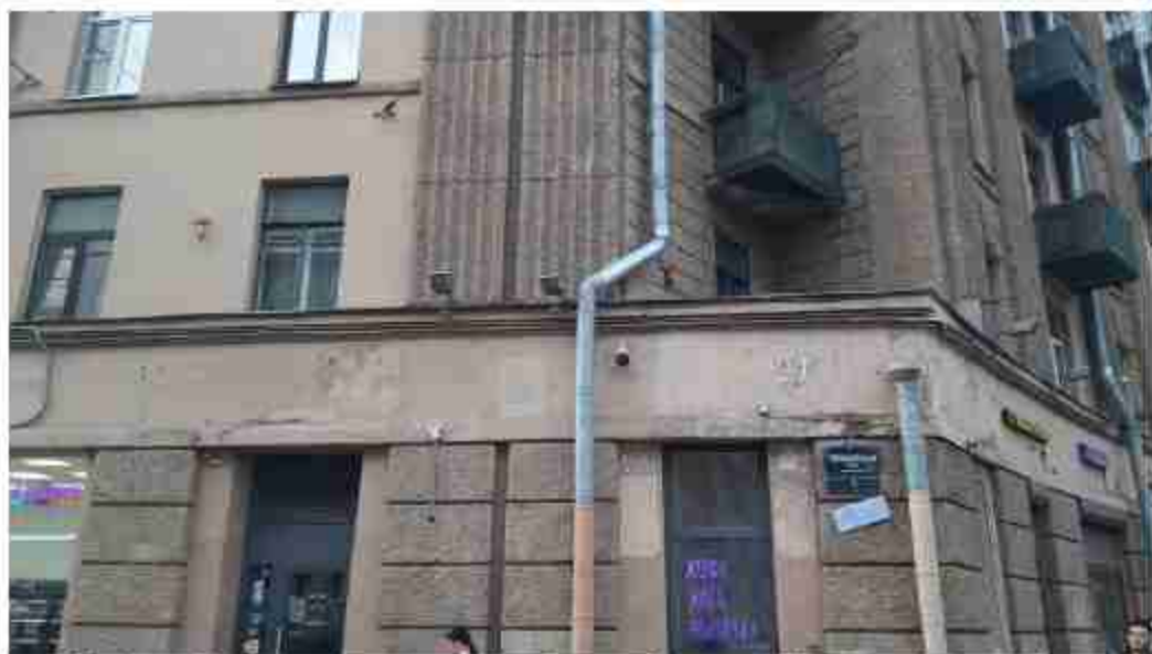
52. Ансамбль жилых домов площади Стачек (3 здания) (Перекопская ул., д. 1, лит. А). Лицевой фасад (фрагмент). Фото мест установки оборудования и кабельных трасс: Штиглиц М.С. 07.05.2024.
