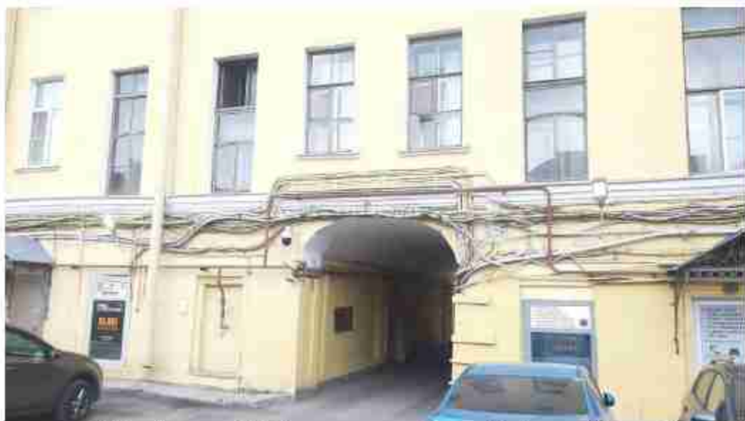
69. Дом Яковлева С.Я. (Гороховая ул., д. 45, лит. А). Дворовый фасад. Фото мест установки оборудования и кабельных трасс. Штиглиц М.С. 07.05.2024.
