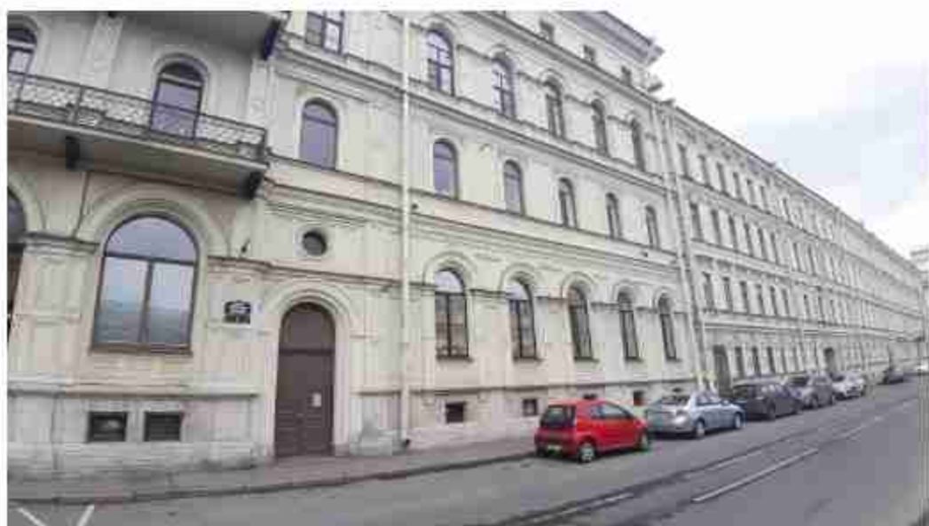
23. Дом А.Б.Фитингофа. (ул. Глинки, д. 1, лит. А). Лицевой фасад (фрагмент). Фото мест установки оборудования и кабельных трасс. Штиглиц М.С. 07.05.2024.
