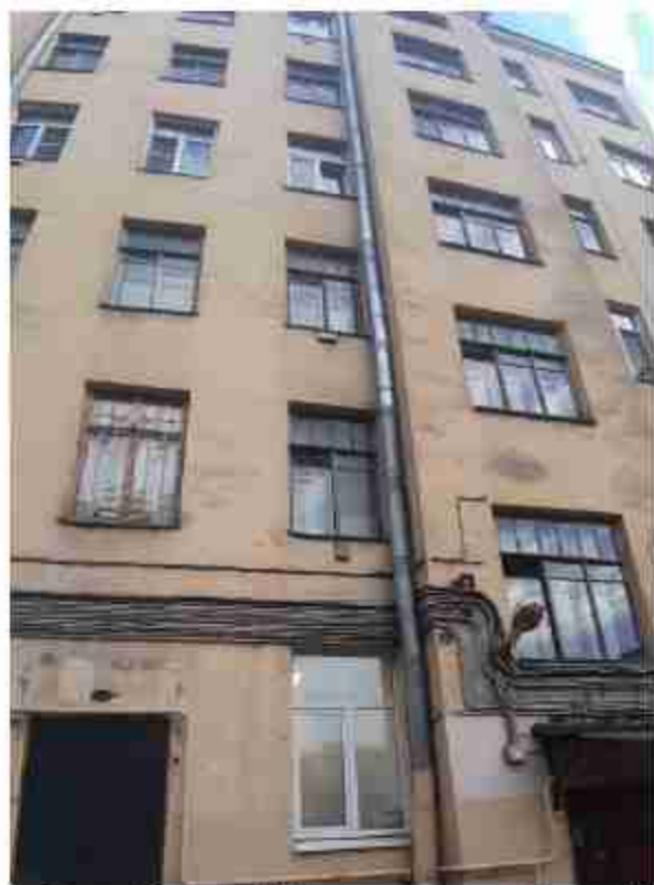
57. Ансамбль жилых домов площади Стачек (3 здания) (Перекопская ул., д. 1, лит. А). Дворовые фасады. Фото мест установки оборудования и кабельных трасс. Штиглиц М.С. 07.05.2024.
