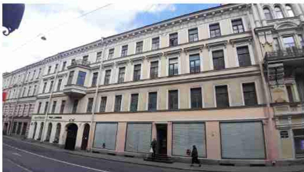
59. Дом Разевича (Вознесенский пр., д. 28, лит. А). Лицевой фасад. Штиглиц М.С. 07.05.2024.
