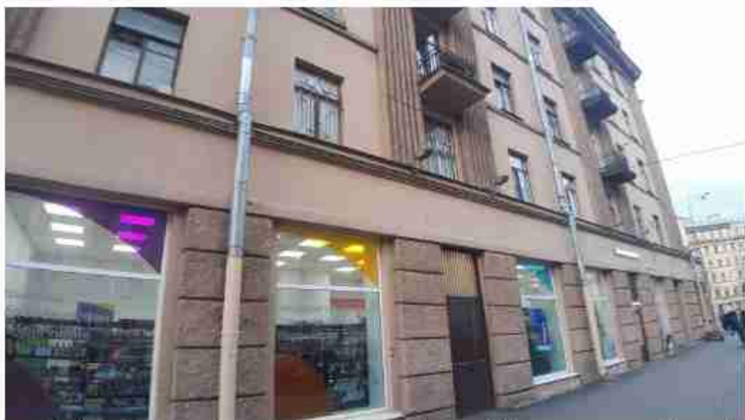
54. Ансамбль жилых домов площади Стачек (3 здания) (Перекопская ул., д. 1, лит. А). Лицевой фасад (фрагмент). Фото мест установки оборудования и кабельных трасс. Штиглиц М.С. 07.05.2024.
