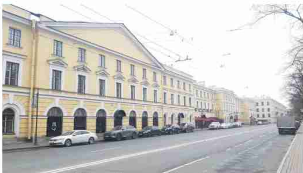
33. Казармы (Трехэскадронный корпус) (в составе «Манеж и казармы Конногвардейского полка») (Конногвардейский бульвар, д. 4, лит. А). Лицевой фасад (фрагмент) по Конногвардейскому бульвару. Штиглиц М.С. 07.05.2024.
