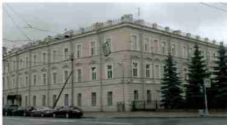
Фото №5. Лицевая фасада. Вид со стороны Загородного проспекта.
