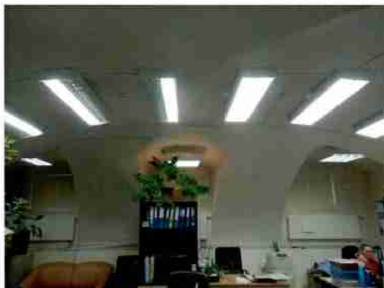
Фото №8. Складные перекрытия цокольного этажа.
