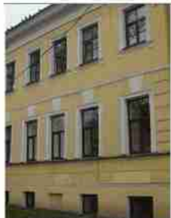
фрагмент лицевого фасада
