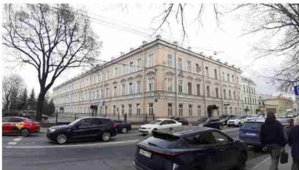
47. Офицерская казарма (в составе «Комплекса казарм Семеновского и Егерского полков»). (Загородный пр., д. 54, лит. А). Общий вид. Штиглиц М.С. 07.05.2024.
