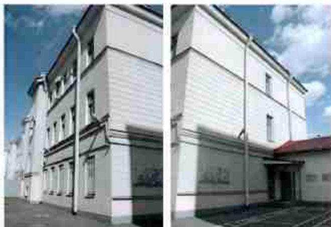
Фото №17. З. Дворовые фасады.
