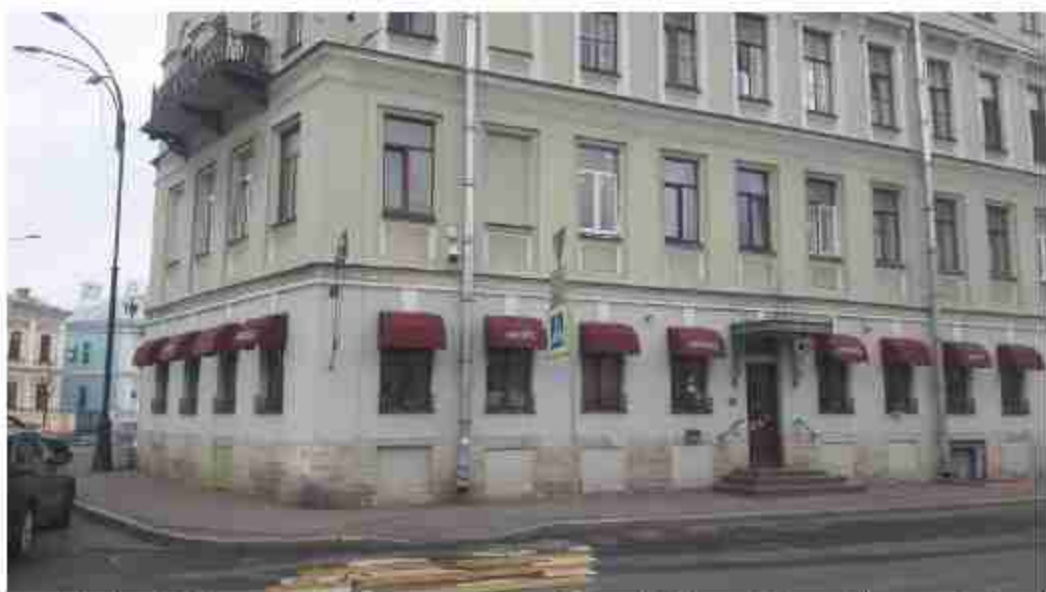
16. Дом Ф. Моровица, (Никольская пл., д. 6, лит. А). Лицевой фасад (фрагмент). Фото мест установки оборудования и кабельных трасс. Штиглиц М.С. 07.05.2024.
