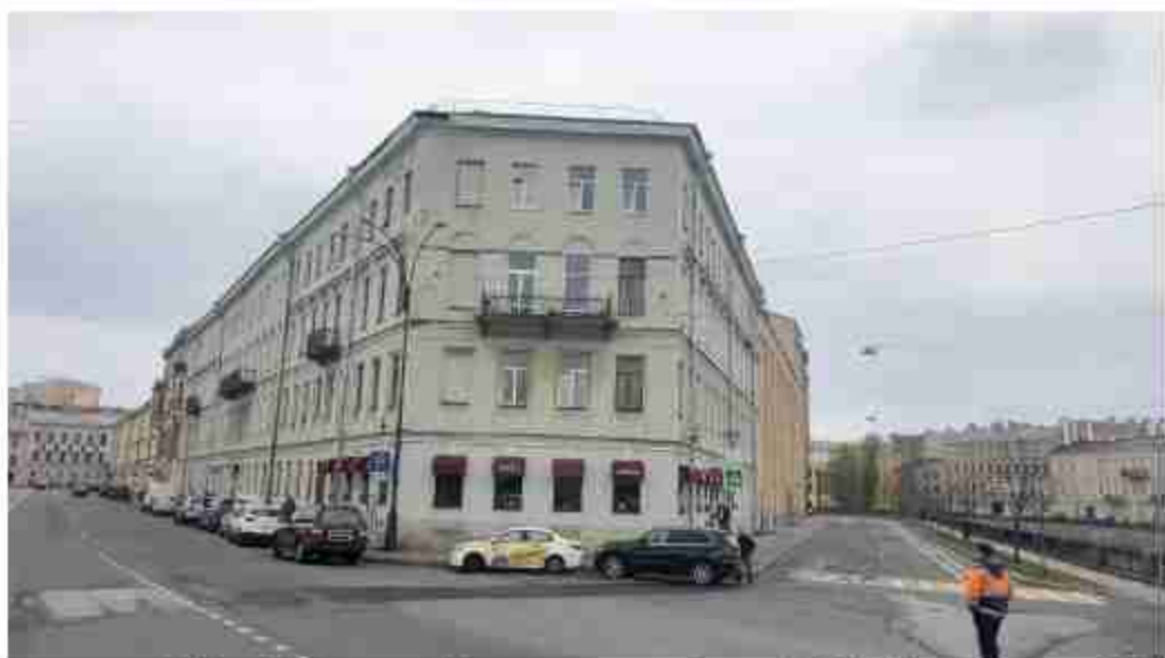
14. Дом Ф. Моровица. (Никольская пл., д. 6, лит. А). Общий вид. Штиглиц М.С. 07.05.2024.
