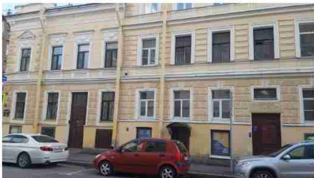
28. Особняк и доходный дом Н.Г. Кудрявцева. (4-я Красноармейская улица, д. 12/11, лит. А). Лицевой фасад (фрагмент). Фото мест установки оборудования и кабельных трасс. Штиглиц М.С. 07.05.2024.
