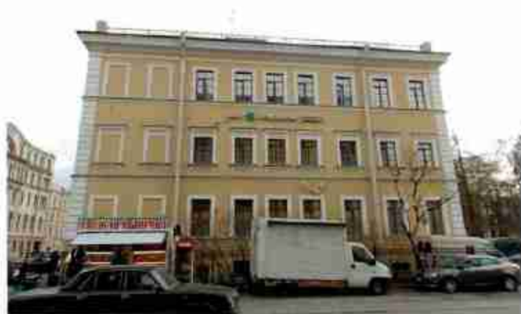
Фото №6. Террасной (северо-западный) фасад.
