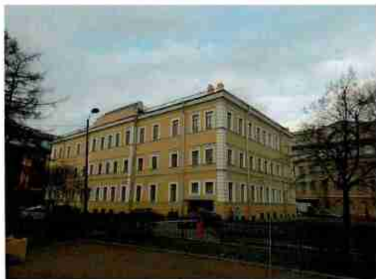
Фото №6. Дворовой и торцевой (юго-восточный) фасады. Вид со стороны сада Театра юных зрителей.
