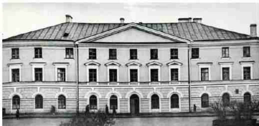
34. «Казармы (Трехэскадронный корпус)» (в составе «Манеж и казармы Конногвардейского полка») (Конногвардейский бульвар, д. 4, лит. А). 1910-е гг. (30).
