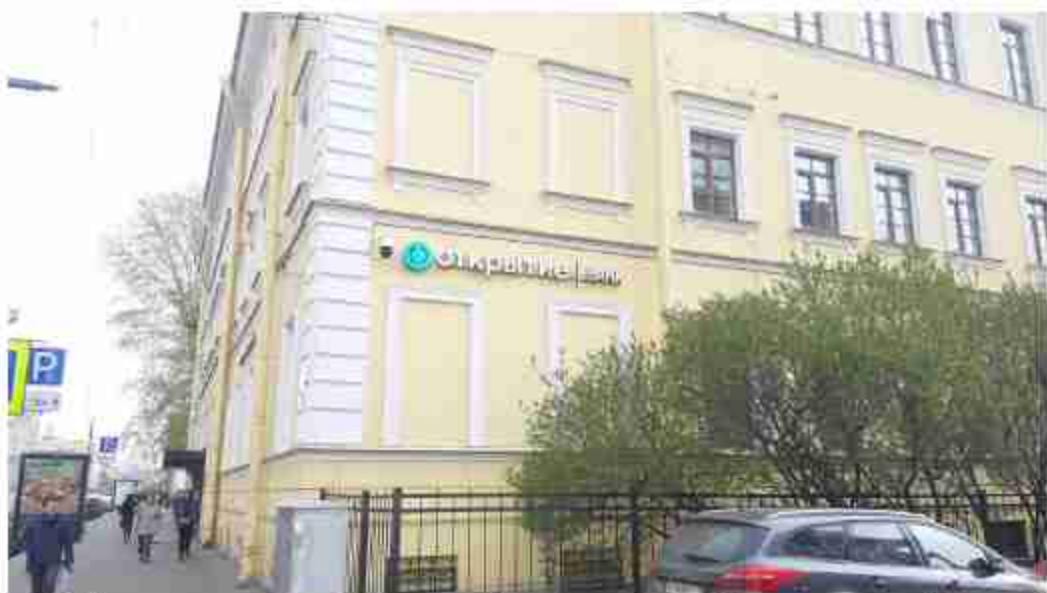
45. Солдатская казарма (в составе «Комплекса казарм Семеновского и Егерского полков»). (Звенигородская ул., д. 3, лит. А). Лицевой фасад (фрагмент). Фото мест установки оборудования и кабельных трасс. Штиглиц М.С. 07.05.2024.
