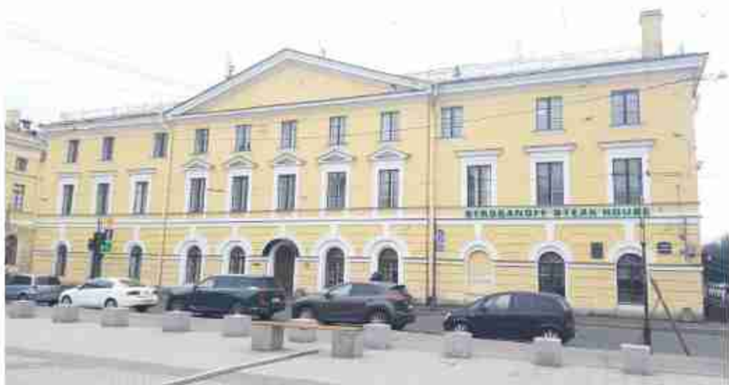
31. Казармы (Трехэскадронный корпус) (в составе «Манеж и казармы Конногвардейского полка») (Конногвардейский бульвар, д. 4, лит. А). Лицевой фасад по Почтамтскому пер. Штиглиц М.С. 07.05.2024.
