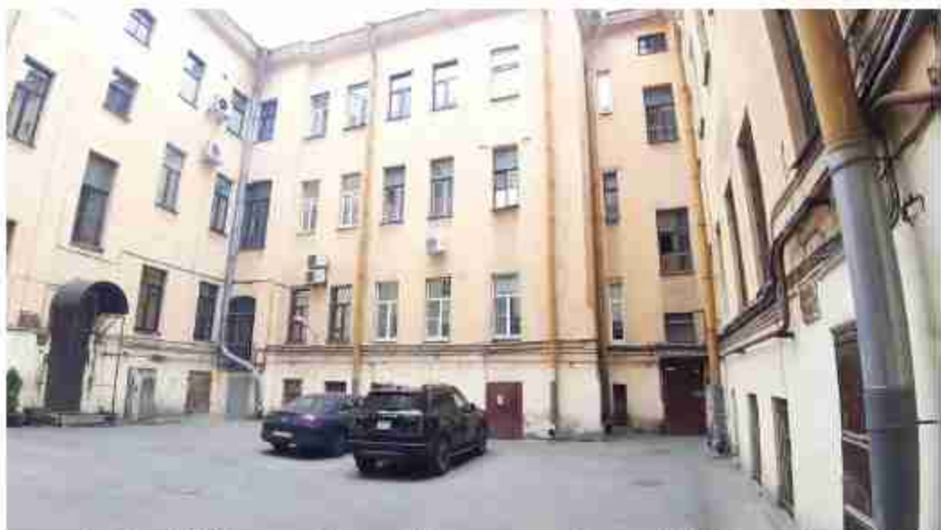
6. Дом А.П. Козлова (Большая Морская ул., д. 56, лит. А). Дворовые фасады. Фото мест установки оборудования и кабельных трасс. Штиглиц М.С. 07.05.2024.
