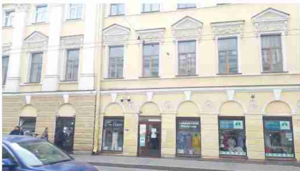
68. Дом Яковлева С.Я. (Гороховая ул., д. 45, лит. А). Лицевой фасад по Гороховой ул. Фото мест установки оборудования и кабельных трасс. Штиглиц М.С. 07.05.2024.
