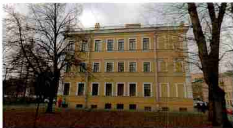
Фото №5. Торцевой (юго-восточный) фасад.
