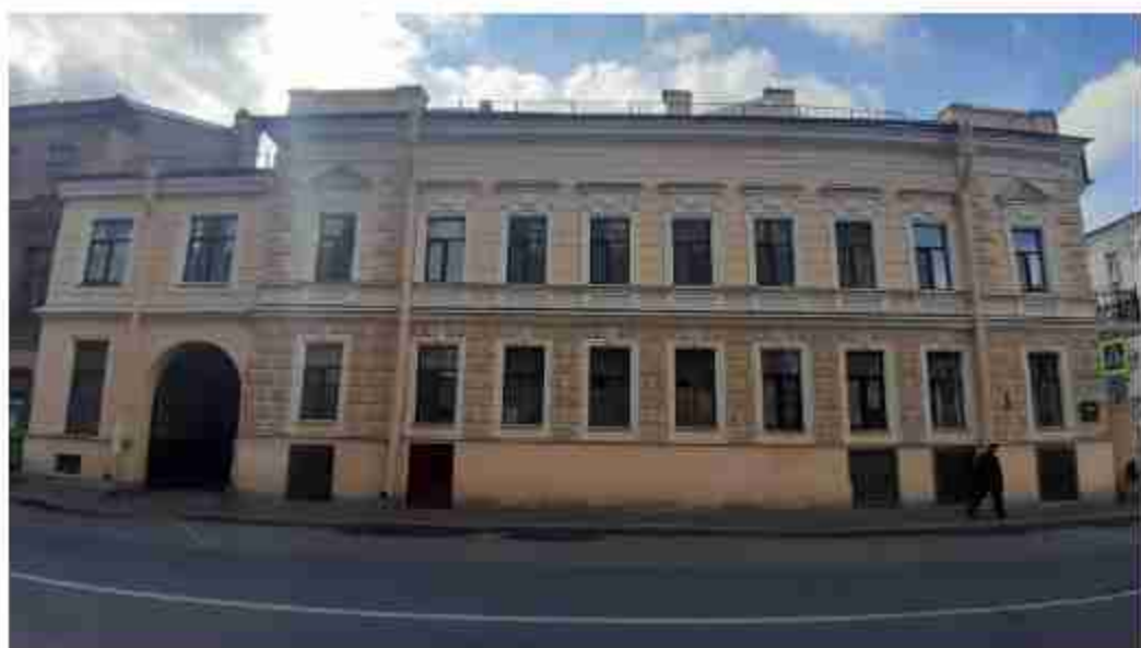
25. Особняк и доходный дом Н.Г. Кудрянцева. (4-я Красноармейская улица, д. 12/11, лит. А). Лицевой фасад по ул. Егорова. Штиглиц М.С. 07.05.2024.
