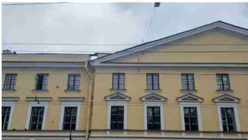
35. Казармы (Трехэскадронный корпус) (в составе «Манеж и казармы Конногвардейского полка») (Конногвардейский бульвар, д. 4, лит. А). Лицевой фасад (фрагмент). Фото мест установки оборудования и кабельных трасс. Штиглиц М.С. 07.05.2024.
