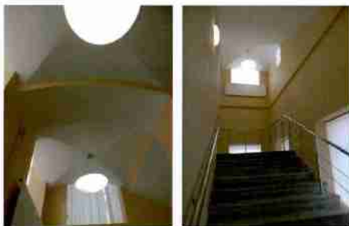
Фото №7. В. Складные перекрытия лестниц и лестничной марши.
