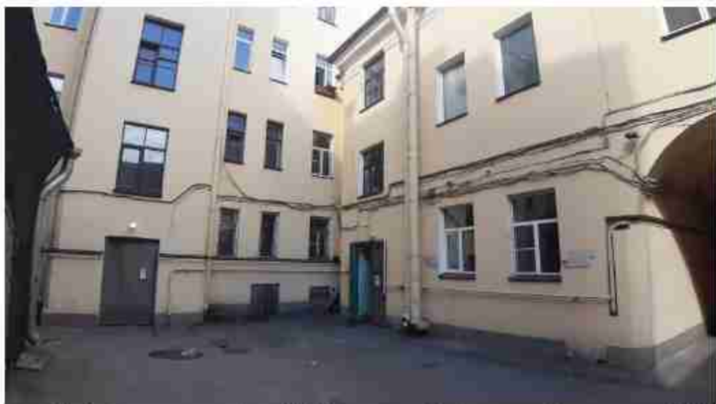
30. Особняк и доходный дом Н.Г. Кудрянцева. (4-я Красноармейская улица, д. 12/11, лит. А). Дворовые фасады. Фото мест установки оборудования и кабельных трасс. Штиглиц М.С. 07.05.2024.
