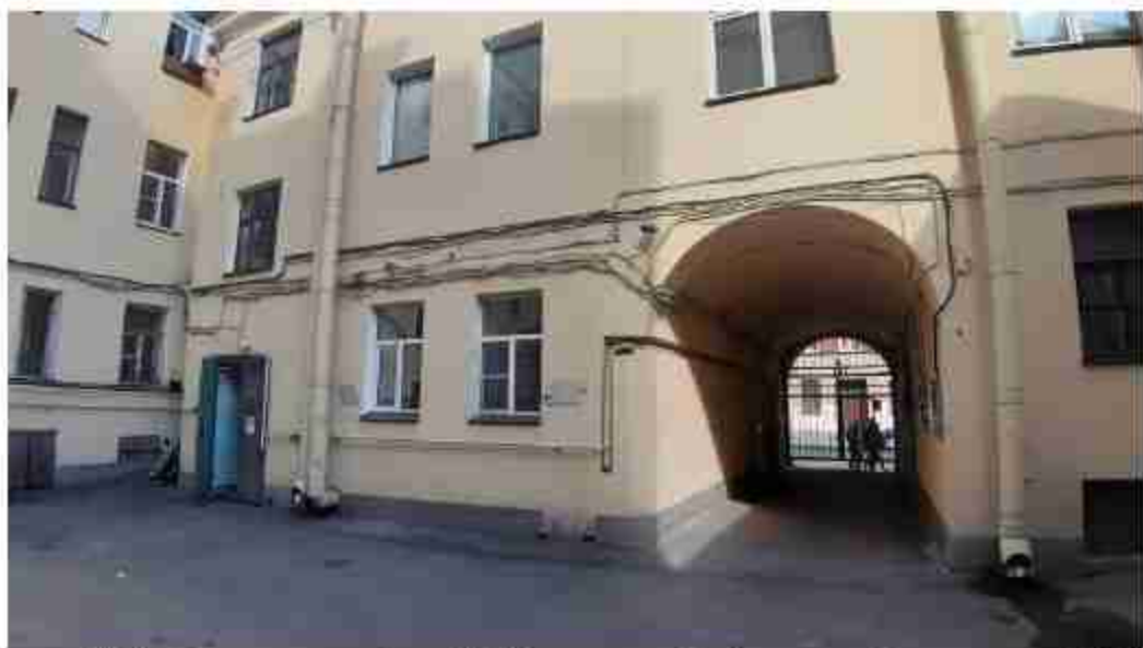
29. Особняк и доходный дом Н.Г. Кудрянцева. (4-я Красноармейская улица, д. 12/11, лит. А). Дворовые фасады. Фото мест установки оборудования и кабельных трасс. Штиглиц М.С. 07.05.2024.
