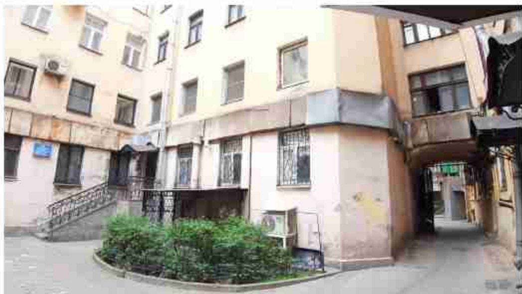
18. Дом Демидовых (А.М. Ушакова) (Малая Садовая ул., д. 3/54, лит. А). Дворовый фасад. Фото мест установки оборудования и кабельных трасс. Штиглиц М.С. 07.05.2024.
