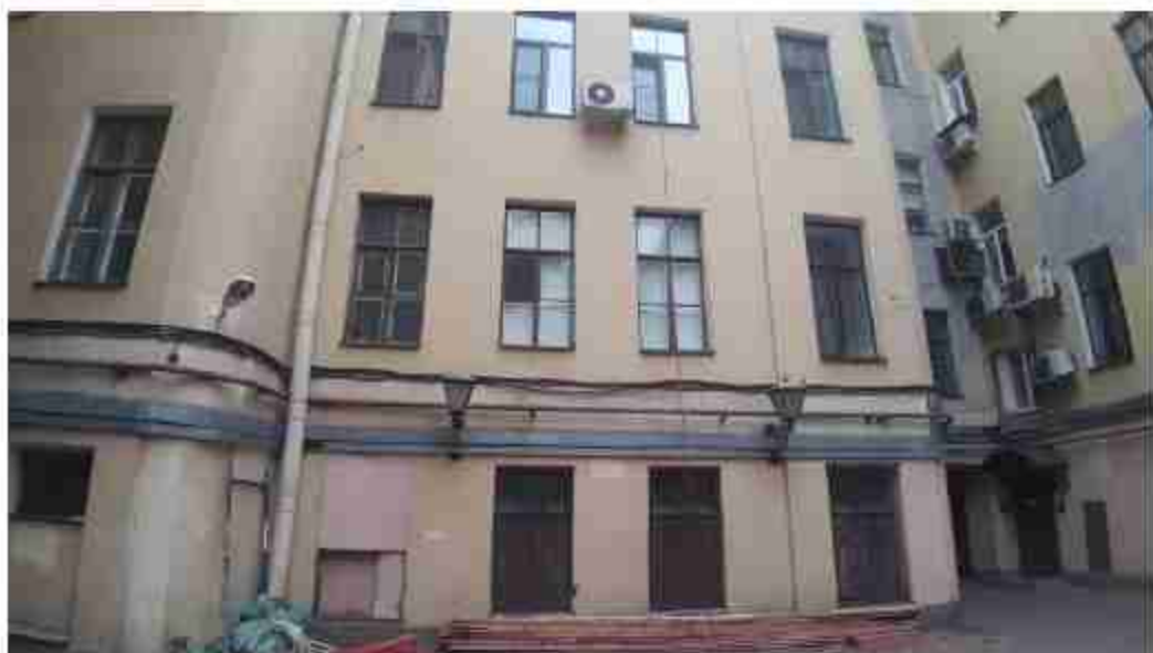
63. Дом П.Д. Мальцова (Пушкинская ул., д. 2/79, лит. А). Дворовый фасад. Фото мест установки оборудования и кабельных трасс. Штиглиц М.С. 07.05.2024.
