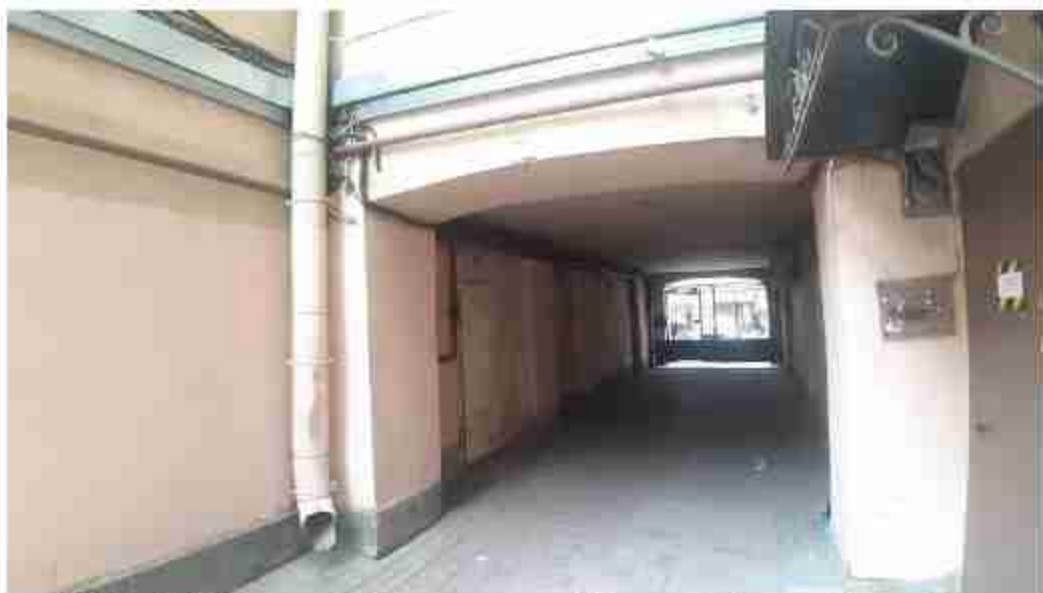
65. Дом П.Д. Мальцова (Пушкинская ул., д. 2/79, лит. А). Дворовый фасад. Фото мест установки оборудования и кабельных трасс. Штиглиц М.С. 07.05.2024.
