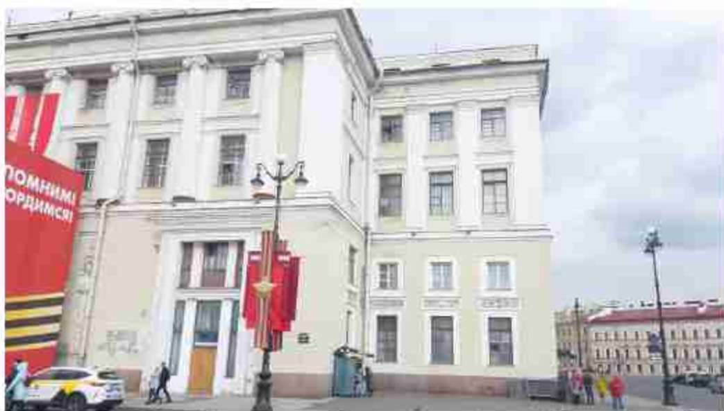
4. Штаб Гвардейского корпуса (Дворцовая пл., д. 4, лит. А). Лицевой фасад. Фото мест установки оборудования и кабельных трасс. Штиглиц М.С. 07.05.2024.
