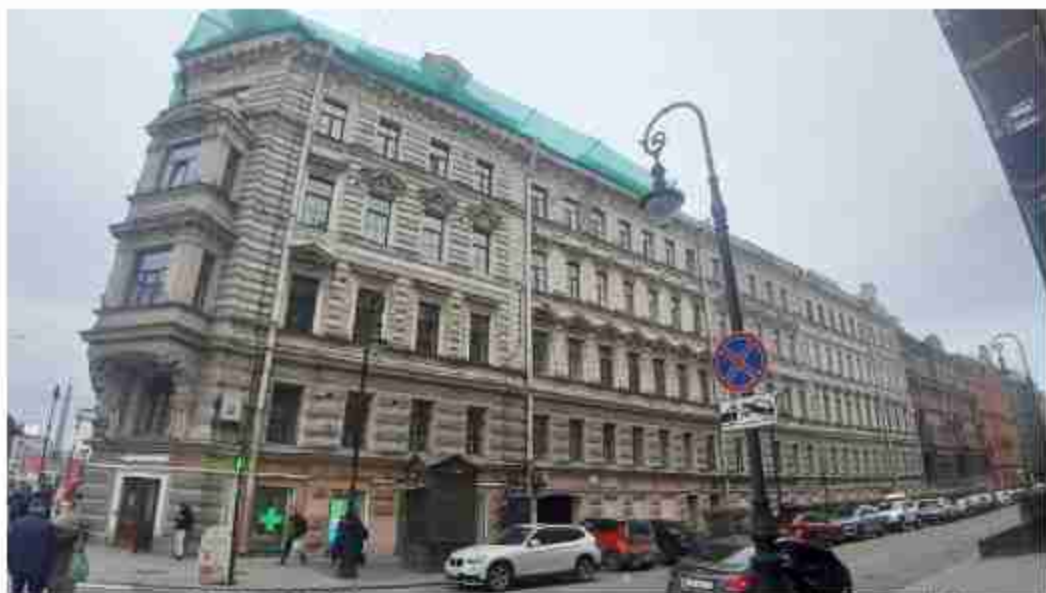
60. Дом П.Д. Мальцова (Пушкинская ул., д. 2/79, лит. А). Лицевой фасад по Пушкинской ул. Штиглиц М.С. 07.05.2024.
