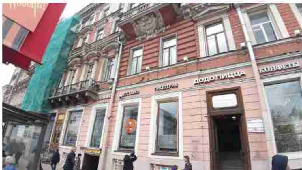
14. Дом Демидовых (А.М. Ушакова) (Малая Садовая ул., д. 3/54, лит. А). Лицевой фасад. Фото мест установки оборудования и кабельных трасс. Штиглиц М.С. 07.05.2024.
