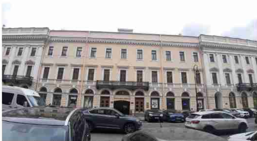
23. Здание Коммунального банка (Невский пр., д. 38/4, лит. А). Лицевой фасад. Штиглиц М.С. 07.05.2024.
