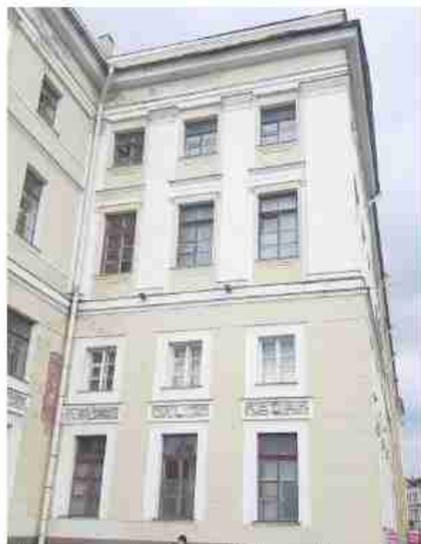
6. Штаб Гвардейского корпуса (Дворцовая пл., д. 4, лит. А). Лицевой фасад. Фото мест установки оборудования и кабельных трасс. Штиглиц М.С. 07.05.2024.
