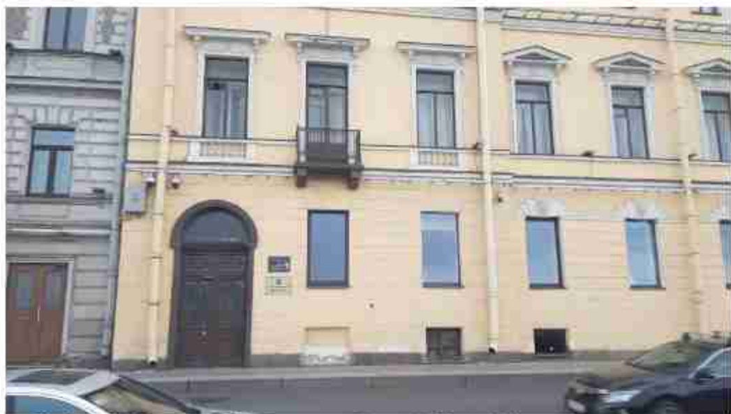
32. Дом С.П. Неклодова (Шпалерная ул., д. 8, лит. А). Лицевой фасад. Фото мест установки оборудования и кабельных трасс. Штиглиц М.С. 07.05.2024.
