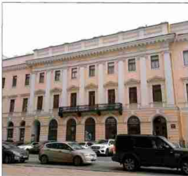
2. Западный фасад. Фрагмент.
