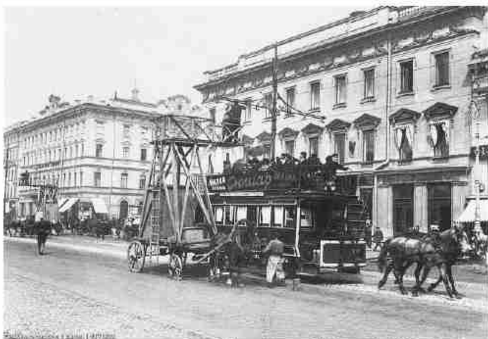
5. Здание Коммунального банка (Невский пр., д. 38/4, лит. А). 1907 г. Установка столбов контактной сети (с сайта pastvu.com).
