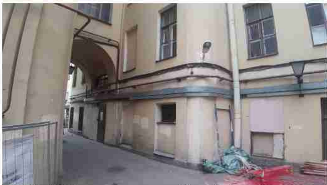
64. Дом П.Д. Мальцова (Пушкинская ул., д. 2/79, лит. А). Дворовый фасад. Фото мест установки оборудования и кабельных трасс. Штиглиц М.С. 07.05.2024.
