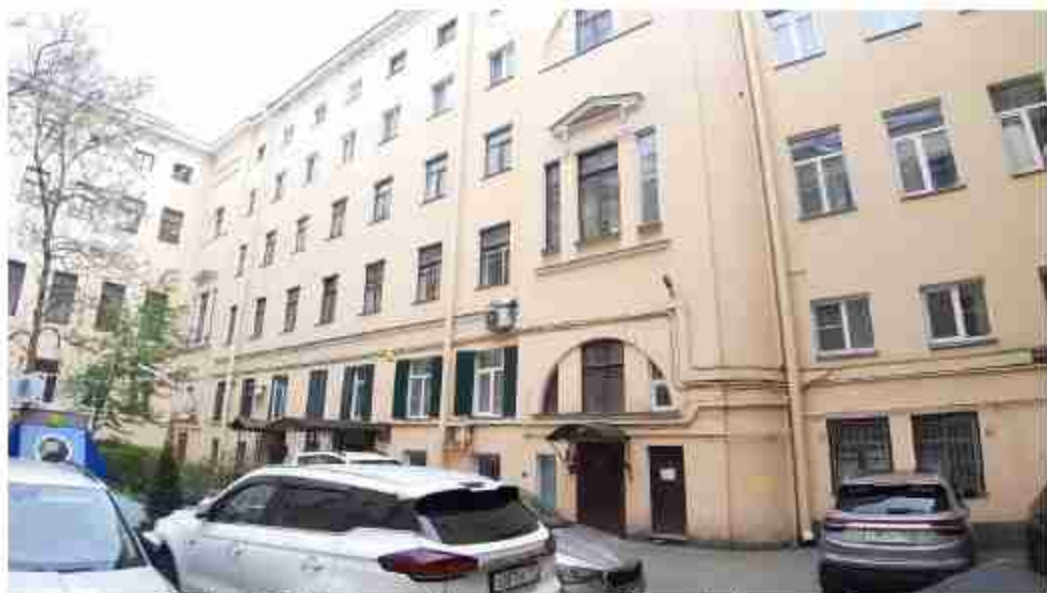
38. Дом С.П. Неклюдова (Шпалерная ул., д. 8, лит. А). Дворовый фасад. Фото мест установки оборудования и кабельных трасс. Штиглиц М.С. 07.05.2024.
