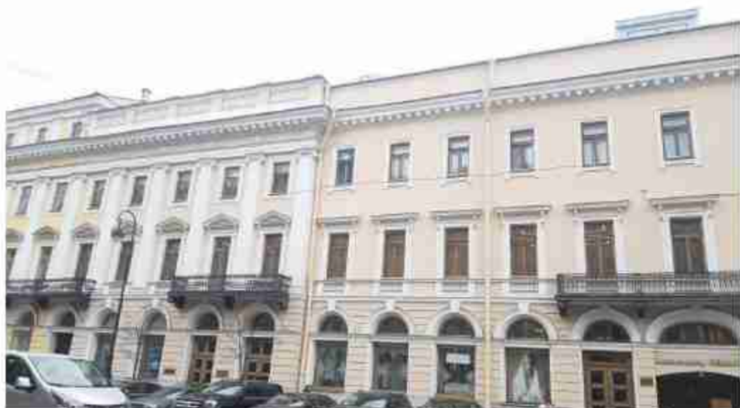
24. Здание Коммунального банка (Невский пр., д. 38/4, лит. А). Лицевой фасад. Фото мест установки оборудования и кабельных трасс. Штиглиц М.С. 07.05.2024.
