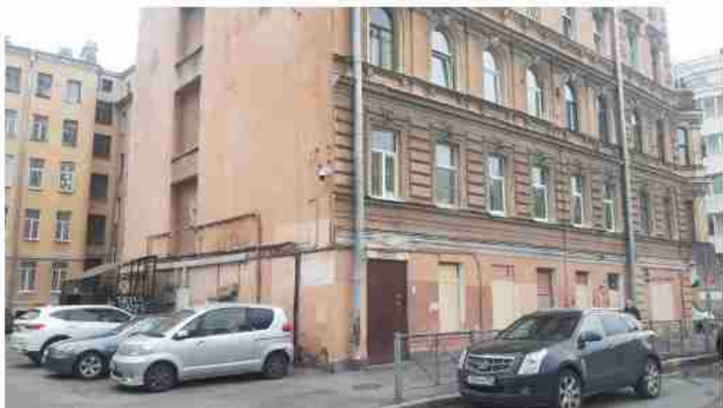
51. Дом, где в ноябре 1905 г. и в 1906 г. жил Ленин В.И. (10-я Советская ул., д. 1-3, лит. А). Лицевой и дворовый фасады. Фото мест установки оборудования и кабельных трасс. Штиглиц М.С. 07.05.2024.
