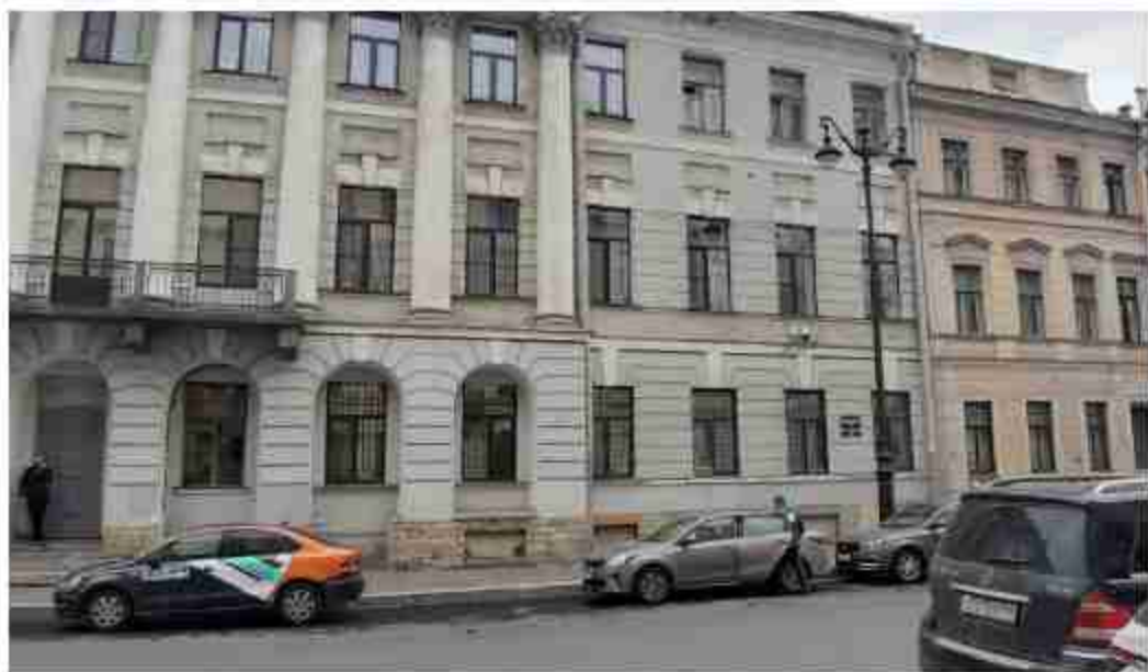
46. Особняк А.И. Эбелинг (Мойки наб. реки, д. 25, лит. А). Лицевой фасад. Фото мест установки оборудования и кабельных трасс. Штиглиц М.С. 07.05.2024.
