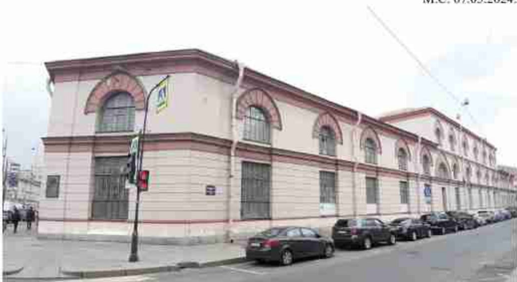
58. Административный корпус» (в составе «Комплекс зданий «Нового Арсенала» (Главного артиллерийского управления и Гильзового отделения Санкт-Петербургского патронного завода)») (Литейный пр., д. 3, лит. А). Лицевой фасад по Шпалерной ул. Фото мест установки оборудования и кабельных трасс. Штиглиц М.С. 07.05.2024.
