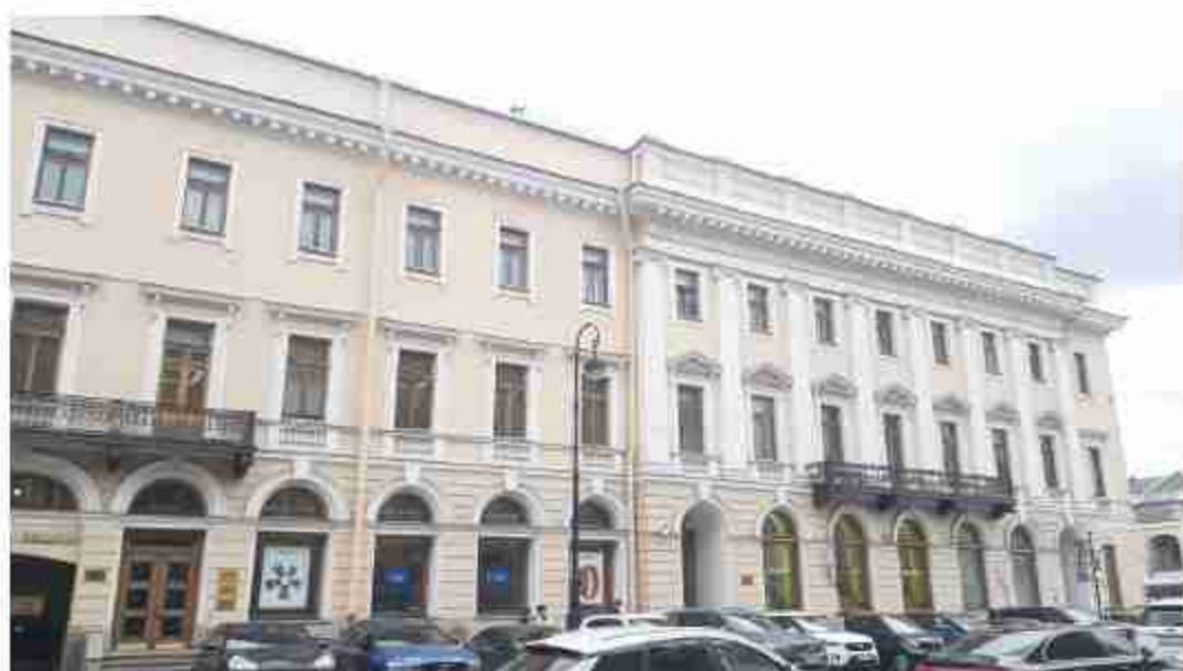
25. Здание Коммунального банка (Невский пр., д. 38/4, лит. А). Лицевой фасад. Фото мест установки оборудования и кабельных трасс. Штиглиц М.С. 07.05.2024.
