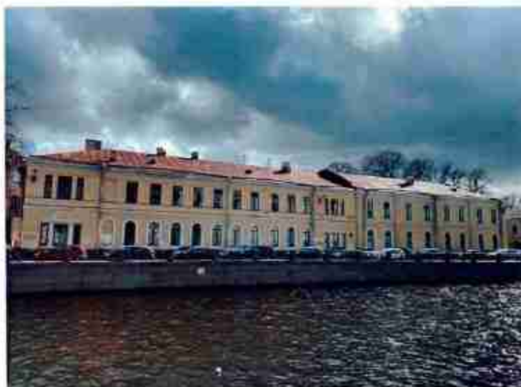
1. Общий вид на объект культурного наследия.
