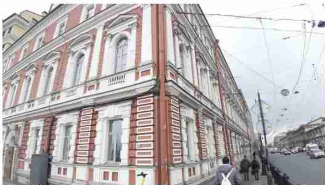
42. Казарма гвардейской конной артиллерии (Шпалерная ул., д. 22, лит. А). Лицевой фасад. Фото мест установки оборудования и кабельных трасс. Штиглиц М.С. 07.05.2024.
