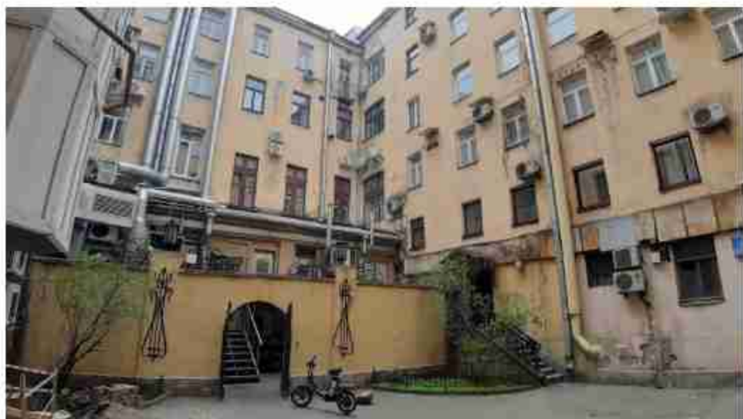
20. Дом Демидовых (А.М. Ушакова) (Малая Садовая ул., д. 3/54, лит. А). Дворовый фасад. Фото мест установки оборудования и кабельных трасс. Штиглиц М.С. 07.05.2024.
