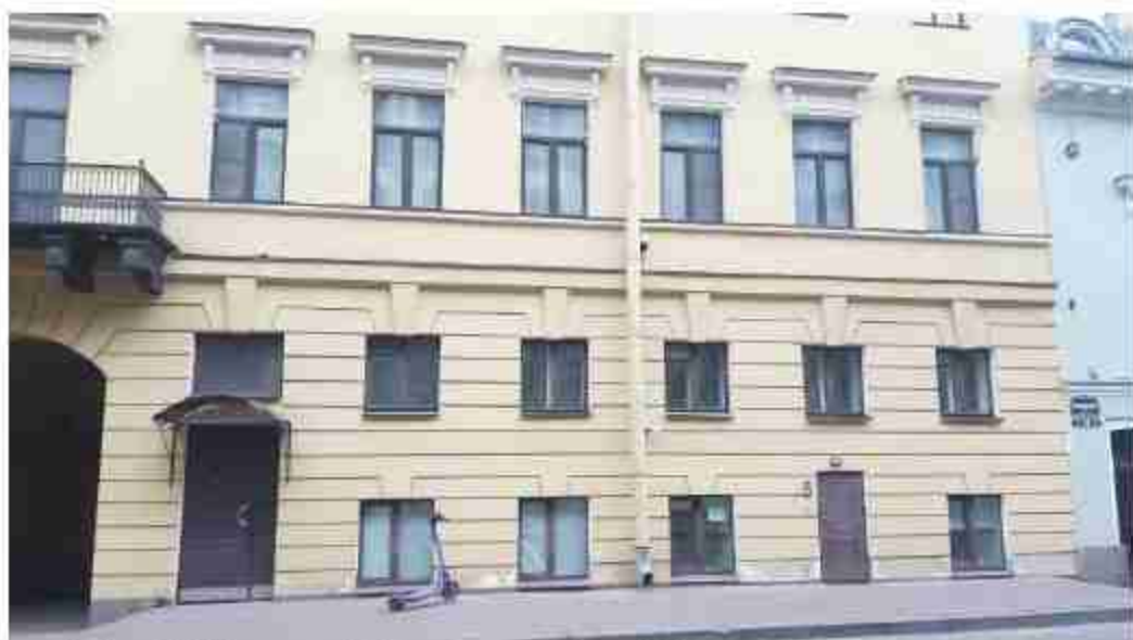
34. Дом С.П. Неклюдова (Шпалерная ул., д. 8, лит. А). Лицевой фасад. Фото мест установки оборудования и кабельных трасс. Штиглиц М.С. 07.05.2024.
