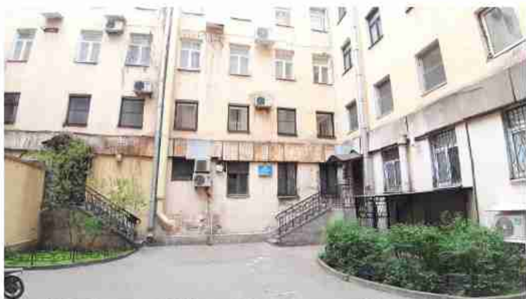
19. Дом Демидовых (А.М. Ушакова) (Малая Садовая ул., д. 3/54, лит. А). Дворовый фасад. Фото мест установки оборудования и кабельных трасс. Штиглиц М.С. 07.05.2024.
