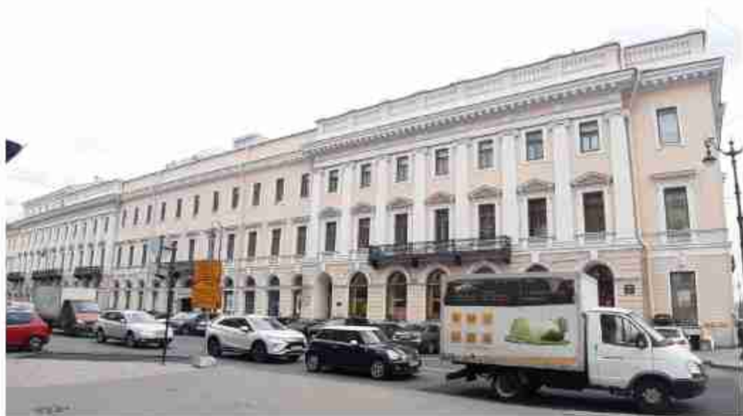
21. Здание Коммунального банка (Невский пр., д. 38/4, лит. А). Лицевой фасад по Михайловской ул. Штиглиц М.С. 07.05.2024.
