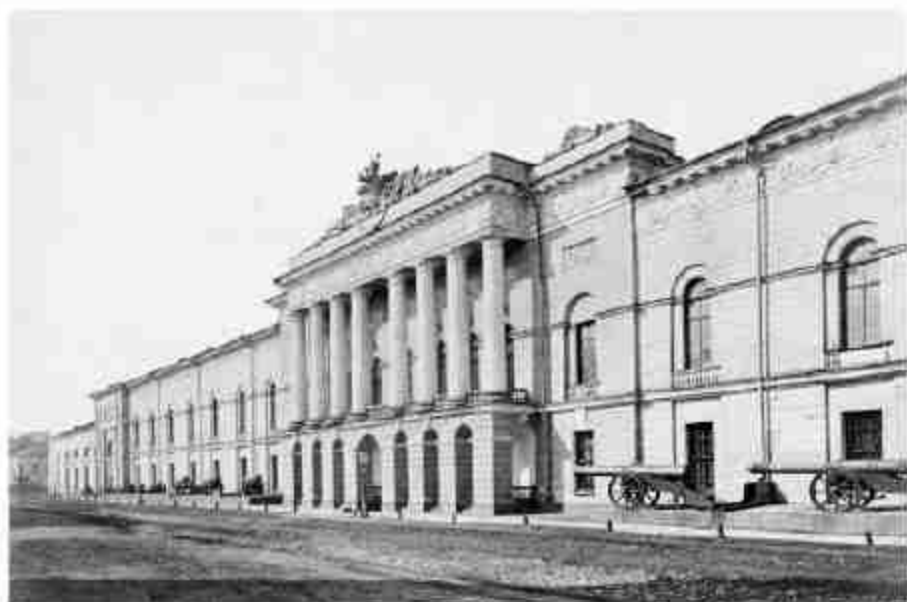
33. Административный корпус» (в составе «Комплекса зданий «Нового Арсенала» (Главного артиллерийского управления и Гильзового отделения Санкт-Петербургского патронного завода)») (Литейный пр., д. 3, лит. А). Арсенал. Конец 19 в. (30).
