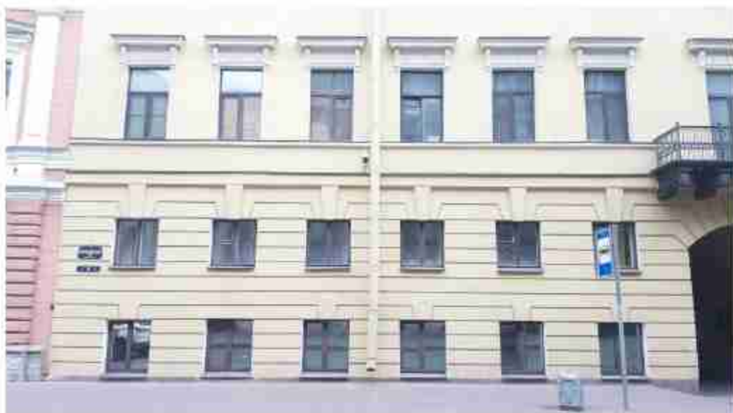
33. Дом С.П. Неклюдова (Шпалерная ул., д. 8, лит. А). Лицевой фасад. Фото мест установки оборудования и кабельных трасс. Штиглиц М.С. 07.05.2024.
