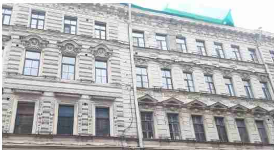
62. Дом П.Д. Мальцова (Пушкинская ул., д. 2/79, лит. А). Лицевой фасад. Фото мест установки оборудования и кабельных трасс. Штиглиц М.С. 07.05.2024.
