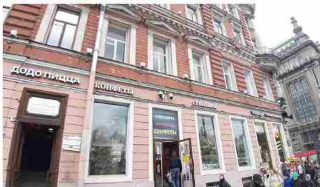
13. Дом Демидовых (А.М. Ушакова) (Малая Садовая ул., д. 3/54, лит. А). Лицевой фасад. Фото мест установки оборудования и кабельных трасс. Штиглиц М.С. 07.05.2024.
