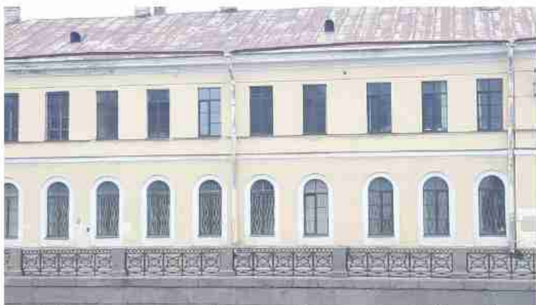
8. Флигель дамский (в составе «Воспитательный дом Императорский») (Мойки наб. реки, д. 48-50-52, лит. А). Лицевой фасад. Фото мест установки оборудования и кабельных трасс. Штиглиц М.С. 07.05.2024.
