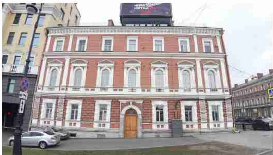
41. Казарма гвардейской конной артиллерии (Шпалерная ул., д. 22, лит. А). Лицевой фасад по Воскресенской наб. Штиглиц М.С. 07.05.2024.
