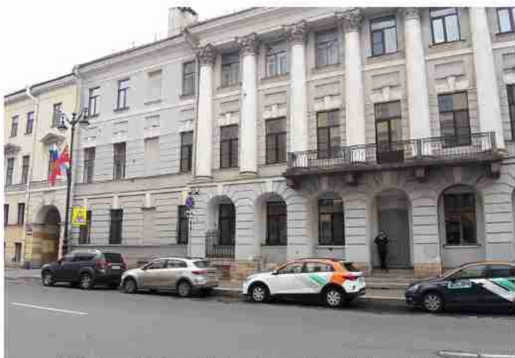
47. Особняк А.И. Эбеллинг (Мойки наб. реки, д. 25, лит. А). Лицевой фасад. Фото мест установки оборудования и кабельных трасс. Штиглиц М.С. 07.05.2024.
