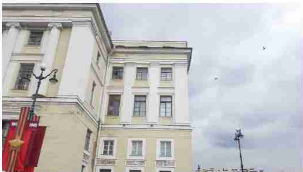
5. Штаб Гвардейского корпуса (Дворцовая пл., д. 4, лит. А). Лицевой фасад. Фото мест установки оборудования и кабельных трасс. Штиглиц М.С. 07.05.2024.
