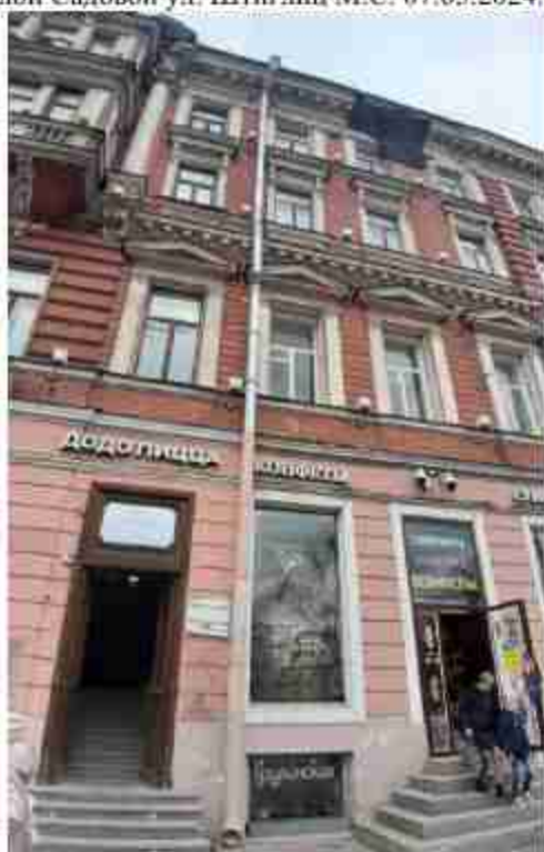
12. Дом Демидовых (А.М. Ушакова) (Малая Садовая ул., д. 3/54, лит. А). Лицевой фасад. Фото мест установки оборудования и кабельных трасс. Штиглиц М.С. 07.05.2024.
