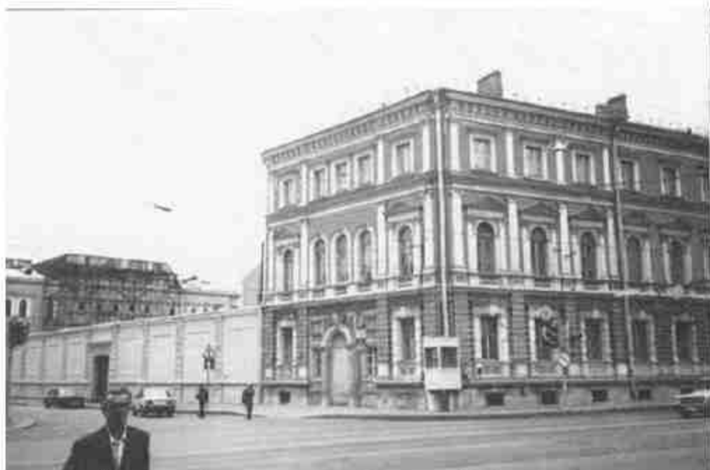
30. Здание офицерских казарм лейб-гвардии 1-й Артиллерийской бригады (с кирпичной оградой). (Литейный пр., д. 1/20, лит. А). Фото 1999 г. (24).
