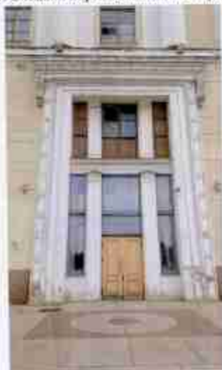
9. Входной портал с западной стороны
