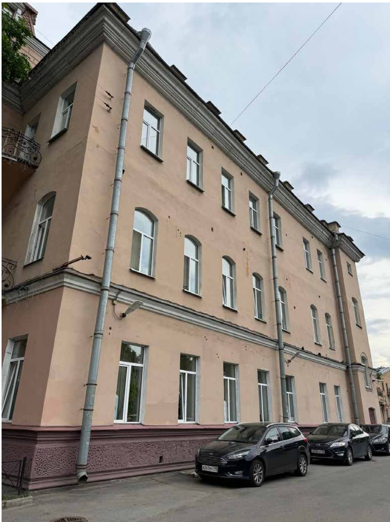
Фото 4. Общий вид восточного фасада объекта культурного наследия.
