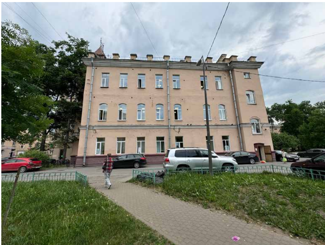
Фото 5. Общий вид восточного фасада объекта культурного наследия.
