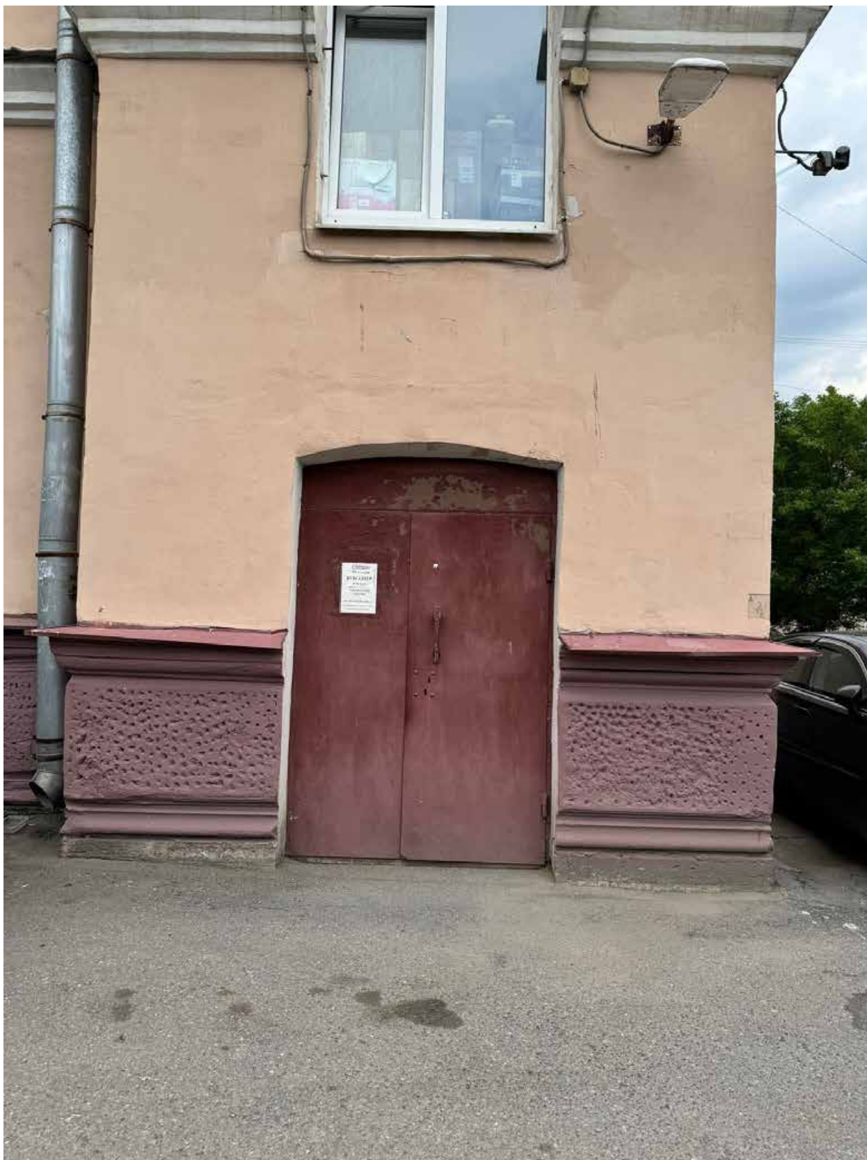
Фото 6. Фрагмент восточного фасада объекта культурного наследия.
