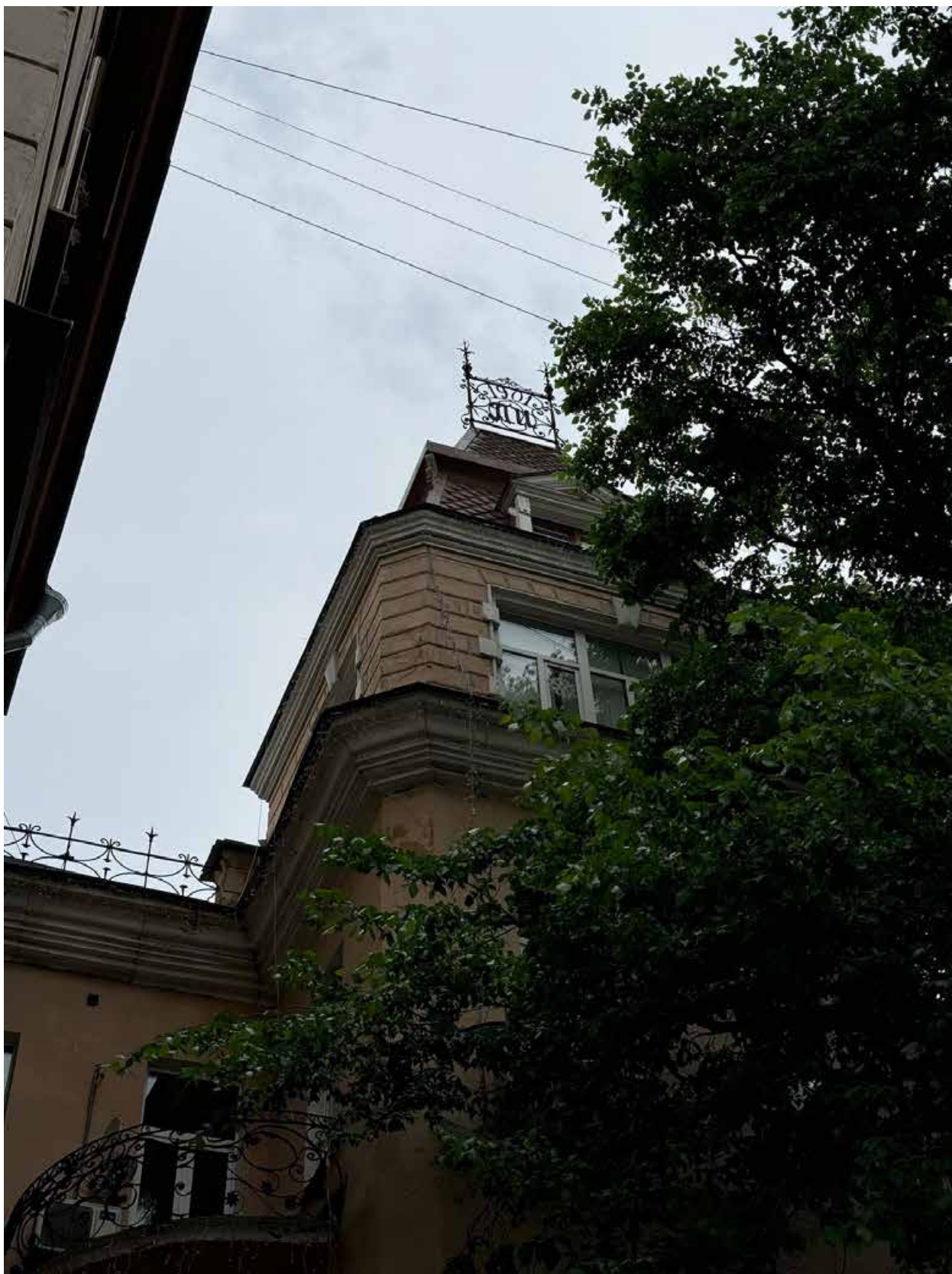
Фото 2. Фрагмент башни со стороны южного лицевого фасада объекта культурного наследия.
