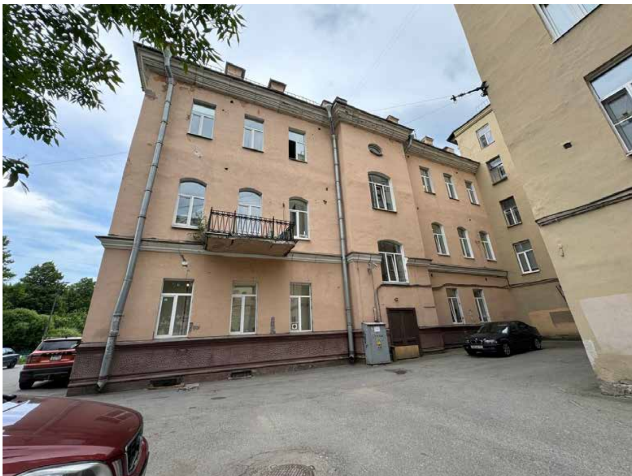
Фото 8. Общий вид западного фасада объекта культурного наследия.
