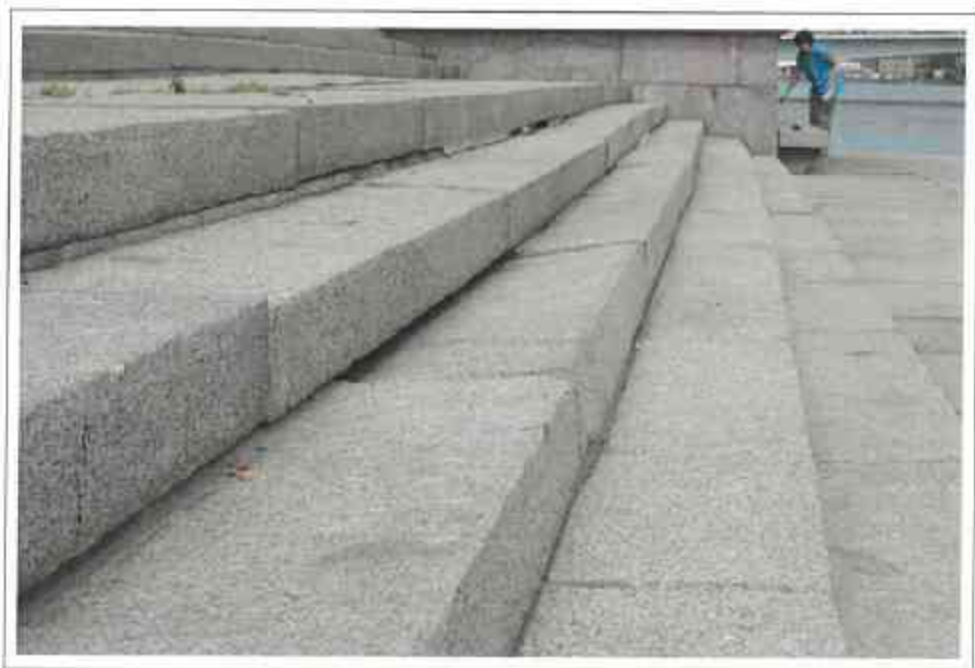
Рис.12. Искривление линий ступеней нижнего марша
