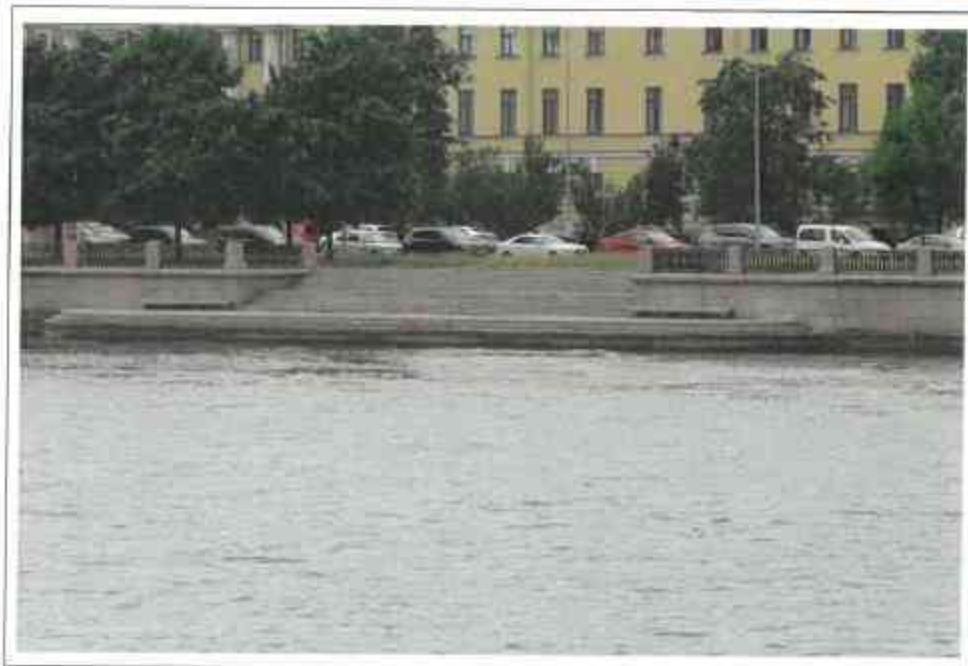
Рис.2. Общий вид сооружения
