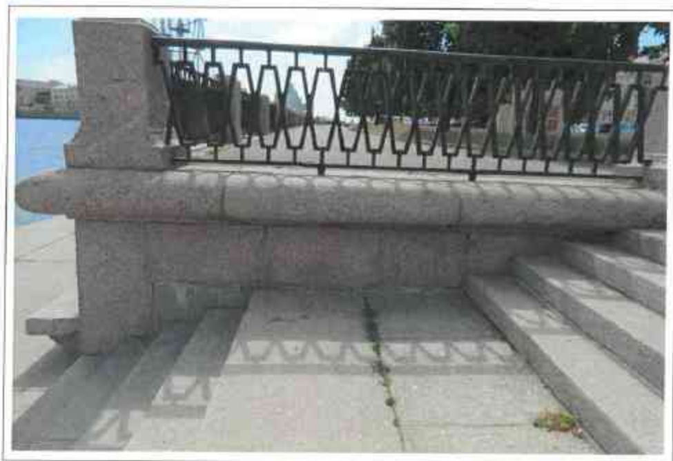
Рис.19. Верховая боковая стенка лестничного спуска
