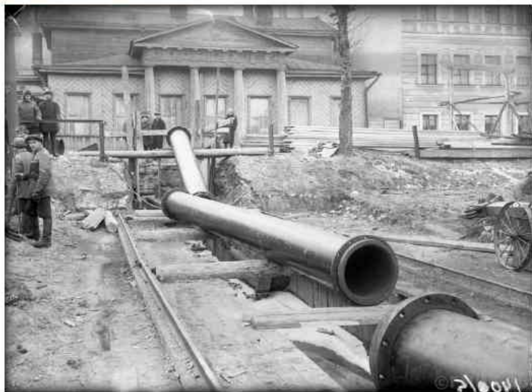
1920-1929 Водопроводные работы. Береговые работы на Петроградской набережной у дома 20 https://pastvu.com/p/1011322
