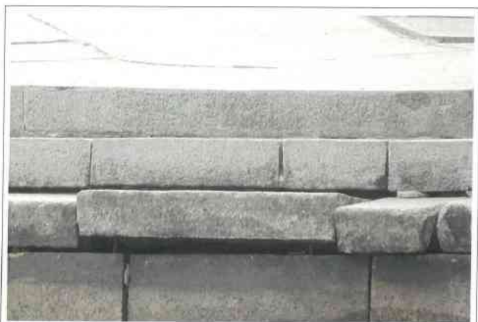
Рис.29. Расстройство двух камней нижней ступени на низовом закруглении площадки
