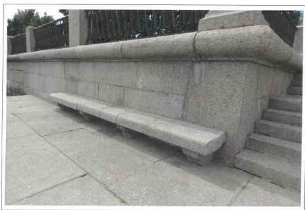
Рис.18. Потёки на верхней фасадной стенке спуска
