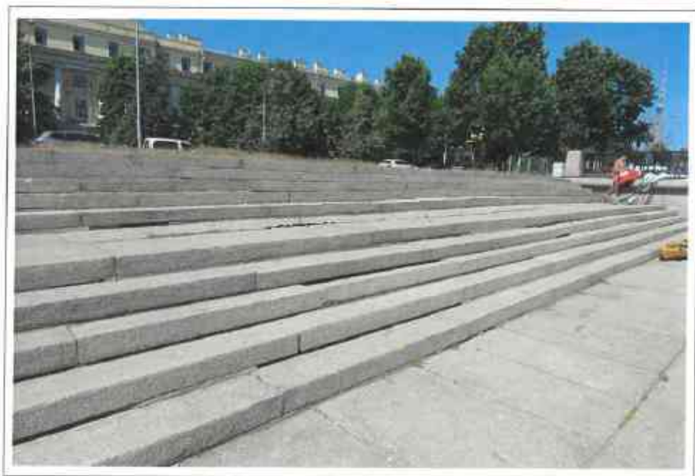
Рис.10. Разрушение расшивки швов ступеней
