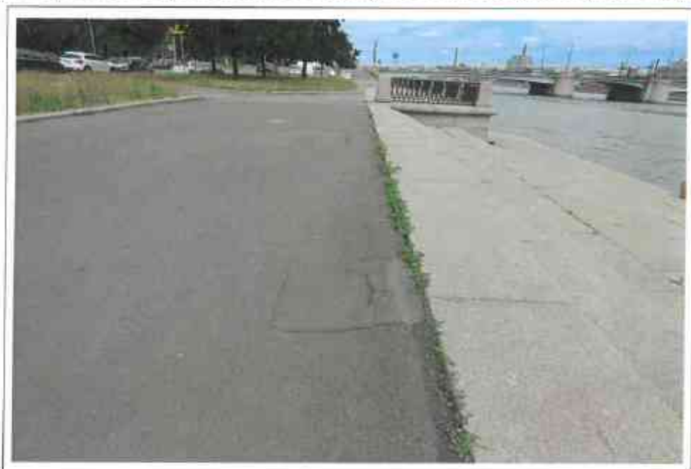
Рис.7. Просадки на поверхности тротуара
