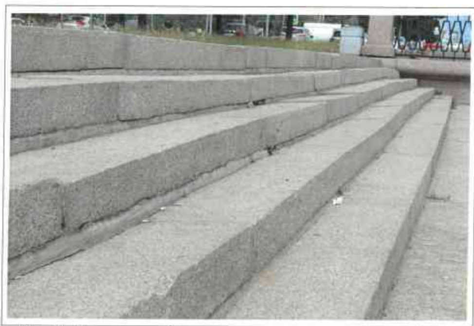
Рис.11. Ливни ступеней искривлены как в плане, так и в профиле
