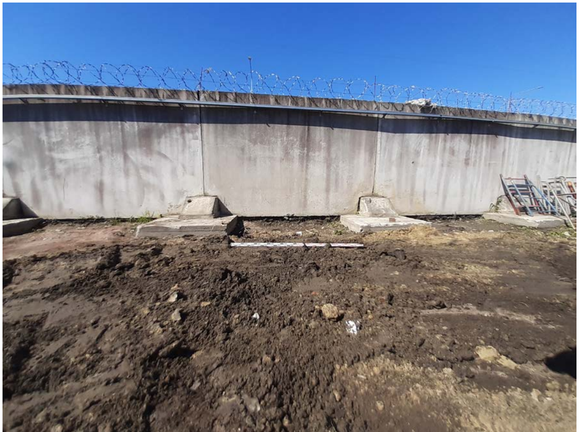
Рис.39. Санкт-Петербург, Красногвардейский р-н., Уманский переулок, дом 78, корпус 2, литера А. Шурф 1. Фотофиксация после рекультивации вид на запад.
