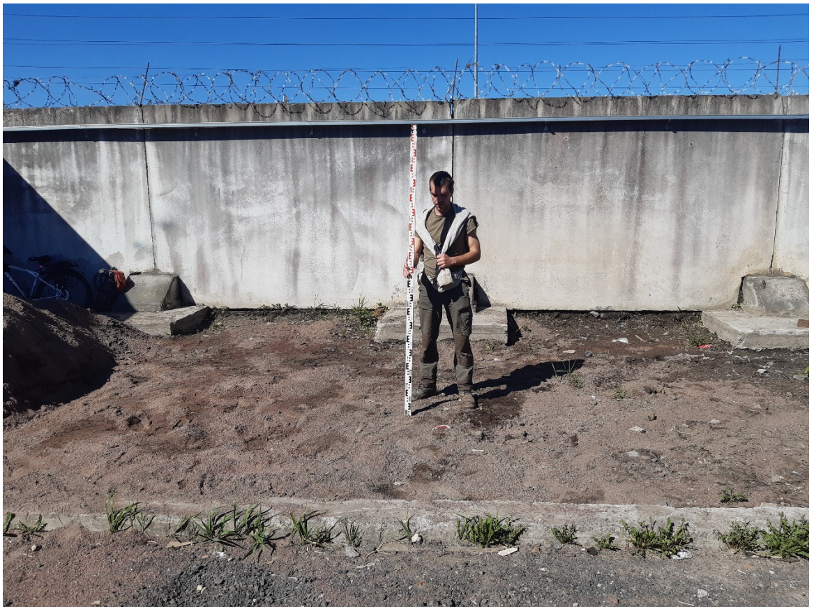
Рис.25. Санкт-Петербург, Красногвардейский р-н., Уманский переулок, дом 78, корпус 2, литера А. Шурф 1. Фотофиксация общего вида до начала работ. Вид на запад.
