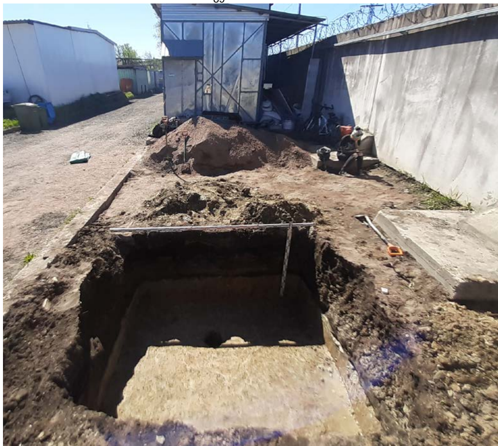
Рис.36. Санкт-Петербург, Красногвардейский р-н., Уманский переулок, дом 78, корпус 2, литера А. Шурф 1. Финальная фотофиксация с окружающим пейзажем. Вид на юг.
