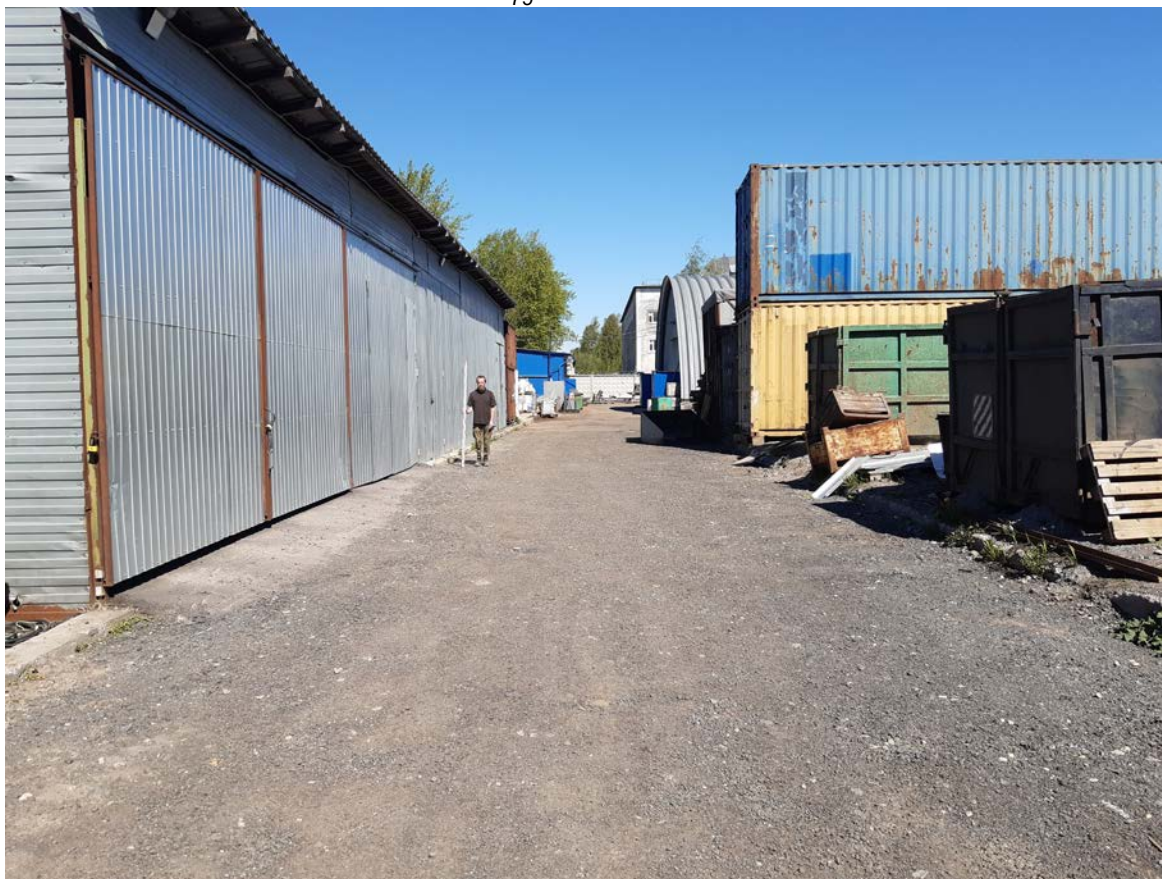
Рис. 16. Санкт-Петербург, Красногвардейский р-н., Уманский переулок, дом 78, корпус 2, литера А. Общий вид участка. Точка съёмки 1. Вид на север.
