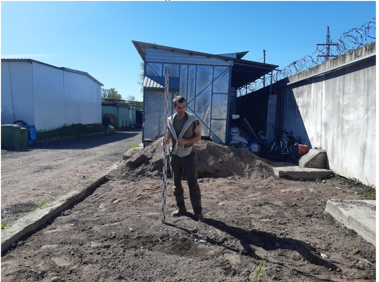
Рис.24. Санкт-Петербург, Красногвардейский р-н., Уманский переулок, дом 78, корпус 2, литера А. Шурф 1. Фотофиксация общего вида до начала работ. Вид на юг.
