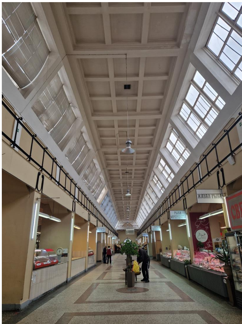
11. Объект культурного наследия регионального значения «Здание Сытного рынка» по адресу: г. Санкт-Петербург, Сытнинская ул., д. 5, литера А. Интерьер торгового зала. Общий вид в северном направлении.
