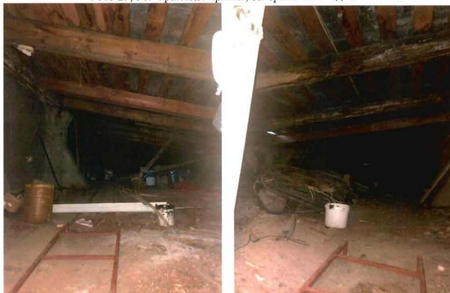
Фото 29, 30. Фрагмент крыши, северная часть здания.
