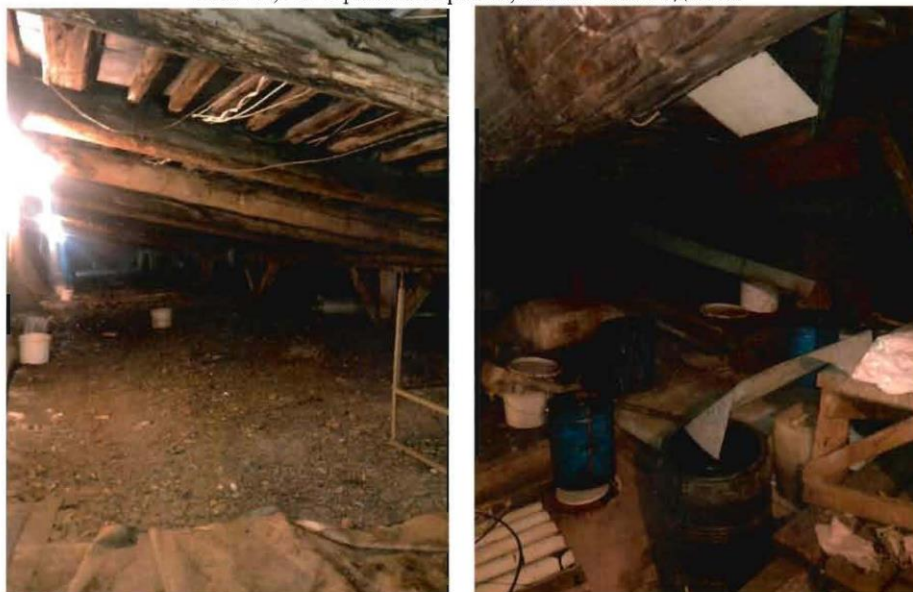
Фото 27, 28. Фрагмент крыши, южная часть здания.
