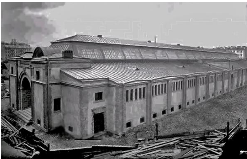
10. Сытный рынок. Строительство здания. Фотография 1010 г. https://www.citywalls.ru/
