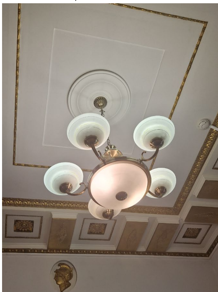
Фото 54. Фрагмент потолка помещения
