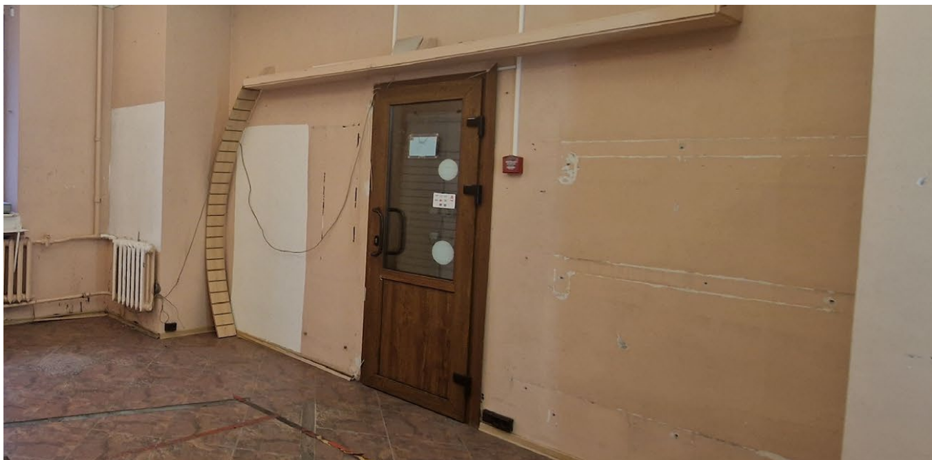
Фото 40. Общий вид помещения
