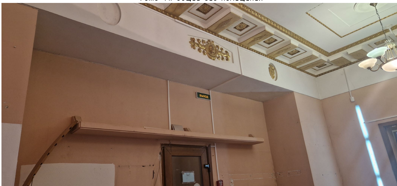
Фото 42. Общий вид помещения
