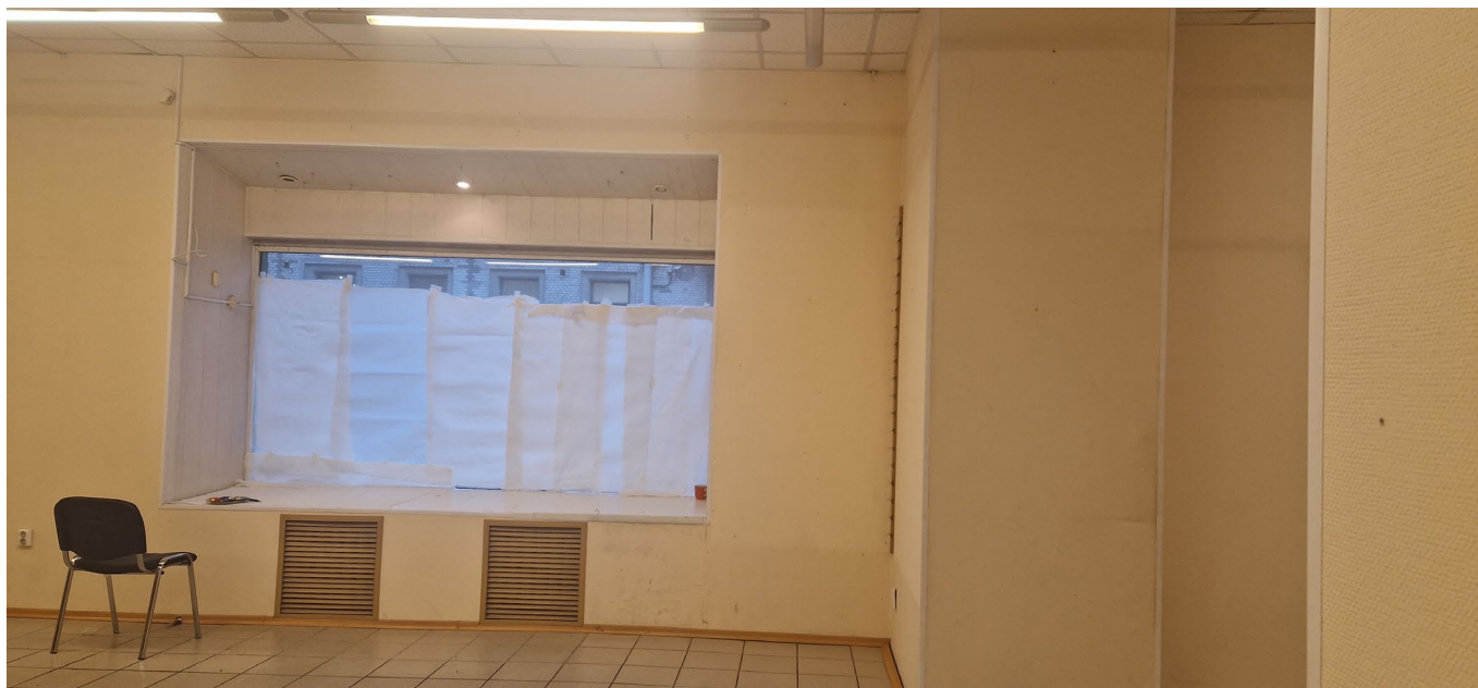
Фото 9. Общий вид помещения
