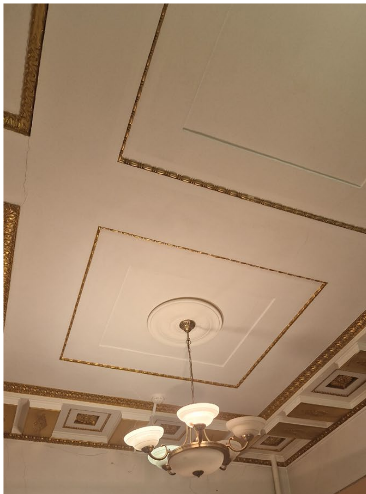
Фото 53. Фрагмент потолка помещения
