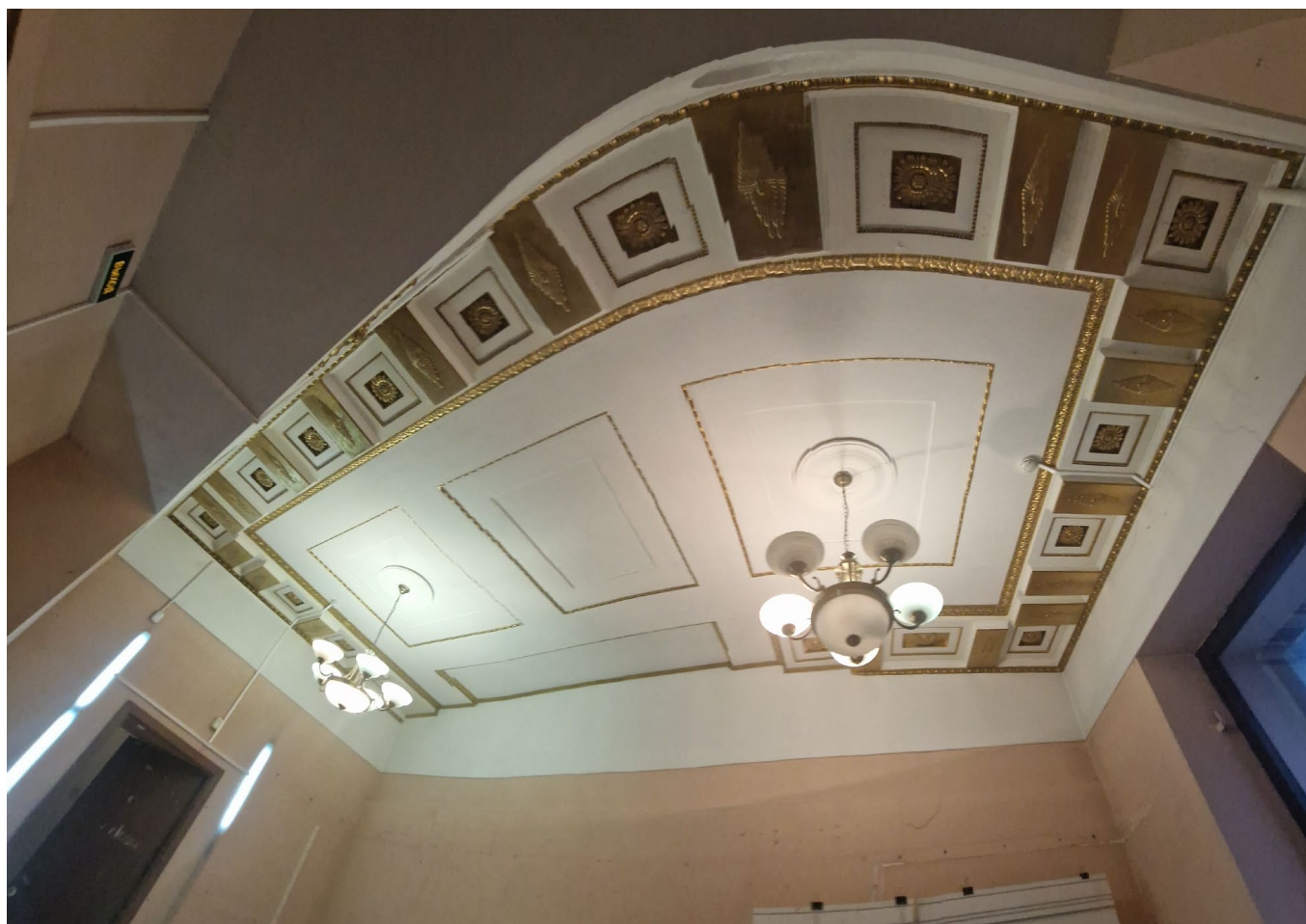
Фото 46. Фрагмент потолка помещения
