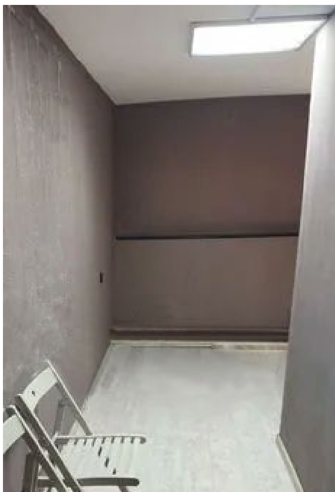
Фото 8. Общий вид помещения
