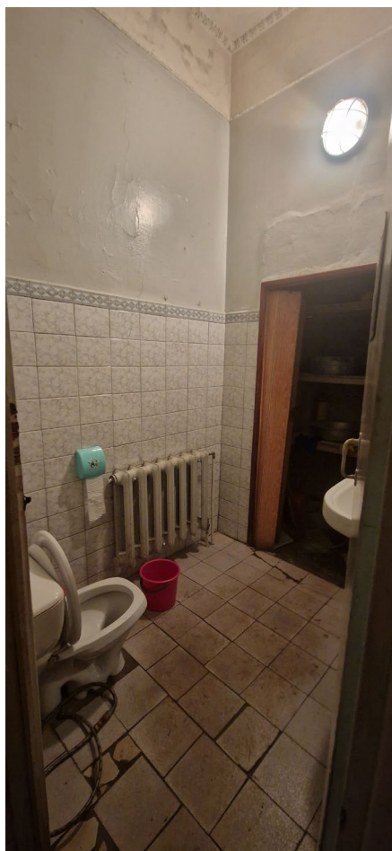
Фото 24. Общий вид помещения
