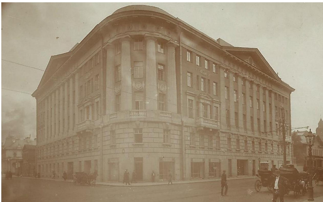
14. Общий вид на здание с северо-запада. Фото 1913-1914 гг. https://pastvu.com/p/124709
