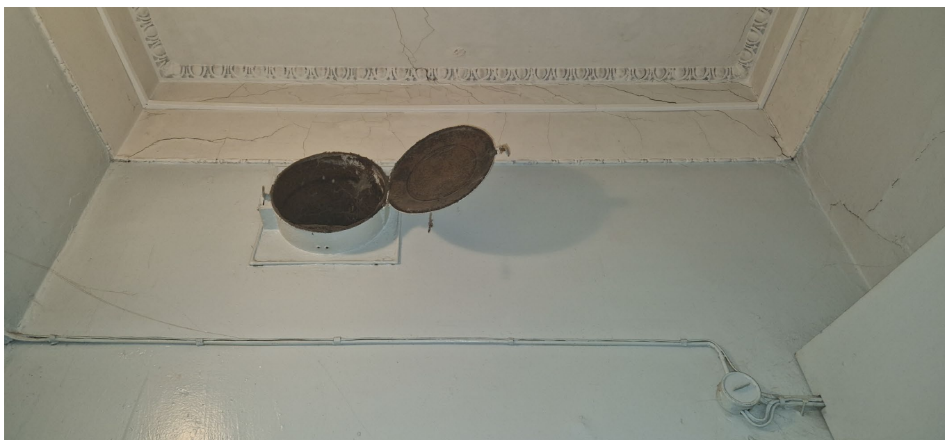
Фото 31. Фрагмент потолка помещения
