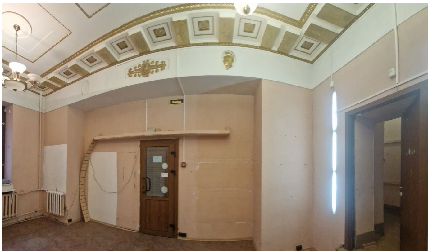
Фото 43. Общий вид помещения
