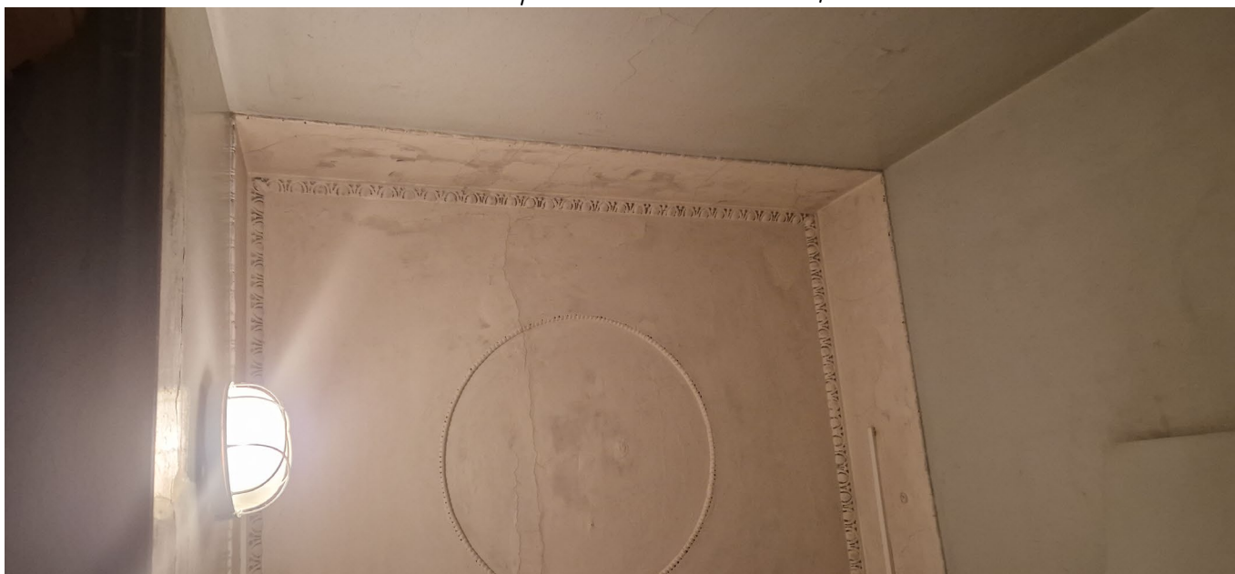
Фото 28. Фрагмент потолка помещения
