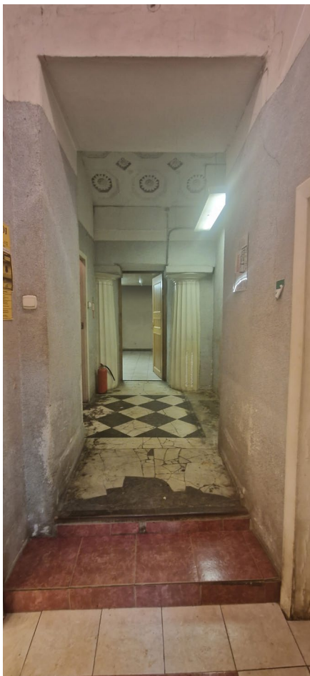
Фото 1. Общий вид помещения
