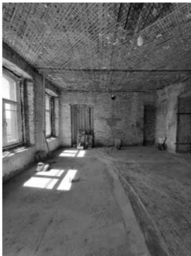
Фото 21 Интерьер квартиры №39 выявленного объекта культурного наследия «Дом Ф.Ф. Шпринга» расположенного по адресу: Санкт-Петербург, пер. Тучков, дом 11/5, литера А (26.09.2022)
