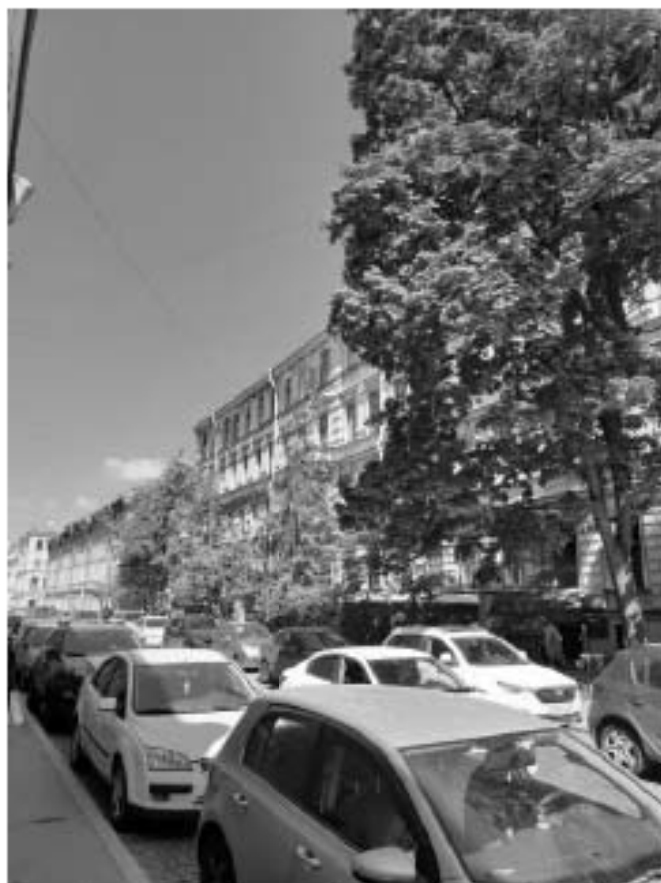
Фото 1 Фрагмент лицевого фасада выявленного объекта культурного наследия «Дом Ф.Ф. Шпринга» расположенного по адресу: Санкт-Петербург, пер. Тучков, дом 11/5, литера А (Тучков пер., 11; Волховский пер., 5) (30.05.2022)
