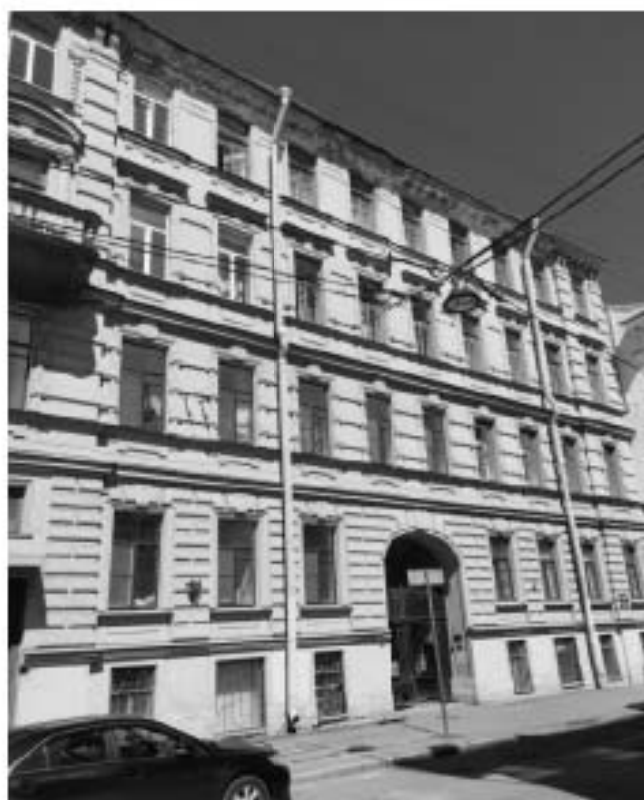
Фото 8 Фрагмент лицевого фасада выявленного объекта культурного наследия «Дом Ф.Ф. Шпринга» расположенного по адресу: Санкт-Петербург, пер. Тучков, дом 11/5, литера А (Тучков пер., 11; Волховский пер., 5) (26.09.2022)
