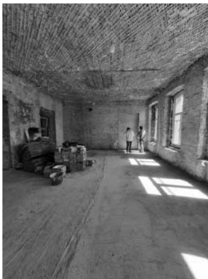
Фото 20 Интерьер квартиры №39 выявленного объекта культурного наследия «Дом Ф.Ф. Шпринга» расположенного по адресу: Санкт-Петербург, пер. Тучков, дом 11/5, литера А (26.09.2022)
