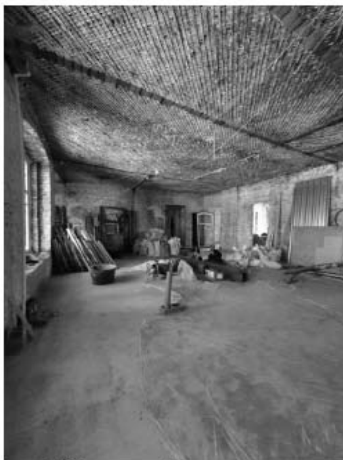
Фото 22 Интерьер квартиры №39 выявленного объекта культурного наследия «Дом Ф.Ф. Шпринга» расположенного по адресу: Санкт-Петербург, пер. Тучков, дом 11/5, литера А (26.09.2022)
