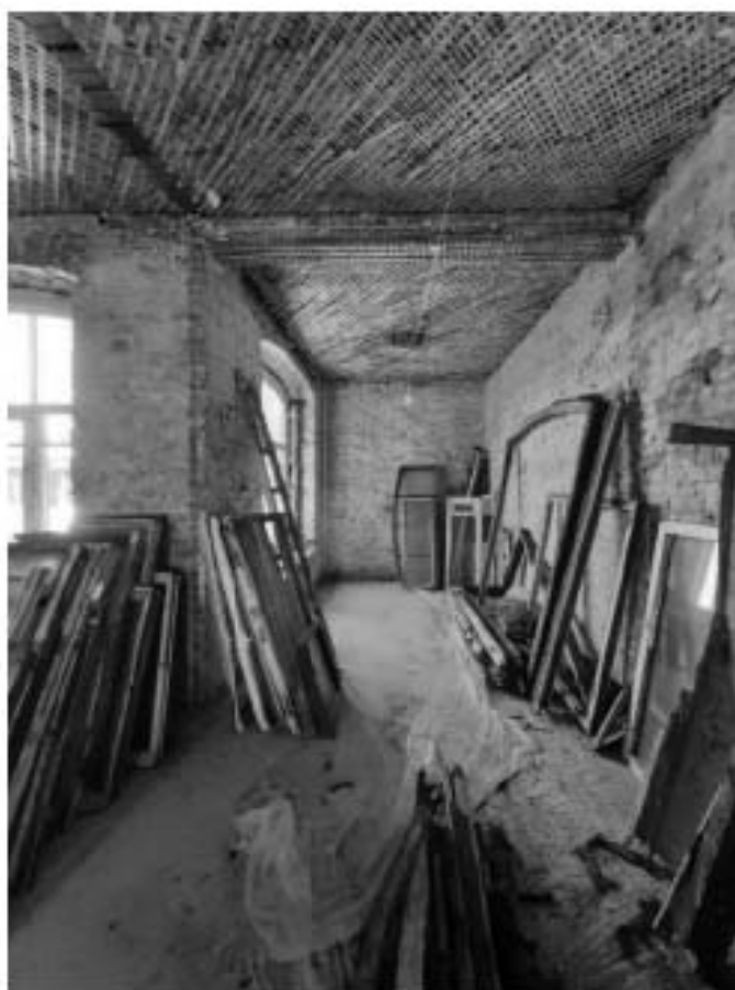
Фото 18 Интерьер квартиры №39 выявленного объекта культурного наследия «Дом Ф.Ф. Шпринга» расположенного по адресу: Санкт-Петербург, пер. Тучков, дом 11/5, литера А (26.09.2022)
