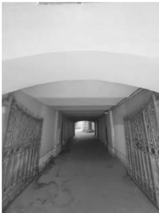
Фото 3 Фрагмент лицевого фасада выявленного объекта культурного наследия «Дом Ф.Ф. Шпринга» расположенного по адресу: Санкт-Петербург, пер. Тучков, дом 11/5, литера А (Тучков пер., 11; Волховский пер., 5) (30.05.2022)
