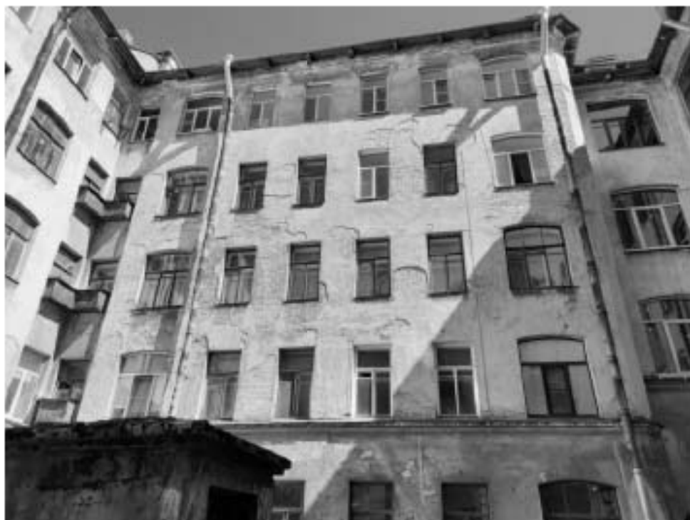
Фото 13 Фрагмент дворового фасада выявленного объекта культурного наследия «Дом Ф. Ф. Шпринга» расположенного по адресу: Санкт-Петербург, пер. Тучков, дом 11/5, литера А (Тучков пер., 11; Волховский пер., 5) (26.09.2022)
