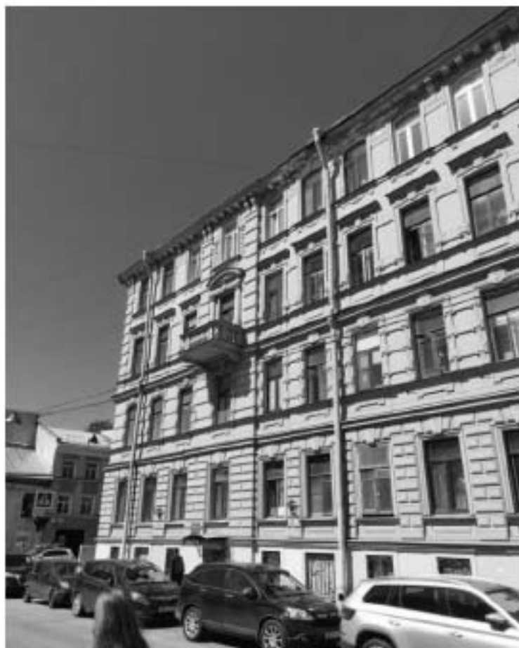
Фото 6 Фрагмент лицевого фасада выявленного объекта культурного наследия «Дом Ф.Ф. Шпринга» расположенного по адресу: Санкт-Петербург, пер. Тучков, дом 11/5, литера А (Тучков пер., 11; Волховский пер., 5) (26.09.2022)
