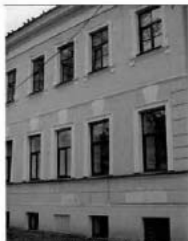
фрагмент лицевого фасада
