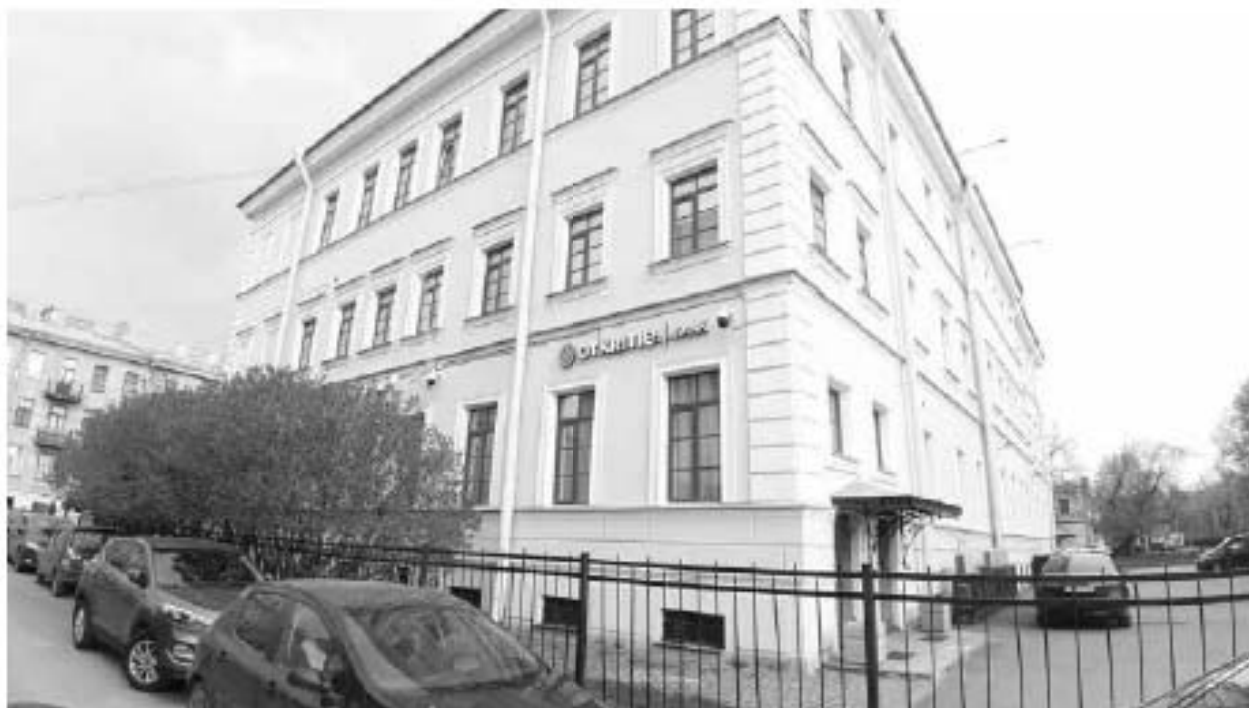
43. Солдатская казарма (в составе «Комплекса казарм Семеновского и Егерского полков»). (Звенигородская ул., д. 3, лит. А). Общий вид. Штиглиц М.С. 07.05.2024.
