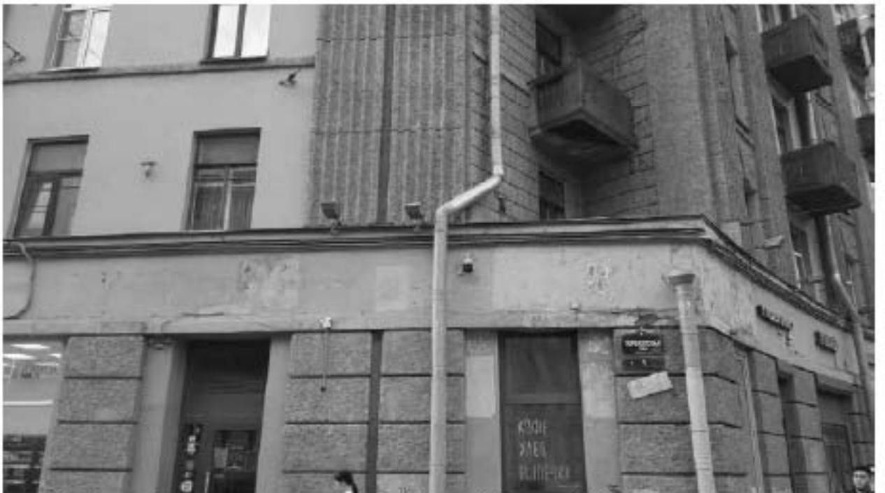
52. Ансамбль жилых домов площади Стачек (3 здания) (Перекопская ул., д. 1, лит. А). Лицевой фасад (фрагмент). Фото мест установки оборудования и кабельных трасс. Штиглиц М.С. 07.05.2024.
