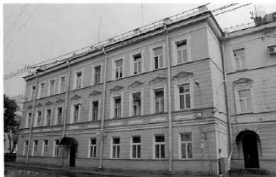
Фото №2. Лицевой фасад. Вид со стороны ул. Рузовской.
