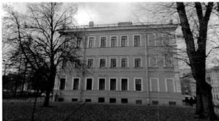
Фото №5. Терцевой (юго-восточный) фасада.
