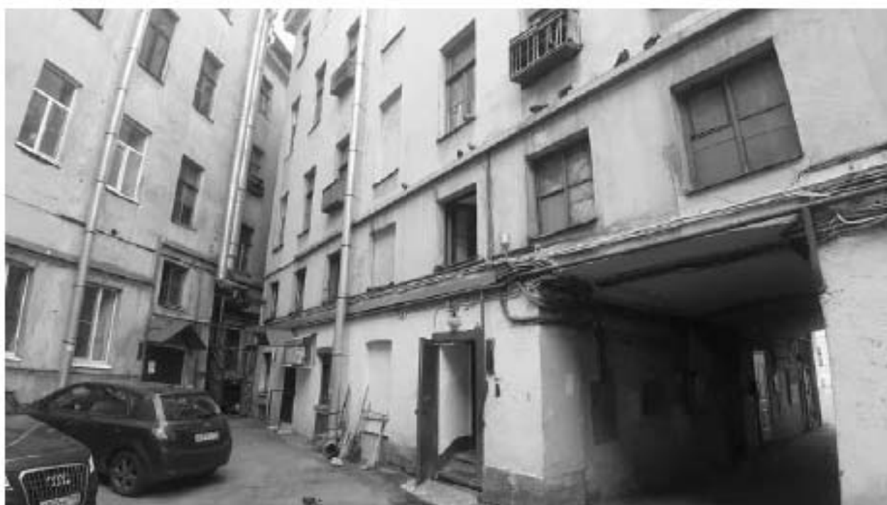
17. Дом Ф. Моровица (Никольская пл., д. 6, лит. А). Дворовые фасады. Фото мест установки оборудования и кабельных трасс. Штиглиц М.С. 07.05.2024.
