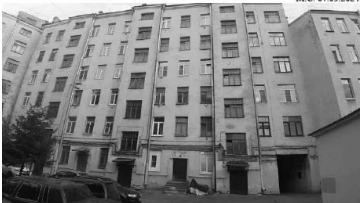
58. Ансамбль жилых домов площади Стачек (3 здания) (Перекопская ул., д. 1, лит. А). Дворовые фасады. Фото мест установки оборудования и кабельных трасс. Штиглиц М.С. 07.05.2024.
