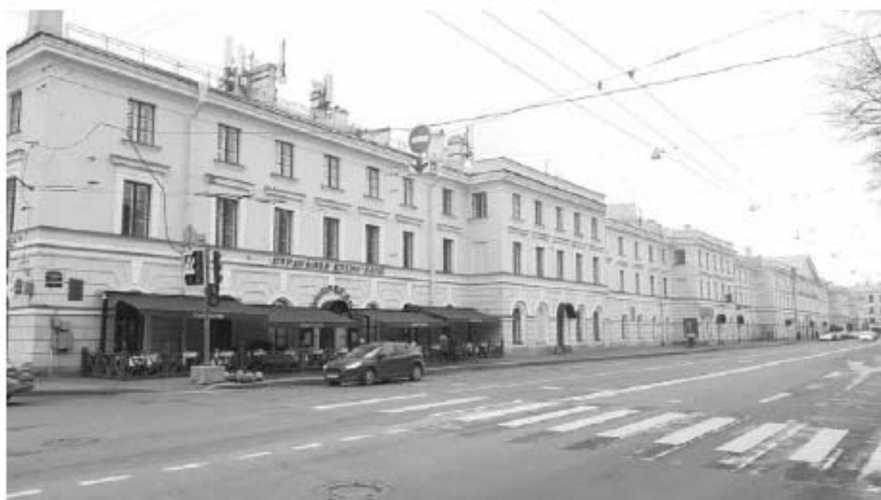
32. Казармы (Трехэскадронный корпус) (в составе «Манеж и казармы Конногвардейского полка») (Конногвардейский бульвар, д. 4, лит. А). Лицевой фасад по Конногвардейскому бульвару. Штиглиц М.С. 07.05.2024.
