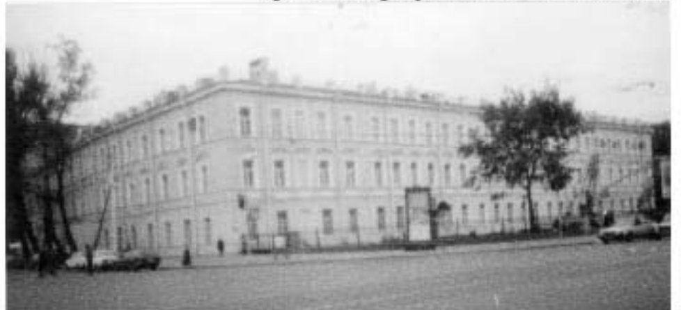
58. «Офицерская казарма» (в составе «Комплекса казарм Семеновского и Егерского полков»). (Загородный пр., д. 54, лит. А). Фото 1999 г. (23).
