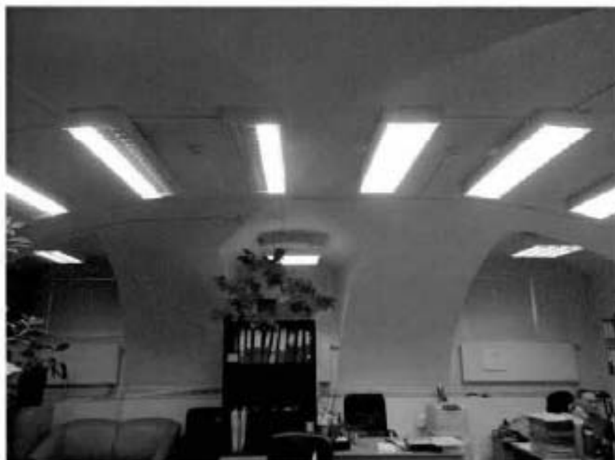
Фото №9. Сводчатые перекрытия цокольного этажа.
