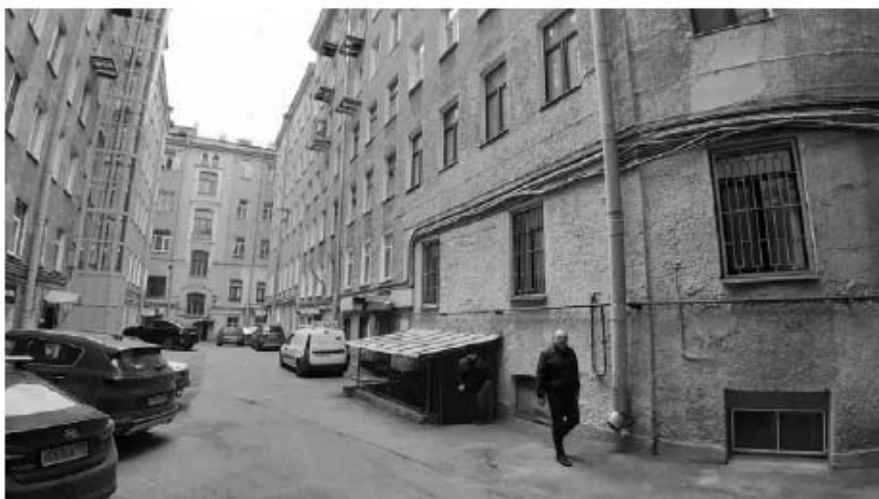
9. Дом Паулуччи А.Ф. Здесь в декабре 1905 - январе 1906 гг. проходили заседания ЦК и ПК РСДРП (Большая Морская ул., д. 36, лит. А). Дворовые фасады. Фото мест установки оборудования и кабельных трасс. Штиглиц М.С. 07.05.2024.
