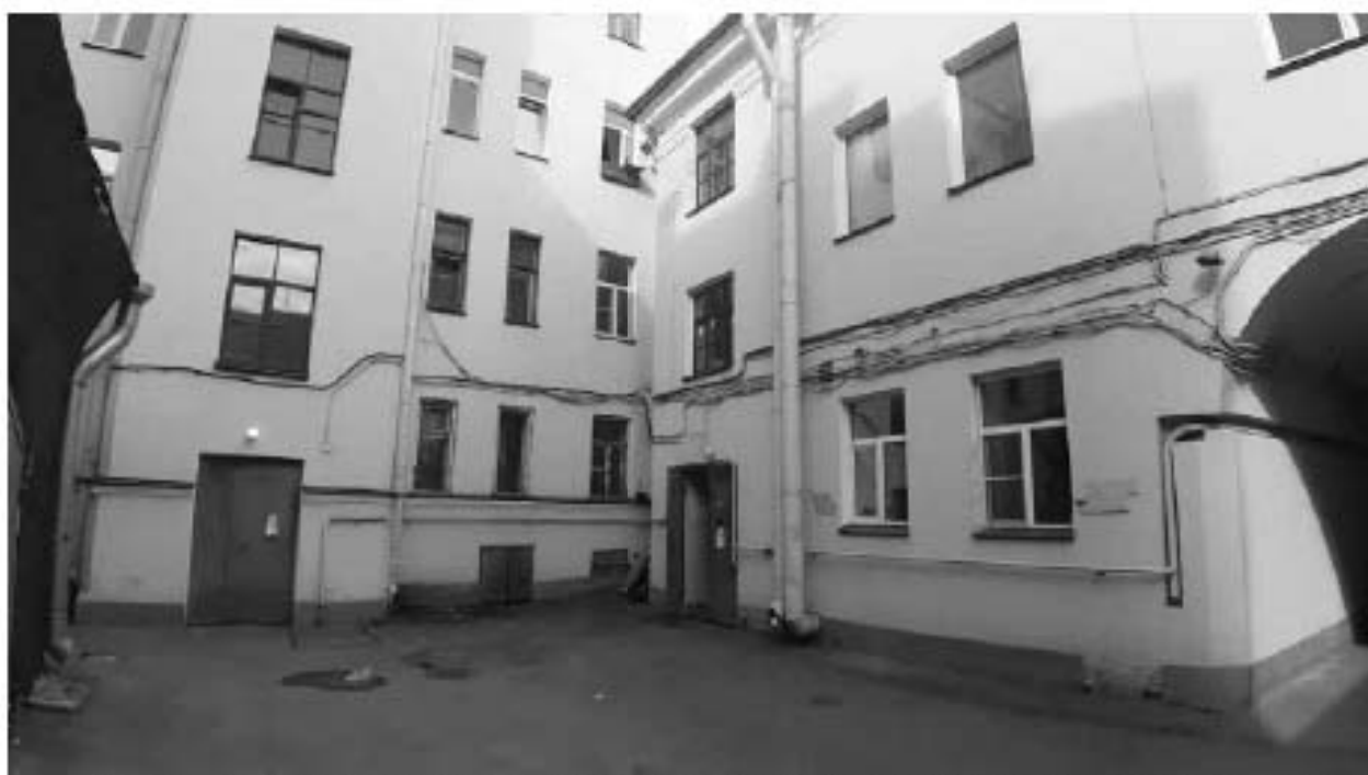
30. Особняк и доходный дом Н.Г. Кудрявцева. (4-я Красноармейская улица, д. 12/11, лит. А). Дворовые фасады. Фото мест установки оборудования и кабельных трасс. Штиглиц М.С. 07.05.2024.
