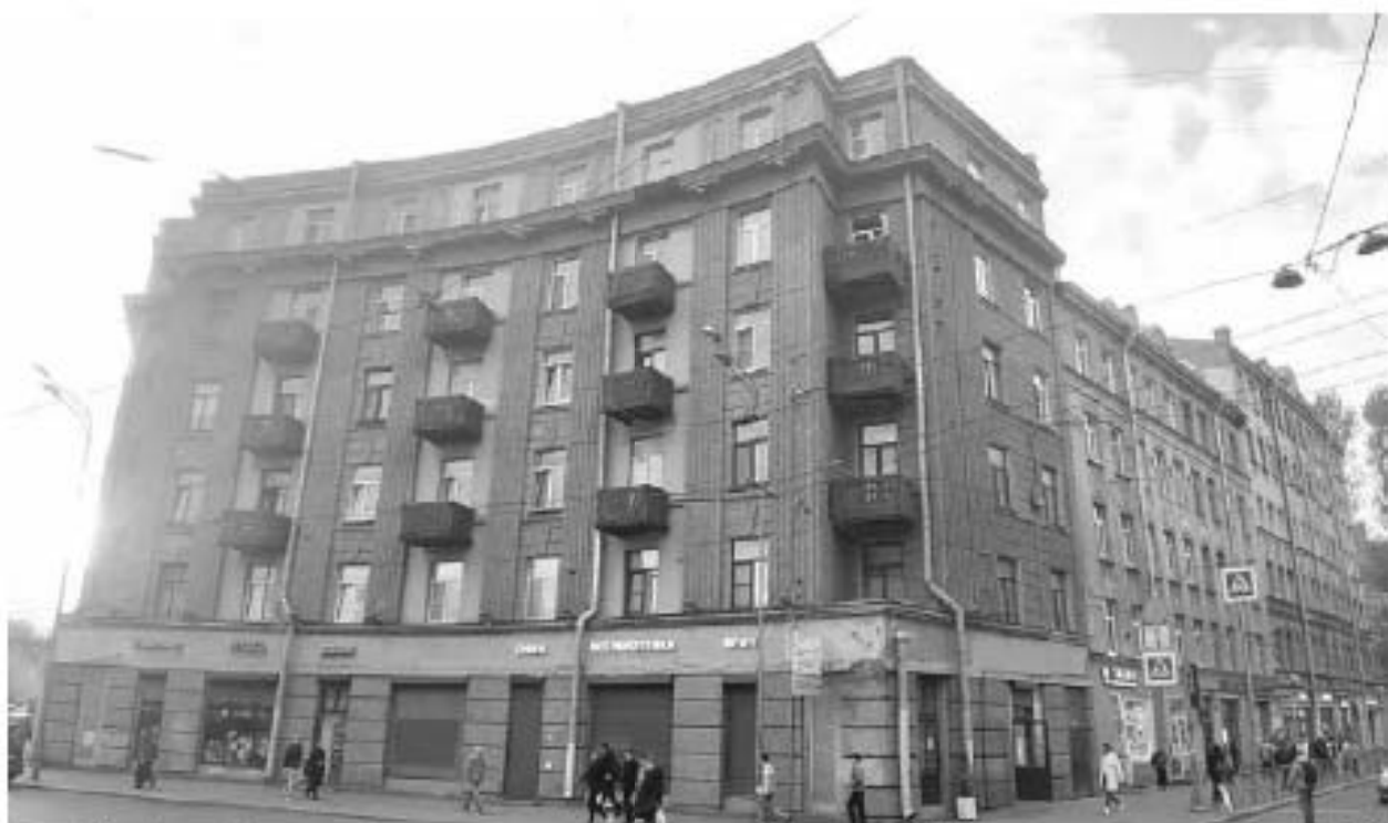
49. Ансамбль жилых домов площади Стачек (3 здания) (Перекопская ул., д. 1, лит. А). Лицевой фасад с площади Стачек. Штиглиц М.С. 07.05.2024.
