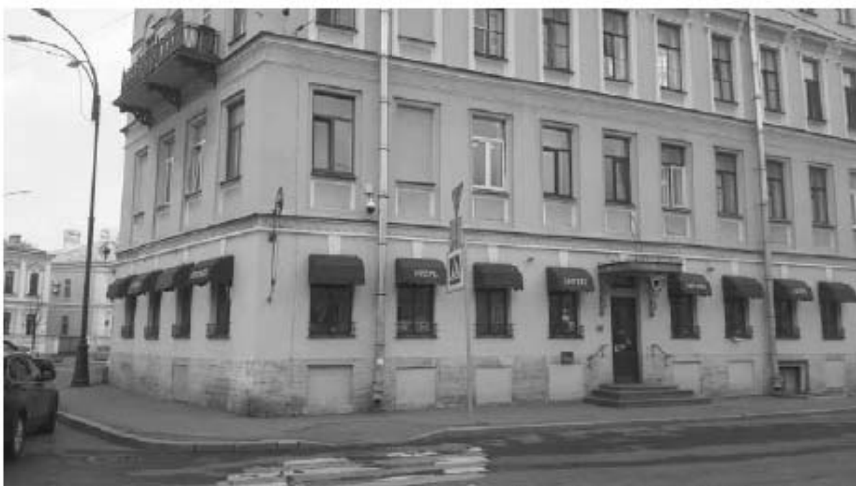
16. Дом Ф. Моровица. (Никольская пл., д. 6, лит. А). Лицевой фасад (фрагмент). Фото мест установки оборудования и кабельных трасс. Штиглиц М.С. 07.05.2024.
