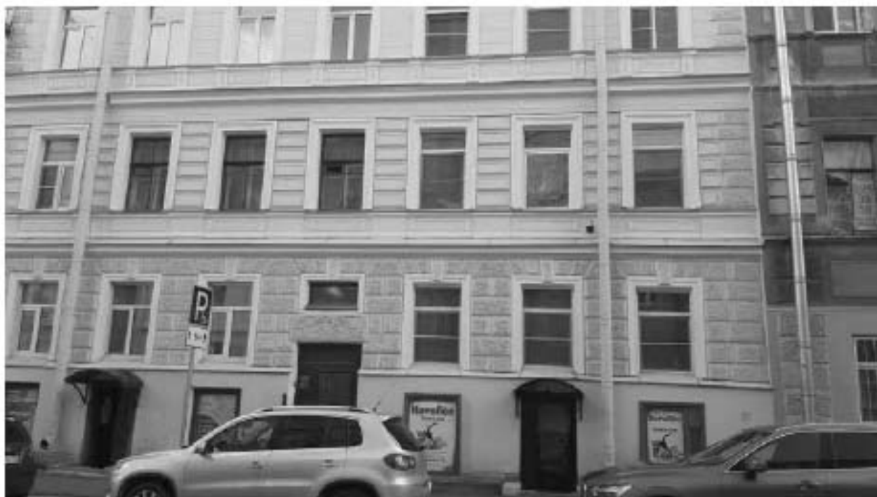
27. Особняк и доходный дом Н.Г. Кудрявцева. (4-я Красноармейская улица, д. 12/11, лит. А). Лицевой фасад (фрагмент). Фото мест установки оборудования и кабельных трасс. Штиглиц М.С. 07.05.2024.
