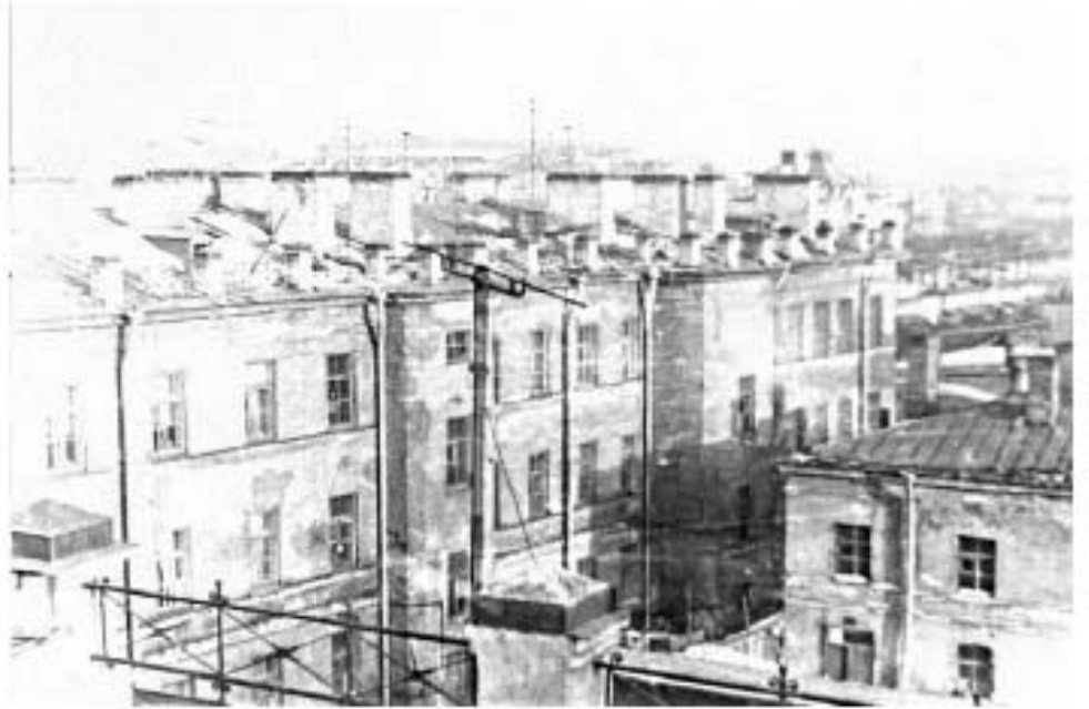
57. «Офицерская казарма» (в составе «Комплекса казарм Семеновского и Егерского полков»). (Загородный пр., д. 54, лит. А). Двор дома 54 по Загородному пр. Вид с крыши в сторону Введенского канала (30).
