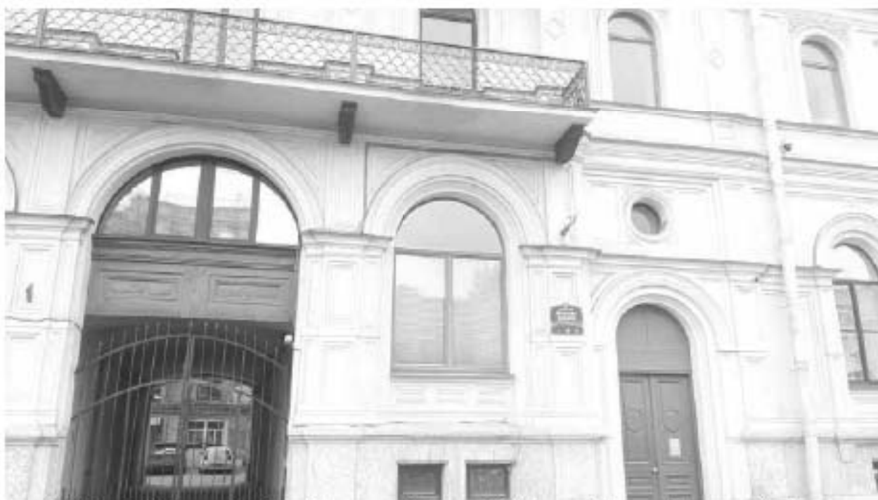
24. Дом А.Б.Фитингофа. (ул. Глинки, д. 1, лит. А). Лицевой фасад (фрагмент). Фото мест установки оборудования и кабельных трасс. Штиглиц М.С. 07.05.2024.
