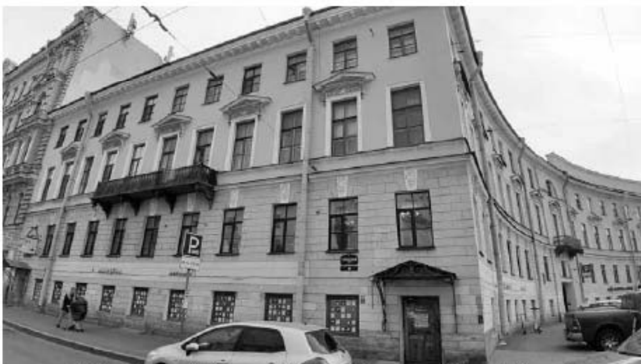
40. Дом Устинова К. (Петровых). (наб. реки Фонтанки, д. 92, лит. А). Лицевой фасад по Гороховой ул. Фото мест установки оборудования и кабельных трасс. Штиглиц М.С. 07.05.2024.
