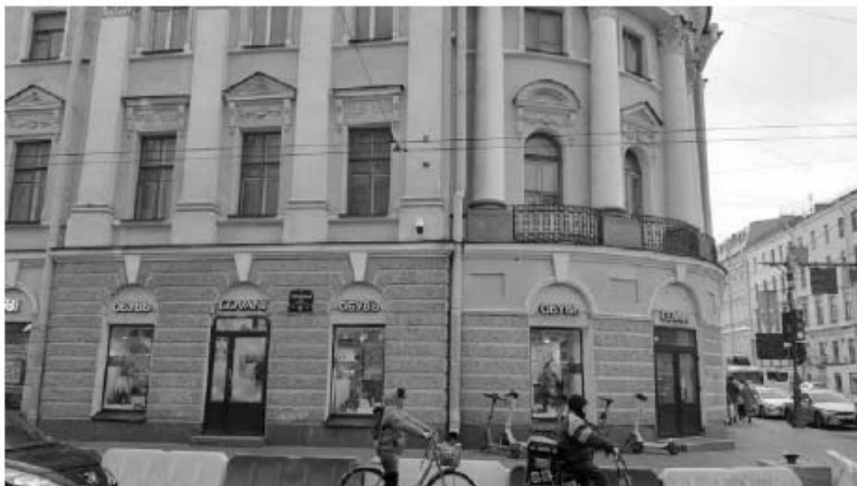
67. Дом Яковлева С.Я. (Гороховая ул., д. 45, лит. А). Лицевой фасад по Гороховой ул. Фото мест установки оборудования и кабельных трасс. Штиглиц М.С. 07.05.2024.
