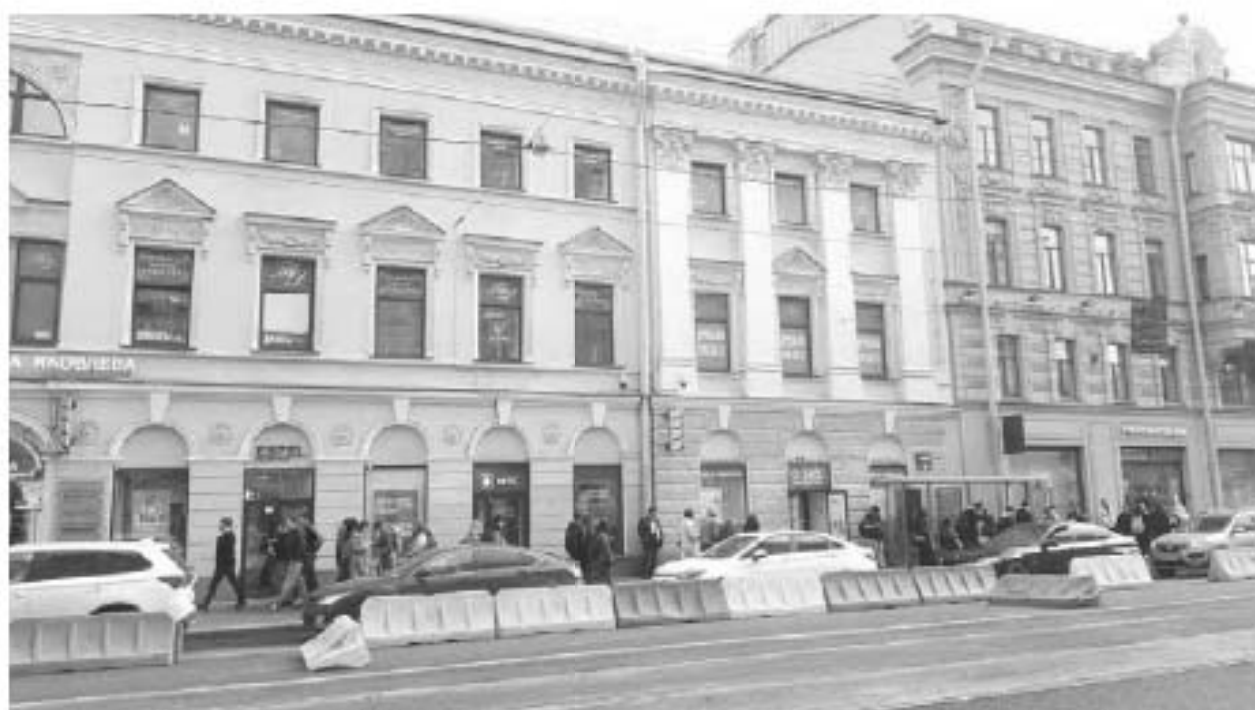
66. Дом Яковлева С.Я. (Гороховая ул., д. 45, лит. А). Лицевой фасад по Садовой ул. Фото мест установки оборудования и кабельных трасс. Штиглиц М.С. 07.05.2024.
