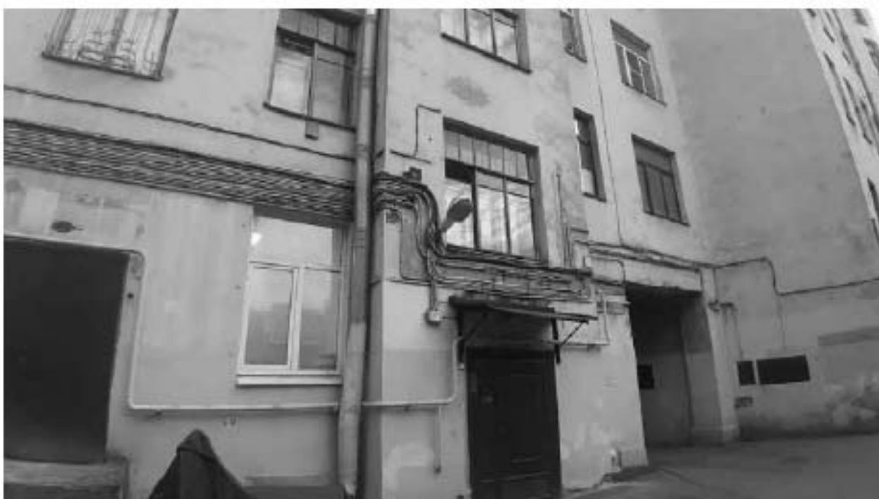
56. Ансамбль жилых домов площади Стачек (3 здания) (Перекопская ул., д. 1, лит. А). Дворовые фасады. Фото мест установки оборудования и кабельных трасс. Штиглиц М.С. 07.05.2024.
