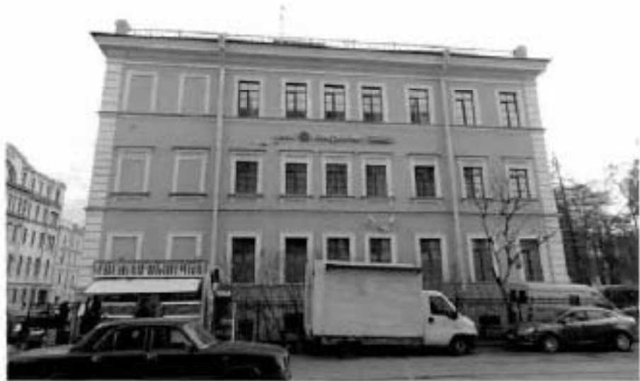
Фото №4. Торжневой (северо-западный) фасад.
