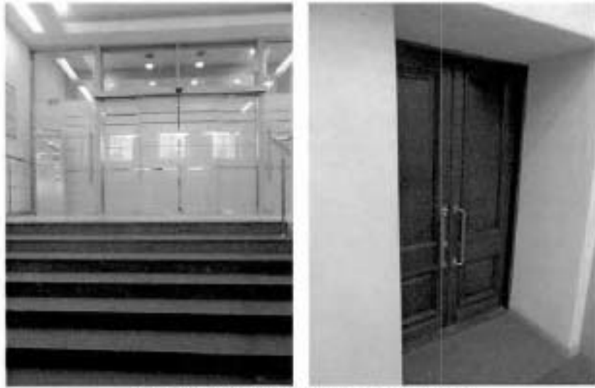
Фото №10, 11. Входные группы тамбура 1-го этажа.
