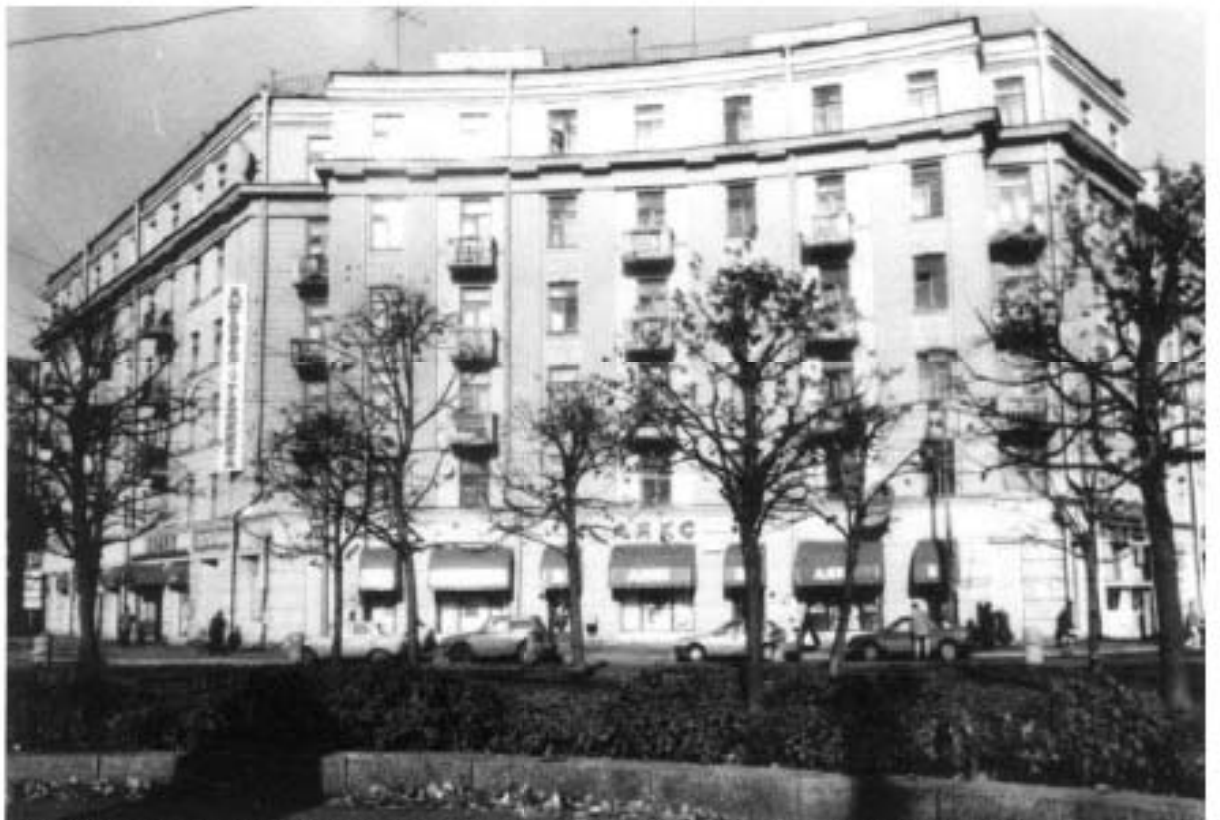
47. «Ансамбль жилых домов площади Стачек (3 здания)». Перекопская ул., д. 1, лит. А. Фото 1999 г. (23).
