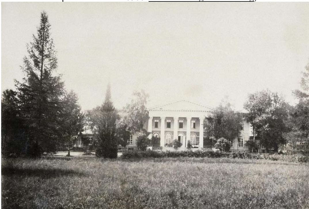
21. Фасад дома графов Левашовых в усадьбе Осинная роща. 1885 г. (Государственный Эрмитаж. ЭРФТ-988. www.hermitagemuseum.org )
