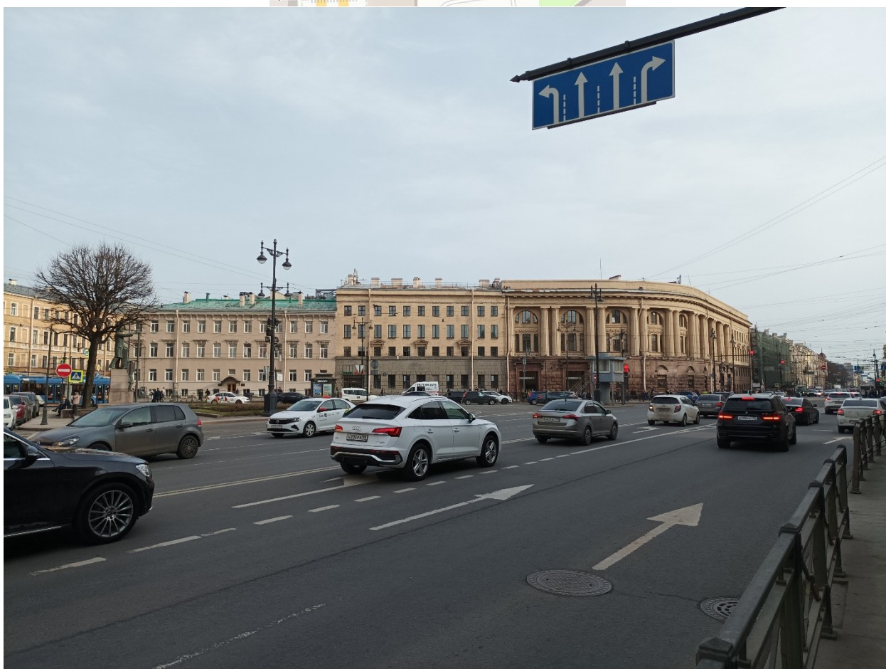
1. Объект культурного наследия регионального значения: «Станция метро «Технологический институт» (с перронным залом)», по адресу: Санкт-Петербург, Московский пр., д. 28, литера А. Общий вид объекта. Дата съемки: 21.03.2024г.
