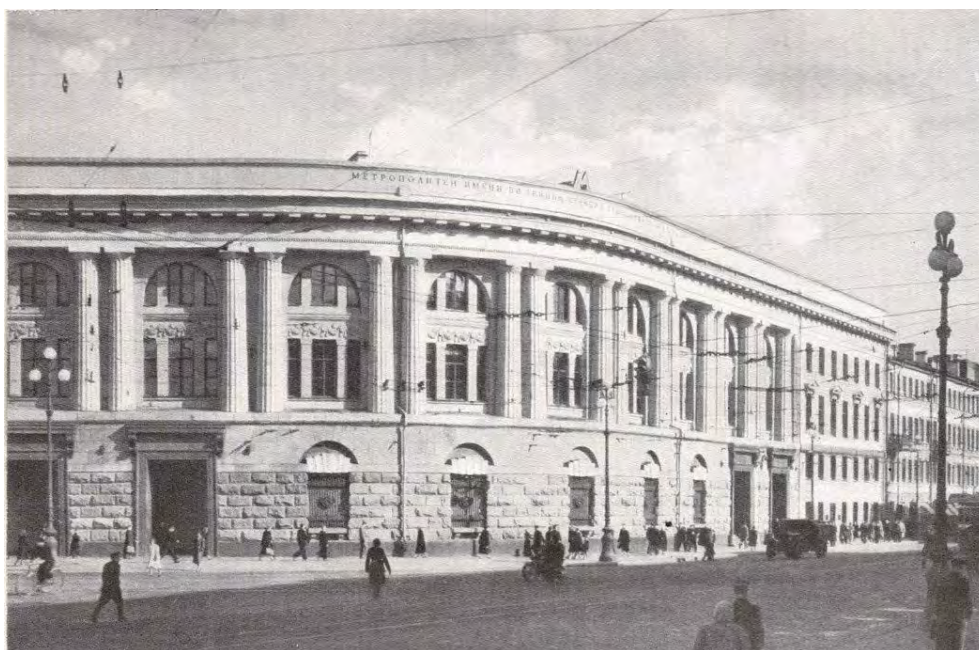
26. Павильон станции «Технологический институт». 1957 г. Источник: "Ленинград. Планировка и застройка 1945-1957".
