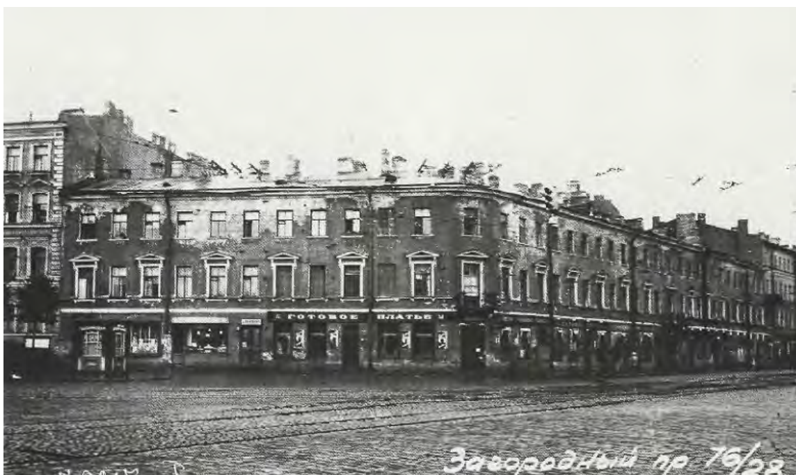
10. Загородный пр. 76/28. Доходный дом Н. М. Релева на месте наземного павильона станции метро «Технологический институт». 1945-1949 гг. Источник: www.pastvu.com
