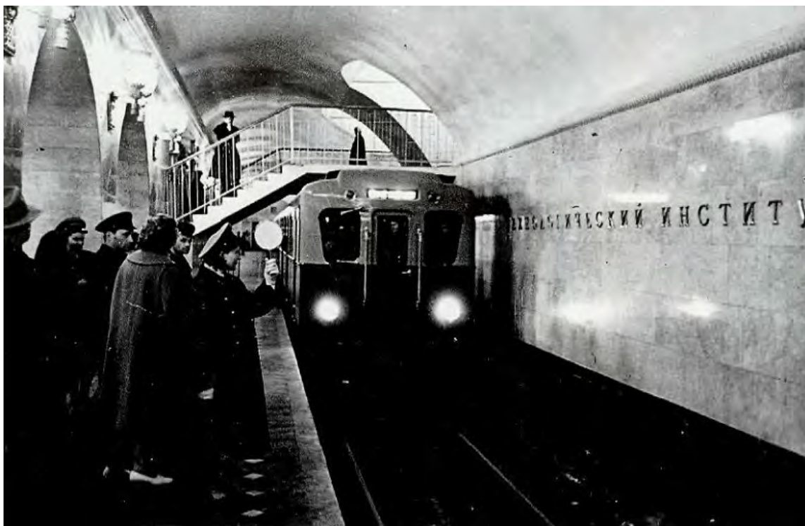
33. Отправление поезда со станции «Технологический институт». 1961 г. Источник: www.pastvu.com
