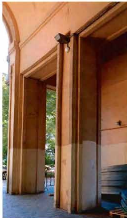
10. Фрагмент. Северная проездная арка северного флигеля.
