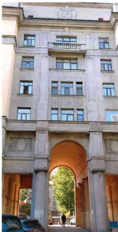
3. Фрагмент. Восточный фасад южного флигеля.
