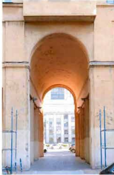
9. Фрагмент. Северная проездная арка северного флигеля.
