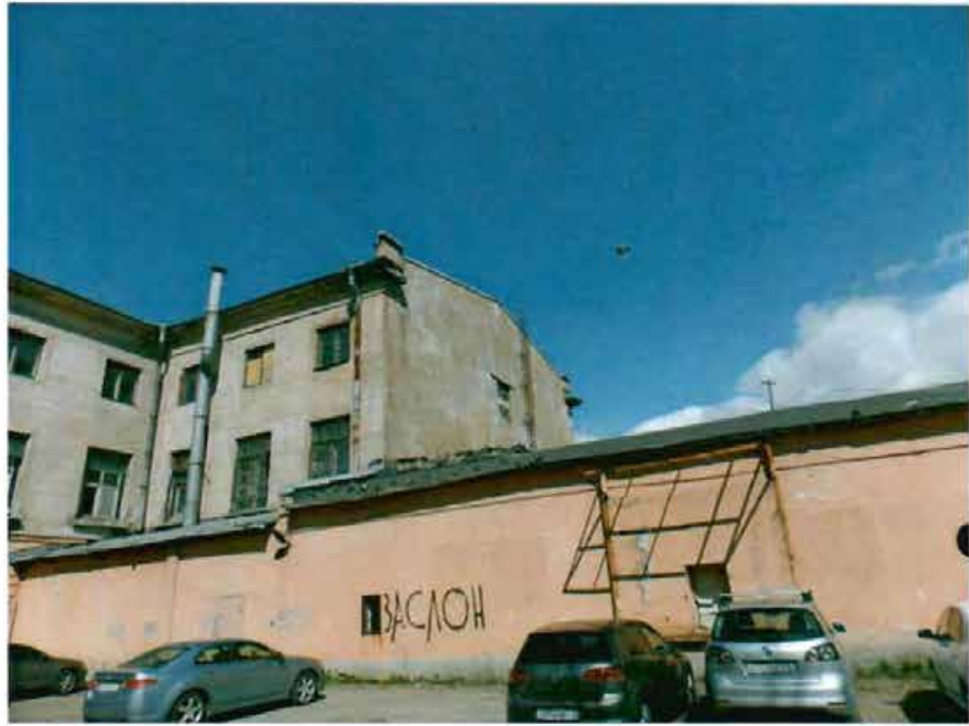
Фото 9. Часть южного и восточного фасада.
