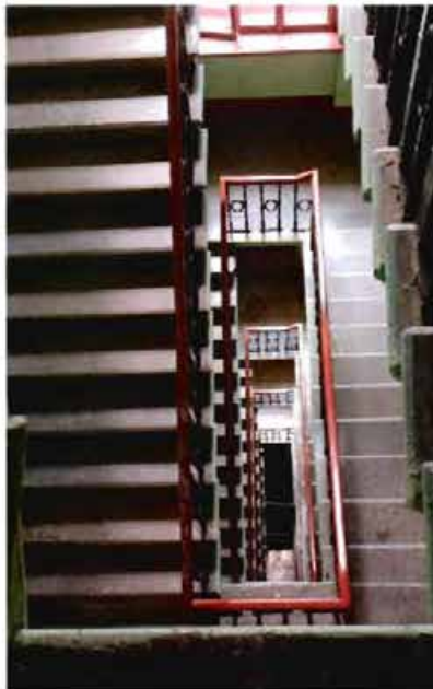
16. Интерьер. Пространство ЛК-9.
