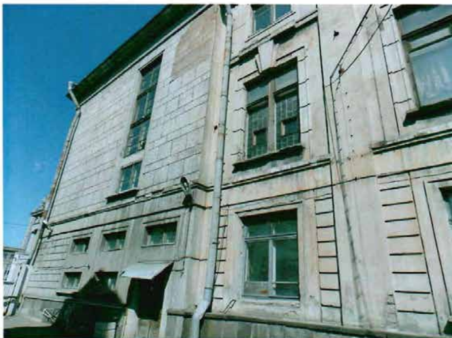
Фото 8. Часть южного фасада.
