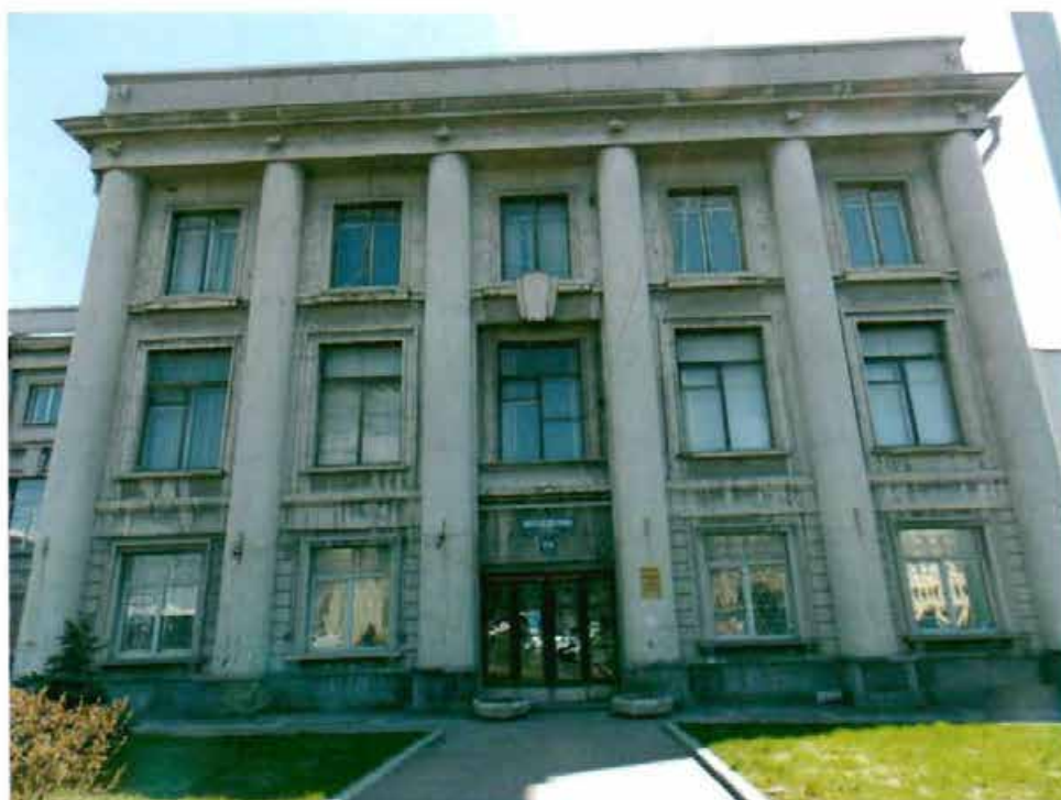
Фото 1. Фрагмент западного фасада.
