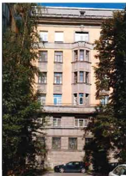
4. Фрагмент. Восточный фасад главного флигеля.
