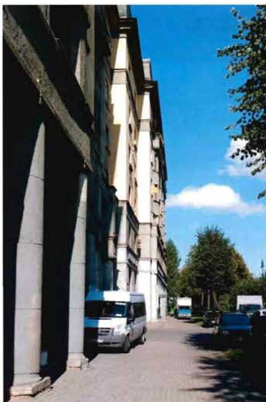
6. Фрагмент. Восточный фасад южного флигеля.
