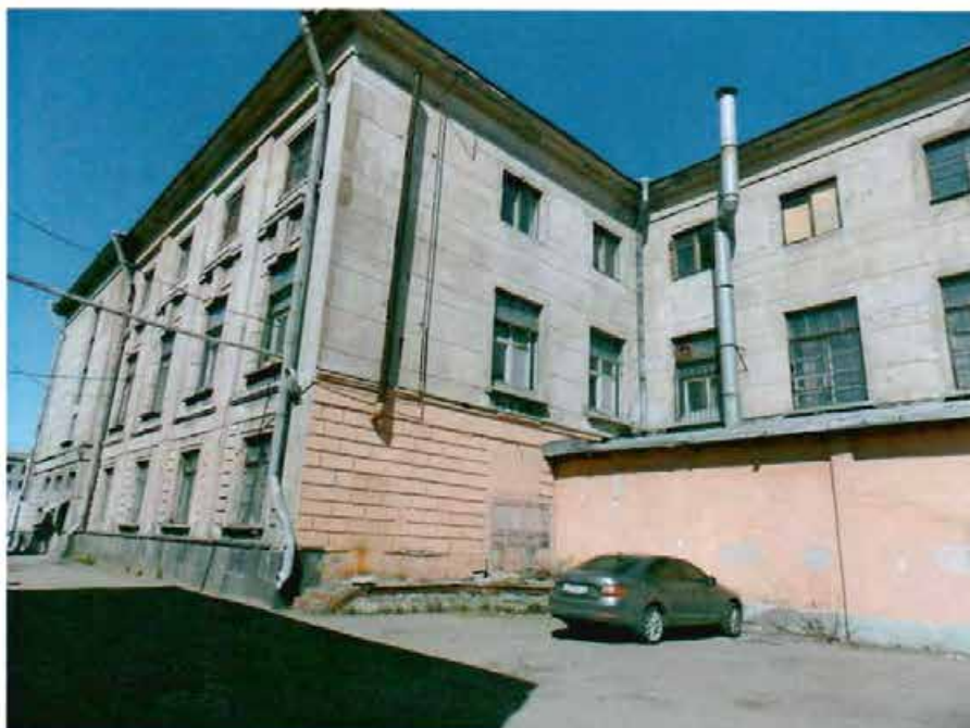
Фото 7. Часть южного и восточного фасада.
