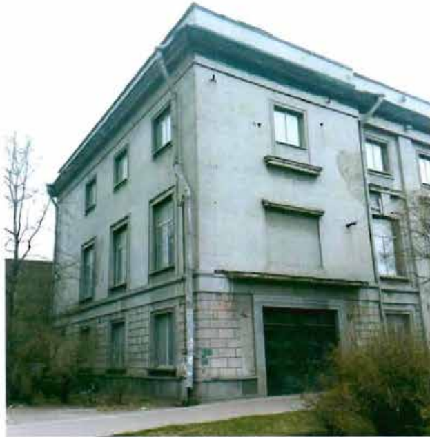
Фото 3. Часть западного и северного фасада.
