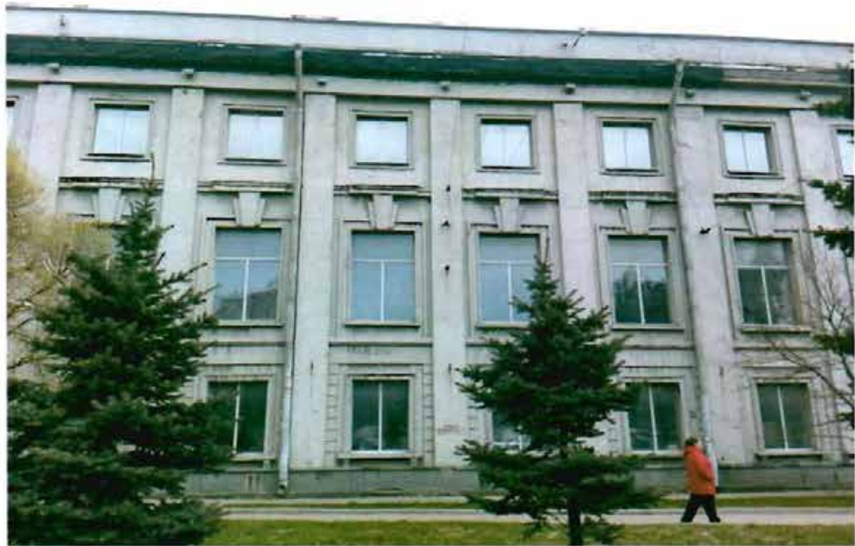
Фото 6. Фрагмент западного фасада.
