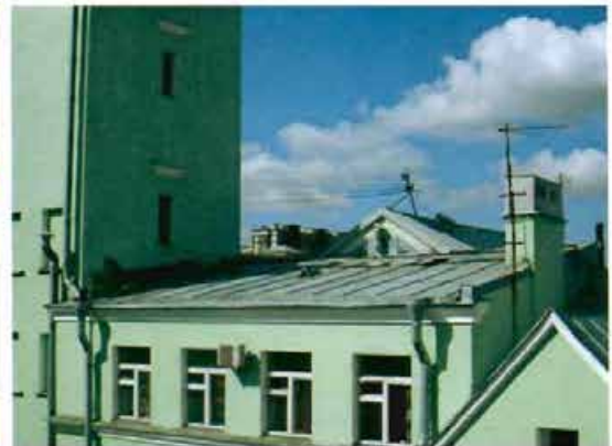
10. Вид на фальцевое покрытие кровли
