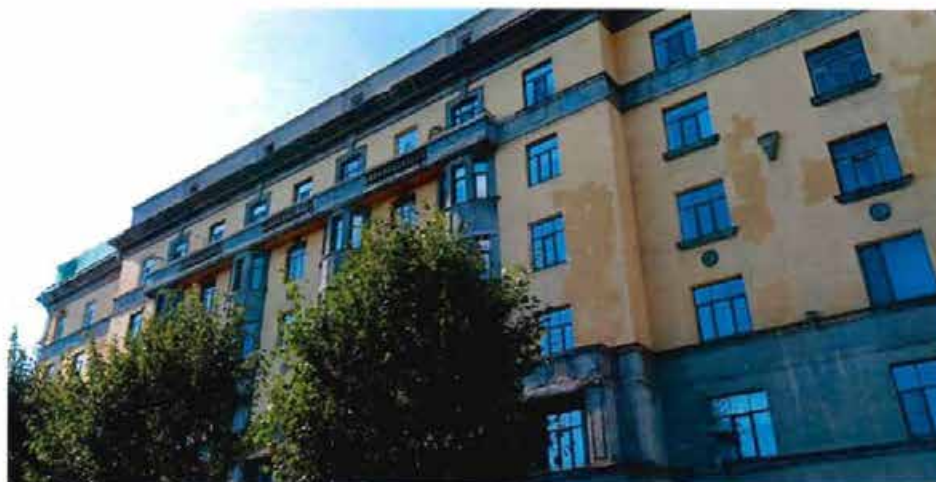
5. Фрагмент. Восточный фасад южного флигеля.
