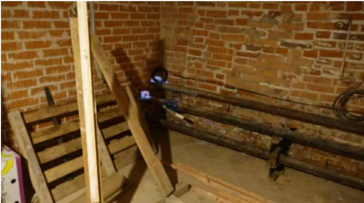
Фото 11. Стальной трубопровод, уходящий за границы помещения 18. Теплоизоляция магистрали отсутствует. Дата фотофиксации: 15.05.2024
