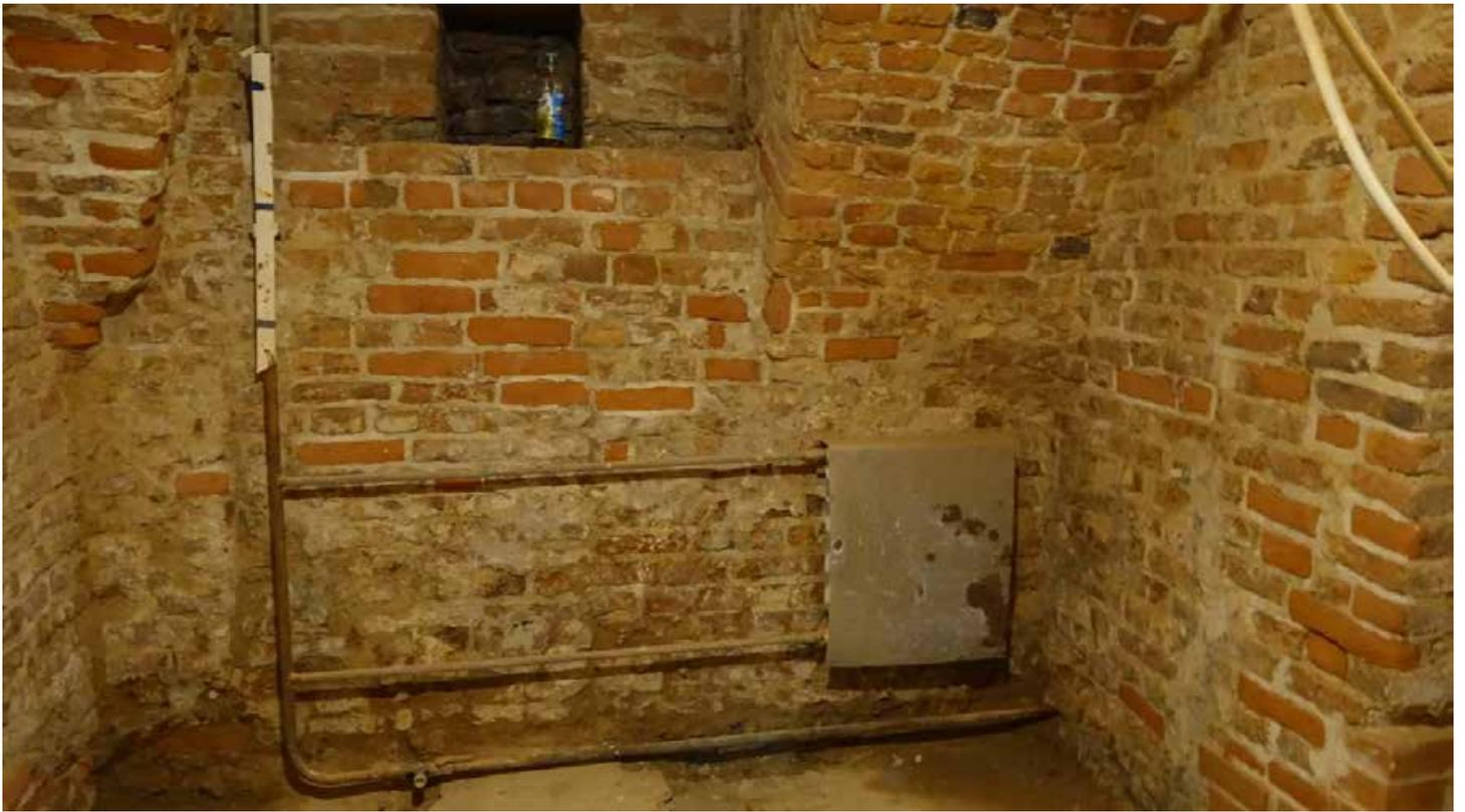
Фото 17. Радиатор в помещении 4. Стальной трубопровод, не окрашен. Теплоизоляция магистрали отсутствует. Дата фотофиксации: 15.05.2024
