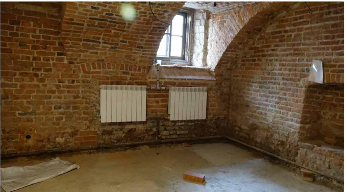
Фото 16. Секционные радиаторы в помещении 3. Общий вид. Дата фотофиксации: 15.05.2024
