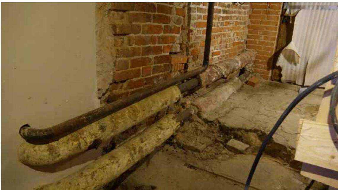
Фото 9. Стальной трубопровод в помещении 17, не окрашен. Теплоизоляция магистрали отсутствует.
