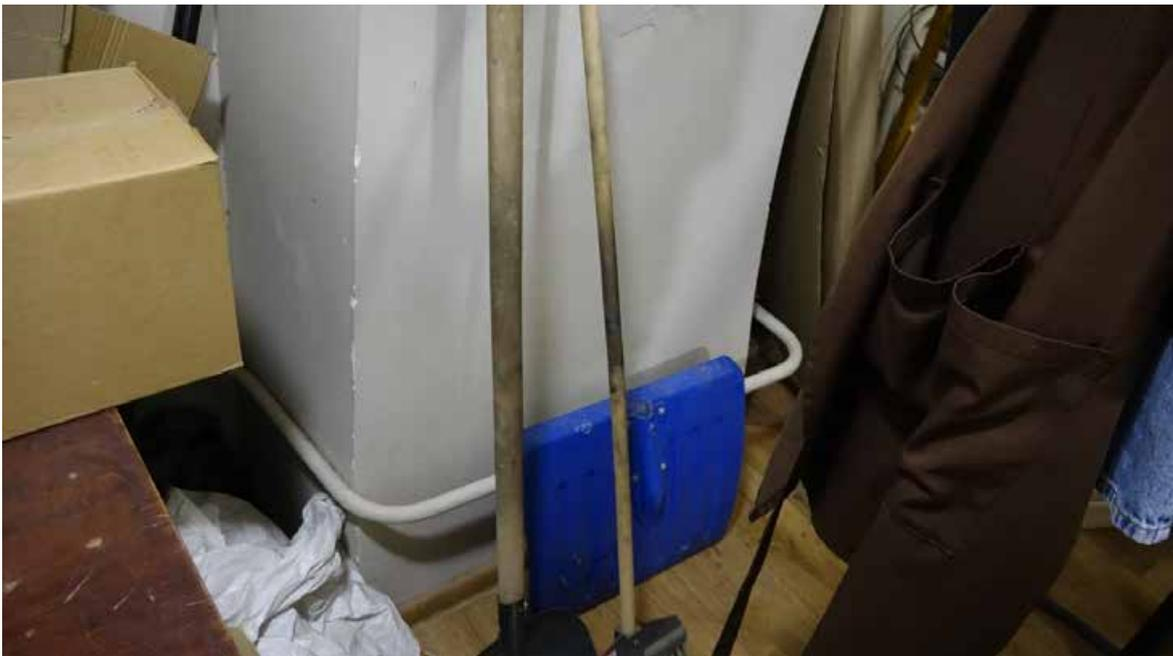
Фото 8. Окрашенный трубопровод в помещении 16. Теплоизоляция магистрали отсутствует. Фрагмент.
