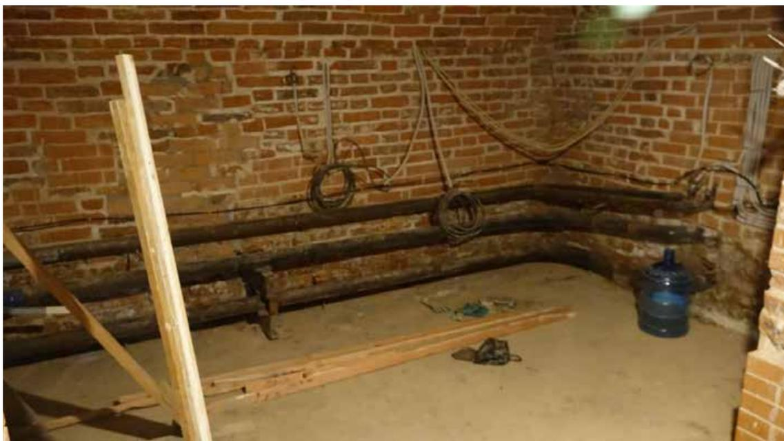
Фото 10. Стальной трубопровод в помещении 18, не окрашен. Теплоизоляция магистрали отсутствует.
