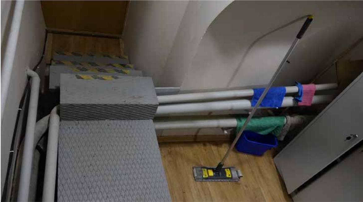
Фото 7. Окрашенный трубопровод в помещении 16. Теплоизоляция магистрали отсутствует.
