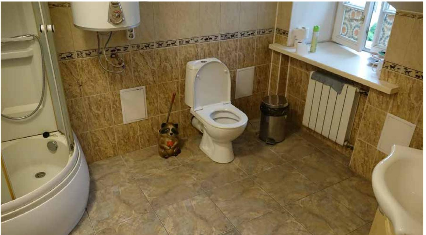
Фото 68. Туалет, секционный радиатор, душевая, накопительный водонагреватель в помещении 305.
