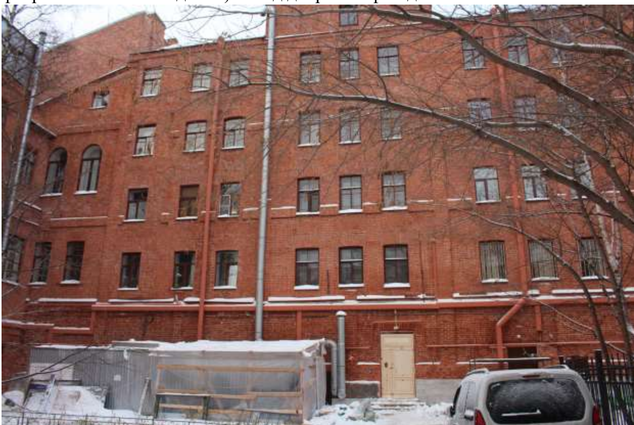
61. Выявленный объект культурного наследия «Дом Г.А. Хаймовича (при фабрике жестяных изделий)». Вид дворовые фасады.
