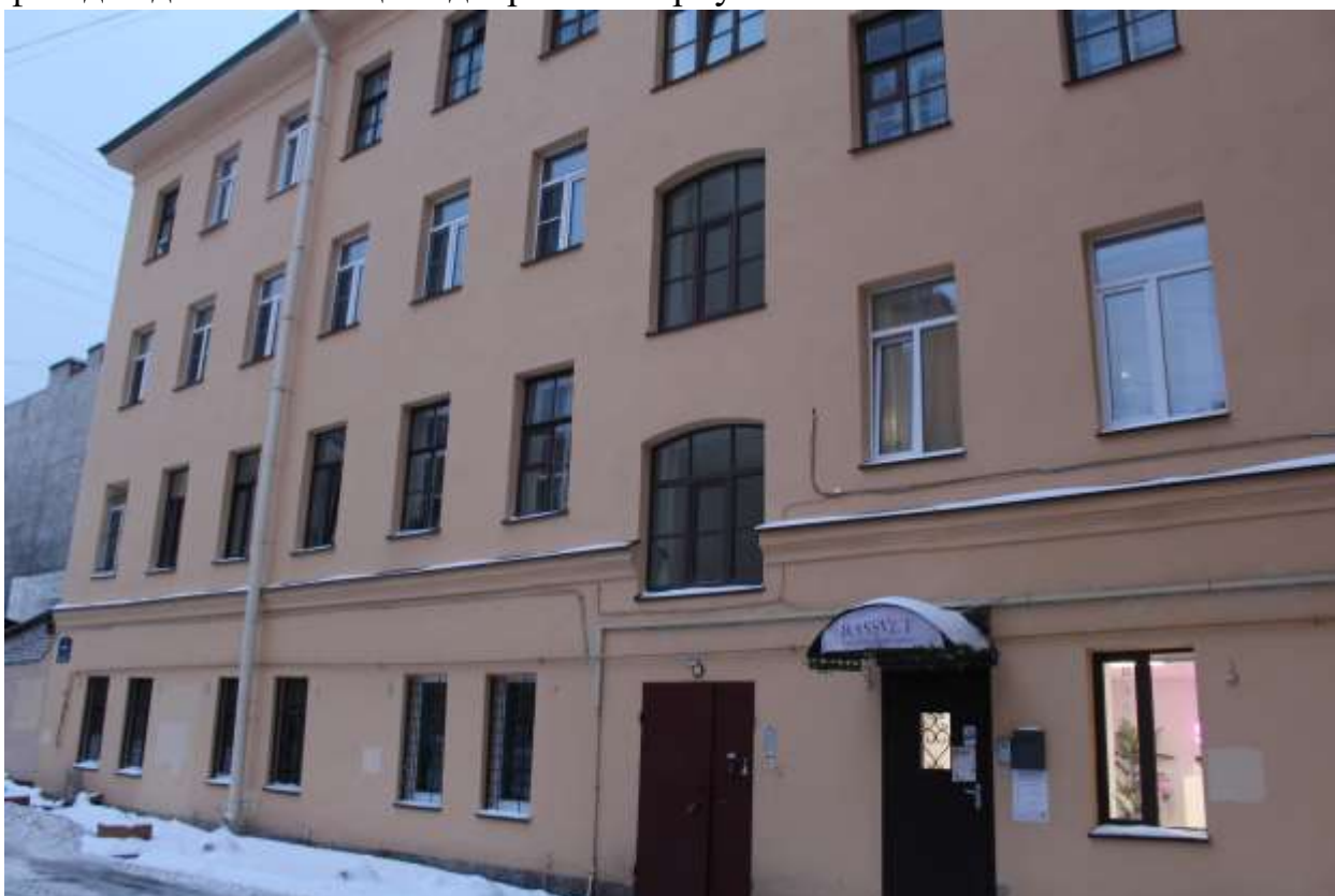
36. Выявленный объект культурного наследия «Дом В.А. Квасникова». Вид на фасад отдельно стоящего дворового корпуса.
