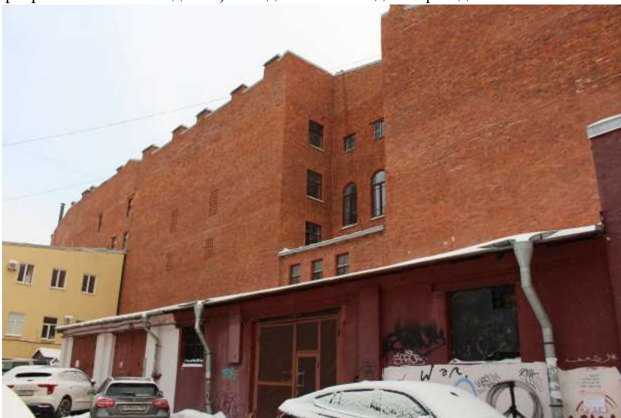
57. Выявленный объект культурного наследия «Дом Г.А. Хаймовича (при фабрике жестяных изделий)». Вид на северо-западный фасад.
