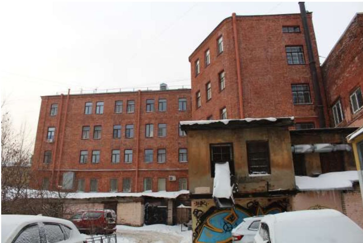
64. Выявленный объект культурного наследия «Дом Г.А. Хаймовича (при фабрике жестяных изделий)». Вид дворовые фасады.
