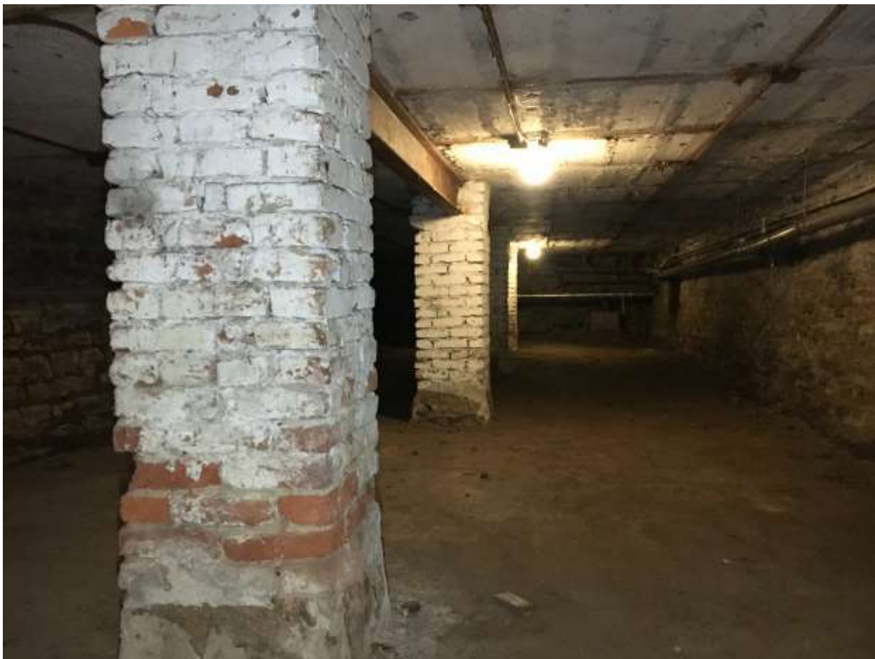
75. Выявленный объект культурного наследия «Богадельня для женщин». Вид на подвальное помещение.
