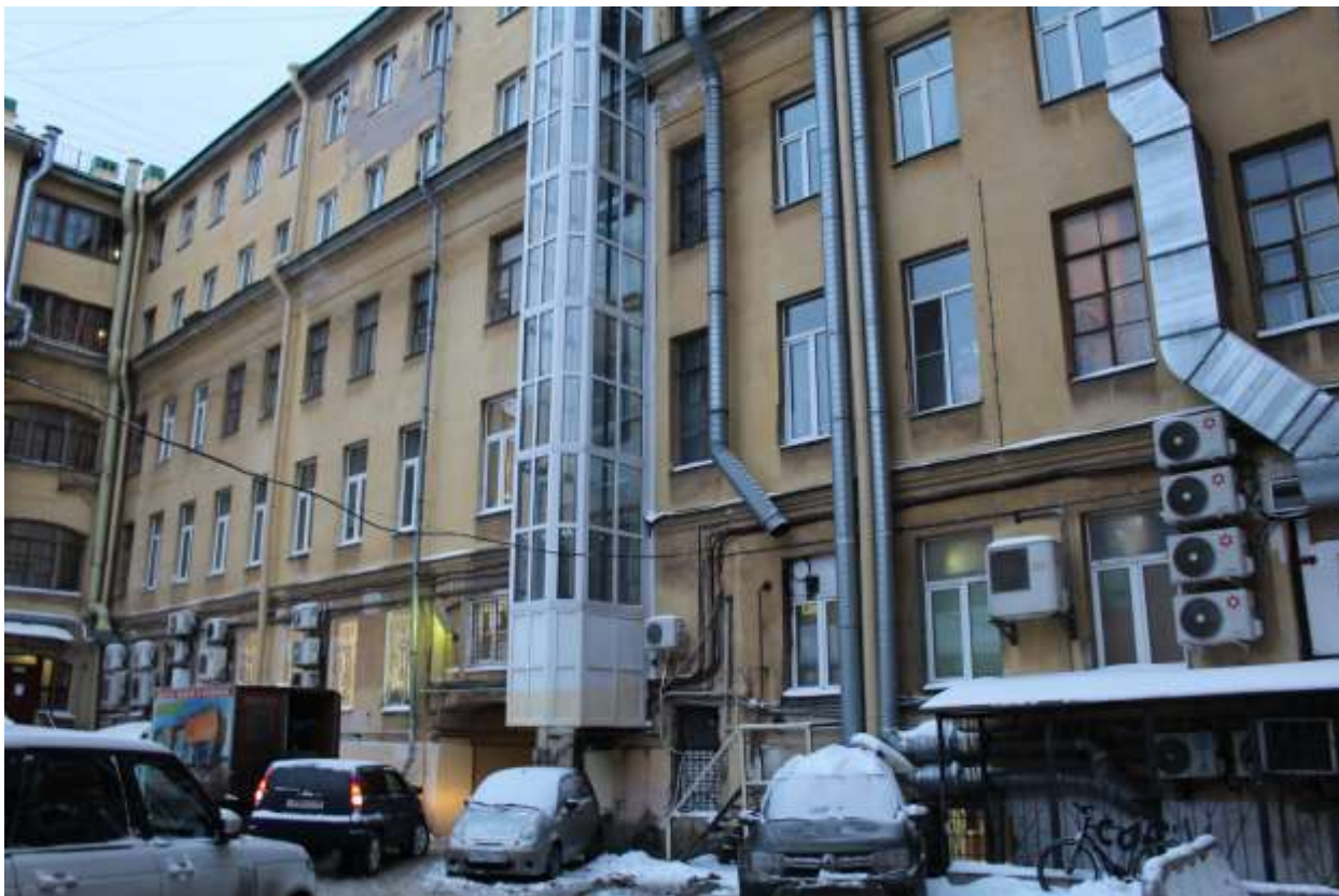
25. Выявленный объект культурного наследия «Дом К. Штрауха». Вид на дворовые фасады.
