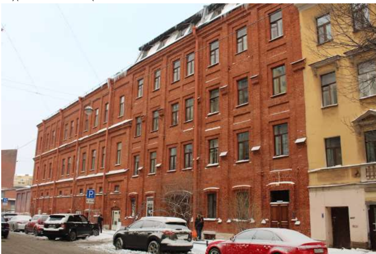
55. Выявленный объект культурного наследия «Дом Г.А. Хаймовича (при фабрике жестяных изделий)». Вид на юго-западный фасад.
