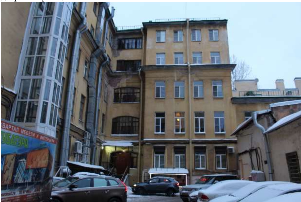
26. Выявленный объект культурного наследия «Дом К. Штрауха». Вид на дворовые фасады.
