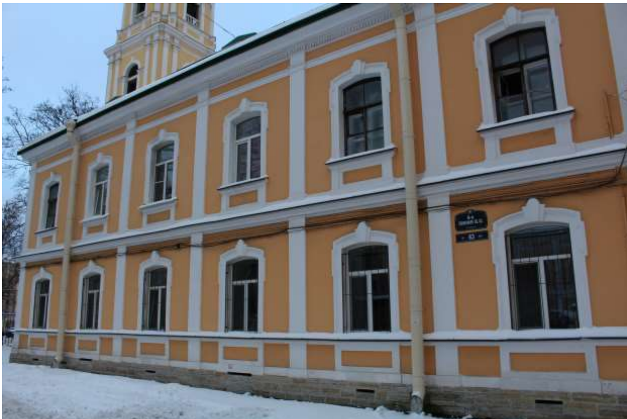
71. Выявленный объект культурного наследия «Богдельня для женщин». Вид на юго-западный фасад.
