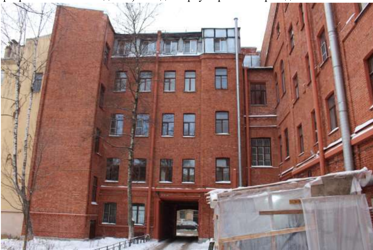
59. Выявленный объект культурного наследия «Дом Г.А. Хаймовича (при фабрике жестяных изделий)». Вид дворовые фасады.
