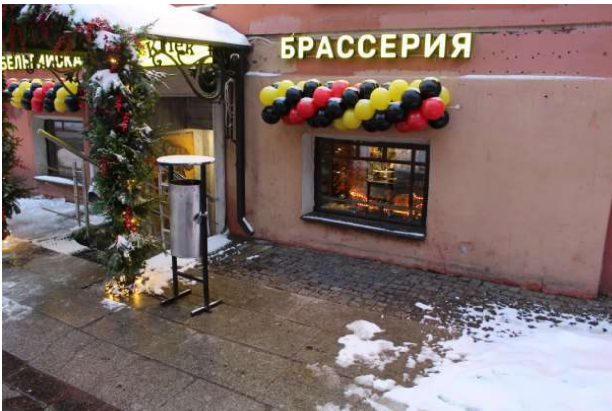
27. Выявленный объект культурного наследия «Дом К. Штрауха». Вид на ввод теплосети со стороны 6-й линии В.О.
