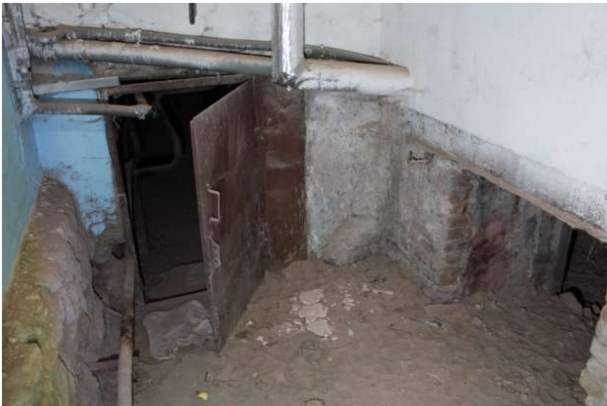
67. Выявленный объект культурного наследия «Дом Г.А. Хаймовича (при фабрике жестяных изделий)». Подвал четырехэтажного с мансардой корпуса.
