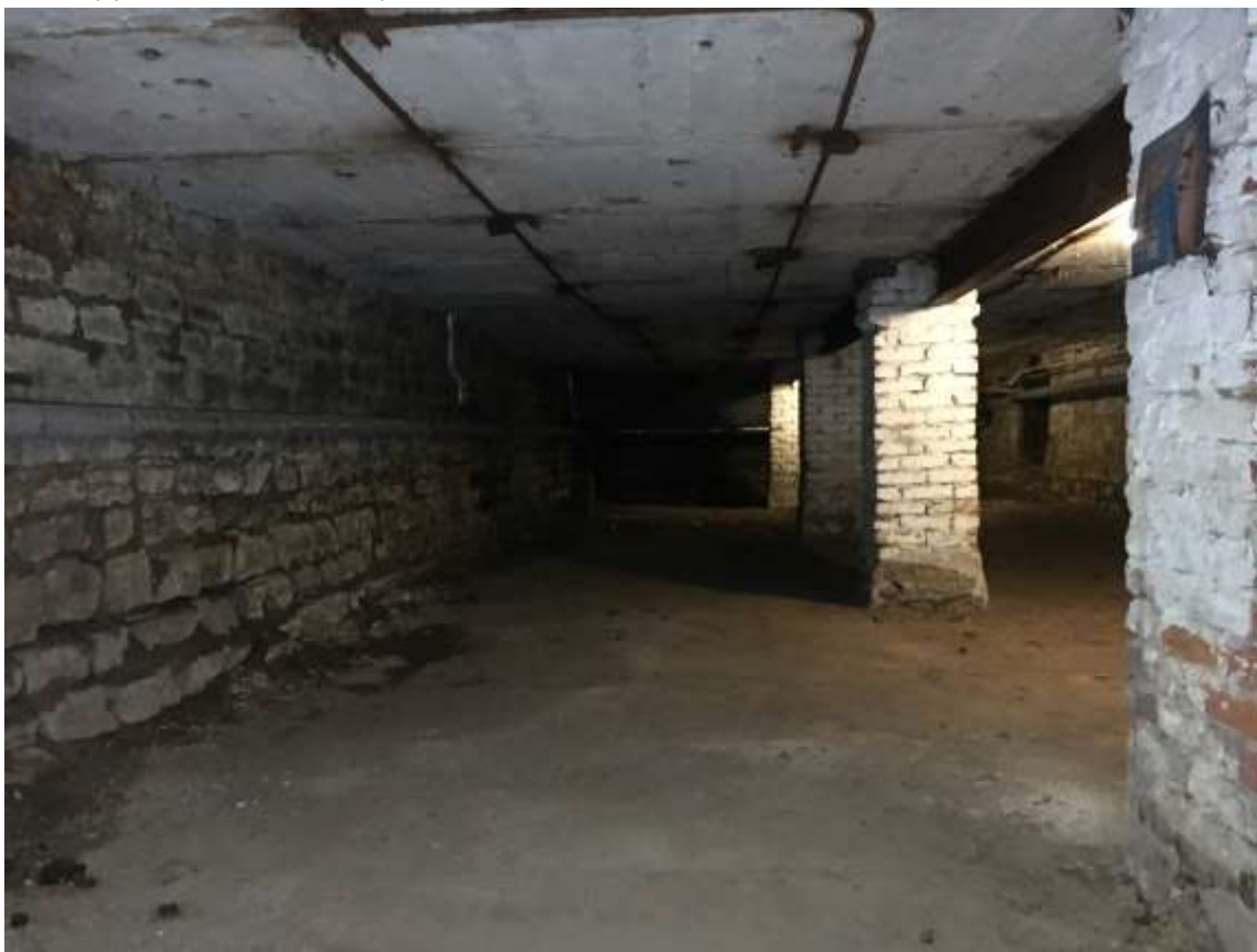
76. Выявленный объект культурного наследия «Богадельня для женщин». Вид на подвальное помещение.
