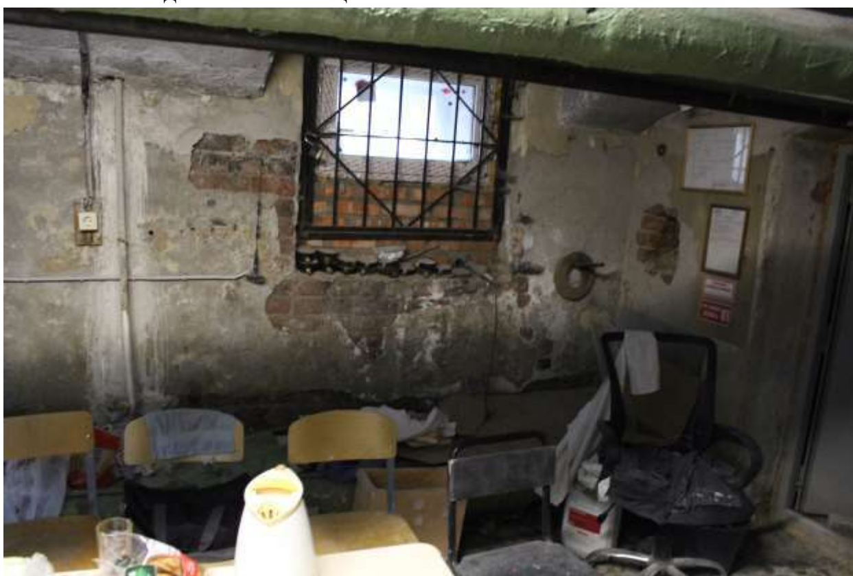
53. Выявленный объект культурного наследия «Городской дом 1-го Василеостровского начального народного училища». Вид на трубы теплосети в подвальном помещении.
