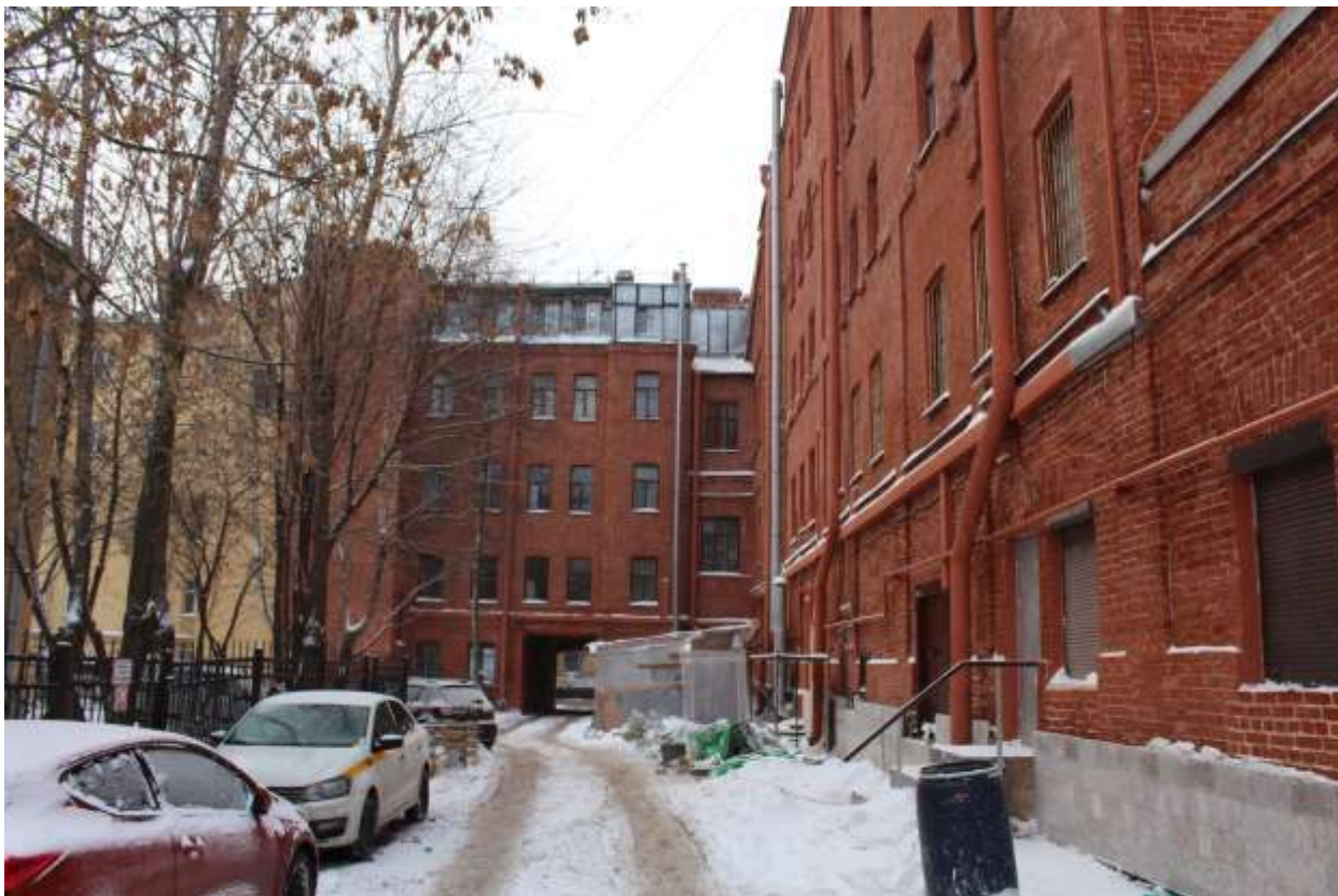
60. Выявленный объект культурного наследия «Дом Г.А. Хаймовича (при фабрике жестяных изделий)». Вид дворовые фасады.
