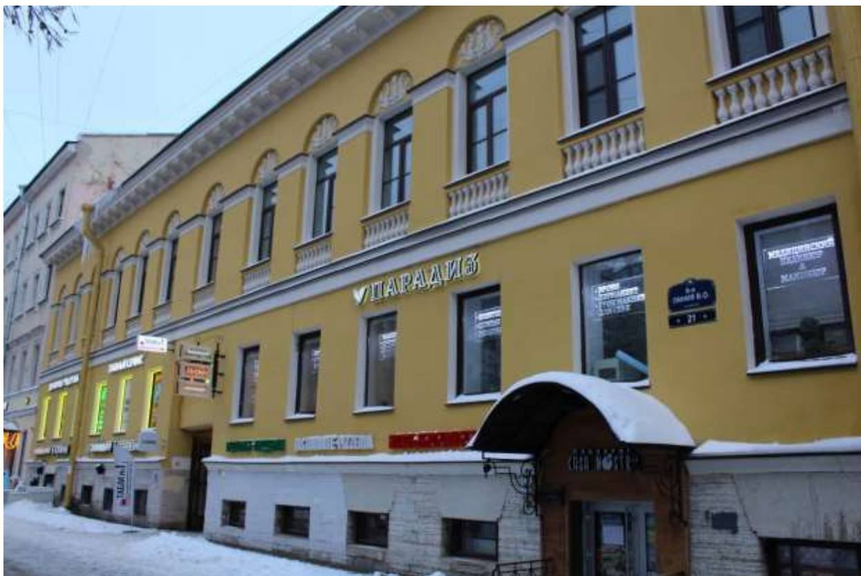
13. Выявленный объект культурного наследия «Дом И. Ковригина». Вид на юго-западный фасад.
