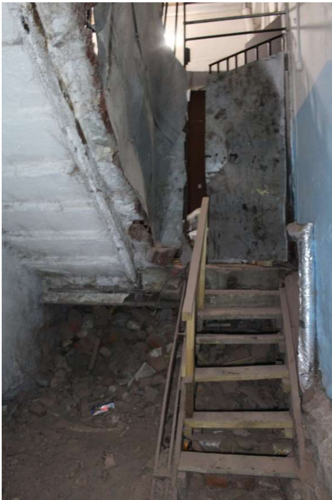
66. Выявленный объект культурного наследия «Дом Г.А. Хаймовича (при фабрике жестяных изделий)». Спуск в подвал четырехэтажного с мансардой корпуса.
