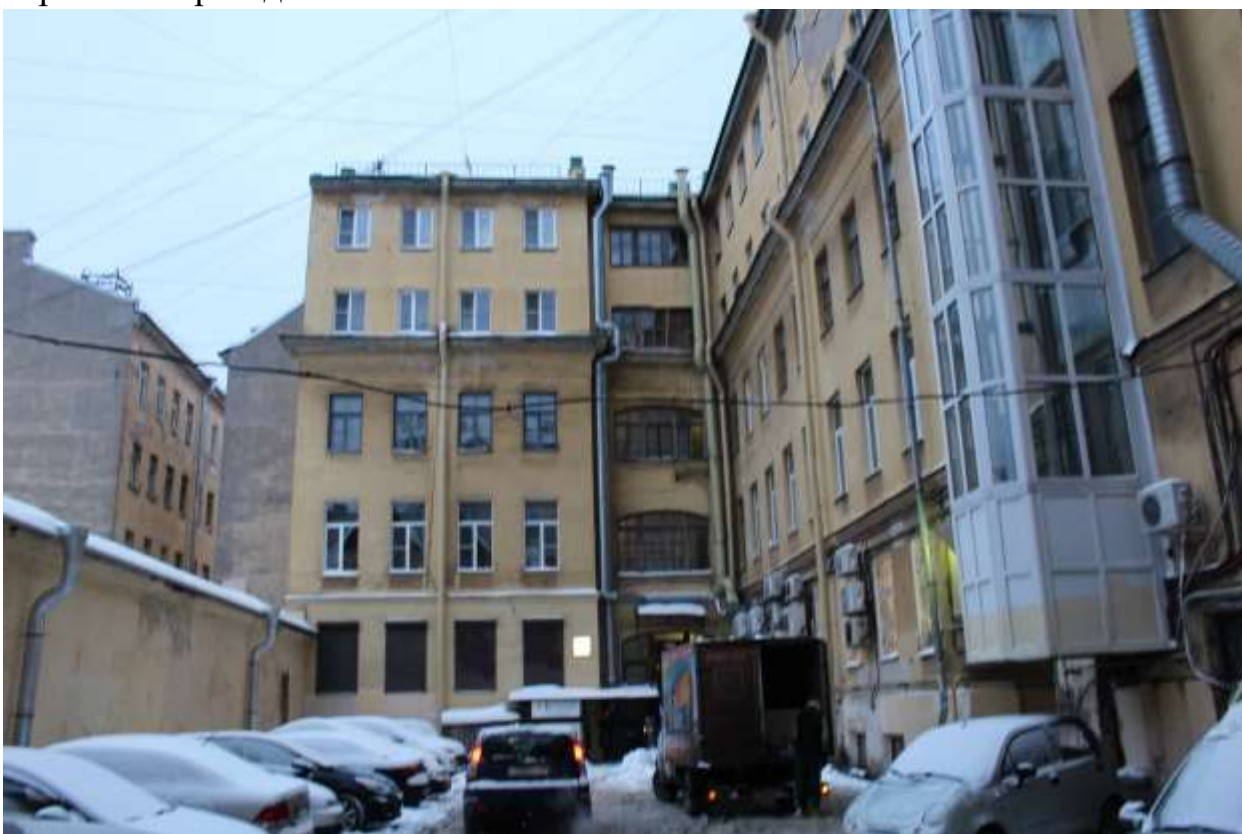
24. Выявленный объект культурного наследия «Дом К. Штрауха». Вид на дворовые фасады.
