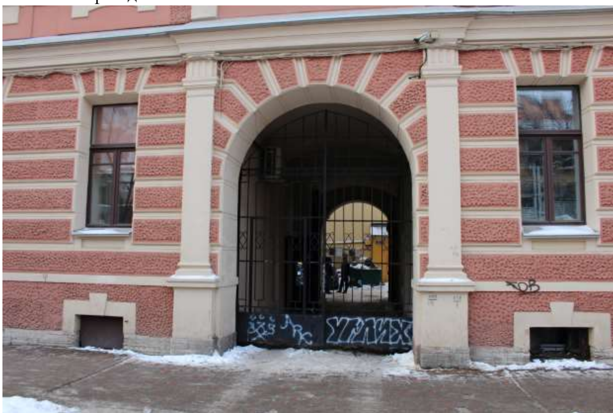
42. Выявленный объект культурного наследия «Городской дом 1-го Василеостровского начального народного училища». Вид на арку воротного проезда.
