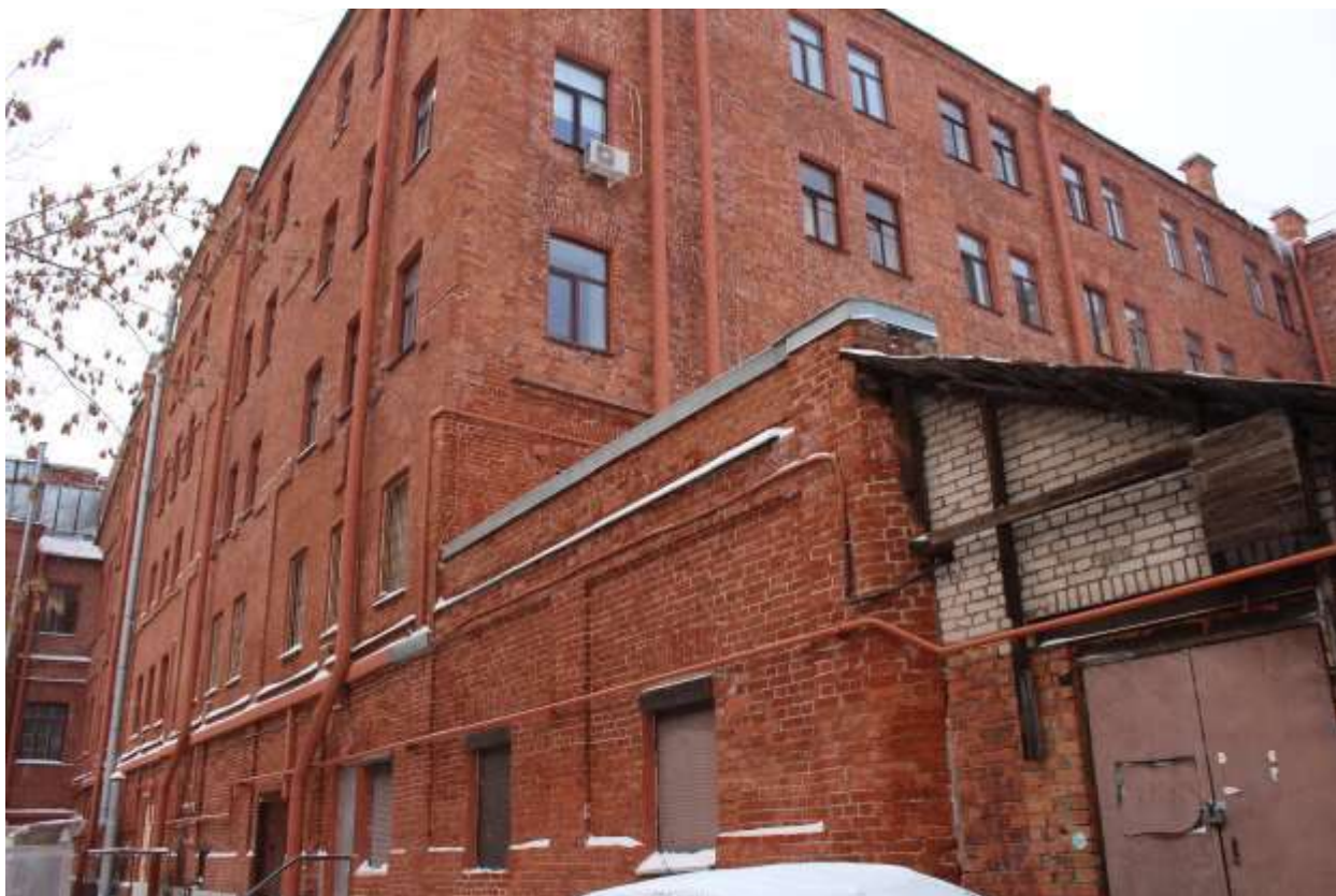
62. Выявленный объект культурного наследия «Дом Г.А. Хаймовича (при фабрике жестяных изделий)». Вид дворовые фасады.
