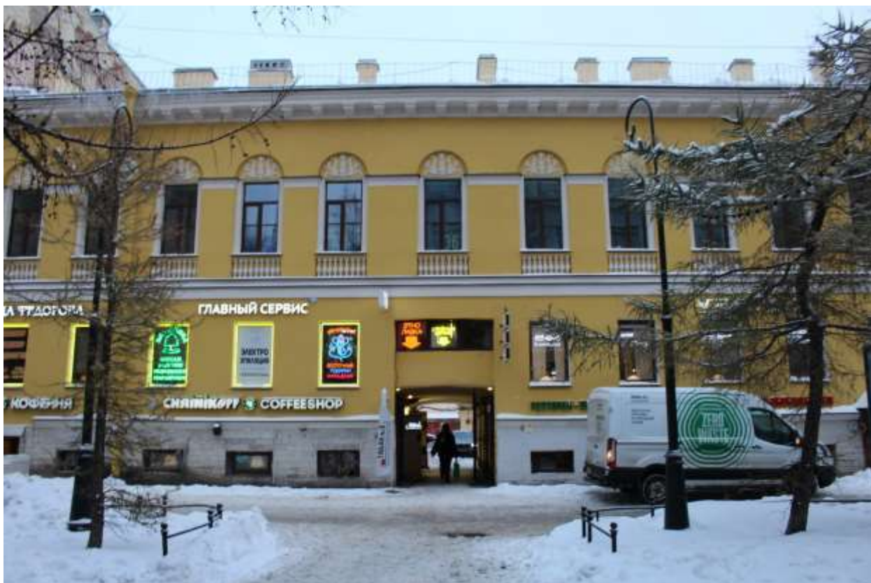
11. Выявленный объект культурного наследия «Дом И. Ковригина». Вид на юго-западный фасад.
