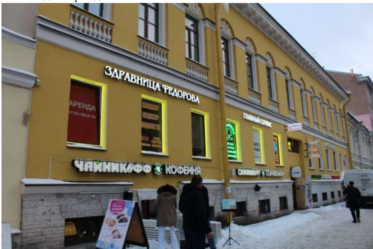
12. Выявленный объект культурного наследия «Дом И. Ковригина». Вид на юго-западный фасад.
