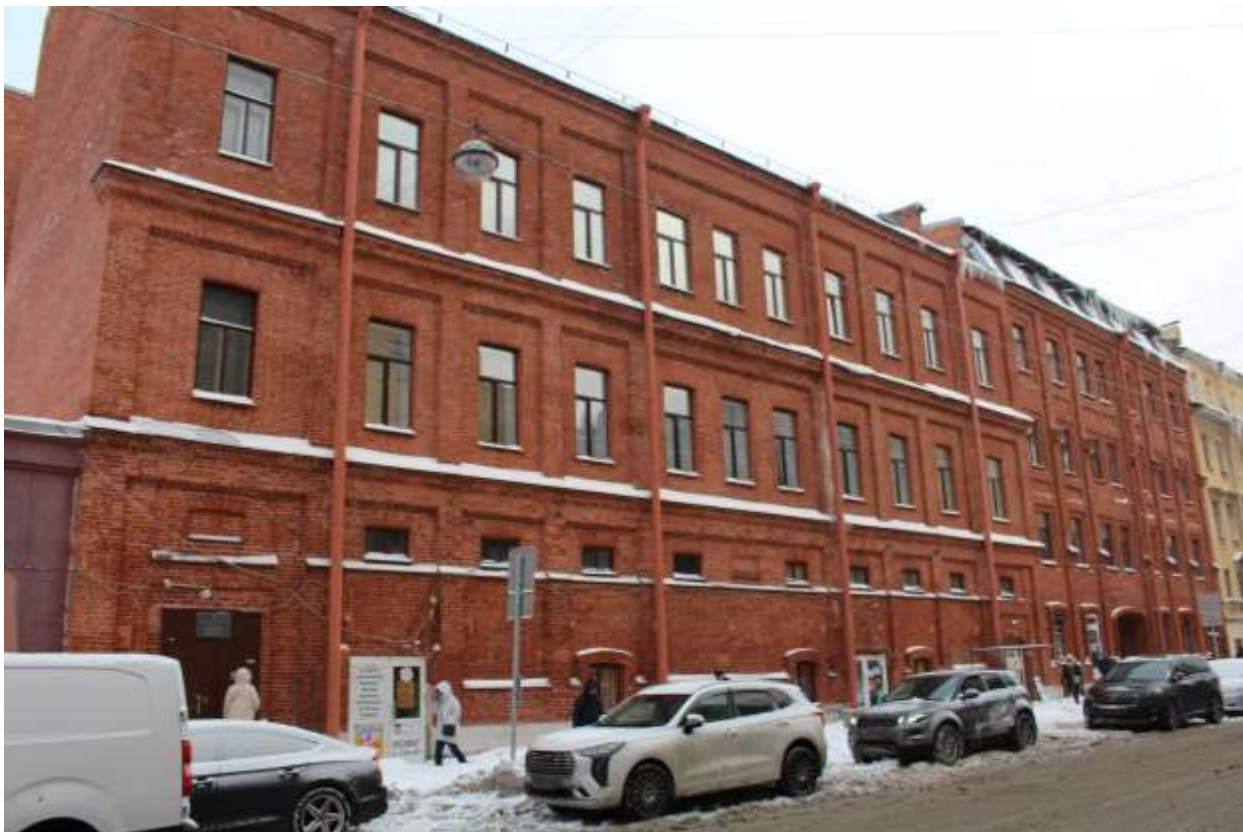
56. Выявленный объект культурного наследия «Дом Г.А. Хаймовича (при фабрике жестяных изделий)». Вид на юго-западный фасад.
