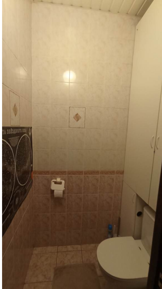
35. Квартира №25. Вид в помещении 5. Фотофиксация от 19.06.2024 г.
