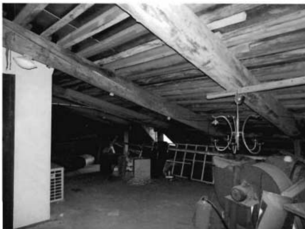
15. Стропильная система
