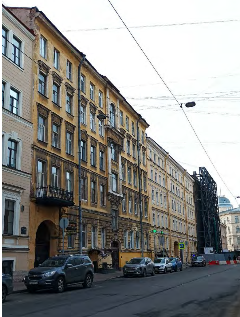
24. Объект культурного наследия регионального значения: «Дом, где жила хореограф Ваганова Агриппина Яковлевна в 1904-1937 гг. (кв. 12, 13, 14 - б. кв. 5)», по адресу: Санкт-Петербург, Бронницкая ул., д. 7. Главный фасад. Фрагмент. Дата съемки: 27.03.2024г.
