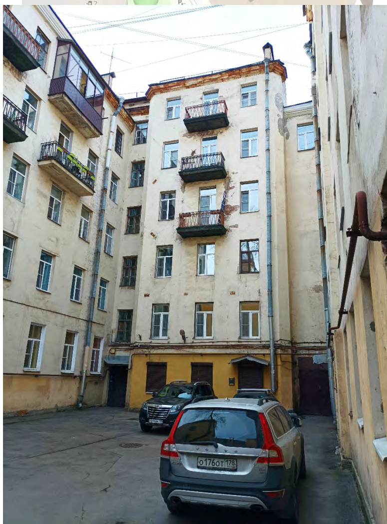
35. Объект культурного наследия регионального значения: «Дом, где жила хореограф Ваганова Агриппина Яковлевна в 1904-1937 гг. (кв. 12, 13, 14 - б. кв. 5)», по адресу: Санкт-Петербург, Бронницкая ул., д. 7. Дворовый фасад. Дата съемки: 27.03.2024г.
