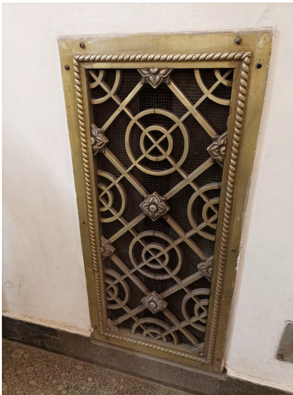
9. Объект культурного наследия регионального значения: «Станция метро «Технологический институт» (с перронным залом)», по адресу: Санкт-Петербург, Московский пр., д. 28, литера А. Вестибюль «Вход». Вентиляционная решетка. Дата съемки: 27.03.2024г.
