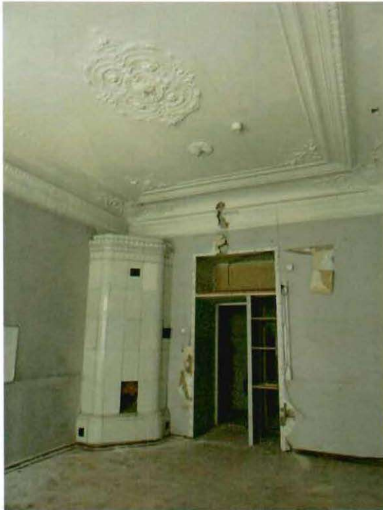
5. Помещение 1 этажа (14-Н(8)).
