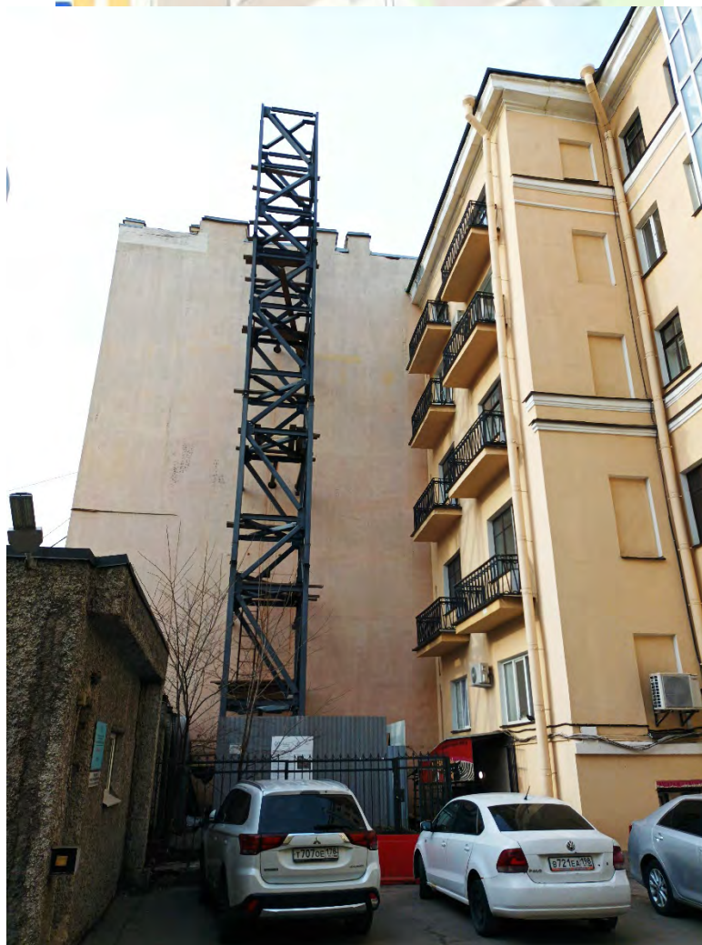
23. Объект культурного наследия регионального значения: «Дом Е.С. и М.Б. Трофимовых», по адресу: Санкт-Петербург, Бронницкая ул., д. 1-3, Дворовый фасад. Дата съемки: 27.03.2024г.
