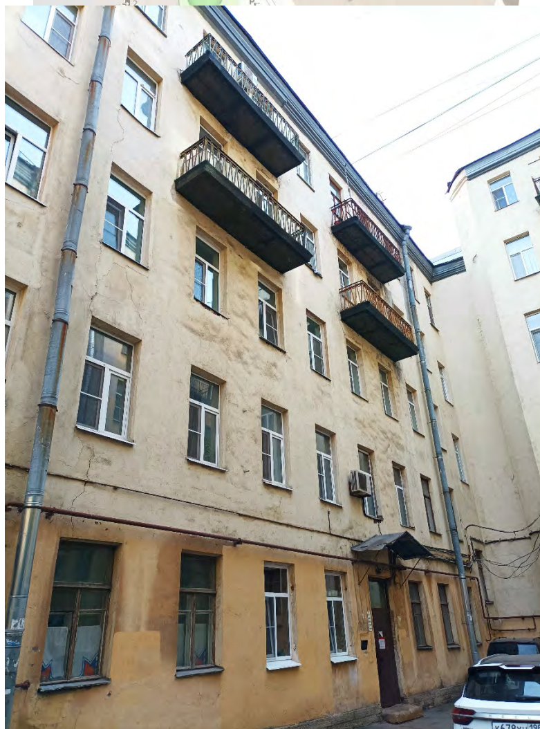
32. Объект культурного наследия регионального значения: «Дом, где жила хореограф Ваганова Агриппина Яковлевна в 1904-1937 гг. (кв. 12, 13, 14 - б. кв. 5)», по адресу: Санкт-Петербург, Бронницкая ул., д. 7. Дворовый фасад. Дата съемки: 27.03.2024г.
