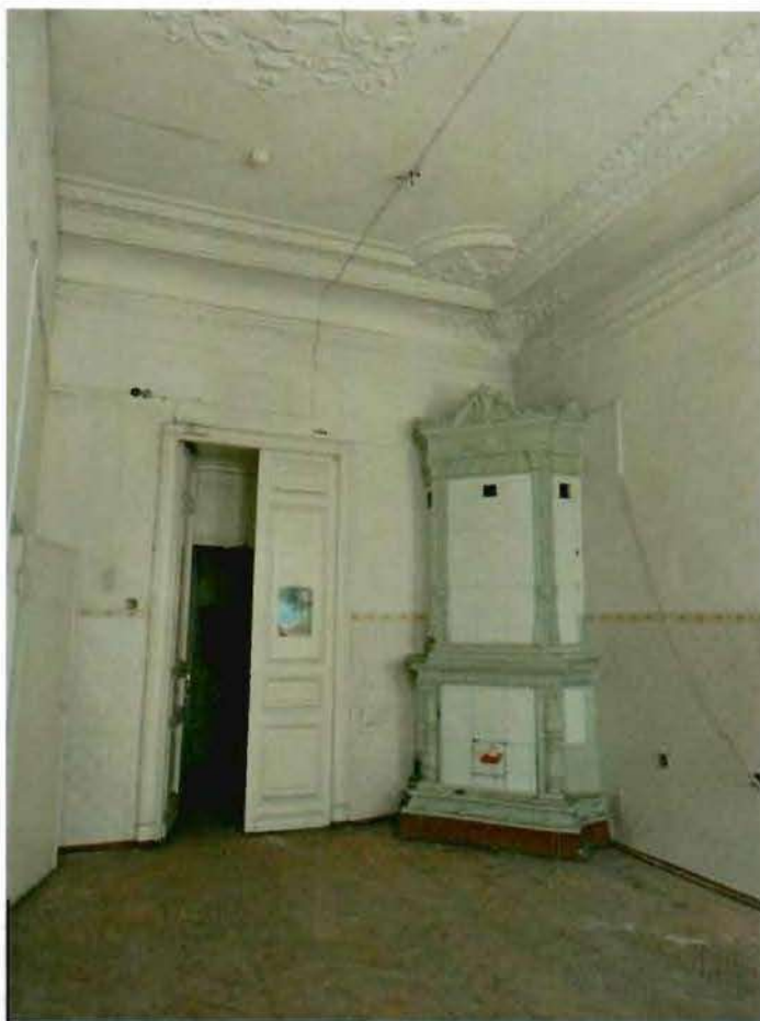
6. Помещение 2 этажа (18-Н(16)).
