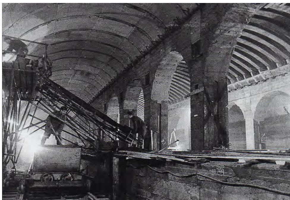
18. Строительство станции метро "Технологический институт" 1954-1955 гг. Источник: www.pastvu.com
