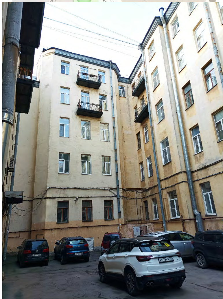
31. Объект культурного наследия регионального значения: «Дом, где жила хореограф Ваганова Агриппина Яковлевна в 1904-1937 гг. (кв. 12, 13, 14 - б. кв. 5)», по адресу: Санкт-Петербург, Бронницкая ул., д. 7. Дворовый фасад. Дата съемки: 27.03.2024г.
