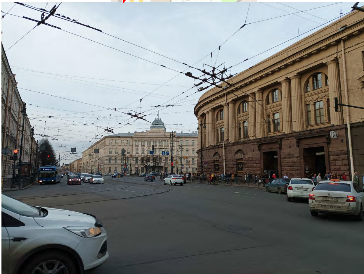
2. Объект культурного наследия регионального значения: «Станция метро «Технологический институт» (с перронным залом)», по адресу: Санкт-Петербург, Московский пр., д. 28, литера А. Общий вид объекта. Дата съемки: 27.03.2024г.
