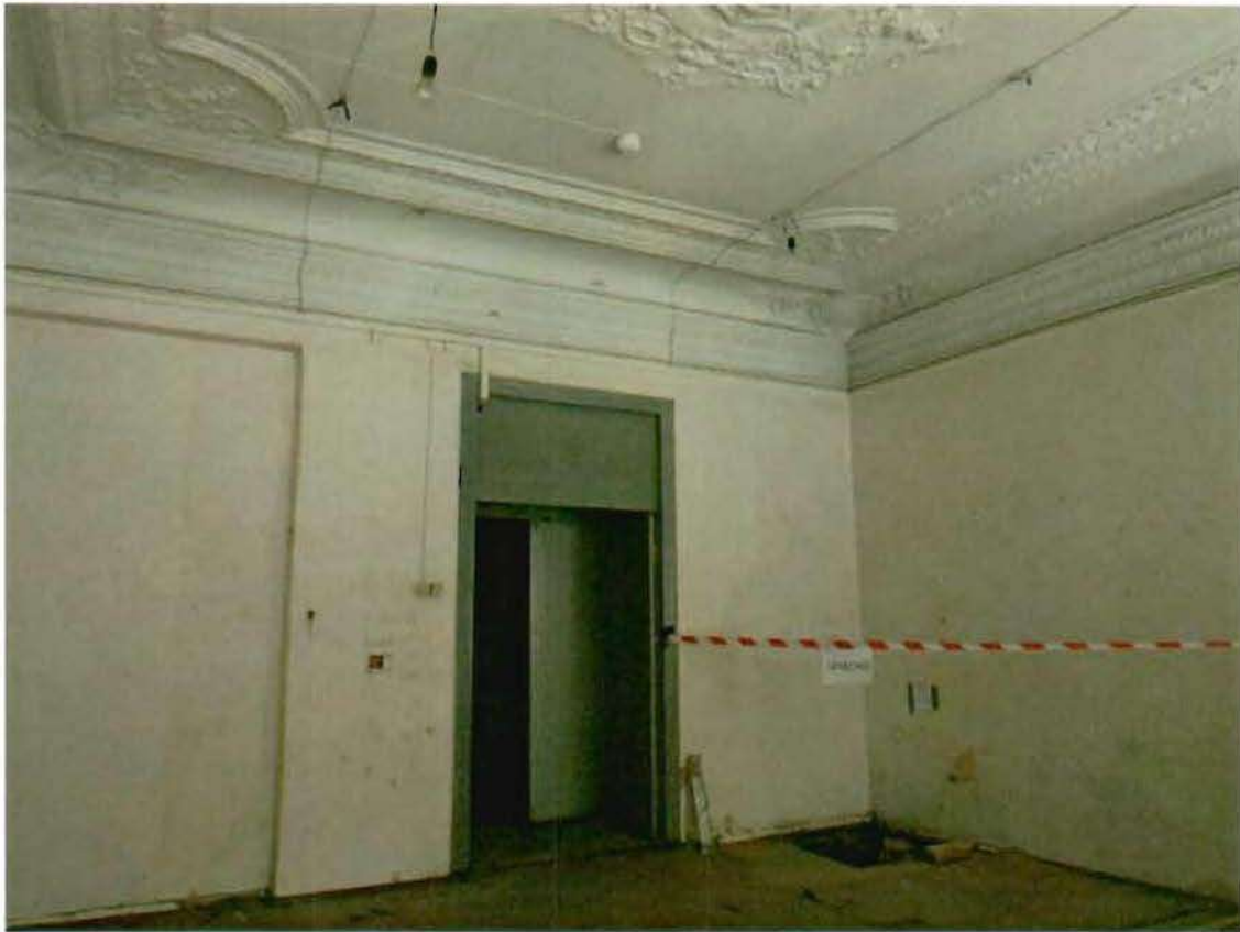
4. Помещение 1 этажа (13-Н(17)).
