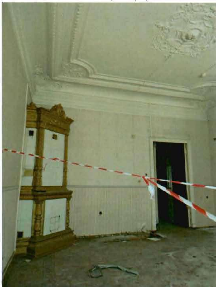
7. Помещение 2 этажа (19-Н(3)).
