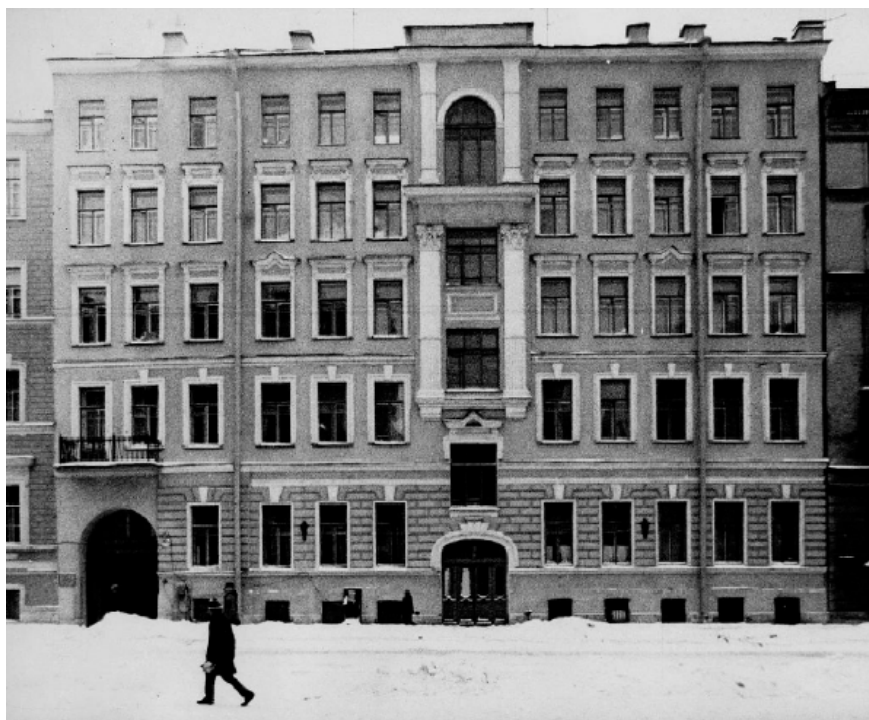
68. Ленинград, улица Бронницкая, дом №7. Главный (лицевой) фасад. Фото 1978 г. Источник: Архив КГИОП. Паспорт памятника.
