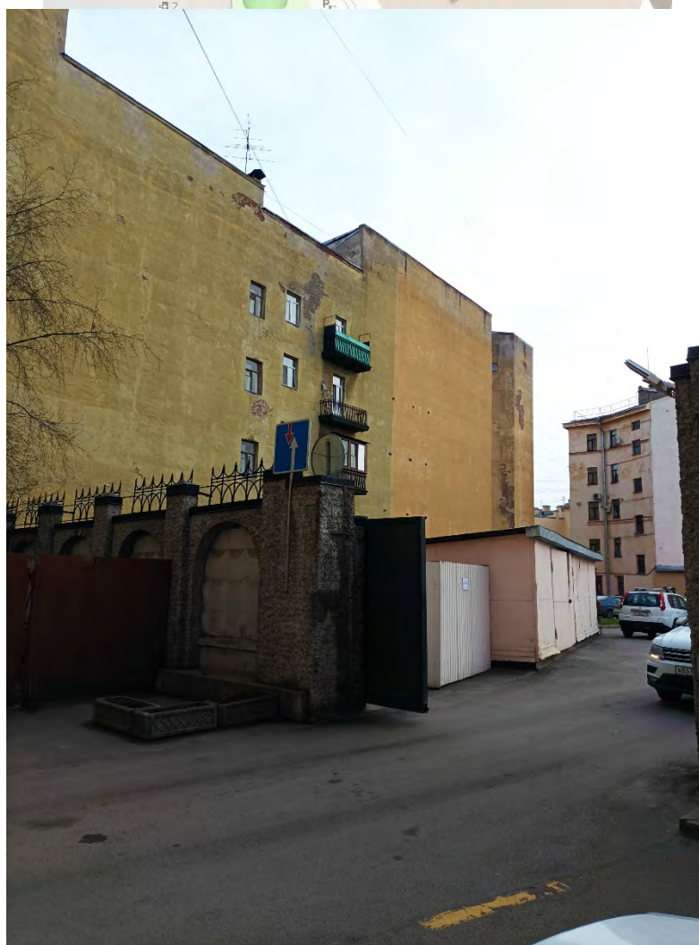
29. Объект культурного наследия регионального значения: «Дом, где жила хореограф Ваганова Агриппина Яковлевна в 1904-1937 гг. (кв. 12, 13, 14 - б. кв. 5)», по адресу: Санкт-Петербург, Бронницкая ул., д. 7. Дворовый фасад. Дата съемки: 27.03.2024г.
