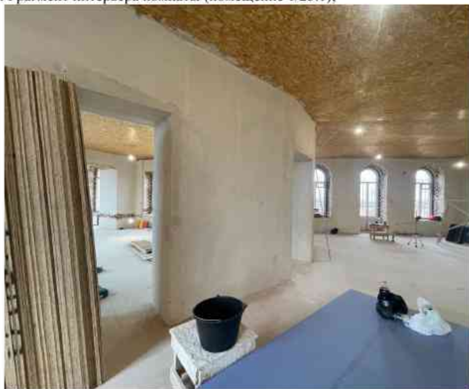
23. Фрагмент интерьера комнаты (помещение 1/25.1);
