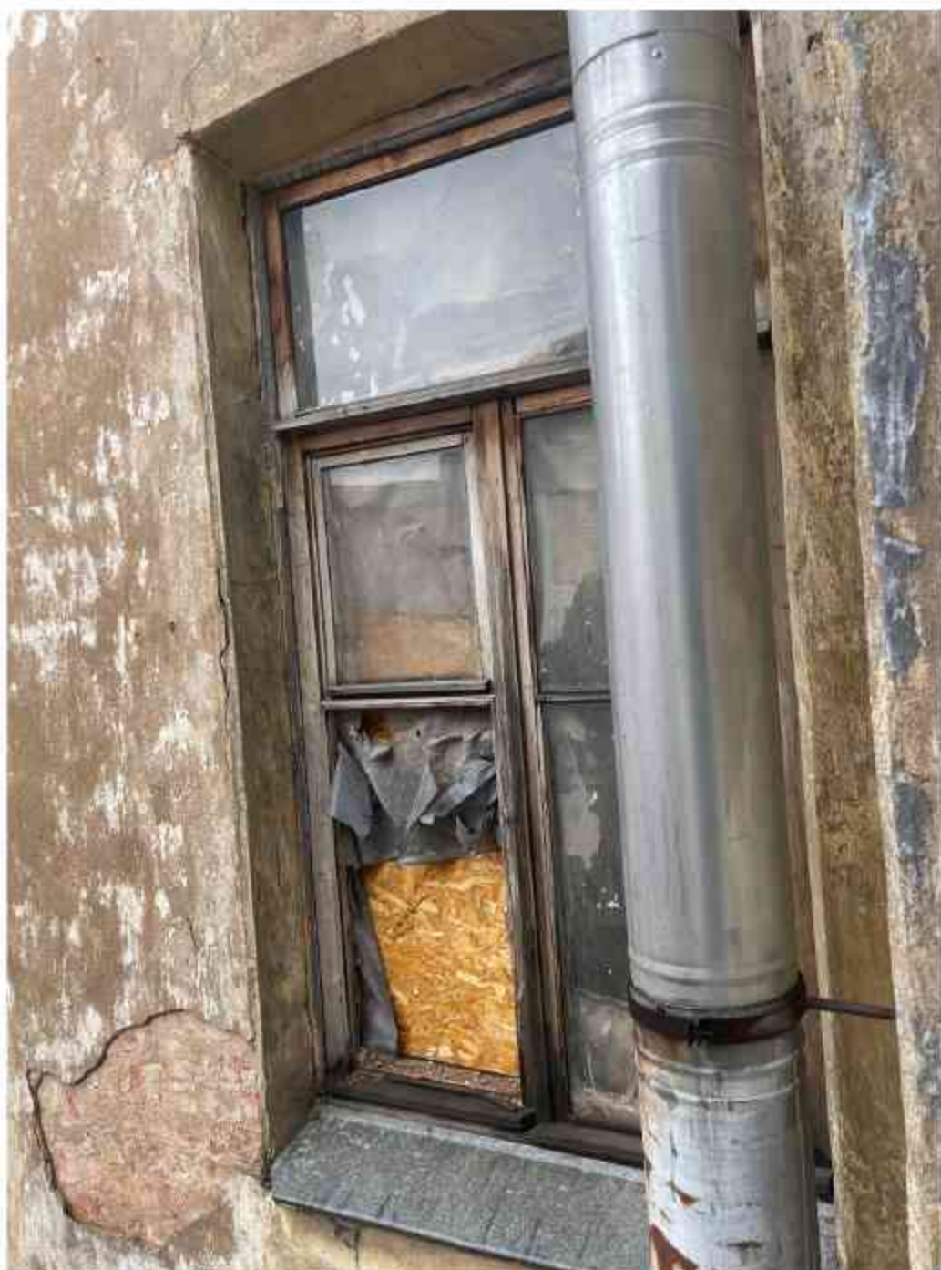
6. Вид на дворовой фасад объекта культурного наследия регионального значения «Дом В.А. Раткова-Рожнова», расположенного по адресу: Санкт-Петербург, Казначейская улица, дом 6/13, литера А;
