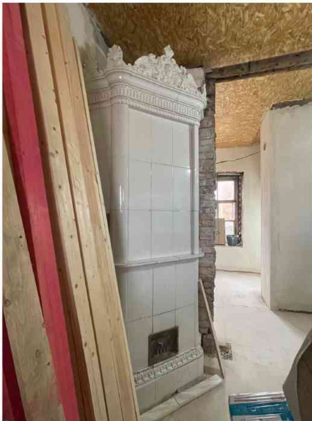
13. Вид на печь в комнате (помещение 2/20.7);
