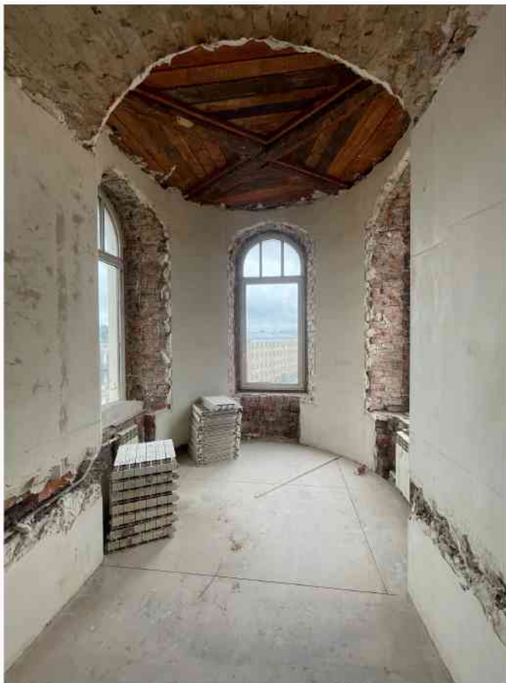
28. Фрагмент интерьера комнаты (помещение 2/63.3);
