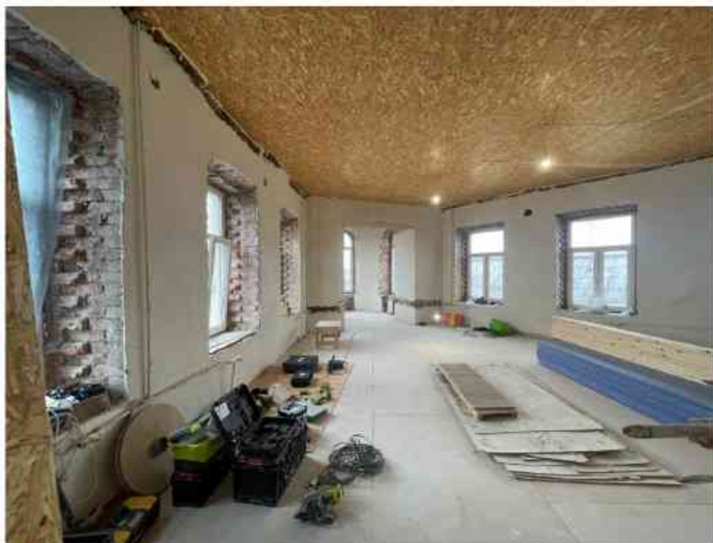
26.Фрагмент интерьера комнаты (помещение 2/63.3);
