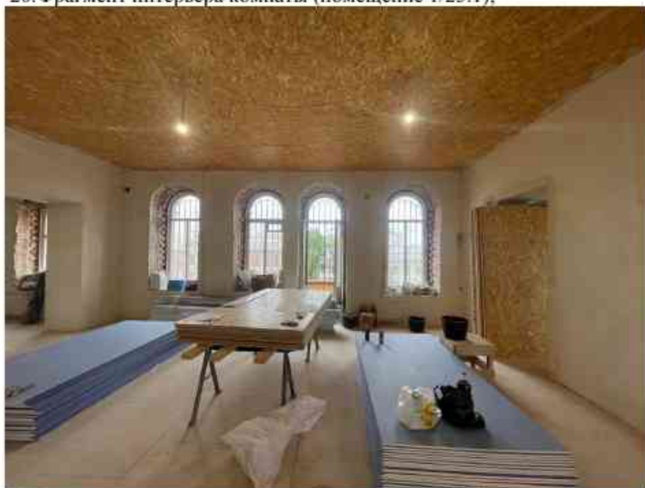
21. Фрагмент интерьера комнаты (помещение 1/25.1);
