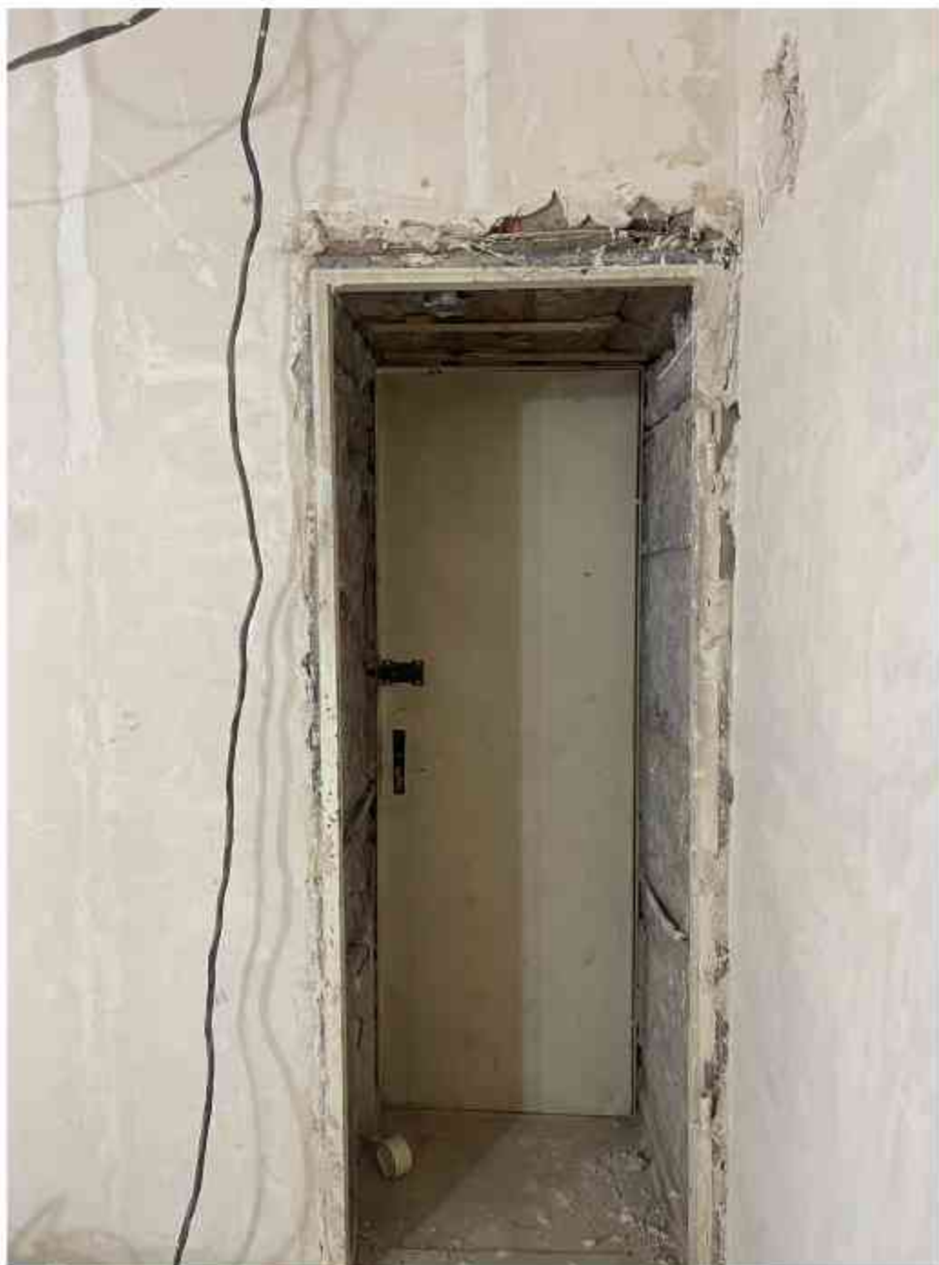
8. Вид на входную дверь в квартире;
