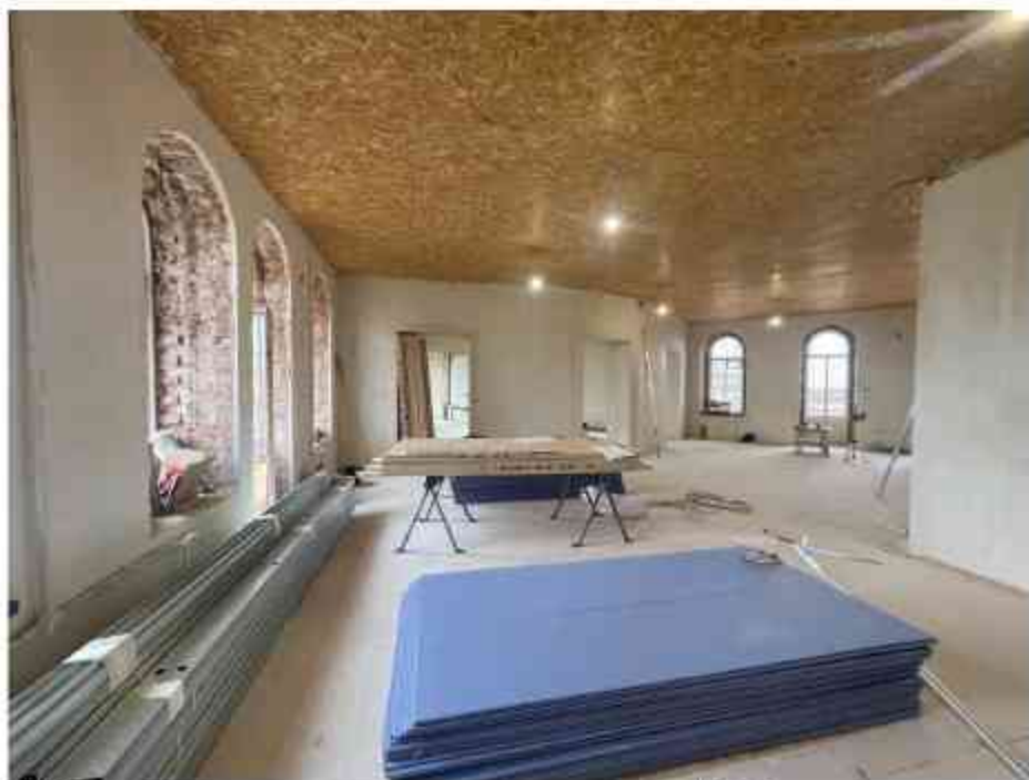
20. Фрагмент интерьера комнаты (помещение 1/25.1);
