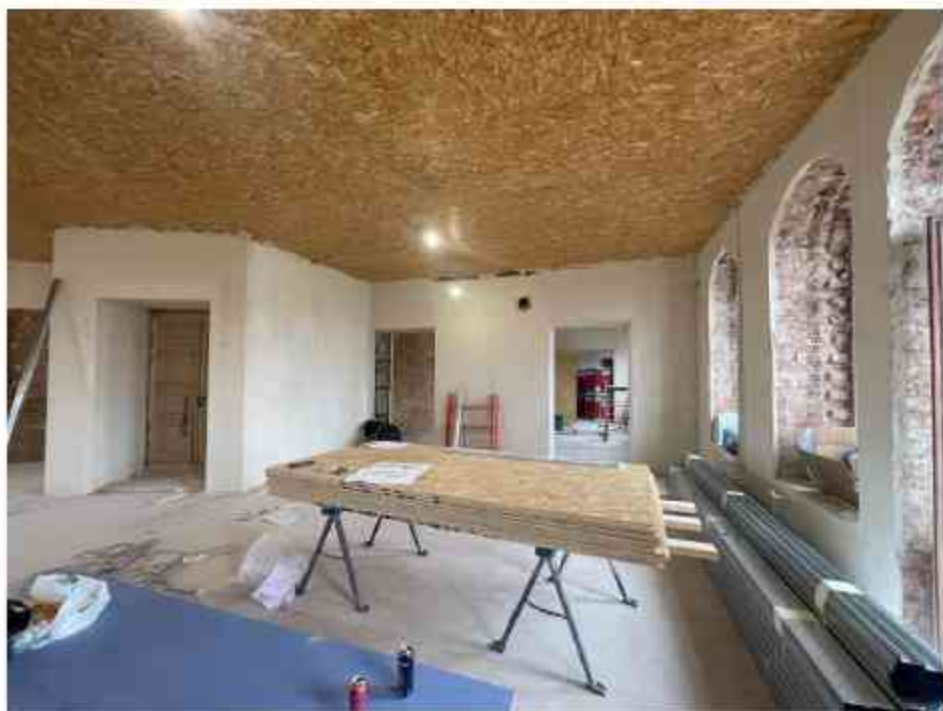
22. Фрагмент интерьера комнаты (помещение 1/25.1);
