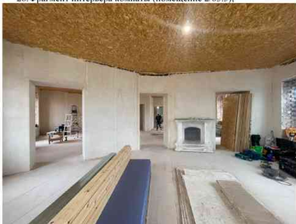
27.Фрагмент интерьера комнаты (помещение 2/63.3);
