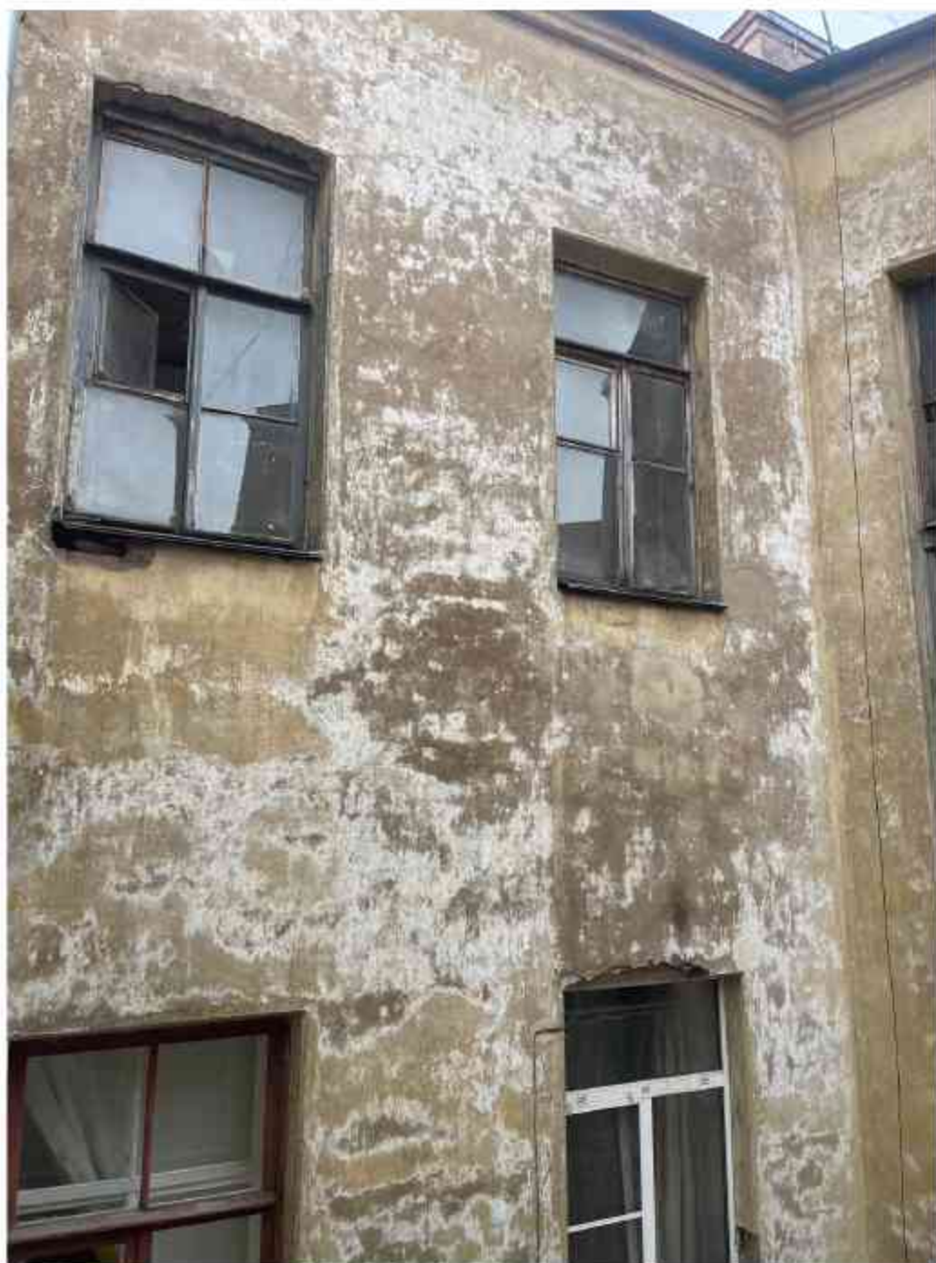
5. Вид на дворовой фасад объекта культурного наследия регионального значения «Дом В.А. Ратькова-Рожнова», расположенного по адресу: Санкт-Петербург, Казначейская улица, дом 6/13, литера А;
