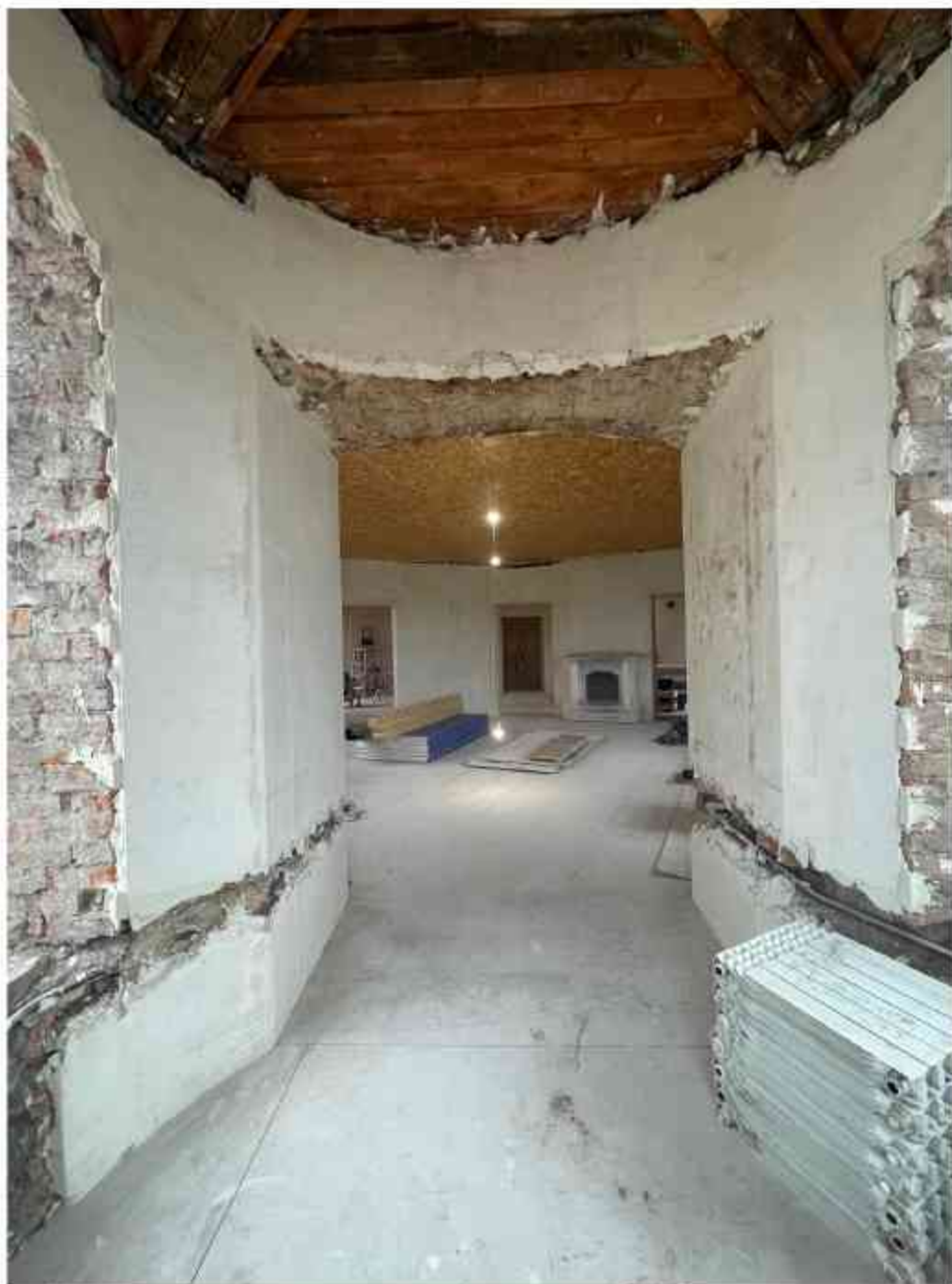
29. Фрагмент интерьера комнаты (помещение 2/63.3).
