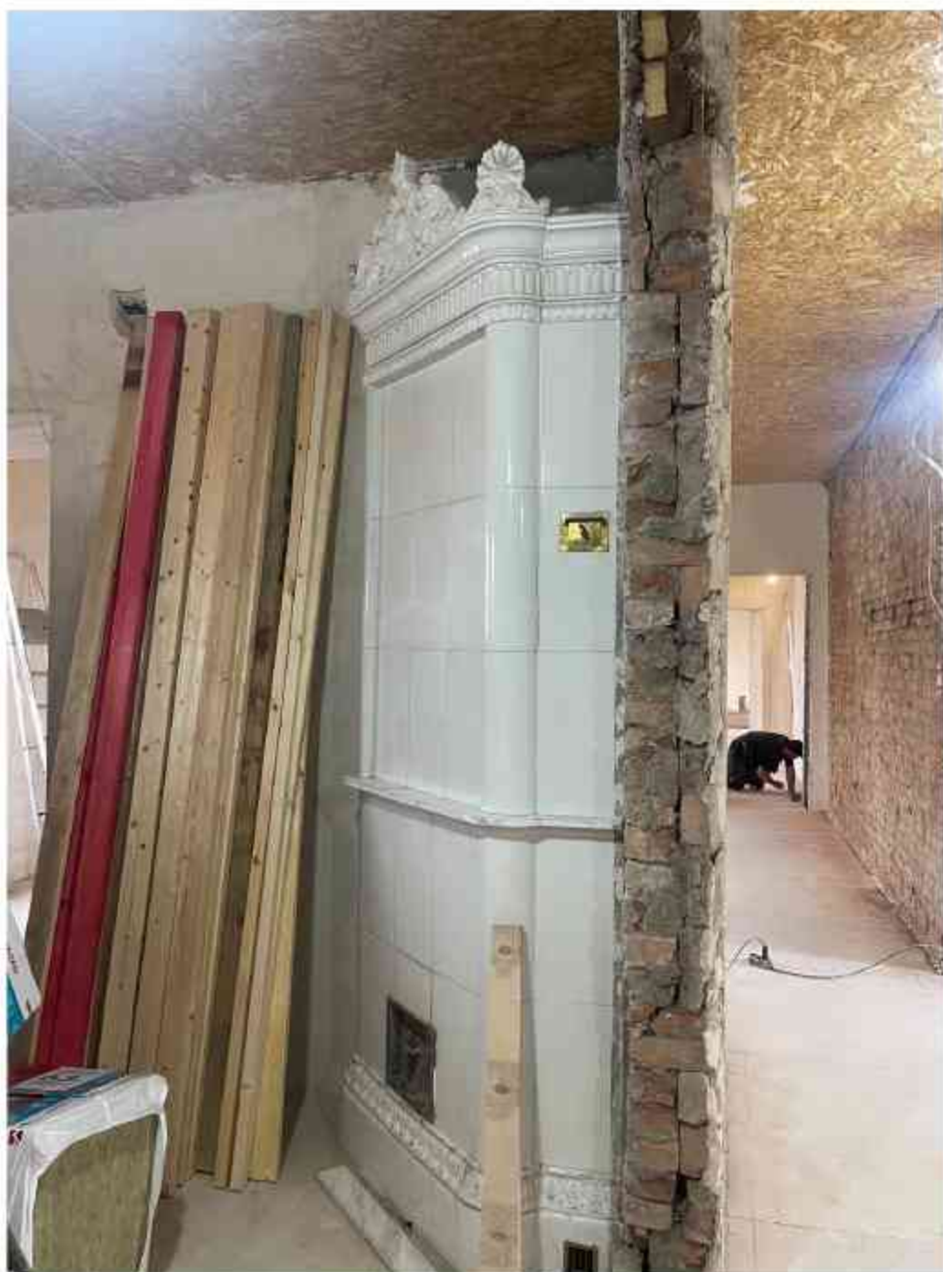
12. Вид на печь в комнате (помещение 2/20.7);
