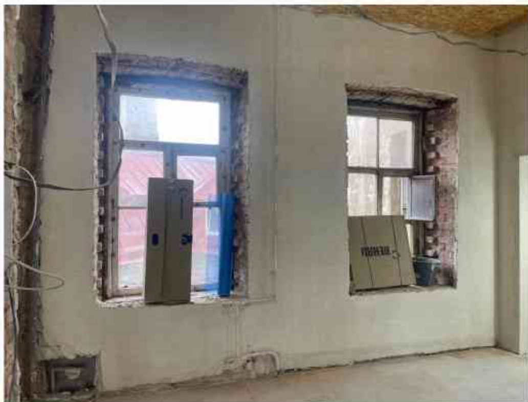
11. Фрагмент интерьера комнаты (помещение 2/20.7);
