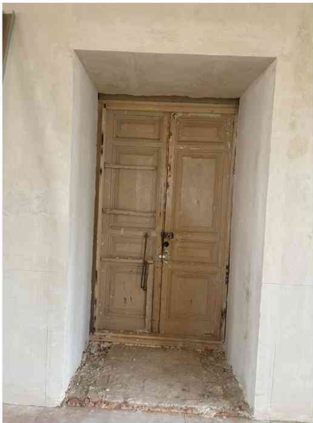
24. Вид на входную дверь в квартире;
