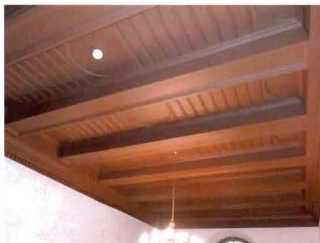
8. Оформление потолка над лестничной клеткой.
