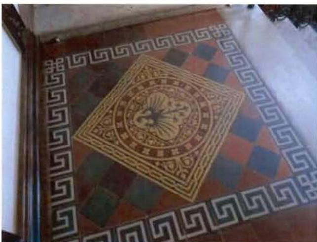
5. Покрытие пола верхнего уровня вестибюля.
