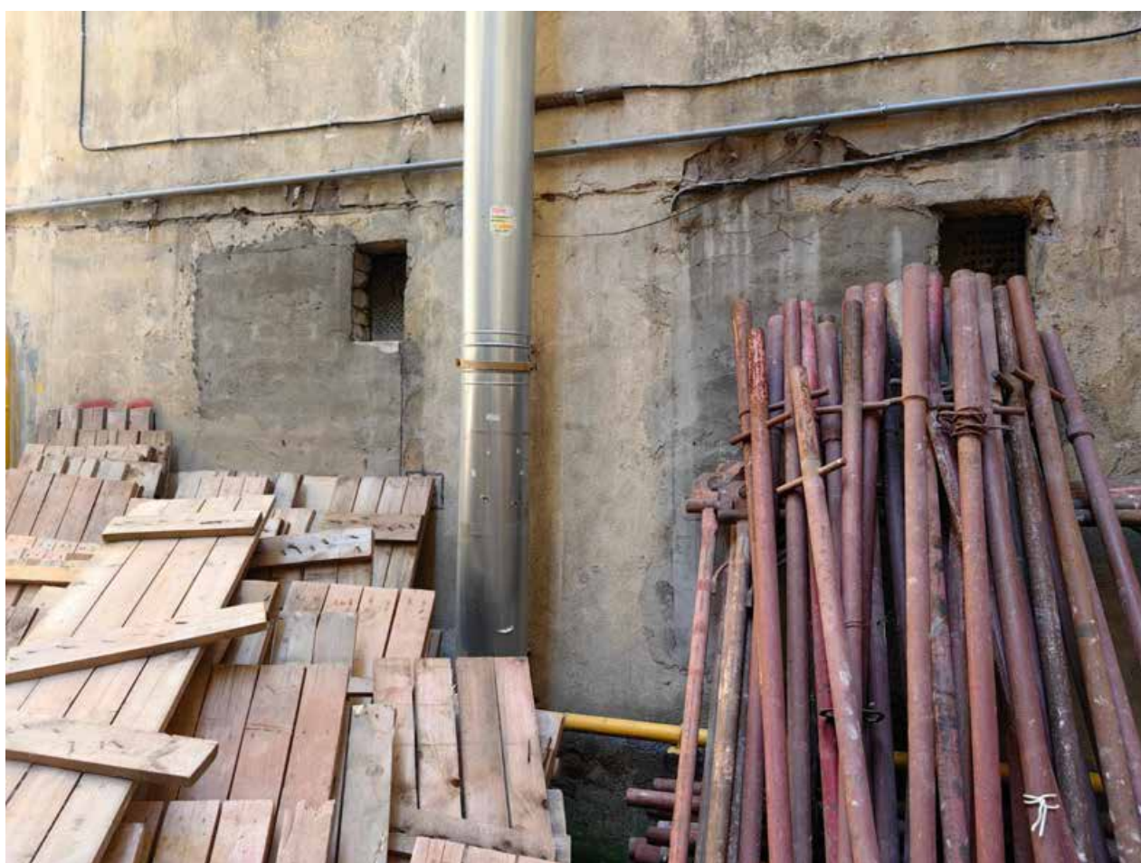
Илл.18. Общий вид на помещения 4-Н со стороны дворового фасада.
