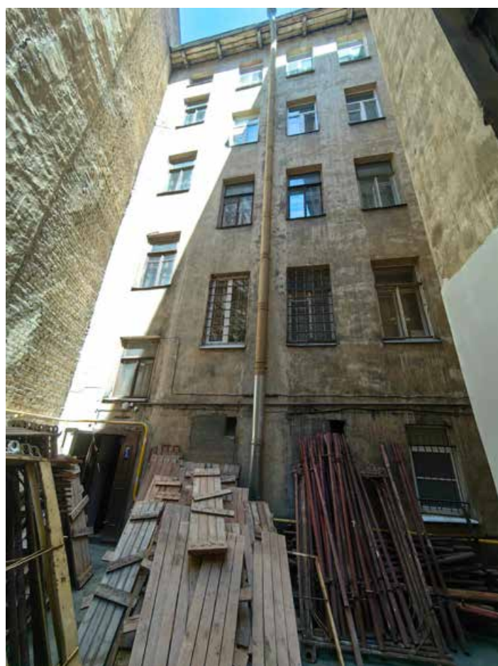
Илл.16. Общий вид на дворовые фасады.
