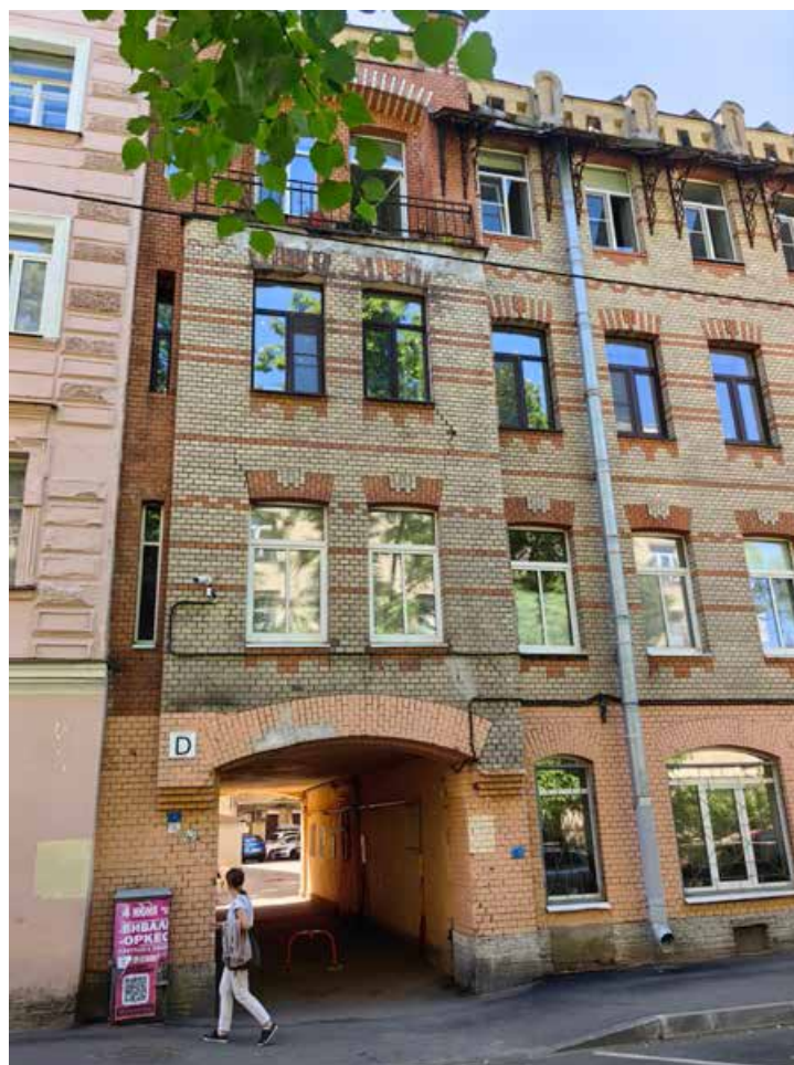
Илл.5. Общий вид на фрагмент лицевого фасада.
