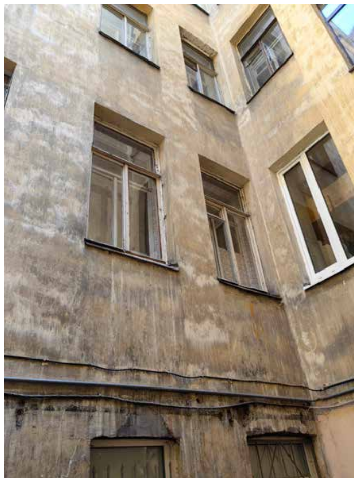
Илл.21. Вид на историческое оконное заполнение дворовых фасадов.
