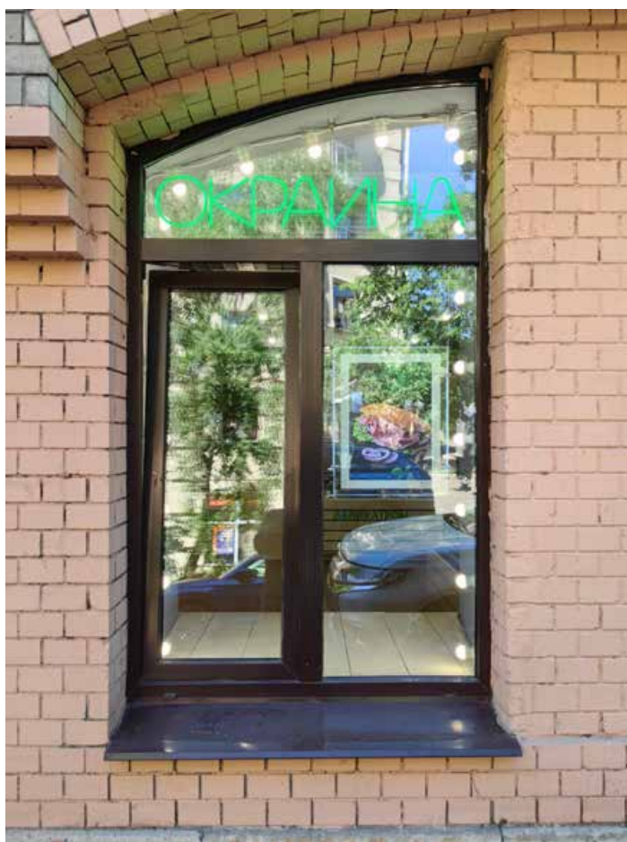
Илл.8. Вид на оконное заполнение помещения 4-Н со стороны лицевого фасада.
