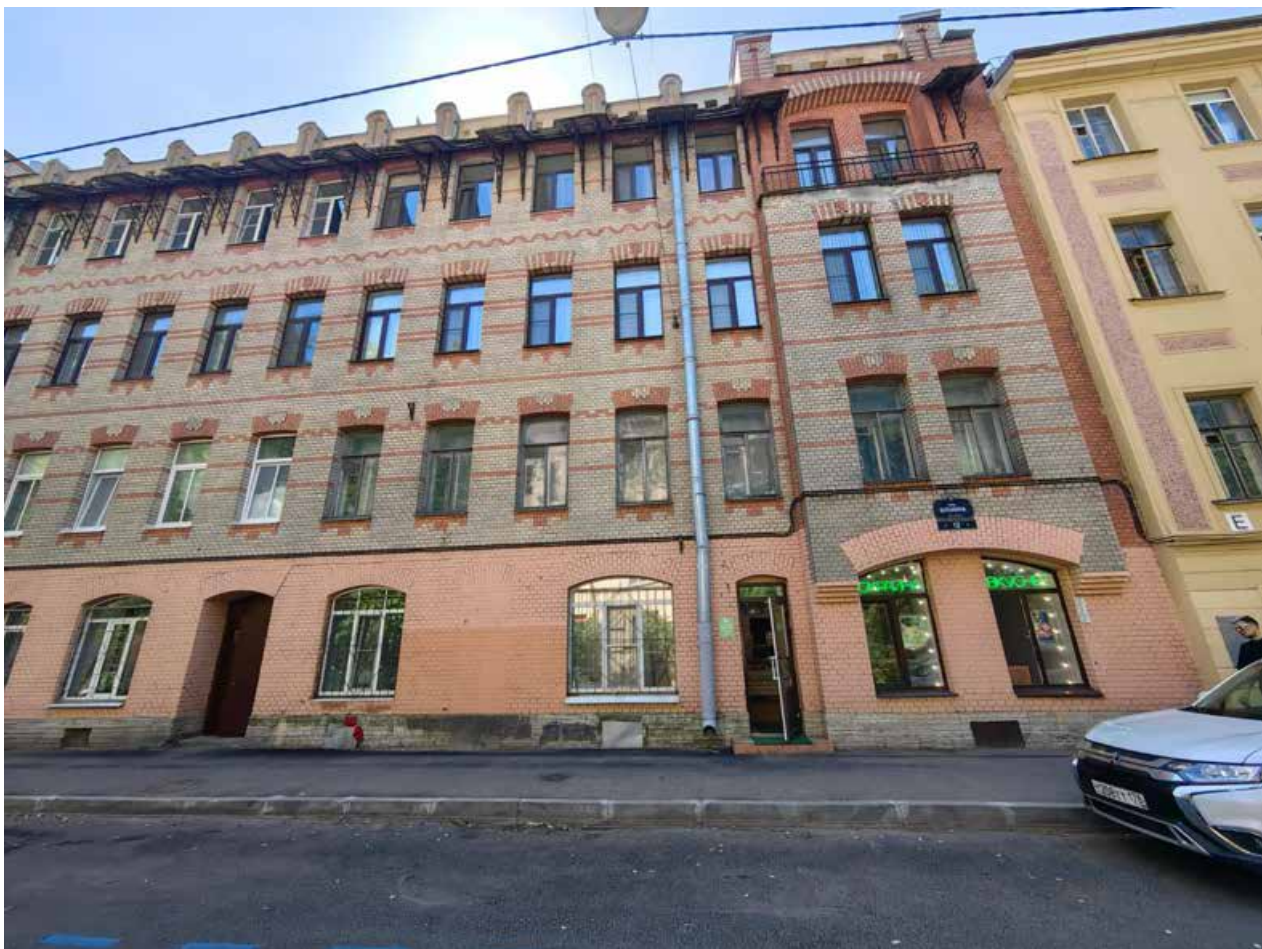
Илл.2. Общий вид на фрагмент лицевого фасада.
