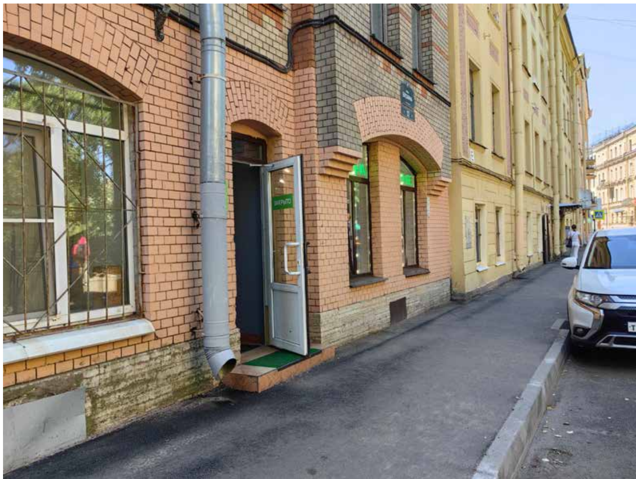
Илл.7. Общий вид на помещения 4-Н со стороны лицевого фасада.
