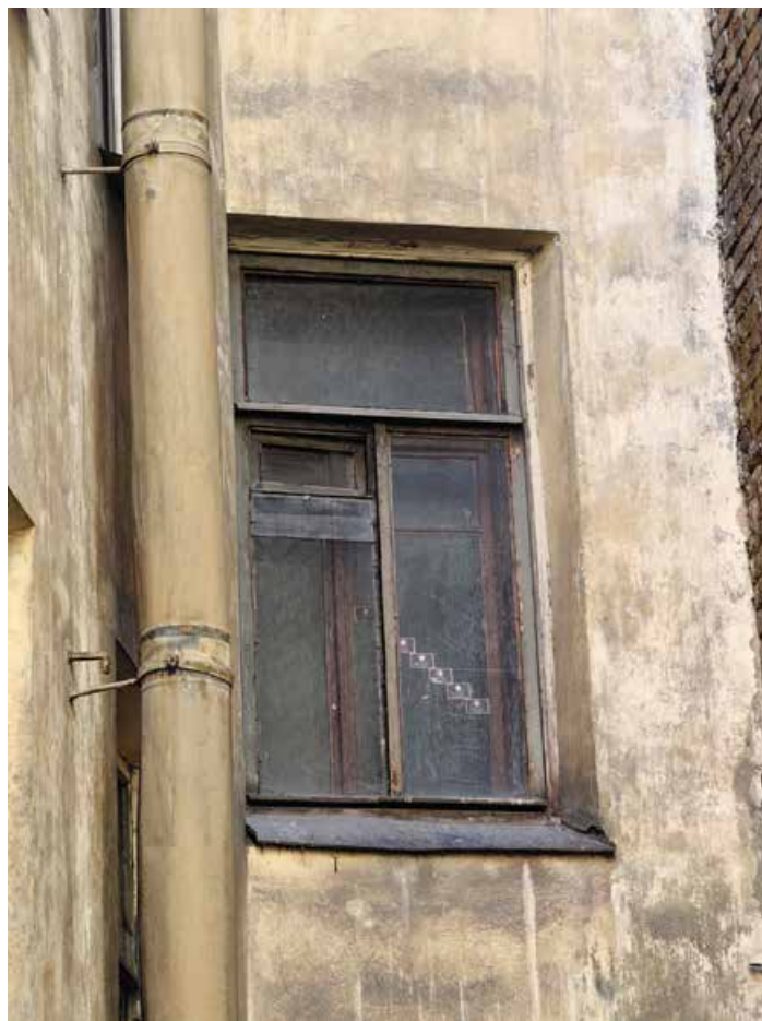
Илл.19. Вид на историческое оконное заполнение дворовых фасадов.
