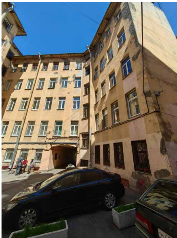
Илл.11. Общий вид на дворовые фасады.
