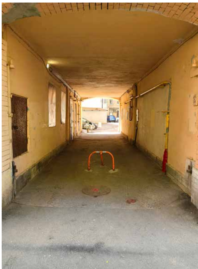
Илл.10. Вид на арочный проем со стороны лицевого фасада.
