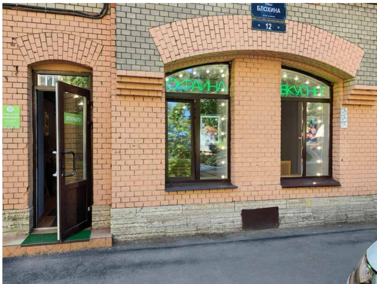
Илл.6. Общий вид на помещения 4-Н со стороны лицевого фасада.
