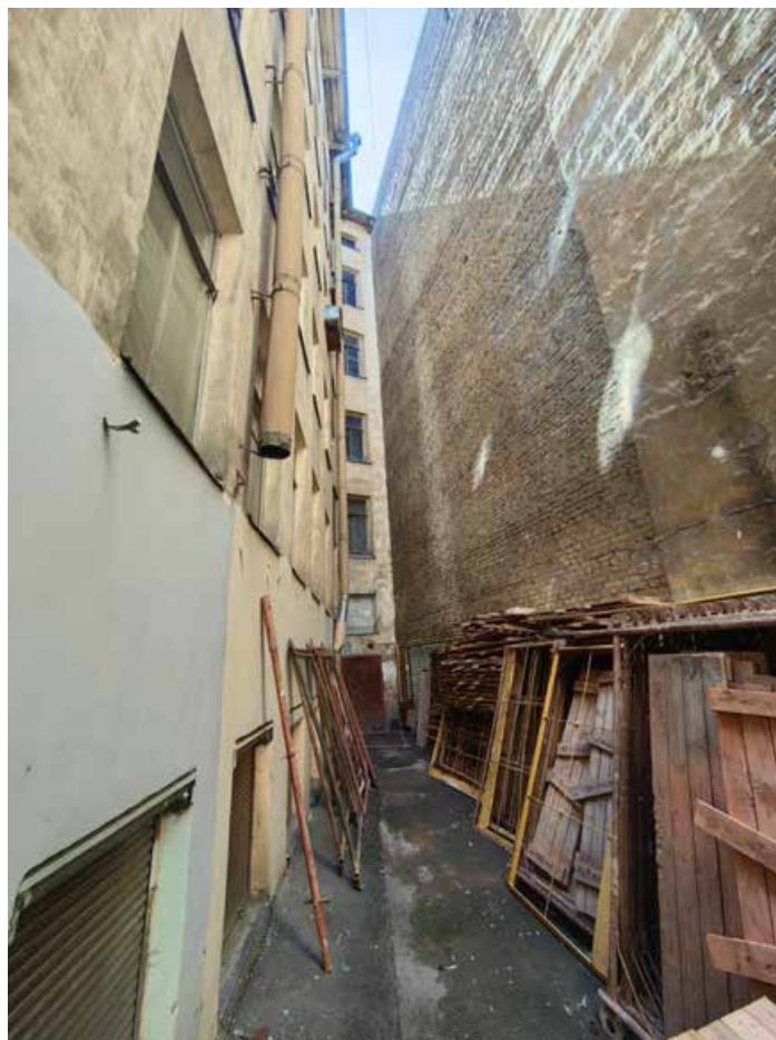
Илл.17. Общий вид на дворовые фасады.
