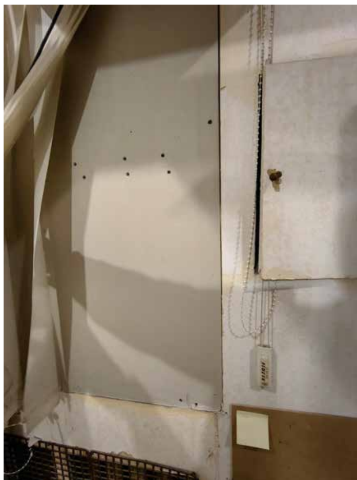
Илл.36. Пом. 4. Вид на защищенный гипсокартоном оконный проем.
