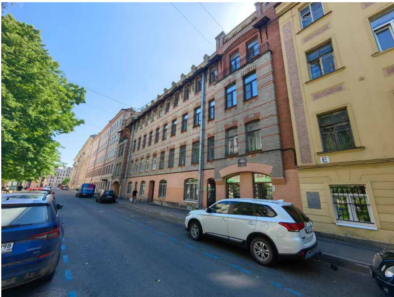
Илл.1. Общий вид на лицевой фасад.
