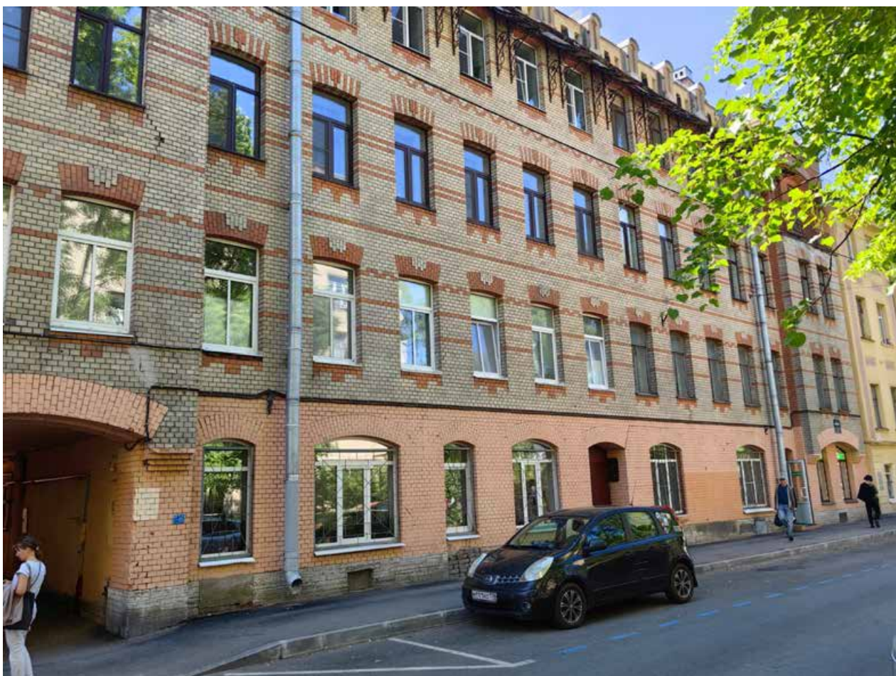
Илл.4. Общий вид на фрагмент лицевого фасада.
