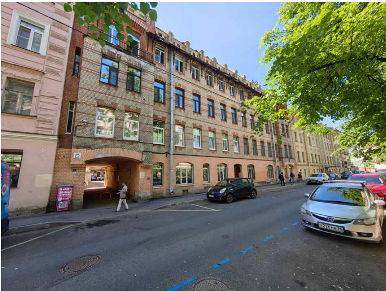
Илл.3. Общий вид на лицевой фасад.
