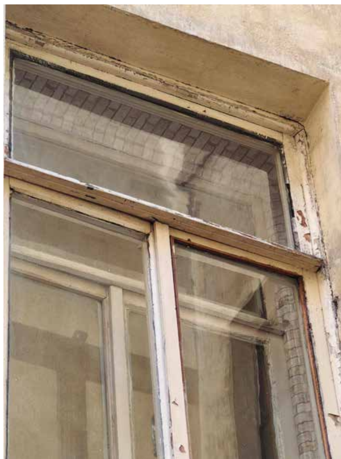
Илл.20. Вид на историческое оконное заполнение дворовых фасадов.
