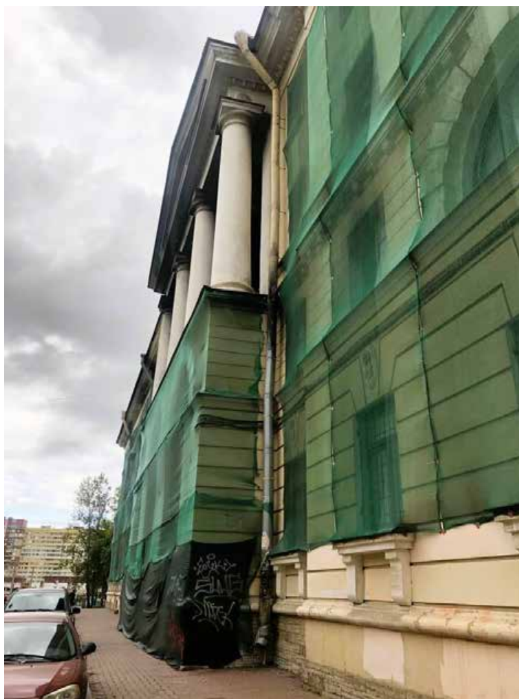
11. Объект культурного наследия регионального значения «Жилой дом», входящий в состав объекта культурного наследия регионального значения «Дача Сиверса (Кировский городок)», расположенный по адресу: Санкт-Петербург, Кировский район, пр. Стачек, д. 172, литера А. Лицевой фасад. Вид вдоль фасада.
