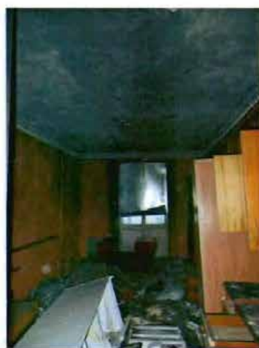
20. Помещение третьего этажа.
