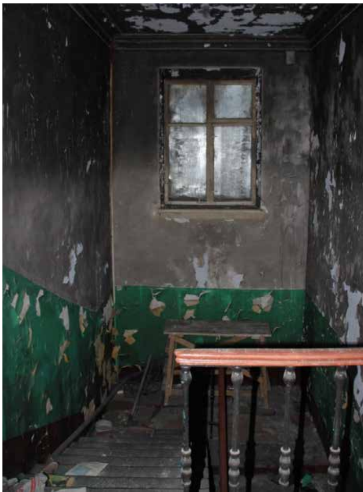
30. Объект культурного наследия регионального значения «Жилой дом», входящий в состав объекта культурного наследия регионального значения «Дача Сиверса (Кировский городок)», расположенный по адресу: Санкт-Петербург, Кировский район, пр. Стачек, д. 172, литера А. Вид лестничной клетки в уровне четвертого этажа.
