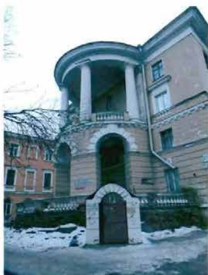
9. Полуциркульный ризалит с балконом и террасой.
