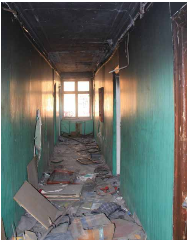
71. Объект культурного наследия регионального значения «Жилой дом», входящий в состав объекта культурного наследия регионального значения «Дача Сиверса (Кировский городок)», расположенный по адресу: Санкт-Петербург, Кировский район, пр. Стачек, д. 172, литера А. Помещение второго этажа. Коридор. Фрагмент интерьера.
