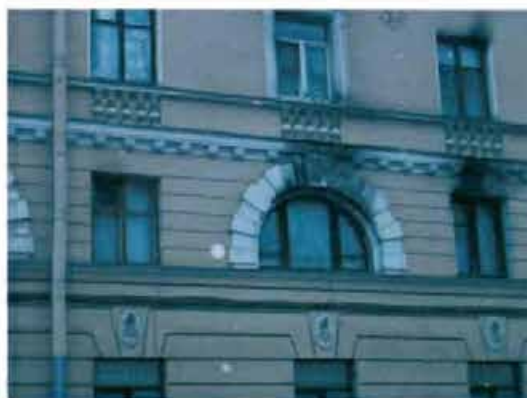
12. Оконные проемы второго этажа.
