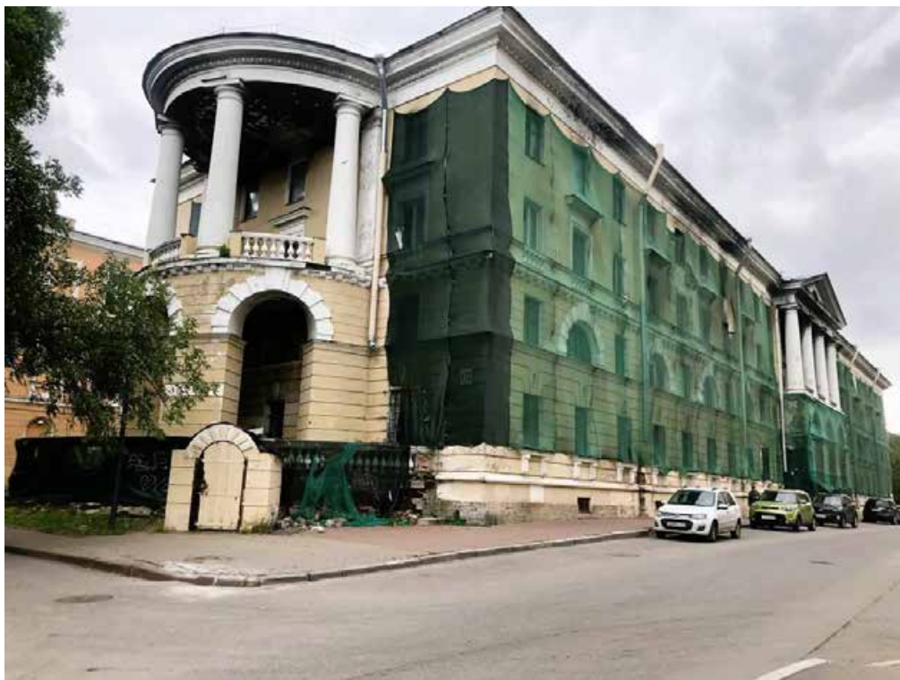
3. Объект культурного наследия регионального значения «Жилой дом», входящий в состав объекта культурного наследия регионального значения «Дача Сиверса (Кировский городок)», расположенный по адресу: Санкт-Петербург, Кировский район, пр. Стачек, д. 172, литера А. Общий вид в направлении Ленинского проспекта. Лицевой и северо-западный фасады.
