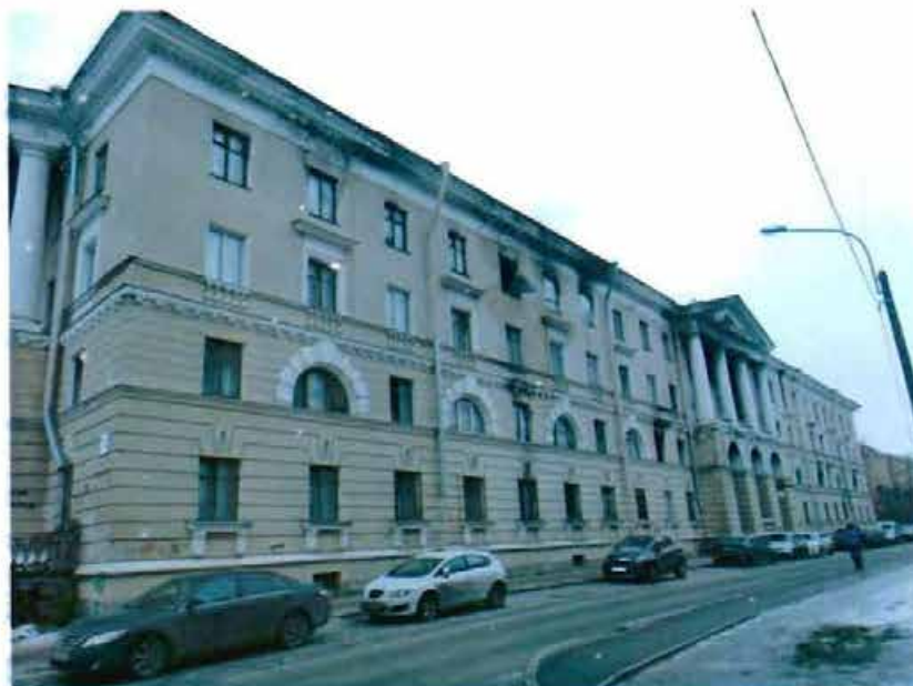
2. Лицевой фасад. Вид с запада.
