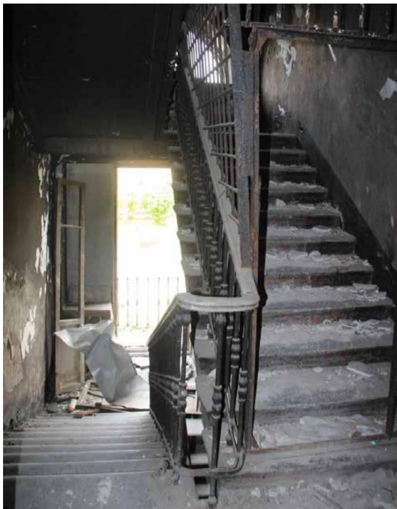
29. Объект культурного наследия регионального значения «Жилой дом», входящий в состав объекта культурного наследия регионального значения «Дача Сиверса (Кировский городок)», расположенный по адресу: Санкт-Петербург, Кировский район, пр. Стачек, д. 172, литера А. Вид лестничной клетки в уровне четвертого этажа.
