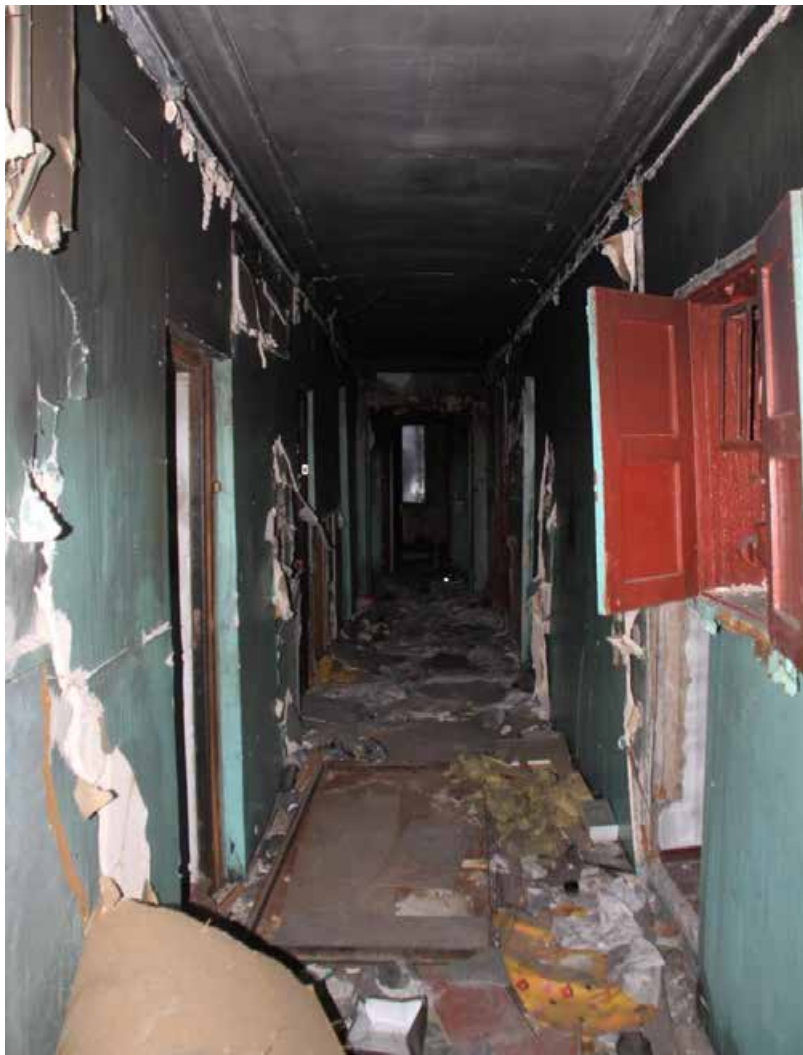
89. Объект культурного наследия регионального значения «Жилой дом», входящий в состав объекта культурного наследия регионального значения «Дача Сиверса (Кировский городок)», расположенный по адресу: Санкт-Петербург, Кировский район, пр. Стачек, д. 172, литера А. Помещение второго этажа. Коридор. Фрагмент интерьера.
