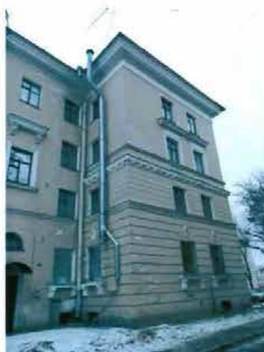
6. Ризалит в западной части.
