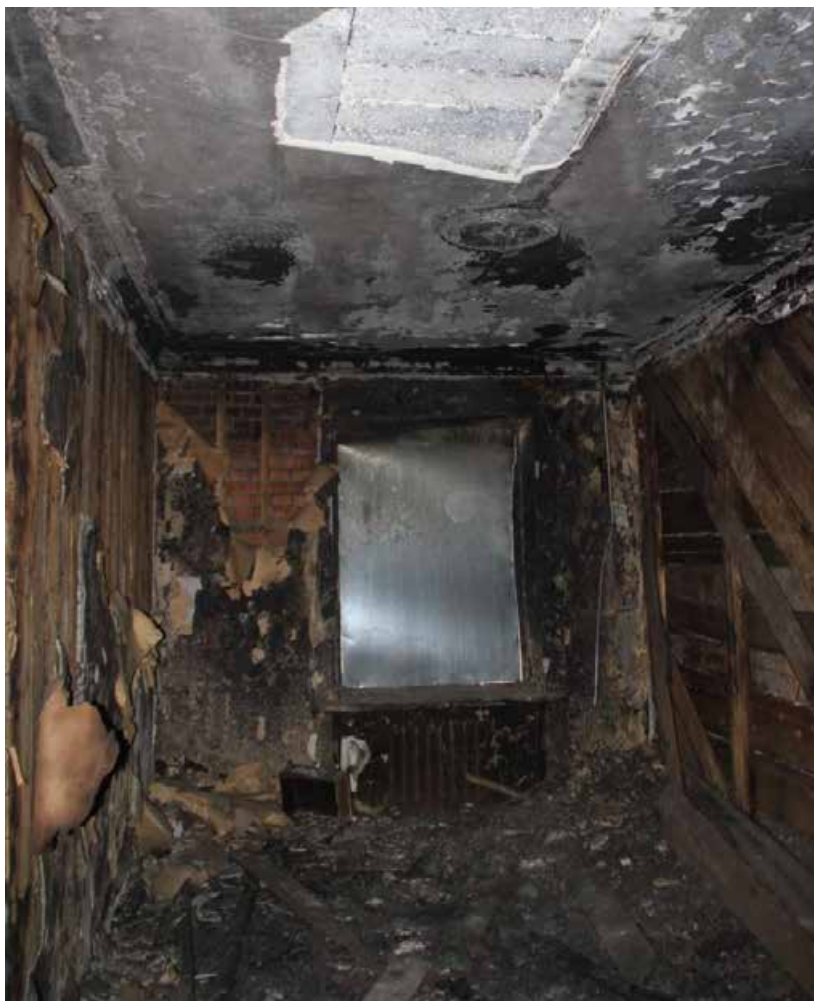
100. Объект культурного наследия регионального значения «Жилой дом», входящий в состав объекта культурного наследия регионального значения «Дача Сиверса (Кировский городок)», расположенный по адресу: Санкт-Петербург, Кировский район, пр. Стачек, д. 172, литера А. Помещение четвертого этажа. Фрагмент интерьера.
