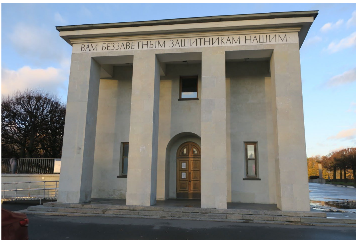
9. Юго-западный лицевой фасад западного павильона объекта культурного наследия федерального значения «Кладбище Пискаревское», расположенного по адресу: г. Санкт-Петербург, пр. Непокоренных, д. 72 литера А. 15.10.2021
