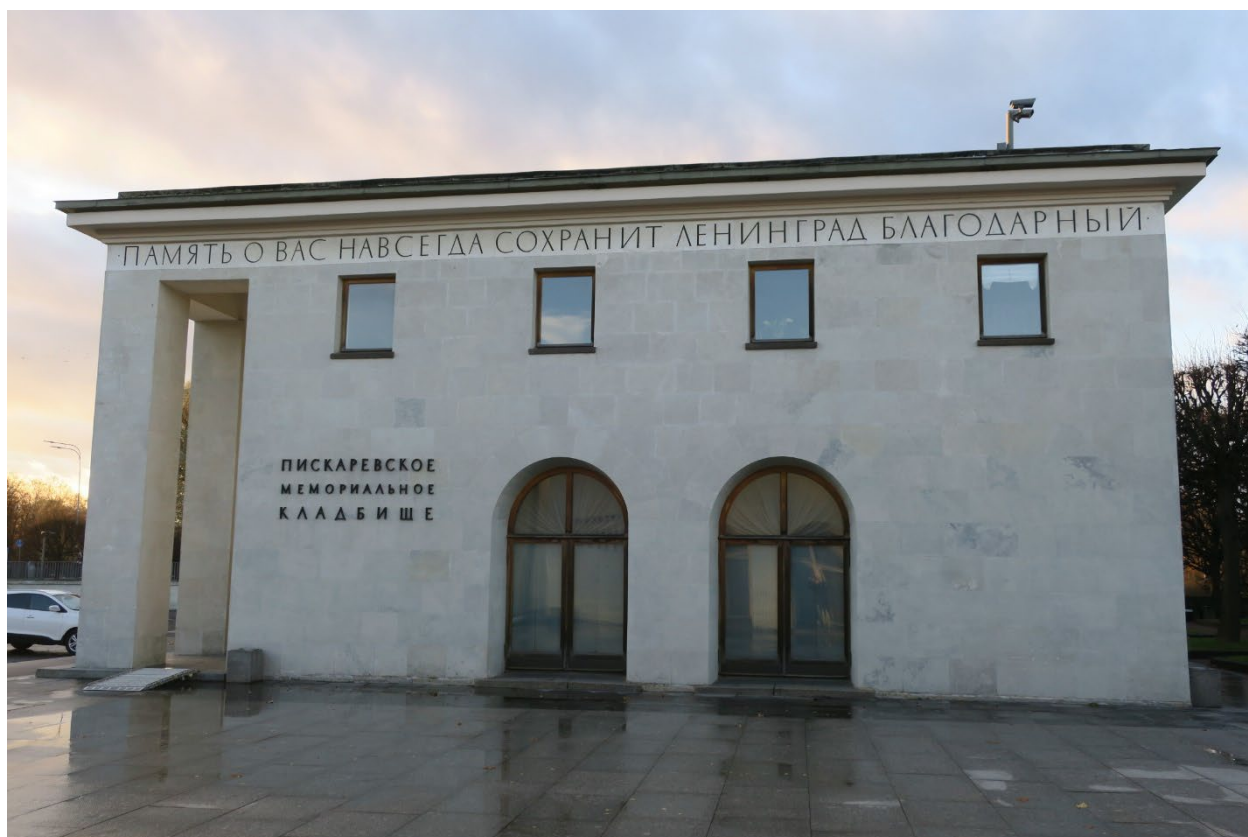
10. Юго-восточный фасад западного павильона объекта культурного наследия федерального значения «Кладбище Пискаревское», расположенного по адресу: г. Санкт-Петербург, пр. Непокоренных, д. 72 литера А. 15.10.2021
