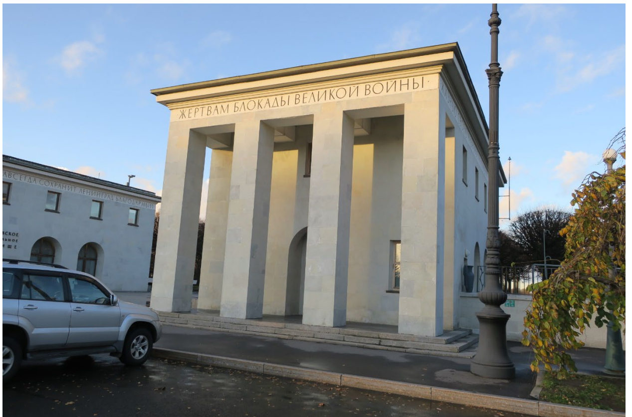
1. Юго-западный лицевой фасад восточного павильона объекта культурного наследия федерального значения «Кладбище Пискаревское», расположенного по адресу: г. Санкт-Петербург, пр. Непокоренных, д. 72 литера А. 15.10.2021
