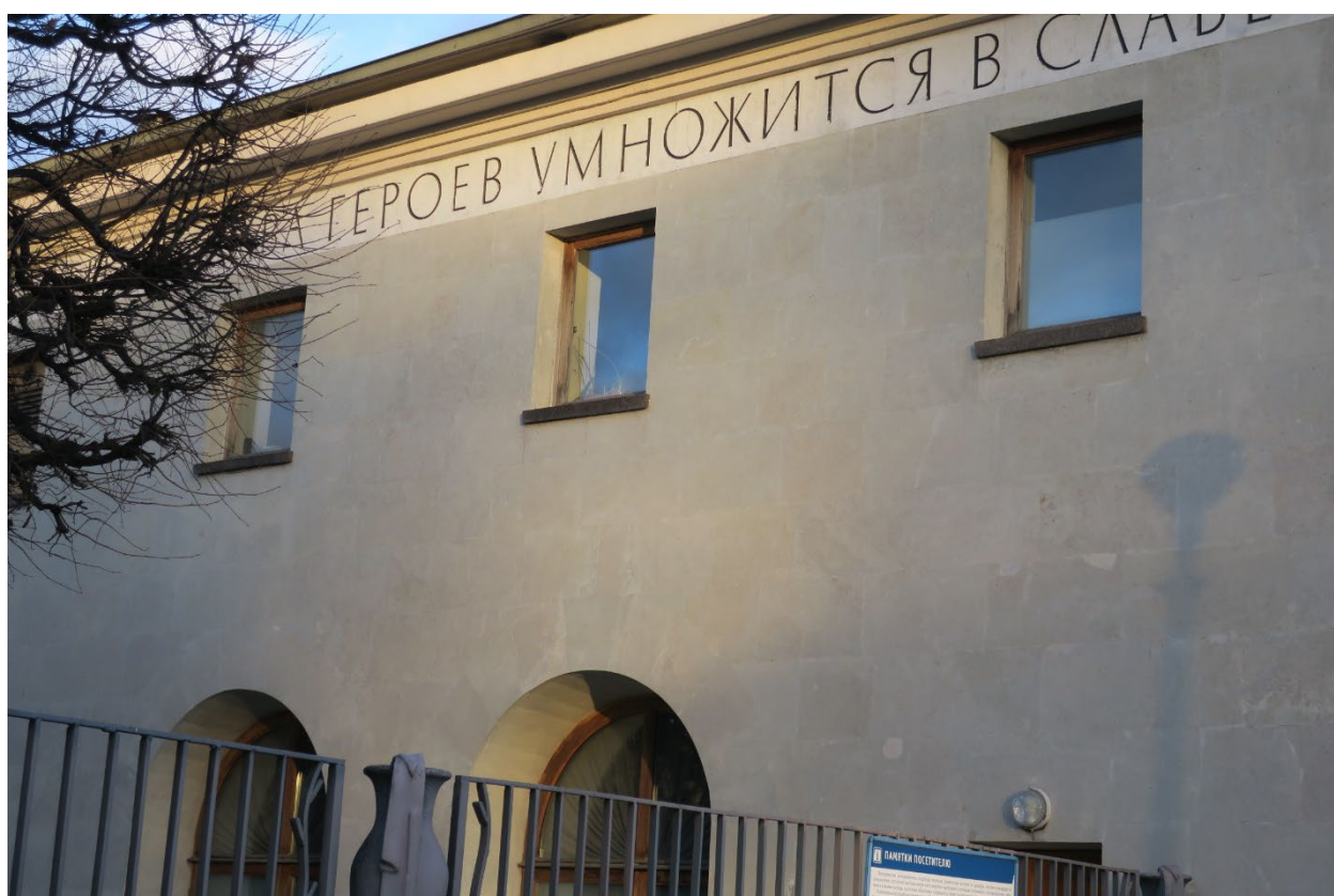
12. Оконные проемы северо-западного фасада западного павильона объекта культурного наследия федерального значения «Кладбище Пискаревское», расположенного по адресу: г. Санкт-Петербург, пр. Непокоренных, д. 72 литера А. 15.10.2021
