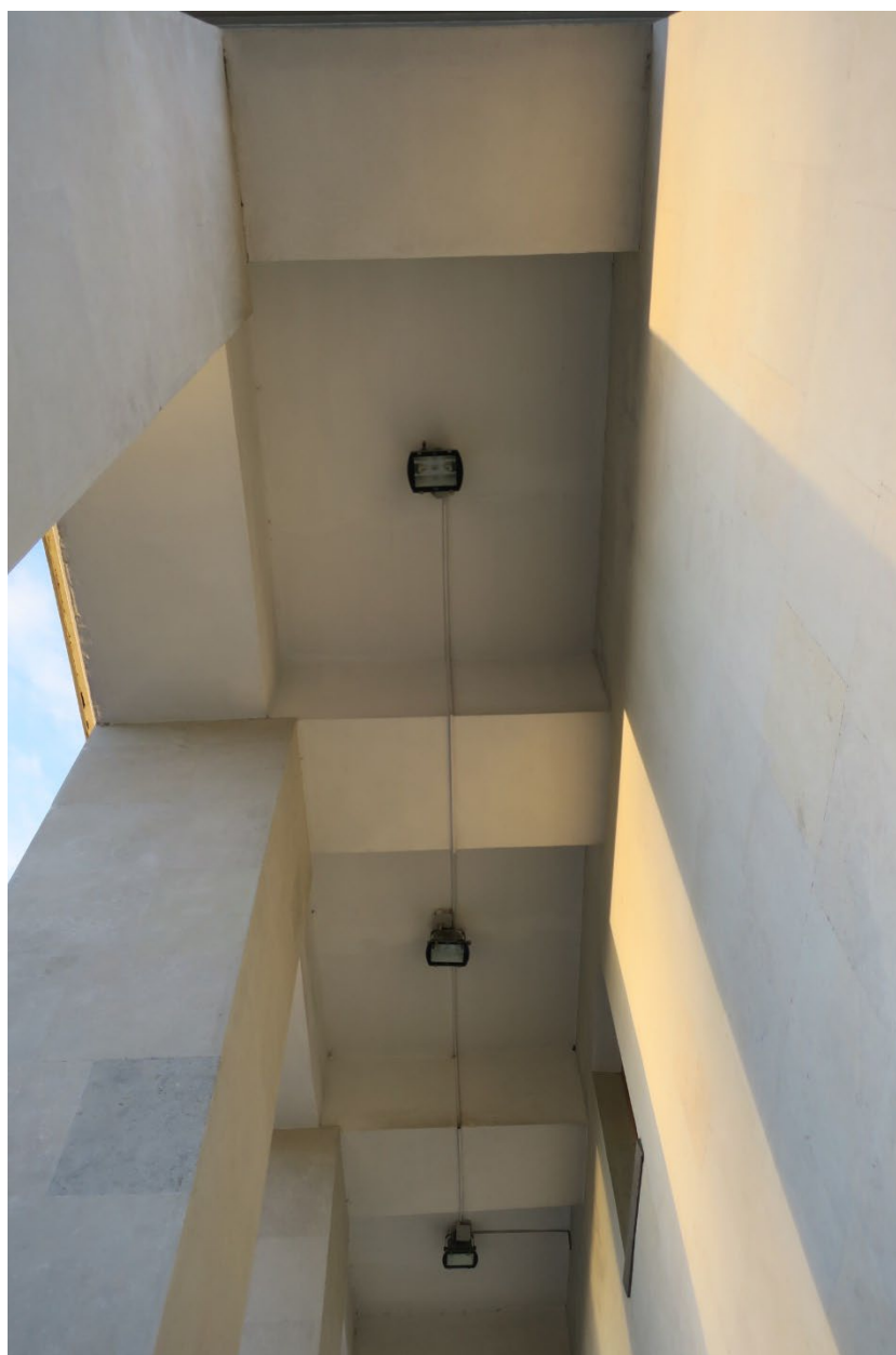
3. Подволока портика юго-западного лицевого фасада восточного павильона восточного павильона объекта культурного наследия федерального значения «Кладбище Пискаревское», расположенного по адресу: г. Санкт-Петербург, пр. Непокоренных, д. 72 литера А. 15.10.2021
