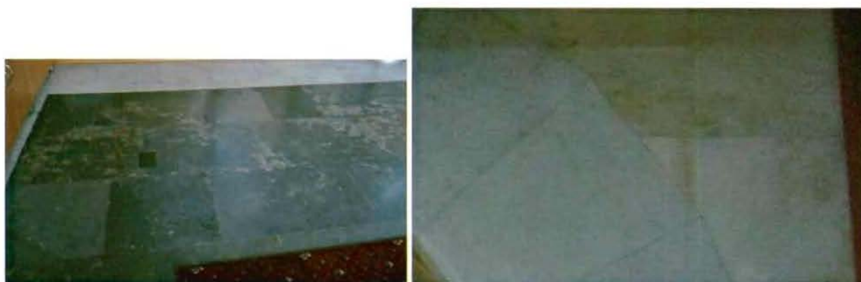
Отделка пола и стен центрального помещения первого этажа левого павильона. Съёмка 20.08.2012, К.С. Евтеев.
