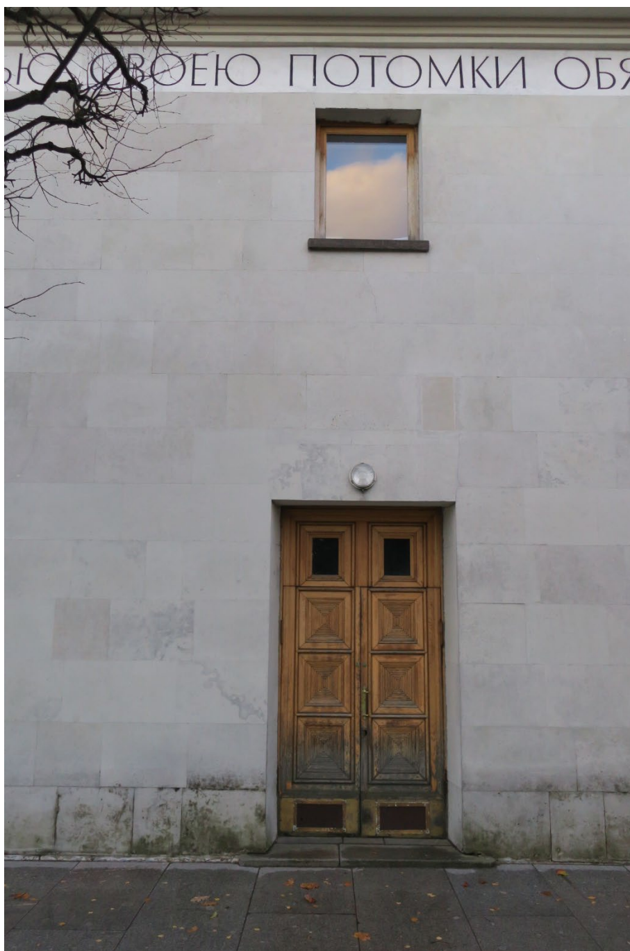
15. Входной проем северо-западного фасада западного павильона объекта культурного наследия федерального значения «Кладбище Пискаревское», расположенного по адресу: г. Санкт-Петербург, пр. Непокоренных, д. 72 литера А. 15.10.2021
