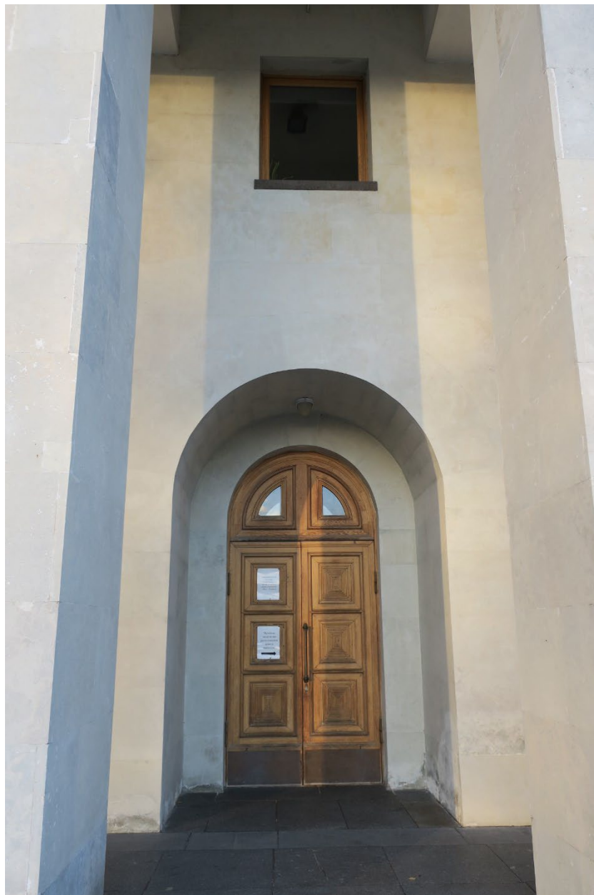
13. Дверной портал северо-западного фасада западного павильона объекта культурного наследия федерального значения «Кладбище Пискаревское», расположенного по адресу: г. Санкт-Петербург, пр. Непокоренных, д. 72 литера А. 15.10.2021
