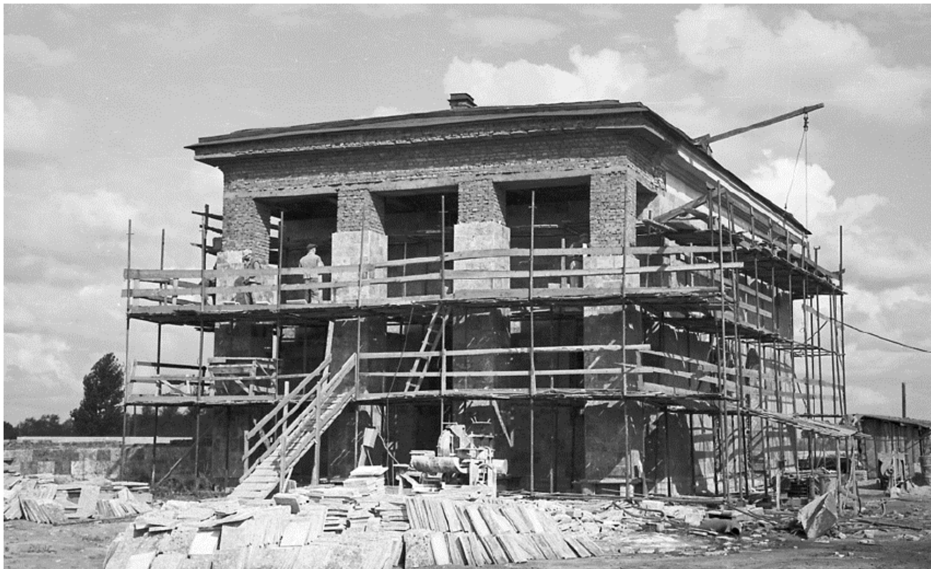
16. Работы по облицовке павильонов. 1959 // Архив ОАО «ЛенНИИПроект»
