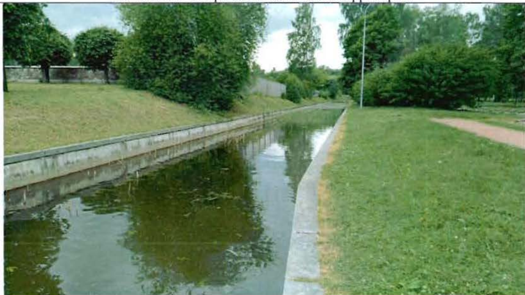
22. Водоотводной канал в юго-западной части территории.
